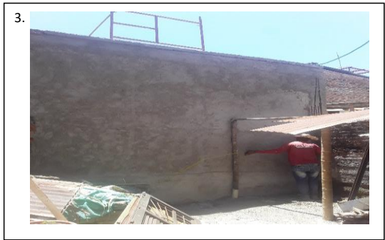
Descripción aplicacion de pañete parte posterior muro sala de audiencias.
