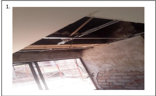
Descripción retiro de cielo falso deteriorado por humedad en oficina de juez
