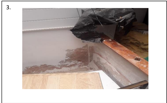
Descripción revision retiro pañete muro posterior hall primer piso
