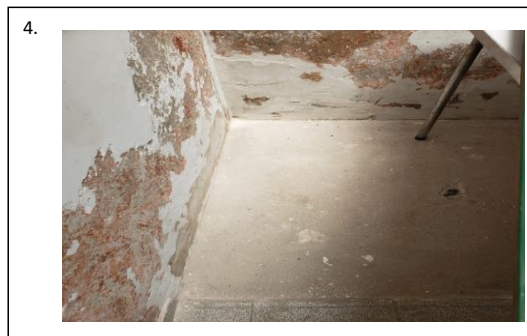
Descripción retiro pañete hall primer piso
