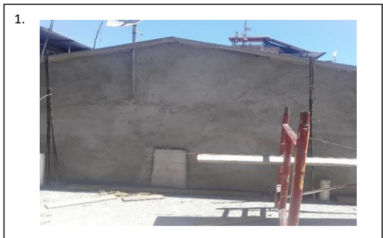
Descripción construccion de alfagia, muro lateral colindante
