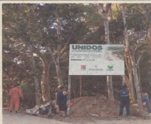
Instalación de Valla Informativa Reglamentaria
