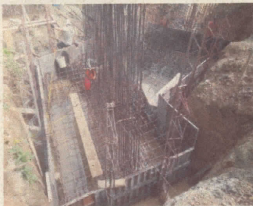
Encofrado para Fundida de Zapatas en Concreto 4000 PSI
