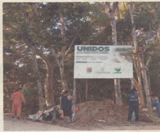
Instalación de Valla Informativa Reglamentaria
