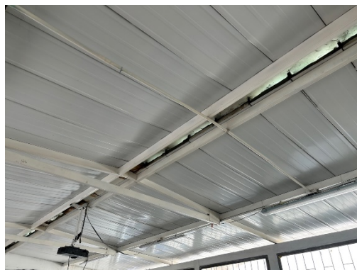
CUBIERTA EN GENERAL
