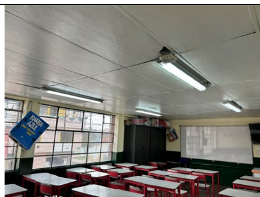
ESTADO ACTUAL AULAS
