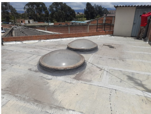
CUBIERTA CON DOMO ACRÍLICO
