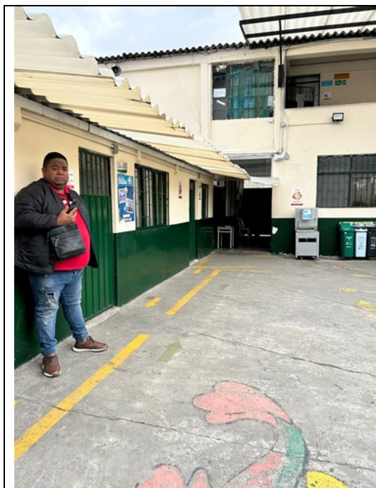
ESTADO ACTUAL PATIO CENTRAL
