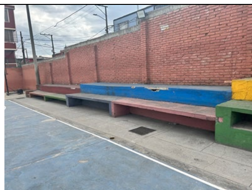
ESTADO ACTUAL DE GRADERIA CANCHA
