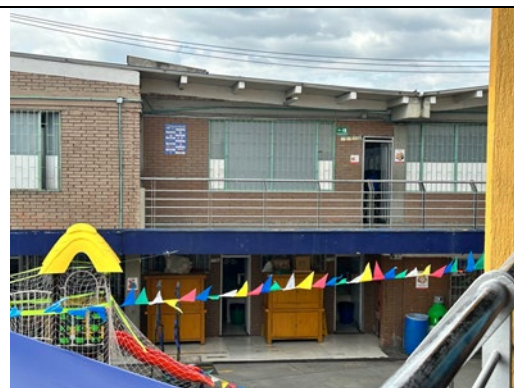
ESTADO ACTUAL FACHADA INTERNA
