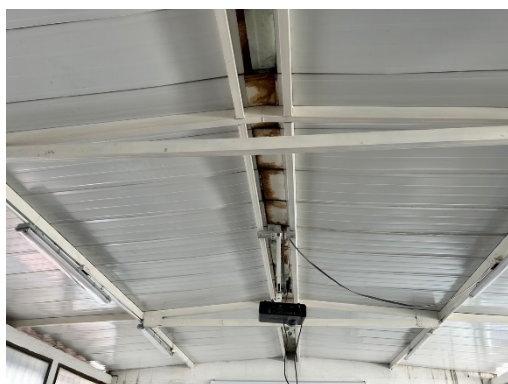
CUBIERTA EN GENERAL
