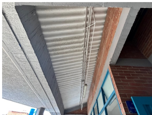
ESTRUCTURA DE CUBIERTA
