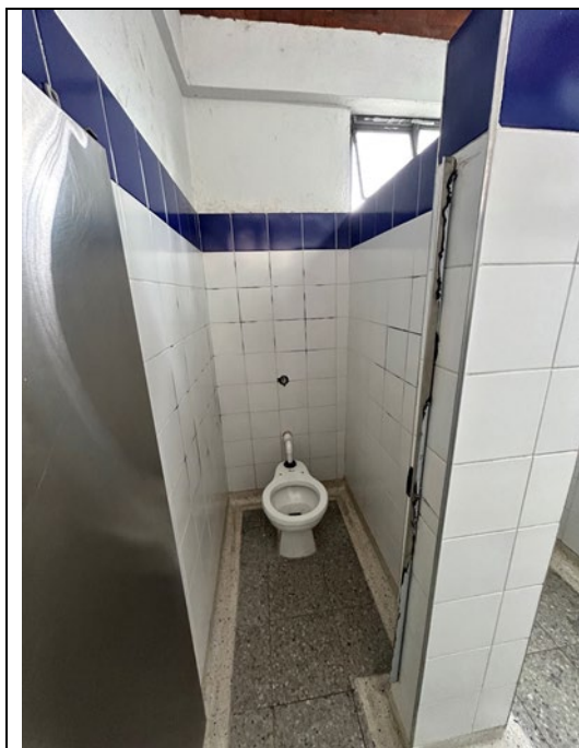
ESTADO ACTUAL BATERIA SANITARIA
