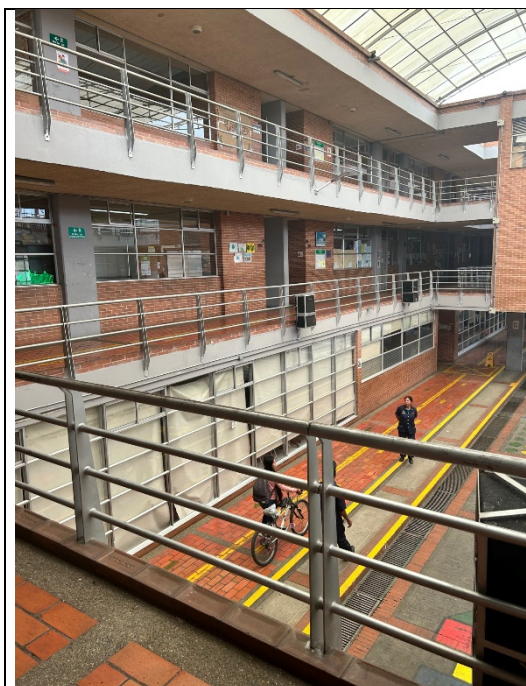
ESTADO ACTUAL BARANDAS
