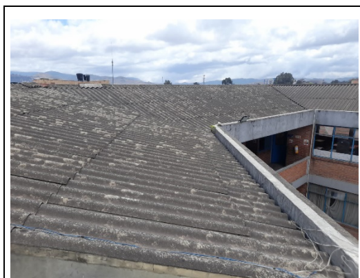
CUBIERTA EN ASBESTO CEMENTO
