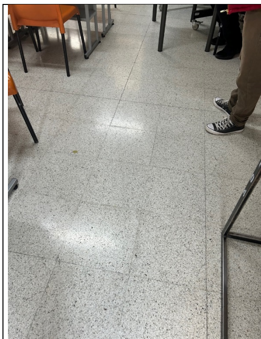
ESTADO ACTUAL PISO AULAS
