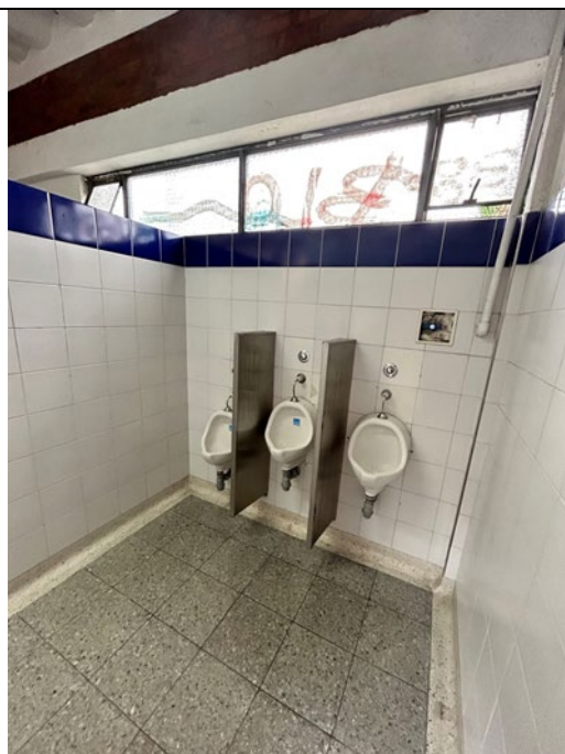
ESTADO ACTUAL BATERIA SANITARIA
