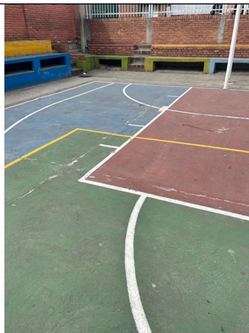
ESTADO ACTUAL DE GRADERIA CANCHA
