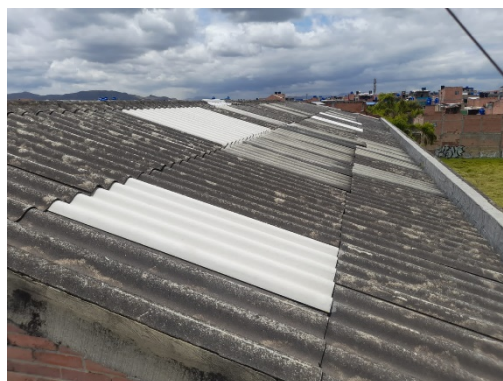
CUBIERTA EN ASBESTO CEMENTO
