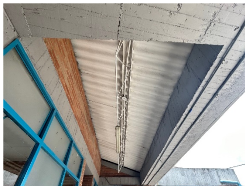
ESTRUCTURA DE CUBIERTA
