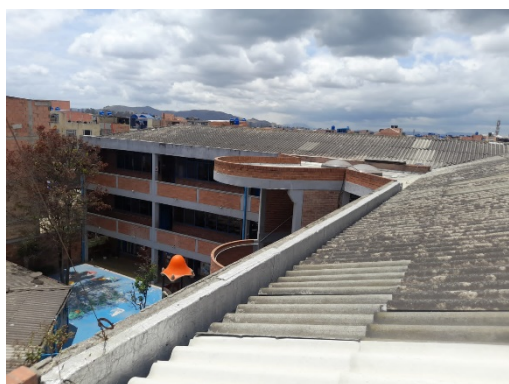
CUBIERTA EN ASBESTO CEMENTO
