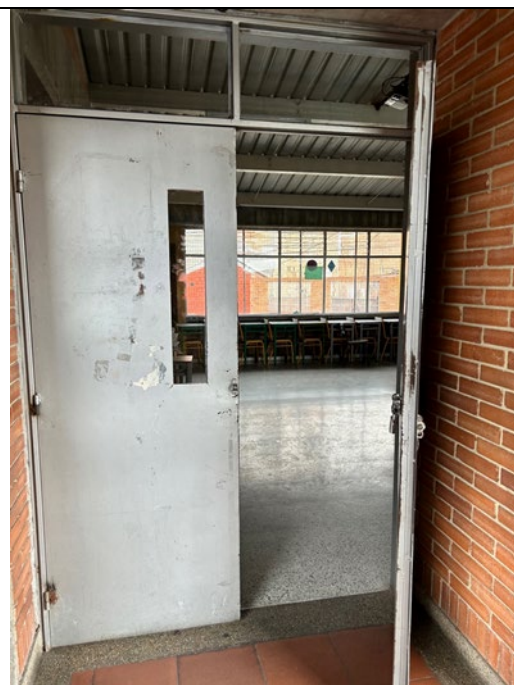
ESTADO ACTUAL CARPINTERIA METALICA
