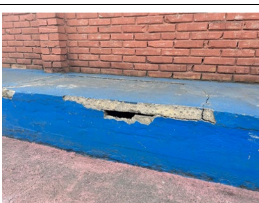
ESTADO ACTUAL DE GRADERIA CANCHA
