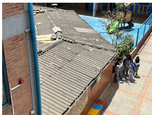
CUBIERTA EN ASBESTO CEMENTO
