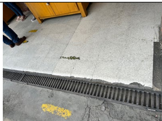
ESTADO ACTUAL CARMACAMOS Y PISOS
