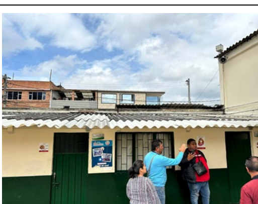
ESTADO ACTUAL DE LA CUBIERTA
