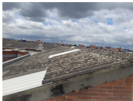
CUBIERTA EN ASBESTO CEMENTO
