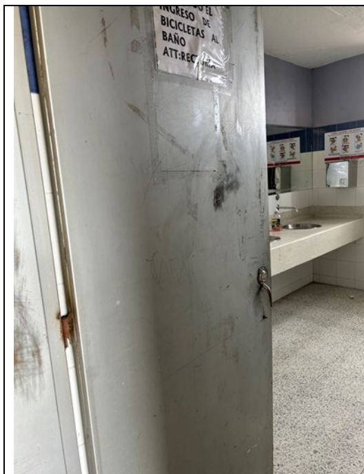
ESTADO ACTUAL CARPINTERIA METALICA
