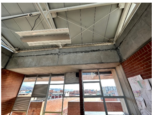
ESTADO ACTUAL DE LA CUBIERTA
