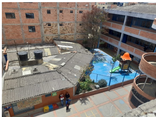
CUBIERTA EN ASBESTO CEMENTO
