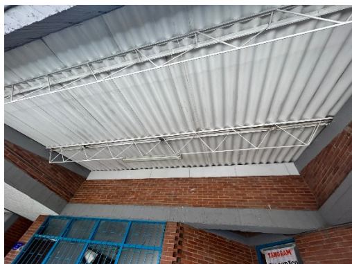
ESTRUCTURA DE CUBIERTA
