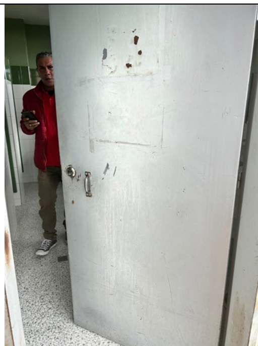
ESTADO ACTUAL CARPINTERIA METALICA
