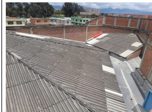
CUBIERTA EN ASBESTO CEMENTO
