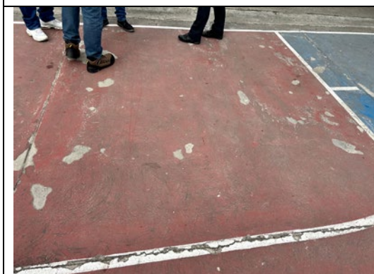
ESTADO ACTUAL DE GRADERIA CANCHA
