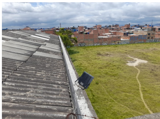
CUBIERTA EN ASBESTO CEMENTO
