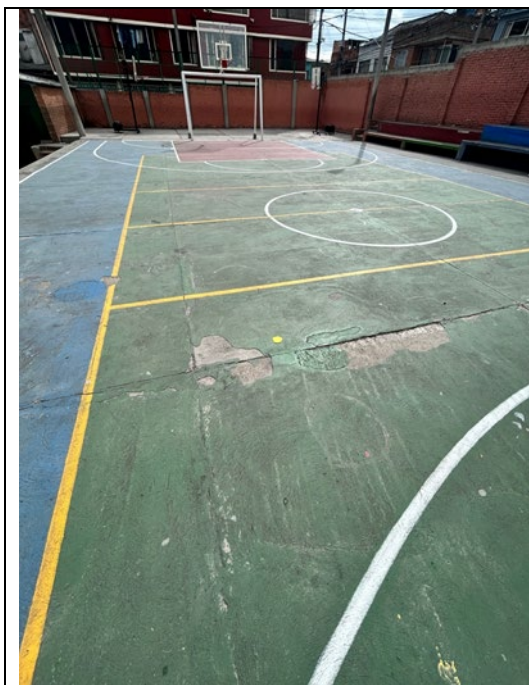
ESTADO ACTUAL DE GRADERIA CANCHA
