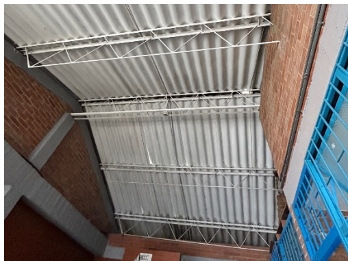
ESTRUCTURA DE CUBIERTA
