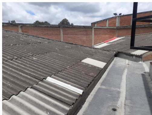
CUBIERTA EN ASBESTO CEMENTO
