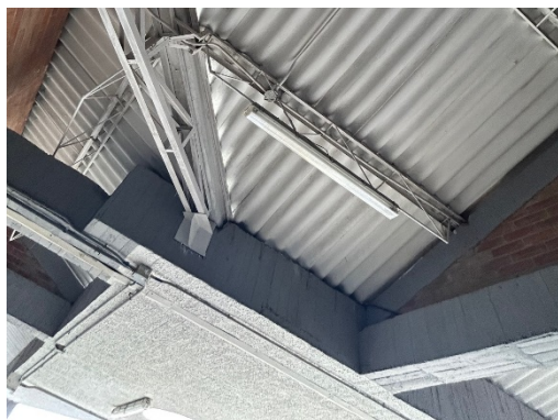
ESTRUCTURA DE CUBIERTA
