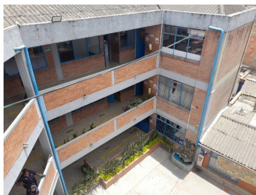
VIGA CANAL PERIMETRAL
