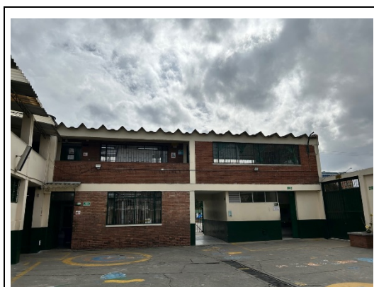
ESTADO ACTUAL FACHADA INTERNA
