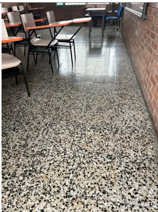
ESTADO ACTUAL PISO AULAS
