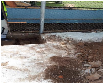
Actividad: Excavaciones y descapote, preliminar
