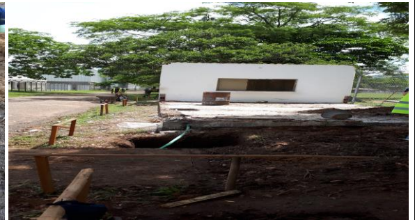
Actividad: Localizacion y replanteo edificacion
