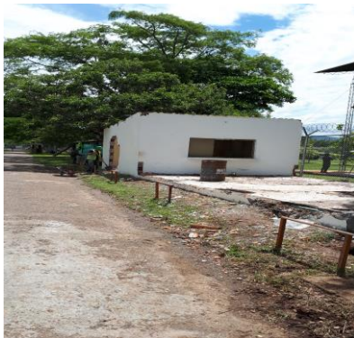
Actividad: Excavaciones, demoliciones y descapote, preliminar
