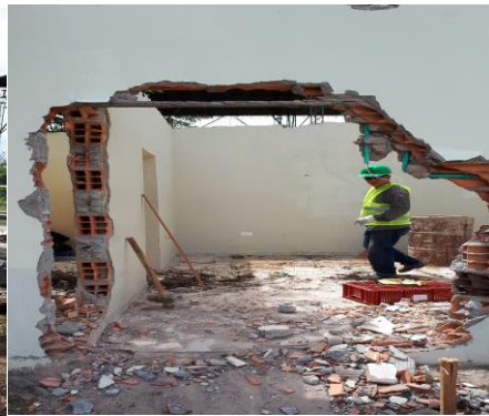
Actividad: Excavaciones, demoliciones y descapote, preliminar
