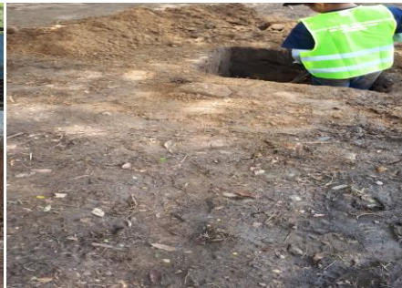
Actividad: Excavaciones y descapote, preliminar
