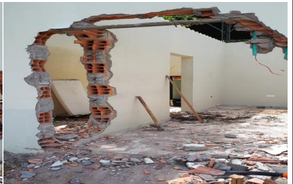
Actividad: Excavaciones, demoliciones y descapote, preliminar
