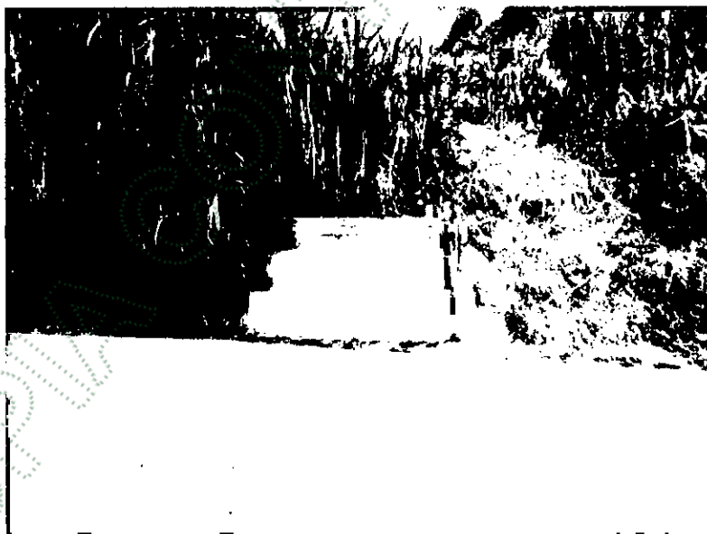
MURO DE 12 M3 DE GAVIÓN
