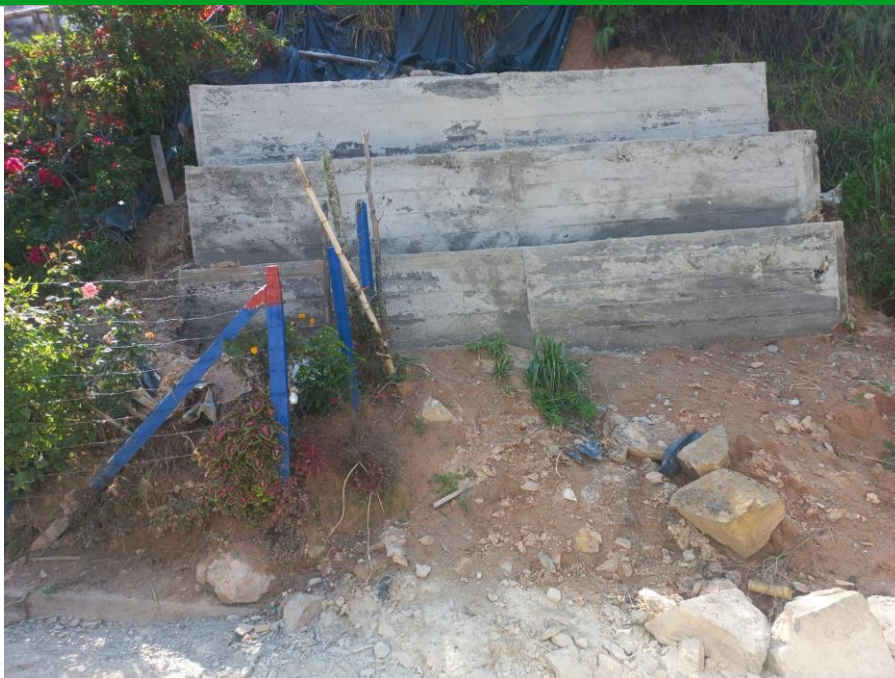
MURO GAVIÓN DE 18 M3 YA CULMINADO
