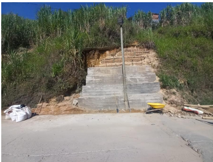
MURO DE 24 M3 DE GAVIÓN Y 19 M DE TRINCHO
