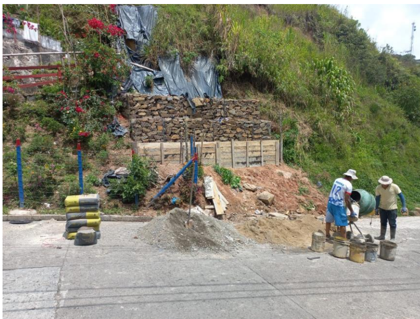
FUNDICIÓN DE RECUBRIMIENTO EN CONCRETO SIMPLE DE 6 CM
