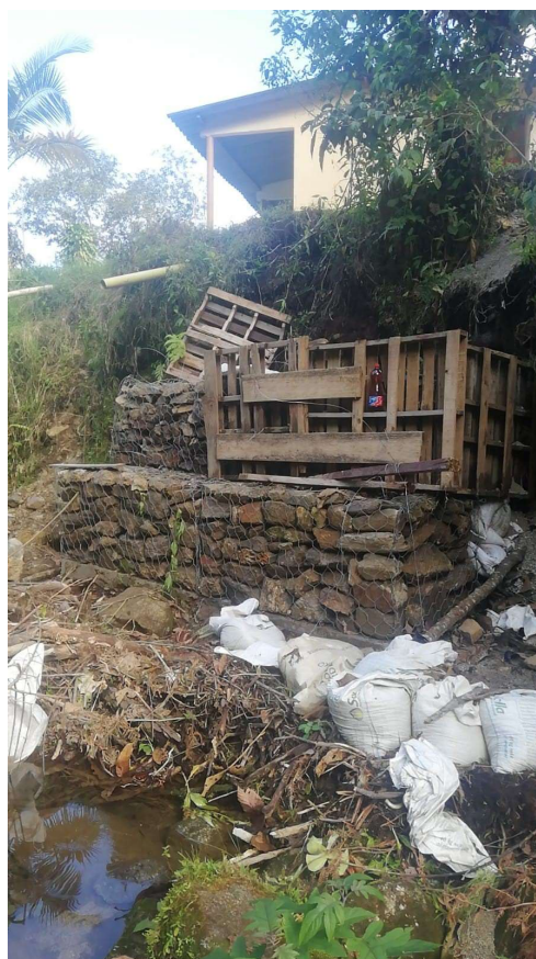
Formaleta de armado de gaviones.
