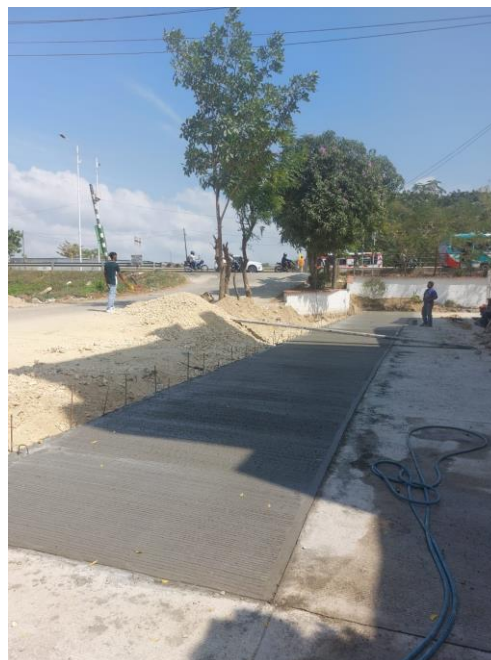
Pavimento en concreto MR 40, incluye acero de refuerzo de dovelas en f=1" Lc 0,40 @0,35m, canastilla de soporte para dovelas, acero de amarre en f=1/2" Lc 1m @ 1,0m, plástico de fondo y curado con antisol
