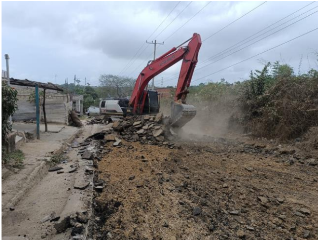
Excavación Mecánica en cualquier tipo de material, incluye Retiro y Disposición Final >5km.
