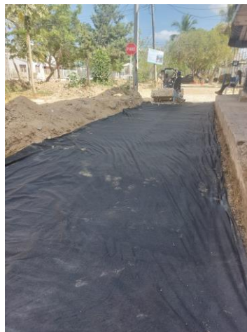
Instalación Geotextil No Tejido 1600
