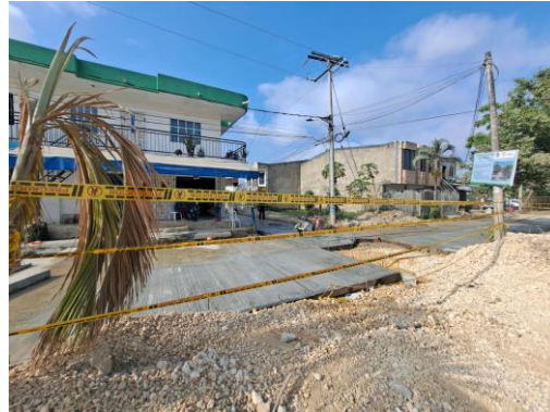
Señalización de obra
