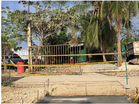
Señalización de obra
