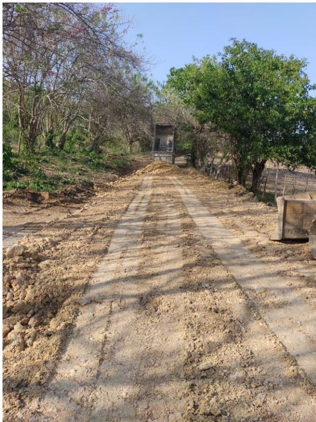
Relleno en Material Seleccionado Compactado 95% PM Zona de Vía.
