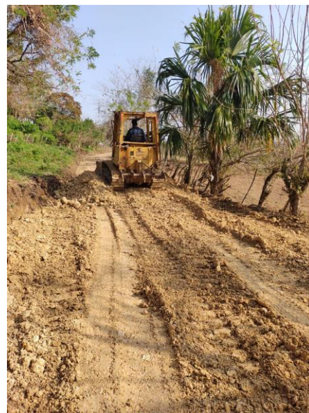
Conformación y Adecuación de vía alterna en afirmado 6m de ancho.
