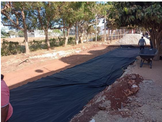
Instalación Geotextil No Tejido 1600
