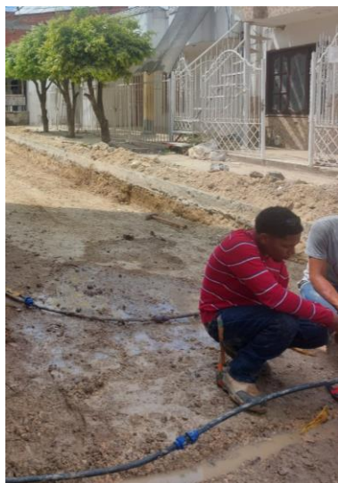
Reparación de acometidas Ac. y Alc averiadas durante los trabajos
