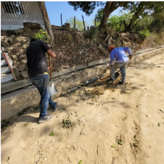
Reparación de acometidas Ac. y Alc averiadas durante los trabajos
