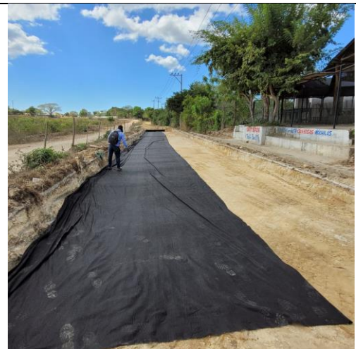
Instalación Geotextil No Tejido 1600
