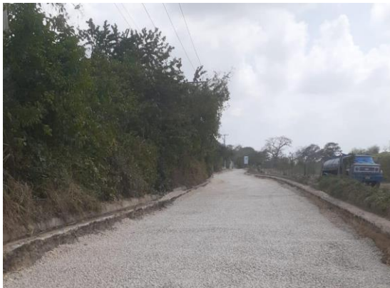
Relleno con Material Seleccionado Triturado 1" a 3/4" en Zona de Calzada Compacto, e =0,30
