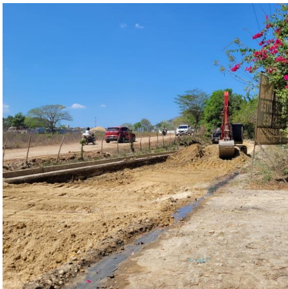
Excavación Mecánica en cualquier tipo de material, incluye Retiro y Disposición Final >5km.
