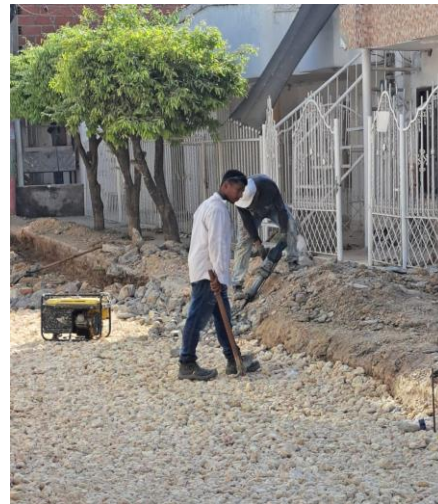
Demolición de bordillos en concreto h=0,1- 0,20m, incluye retiro y disposición de escombros
