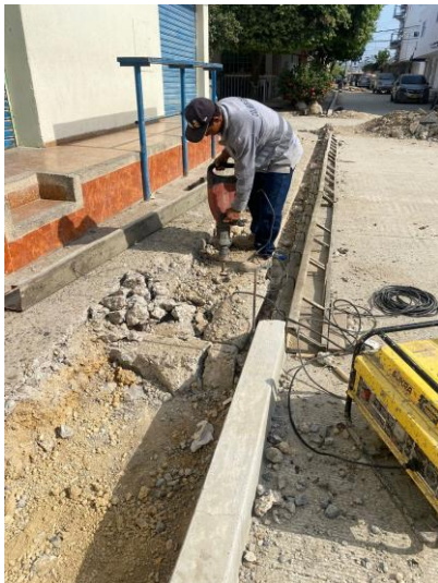
Demolición de andenes en concreto e=0,07-0,10m, incluye retiro y disposición de escombros
