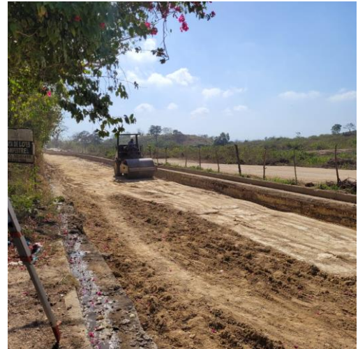
Conformación y Compactación de Terreno Natural .
