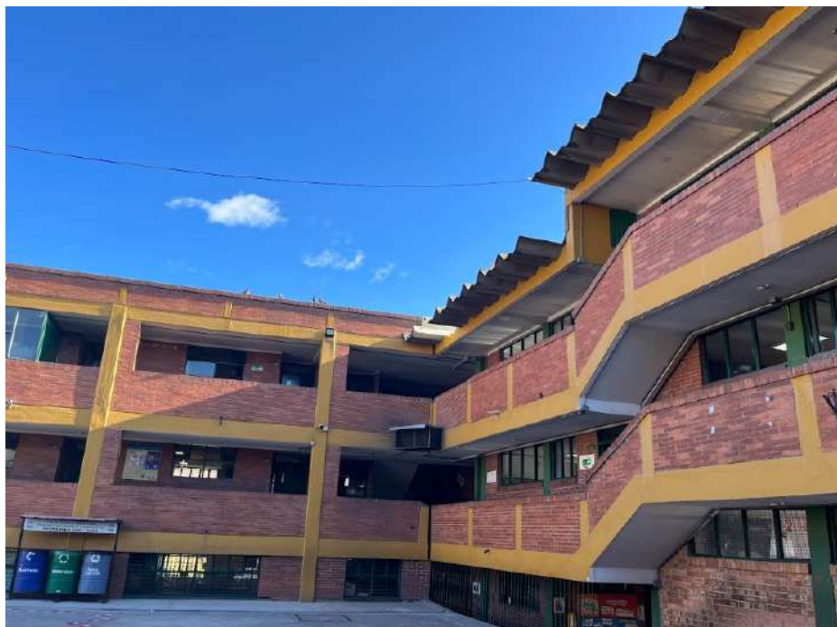
Ilustración 1 IED Santa Martha previo a la intervención.
