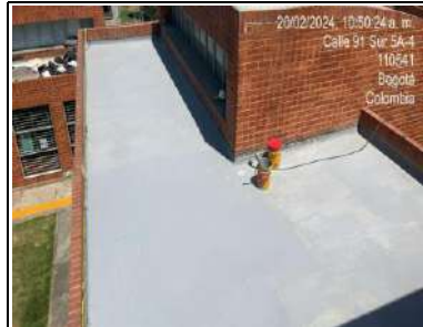
impermeabilización de placa 2
