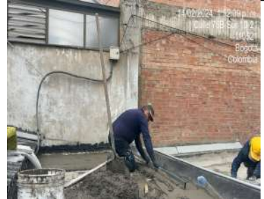
Afinado de piso en mortero impermeabilizado
