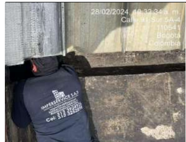
mantenimiento y limpieza de canal
