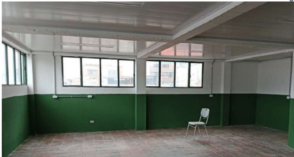
Ilustración 10 Instalación de cielorraso, red eléctrica, aparatos eléctricos y pintura aulas.
