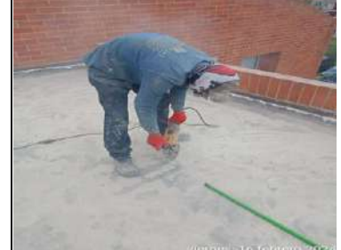
inducción de fisuras de placa 1er piso
