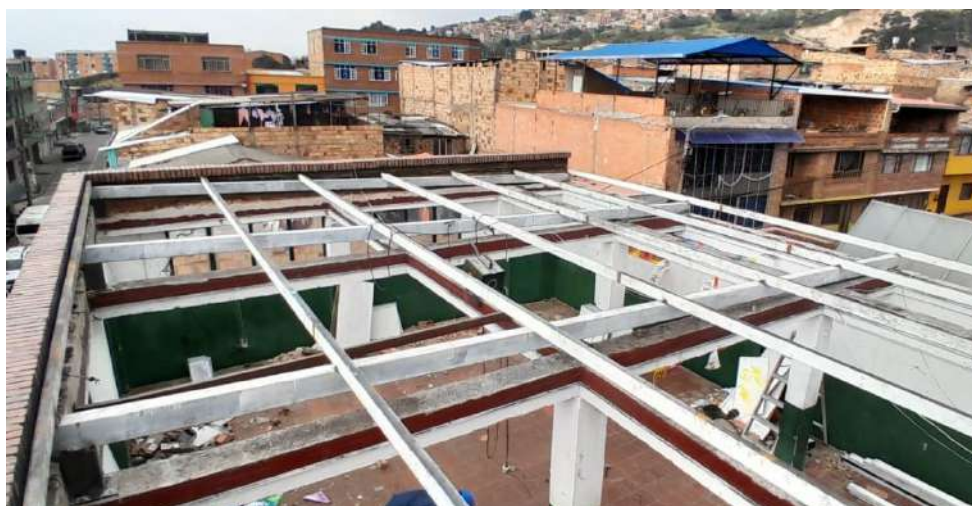
Ilustración 4 Desmonte de cubierta e instalación de estructura.
