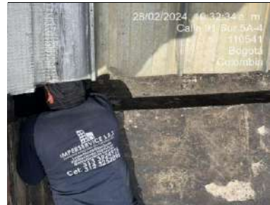
mantenimiento y limpieza de canal
