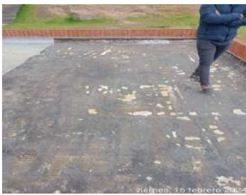
retiro de manto en placa de 1er piso
