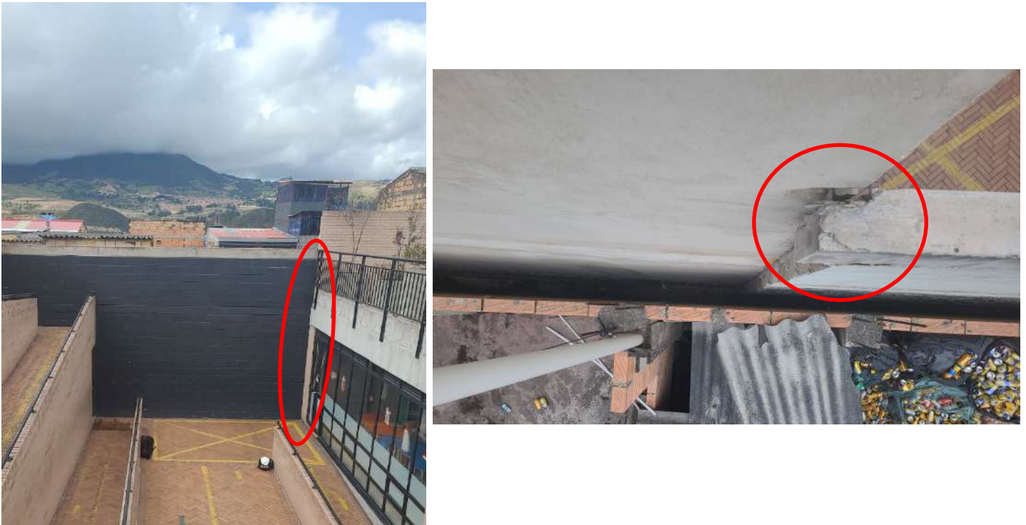
Imagen 1. Muro de cerramiento IED Santa Librada
