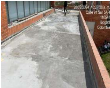
Inducción de fisuras de placa 1
