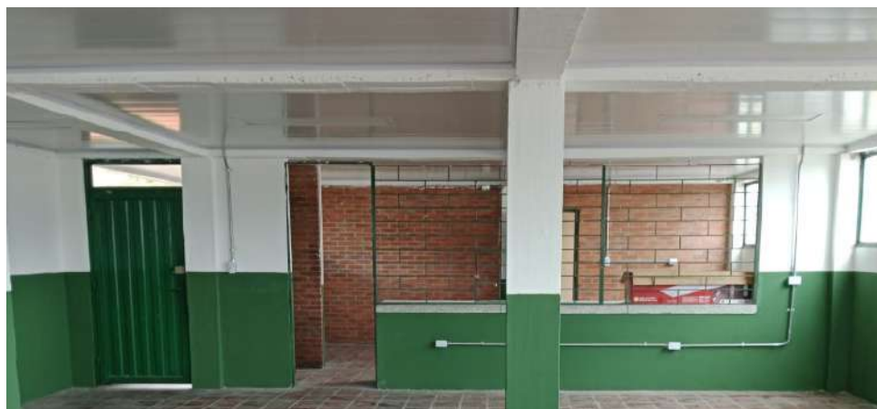
Ilustración 11 Suministro e instalación de pintura tipo vinilo tipo 1 en aulas.
