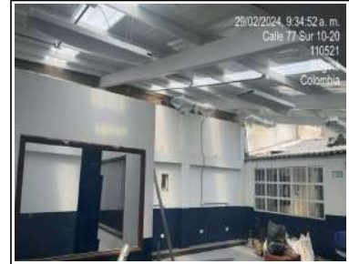
instalación de teja translúcida en cubierta
