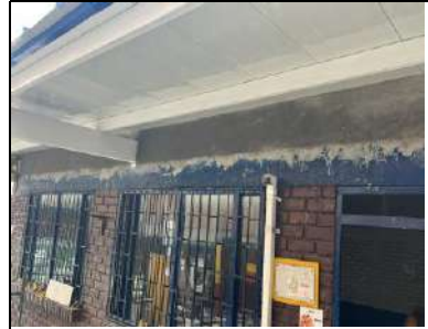
Encorrece de muros
