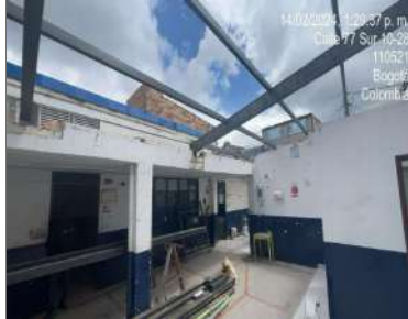
instalación de perfilera metalica en ludoteca
