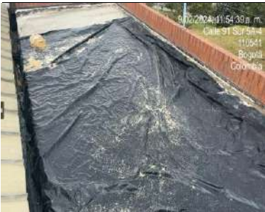
inducción de fisura en placa 2 y afinado
