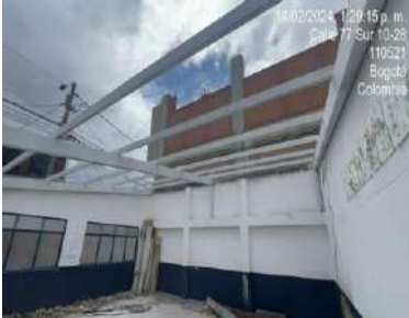
instalación de perfilera metalica en salon No. 6
