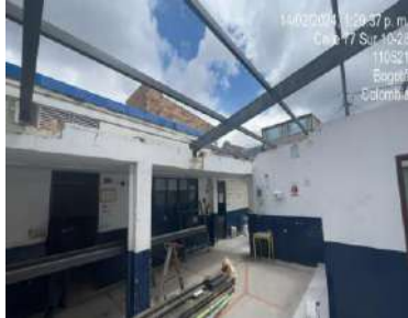
instalación de perfilera metalica en ludoteca
