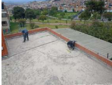
Picado de placa para adherencia
