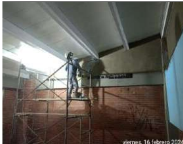
instalación de perfilera y cubierta en salones 304-305-306
