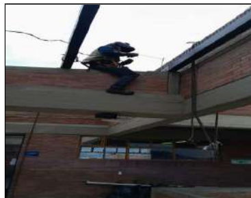
Instalación de perfiles en cubierta
