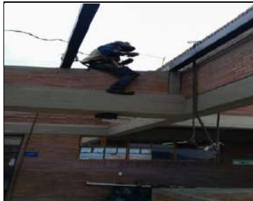
Instalación de perfiles en cubierta
