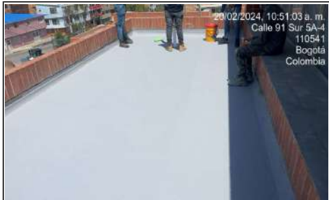
impermeabilización de placa 3
