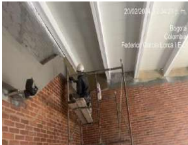
Encoroce de muros
