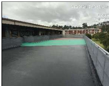
Aplicación de pintura en uretano
