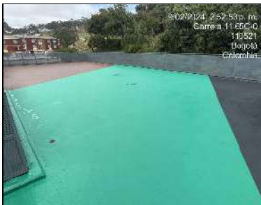
Aplicación de pintura en uretano
