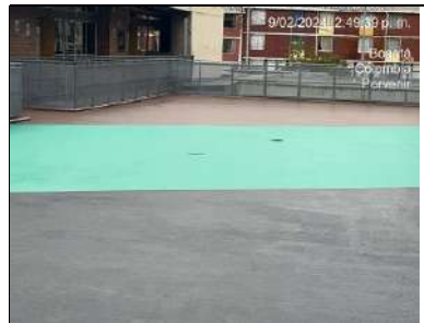
Aplicación de pintura en uretano
