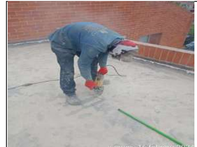
inducción de fisuras de placa 1er piso
