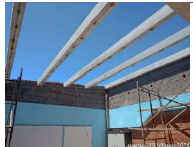
desmonte de cubierta en salones 304-305-306
