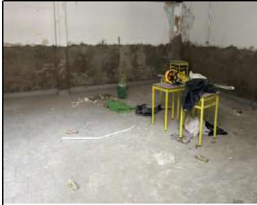
se termina instalación de cubierta del Salon No. 1
