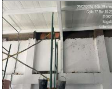
encorizado y pañete
