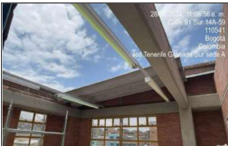
Desmante de cubierta
