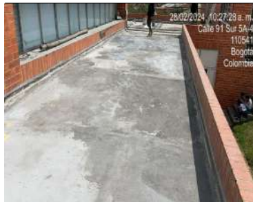
Inducción de fisuras de placa 1
