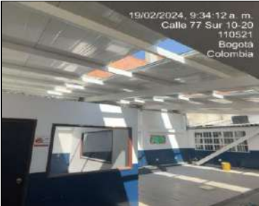
instalación de cubierta de zona de biblioteca
