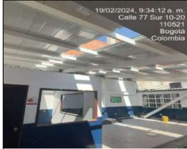
instalación de cubierta de zona de biblioteca
