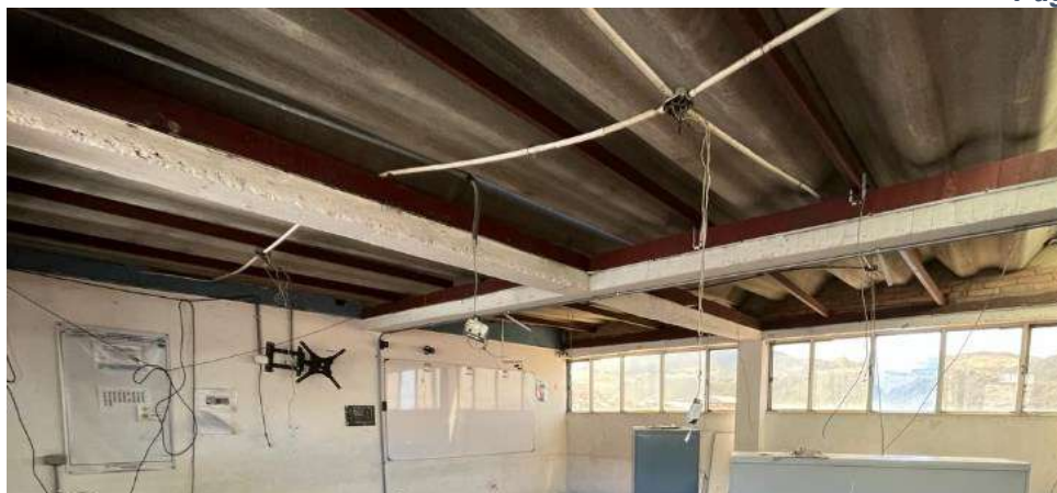
Ilustración 3 Desmonte de cielorraso existente IED santa Martha – Biblioteca.
