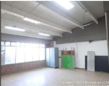
Pintura en salones
