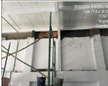
encorizado y pañete
