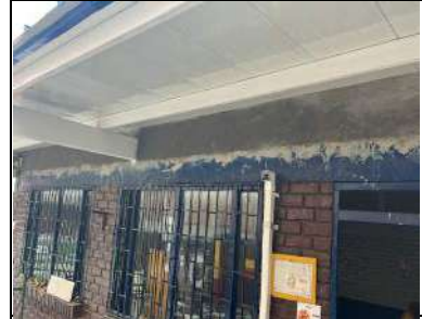
Encorroe de muros
