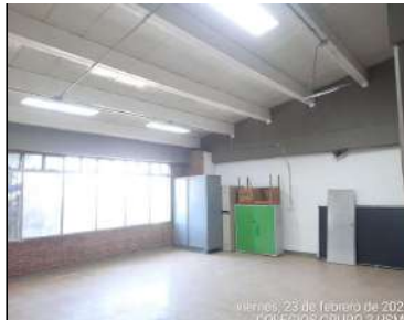
Pintura en salones
