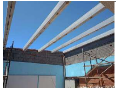
desmante de cubierta en salones 304-305-306
