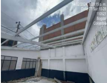
instalación de perfilera metalica en salon No. 6
