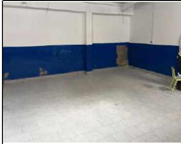
Pintura en salones
