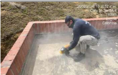
impermeabilización de placa 3
