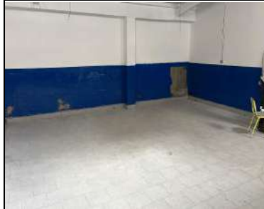
Pintura en salones
