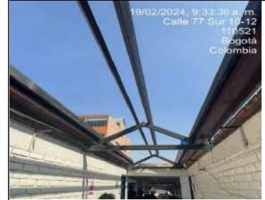
estructura metalica de zona de circulación entrada.
