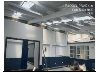
instalación de teja translúcida en cubierta
