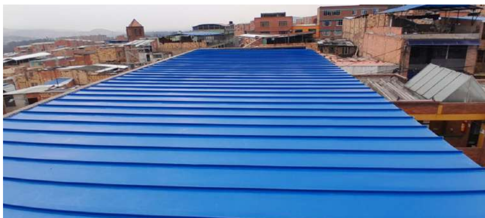
Ilustración 6 Instalación de cubierta tipo sándwich.
