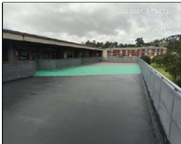
Aplicación de pintura en uretano
