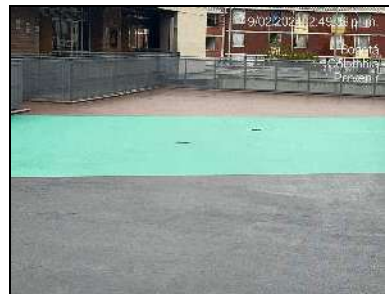
Aplicación de pintura en uretano
