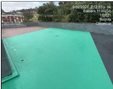
Aplicación de pintura en uretano
