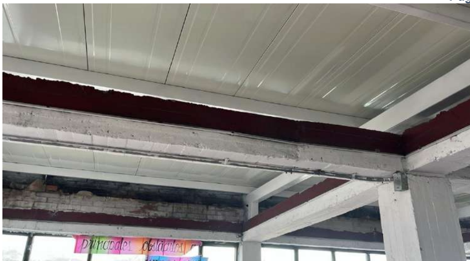
Ilustración 5 Instalación de cubierta tipo sándwich.
