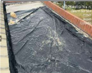
inducción de fisura en placa 2 y afinado
