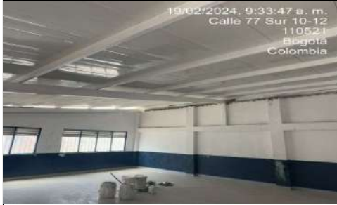
instalación de cubierta aula No. 6
