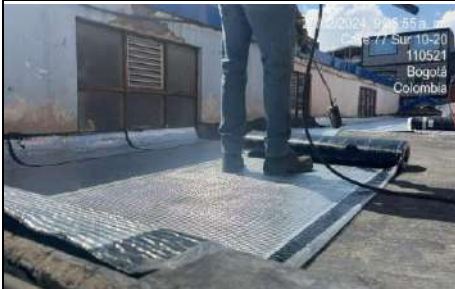
instalación de manto en placa de cubierta
