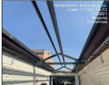
estructura metalica de zona de circulación entrada.
