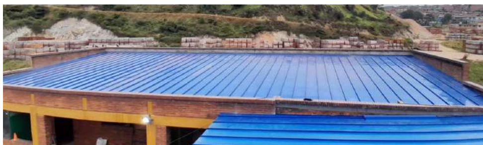
Ilustración 7 Instalación de cubierta tipo sándwich.
