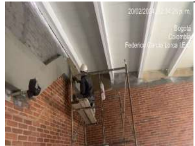
Encoroco de muros
