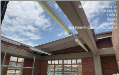
Desmante de cubierta
