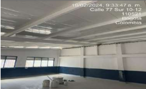
instalación de cubierta aula No. 6
