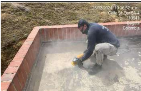
impermeabilización de placa 3
