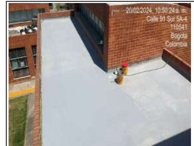
impermeabilización de placa 2
