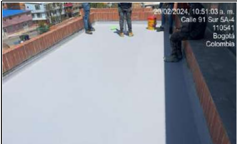
impermeabilización de placa 3
