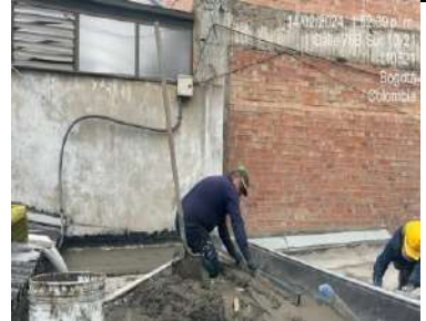
Afinado de piso en mortero impermeabilizado
