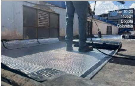
instalación de manto en placa de cubierta
