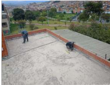
Picado de placa para adherencia
