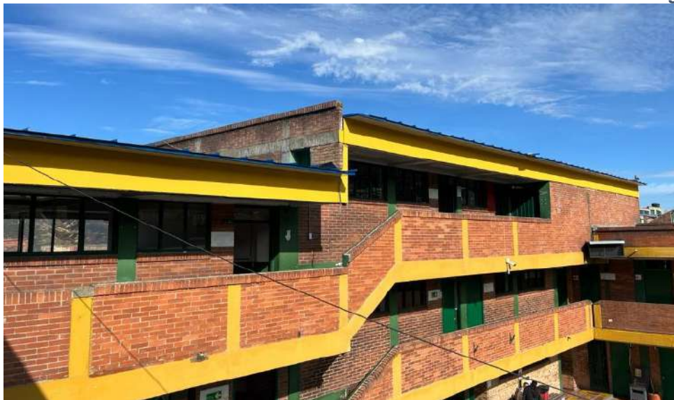
Ilustración 8 Instalación de superboard perímetro.
