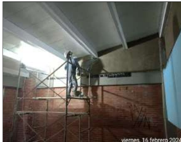
instalación de perfilera y cubierta en salones 304-305-306
