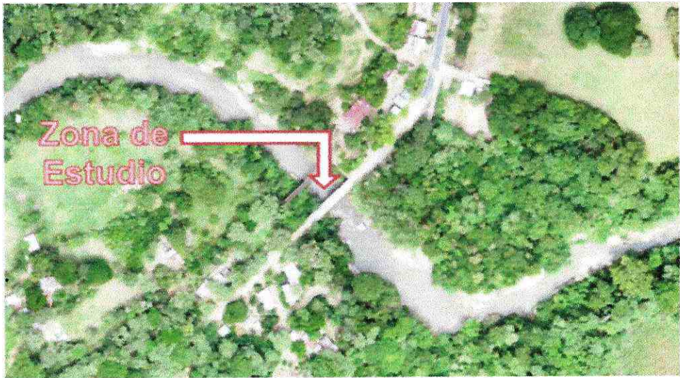
Ilustración 1.3. Ubicación Puente sobre el Río Venadillo en el corredor vial Palobayo – Ambalema
