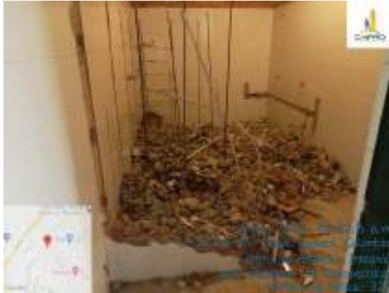
DEMOLICIÓN ENCHAFE Y MUROS DIVISORIO EN BAÑO 1 Y 3.
