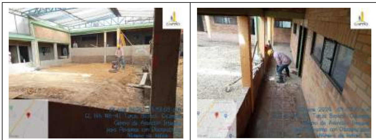
NIVELACIÓN CON MATERIAL GRANULAR (RECEBO) Y DEMOLICIÓN ENCHAPE PISO
