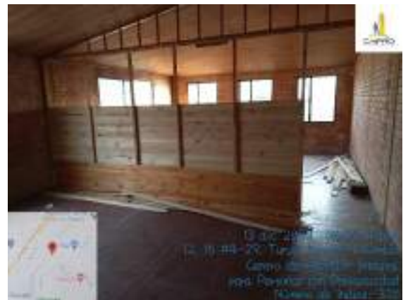
DESMONTE DE DIVISIONES EXISTENTES
