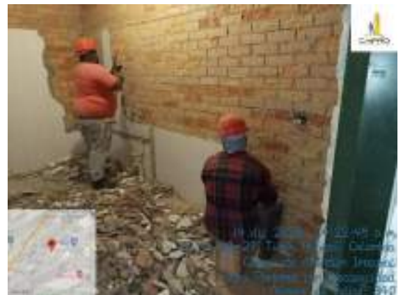
DESMONTE DE DIVISIONES EXISTENTES
