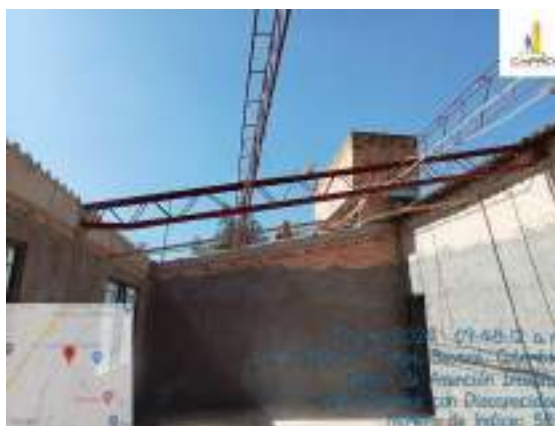
REGATAS E INSTALACIÓN DE TUBERÍA Y CAJAS ELÉCTRICAS – DESMONTE DE TEJAS DE ASBESTO CEMENTO.
