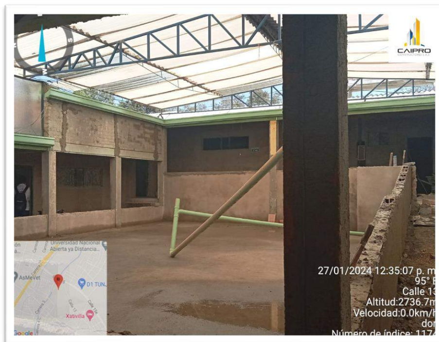
REGISTRO FOTOGRÁFICO 1 DE OBRA
