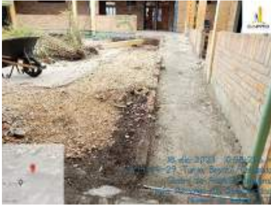
DEMOLICIÓN DE MESONES Y PLACA DE CONTRAPISO PATIO CENTRAL
