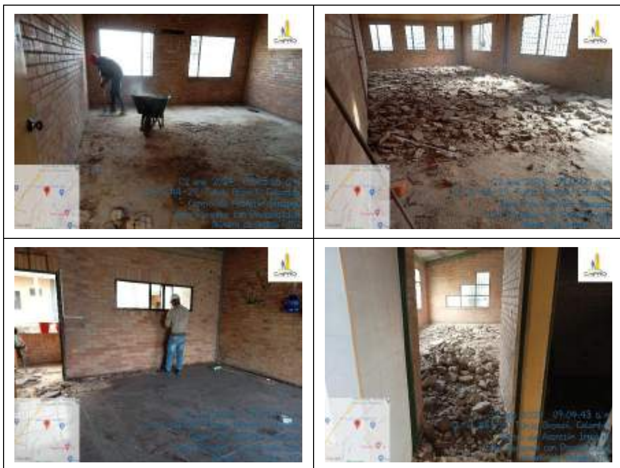
NIVELACIÓN CON MATERIAL GRANULAR (RECEBO) Y DEMOLICIÓN ENCHAPE PISO
