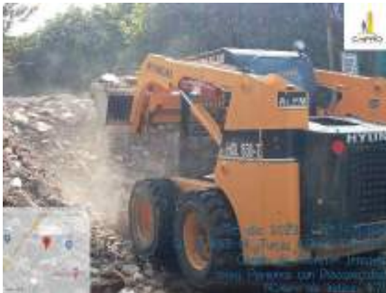
DEMOLICIÓN DE MESONES Y PLACA DE CONTRAPISO PATIO CENTRAL
