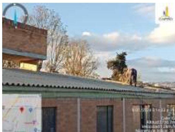
REGATAS E INSTALACIÓN DE TUBERÍA Y CAJAS ELÉCTRICAS – DESMONTE DE TEJAS DE ASBESTO CEMENTO.
