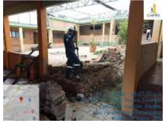
DEMOLICIÓN DE MESONES Y PLACA DE CONTRAPISO PATIO CENTRAL
