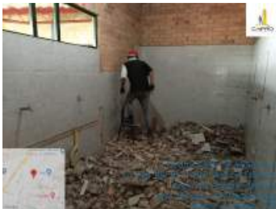
DESMONTE DE DIVISIONES EXISTENTES
