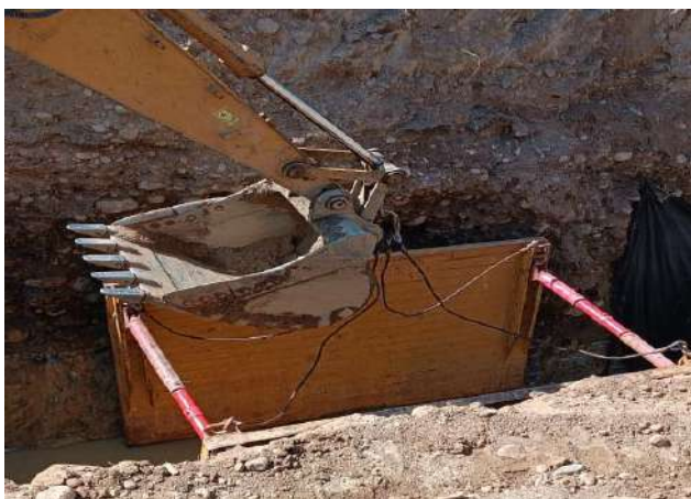
Instalacion de contencion metalica
