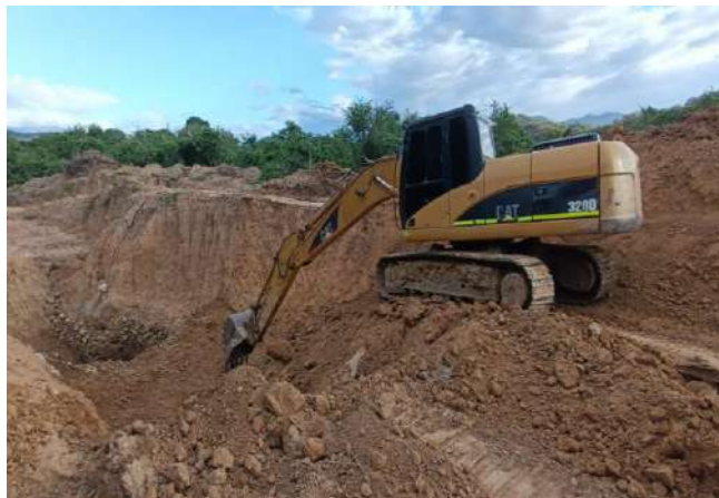
Excavacion con Maquinaria
