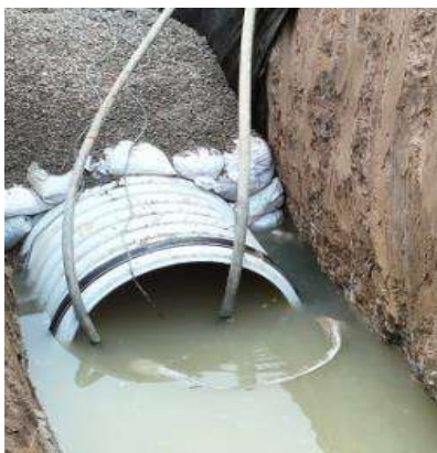
Instalacion de motobombas, Para manejo de Aguas
