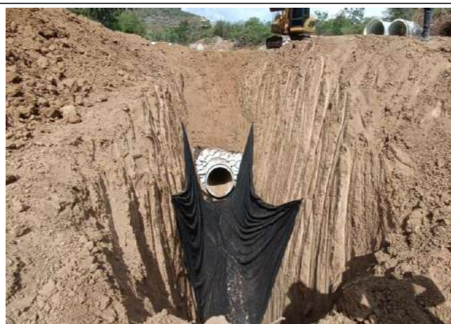
Instalacion de geotextil
