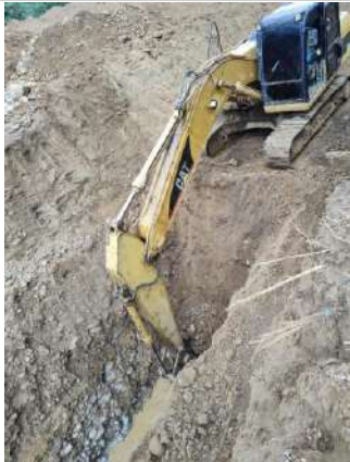
Excavacion >4m
