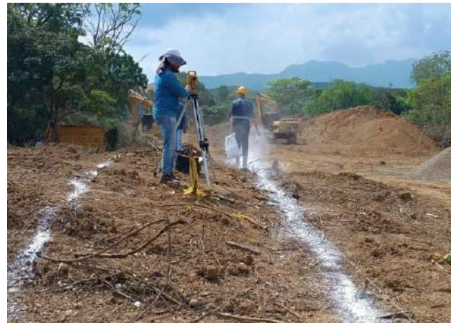
nivelación y replanteo
