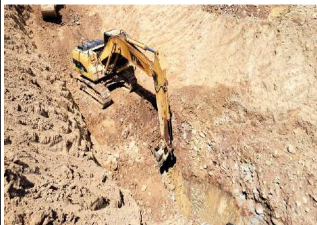
excavacion materiales arcillosos
