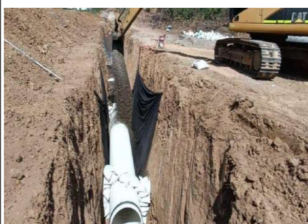
Relleno con triturado 3/4"
