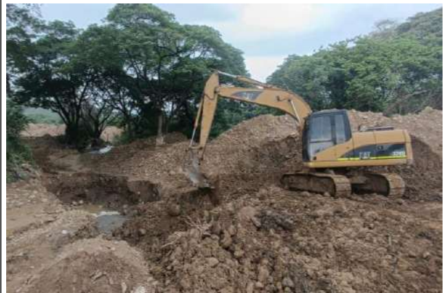
Adecuación con Maquinaria
