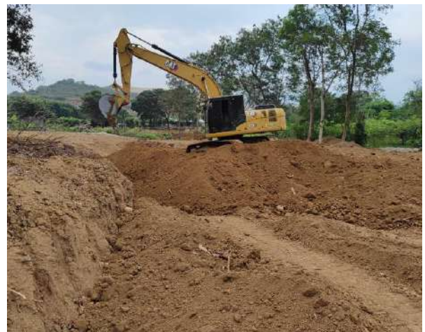
Adecuación con Maquinaria
