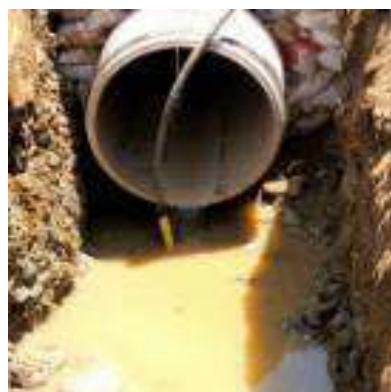
Instalacion de motobombas, Para manejo de Aguas
