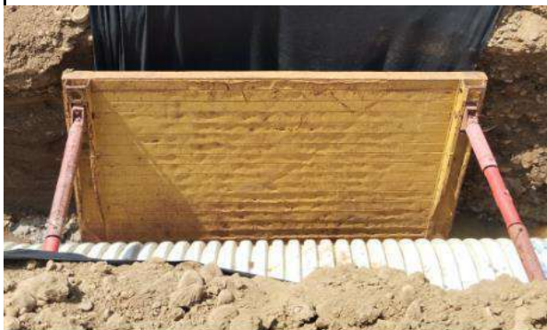
Instalacion de Tuberia PVC de 48"
