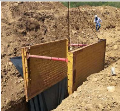
Instalacion de Tuberia PVC de 48"
