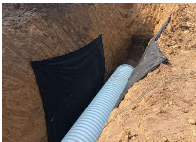
Instalacion de geotextil
