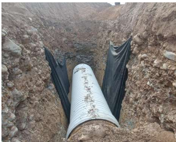
Instalacion de tuberia sanitaria
