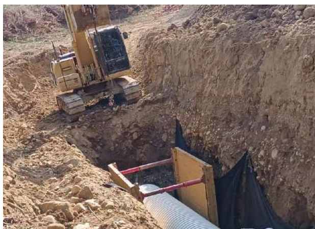
Instalacion de contencion metalica
