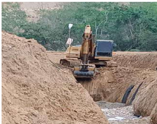
Excavacion con Maquinaria
