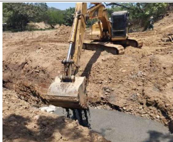
Instalacion en Concreto Ciclopeo
