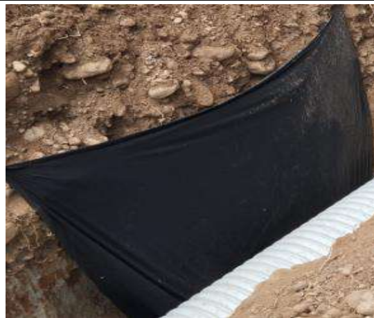
Instalacion de geotextil
