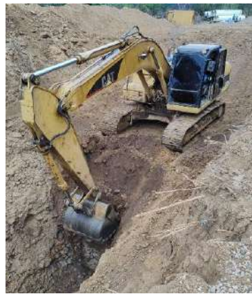
Excavacion entre 2m y 4m
