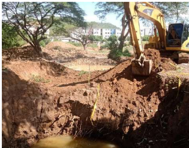
excavacion materiales arcillosos
