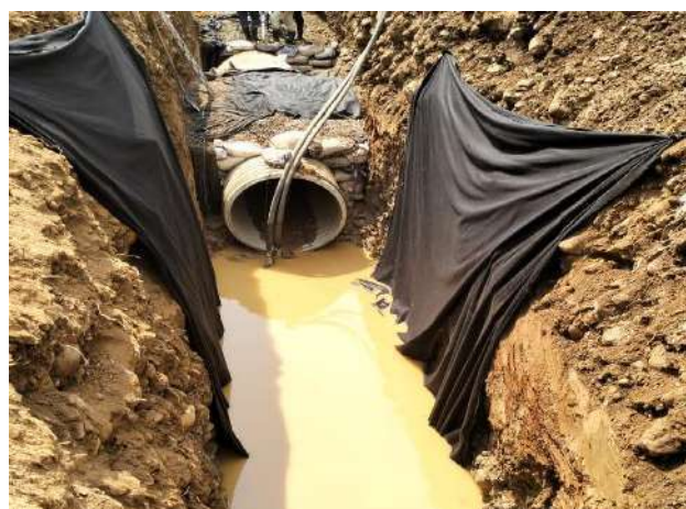
Instalacion de geotextil
