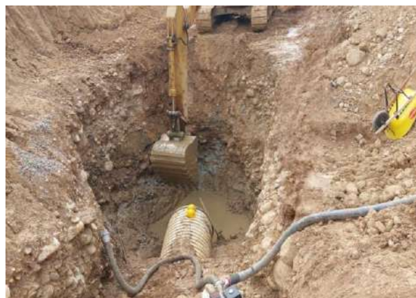
excavacion materiales arcillosos
