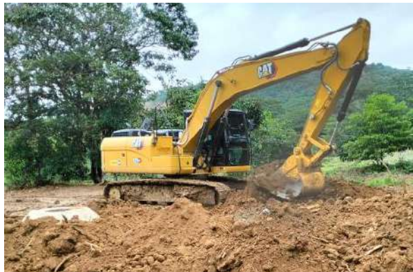
Relleno Con Material Seleccionado
