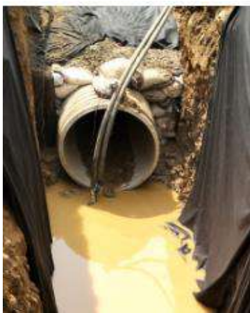
Instalacion de motobombas, Para manejo de Aguas
