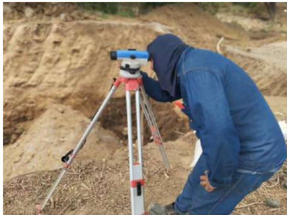
Nivelacion Y Replanteo
