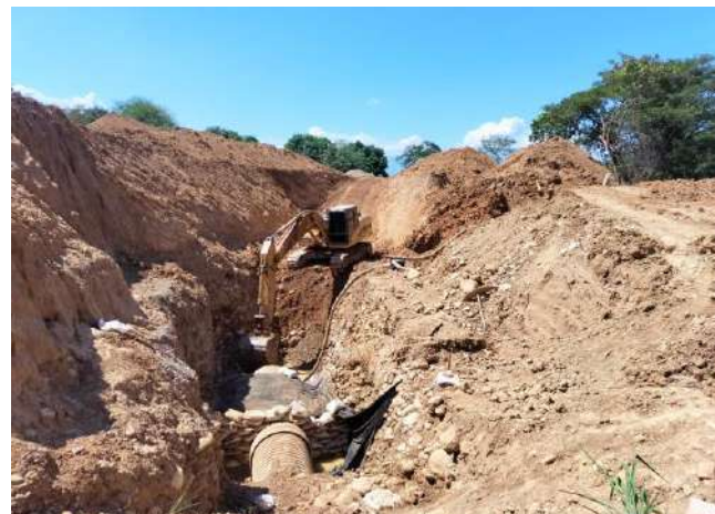
Excavacion con Maquinaria
