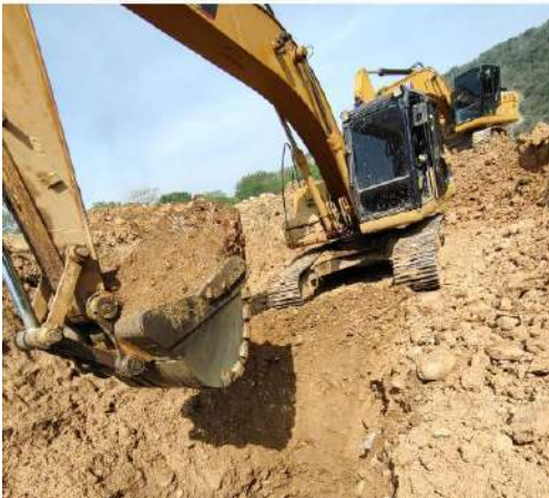
Excavacion entre 2m y 4m
