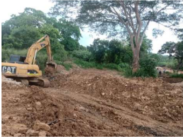
Adecuación con Maquinaria
