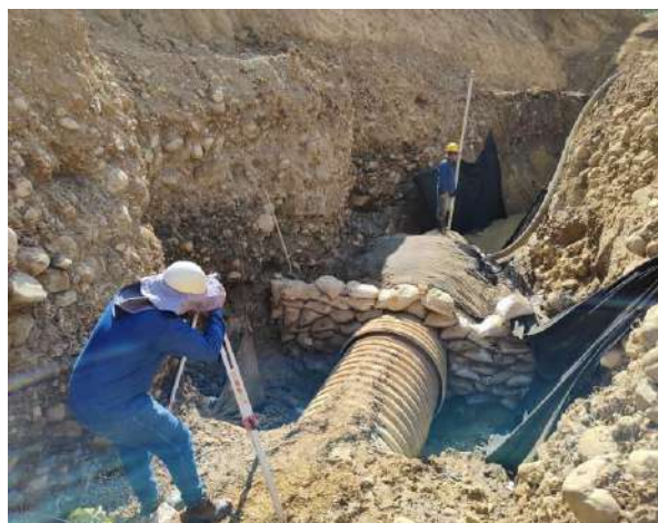
nivelación y replanteo
