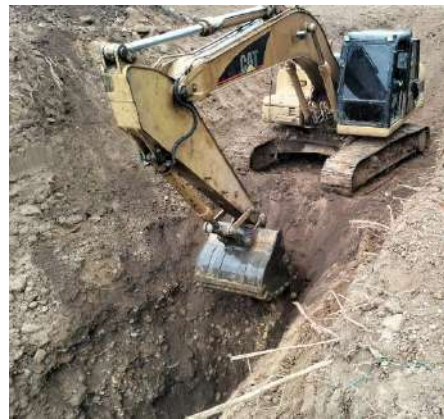
Excavacion >4m
