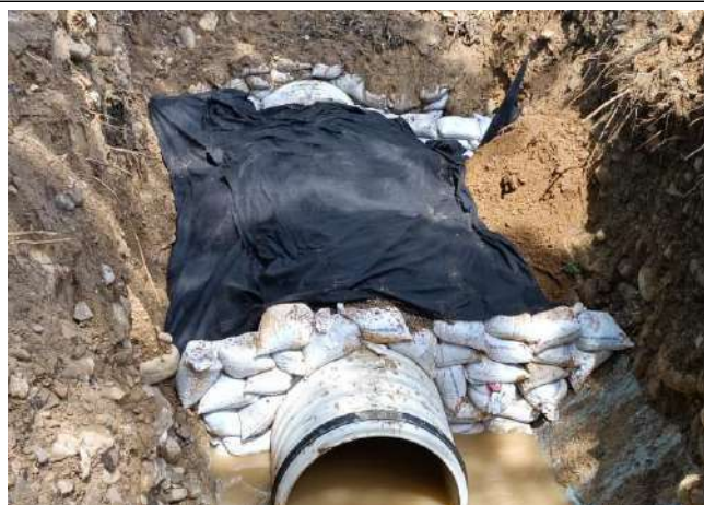
Instalacion de tuberia sanitaria
