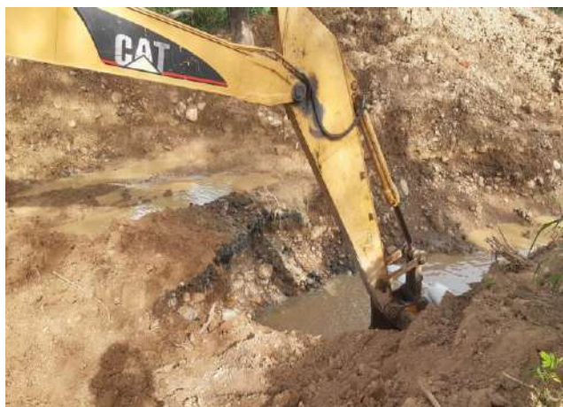
Excavacion con Maquinaria
