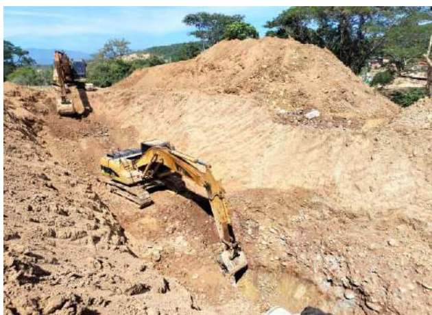
Excavacion con Maquinaria
