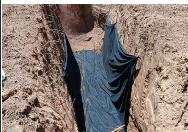
Instalacion de geotextil
