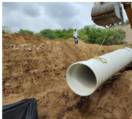
Instalacion tuberia de 54"
