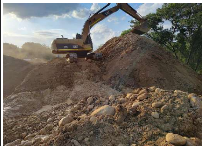
Adecuación con Maquinaria
