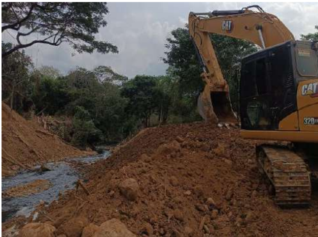
Adecuación con Maquinaria
