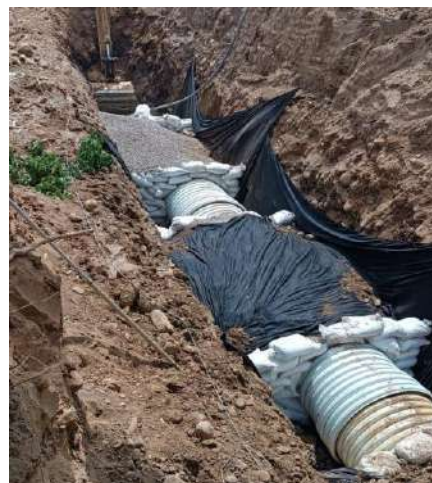
Relleno con triturado 3/4"
