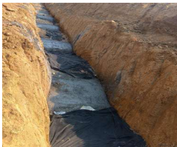
Anclaje en concreto ciclopeo
