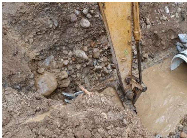
Excavacion con Maquinaria
