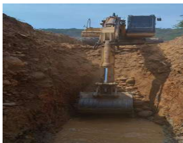
Excavacion con Maquinaria
