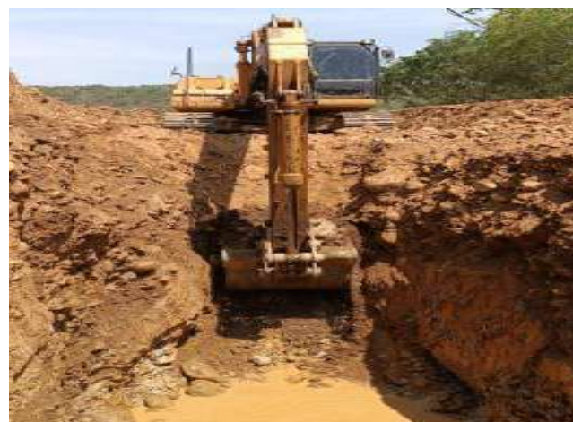
Excavacion con Maquinaria
