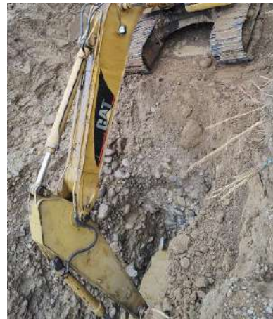
Excavacion entre 2m y 4m
