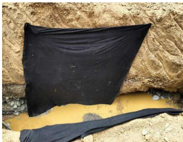
Instalacion de geotextil
