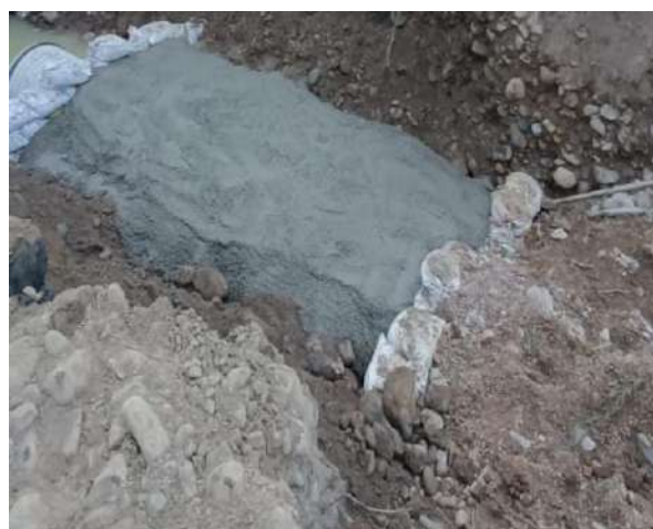
Anclaje en concreto ciclopeo
