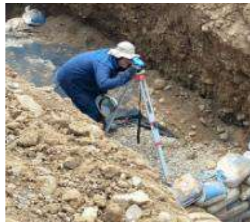
Nivelacion Y Replanteo
