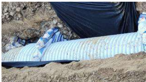
Instalacion de geotextil
