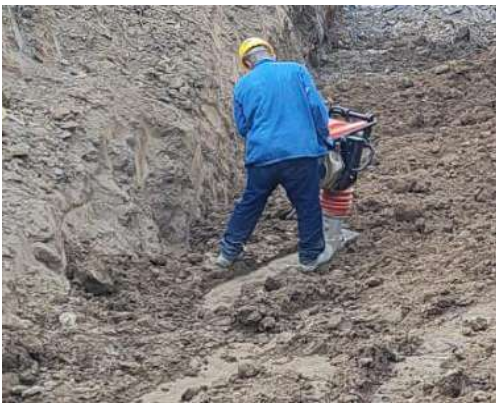
Relleno Con Material Seleccionado
