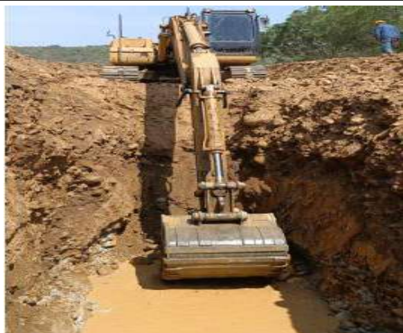
Excavacion con Maquinaria
