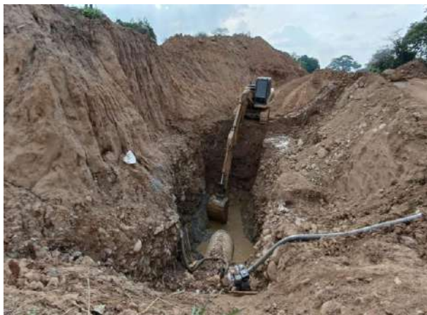
Excavacion con Maquinaria
