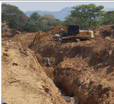
Relleno Con Material Seleccionado
