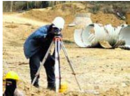
Nivelacion Y Replanteo
