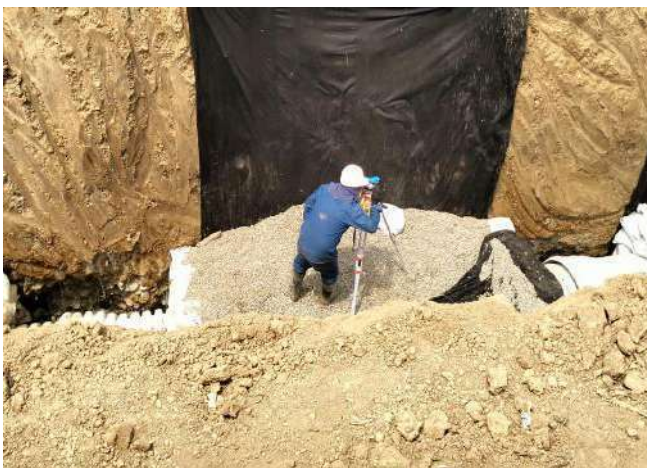
chequeo nivelacion de tuberia
