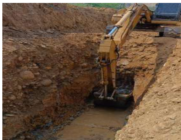
Excavacion con Maquinaria
