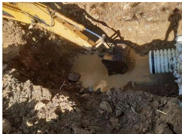
excavacion materiales arcillosos
