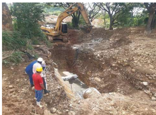
nivelación y replanteo
