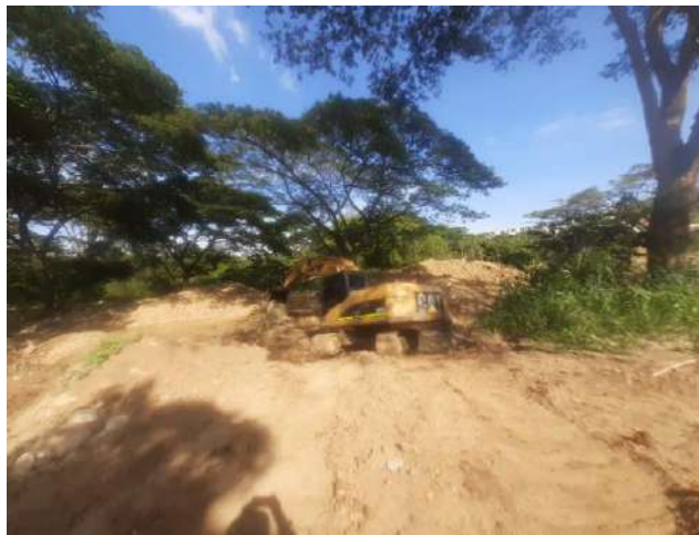
Adecuación con Maquinaria
