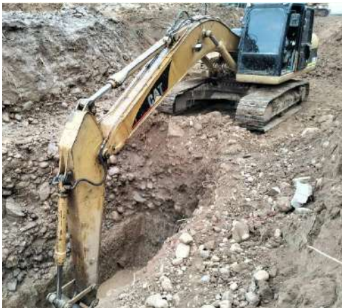
Excavacion >4m
