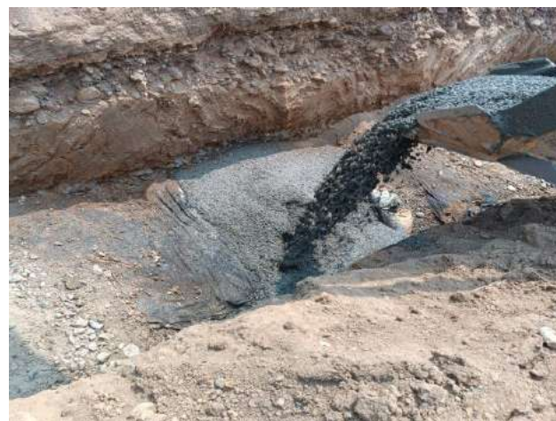
Anclaje en concreto ciclopeo
