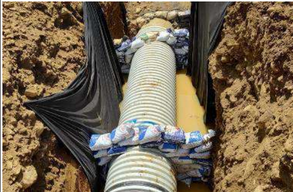
Instalacion tuberia de 54"
