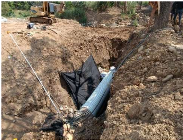
Instalacion de tuberia sanitaria
