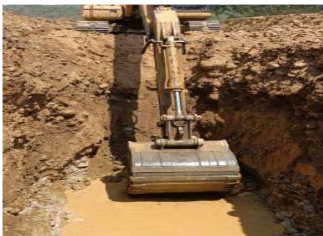
Excavacion con retroexcavadora 320D
