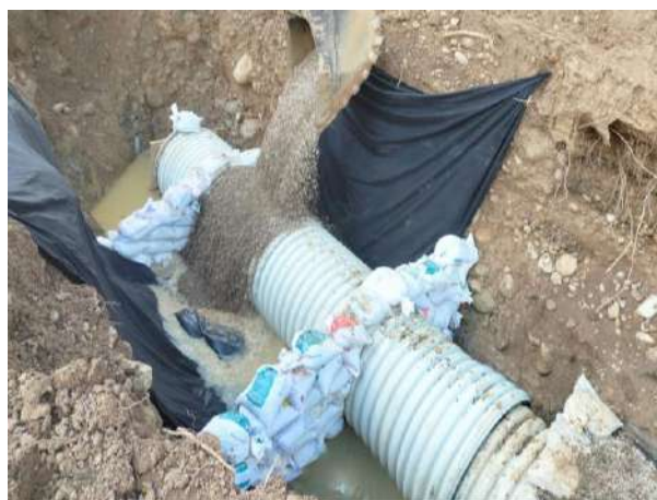
Instalacion de tuberia sanitaria
