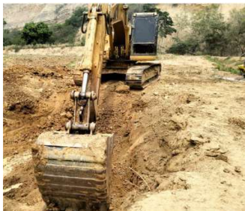
Excavacion < 2m
