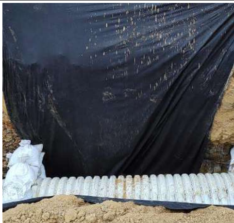
Instalacion de geotextil
