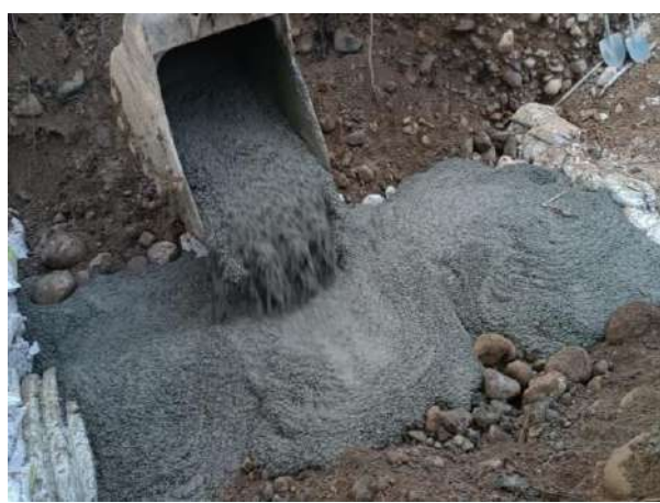
Anclaje en concreto ciclopeo
