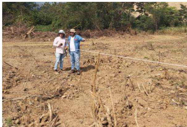
Nivelacion Y Replanteo
