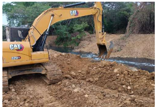
Adecuación con Maquinaria
