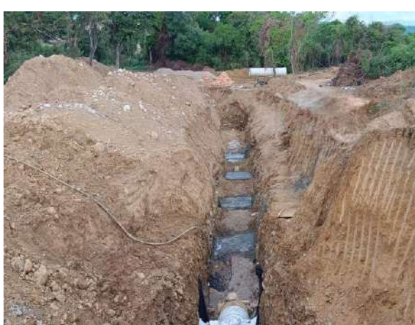
Anclaje en concreto ciclopeo
