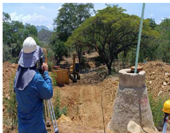
nivelación y replanteo
