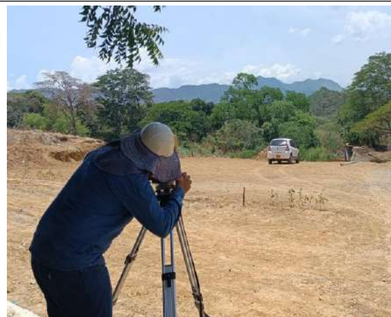
nivelación y replanteo
