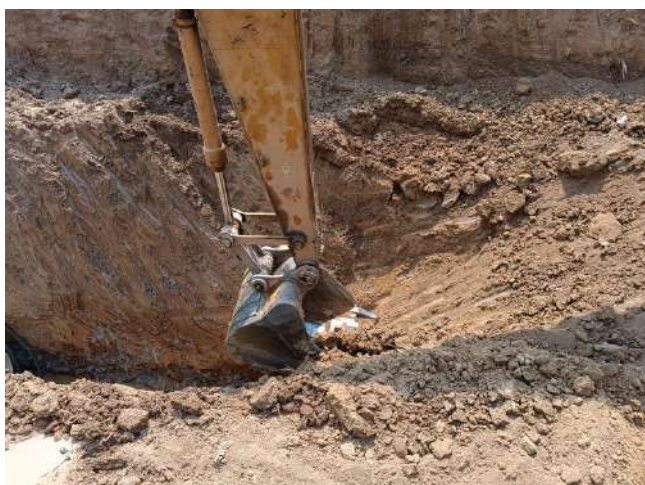
Excavacion con Maquinaria
