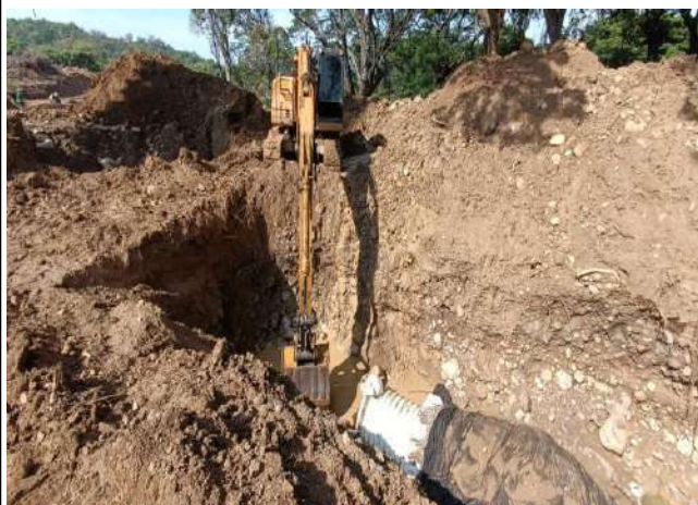
Excavacion con Maquinaria
