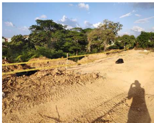
Señalización Seguridad doble linea
