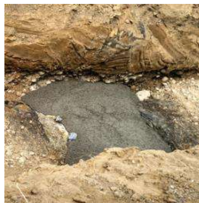
Instalacion en Concreto Ciclopeo
