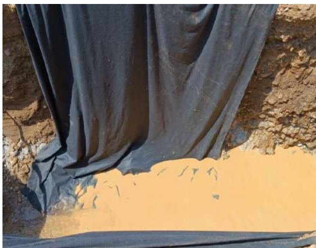
Instalacion de geotextil
