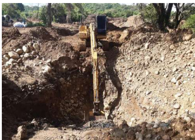
Excavacion con Maquinaria
