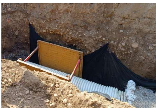
Instalacion de contencion metalica
