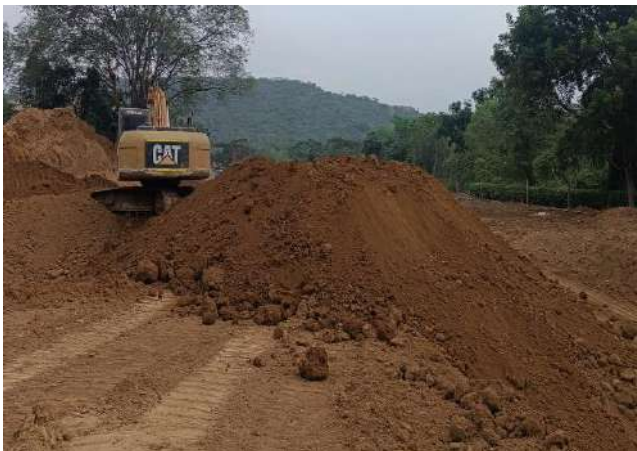
Adecuación con Maquinaria
