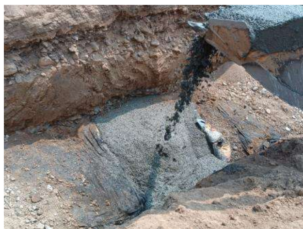
Anclaje en concreto ciclopeo
