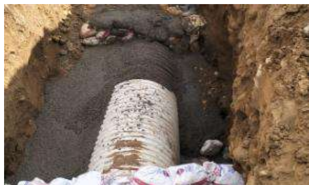
Instalacion en Concreto Ciclopeo
