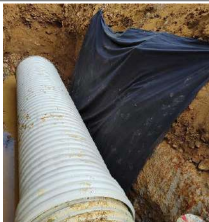
Instalacion tuberia de 54"
