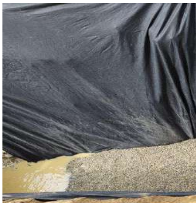
Instalacion de geotextil
