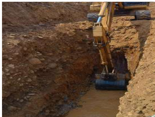
Excavacion con retroexcavadora 320D
