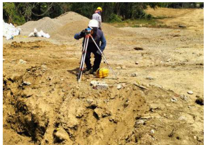
chequeo nivelacion de tuberia
