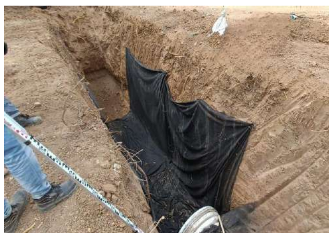
Instalacion de geotextil
