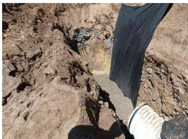
Relleno con triturado 3/4"
