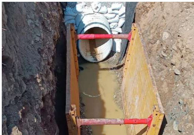
Instalacion de contencion metalica
