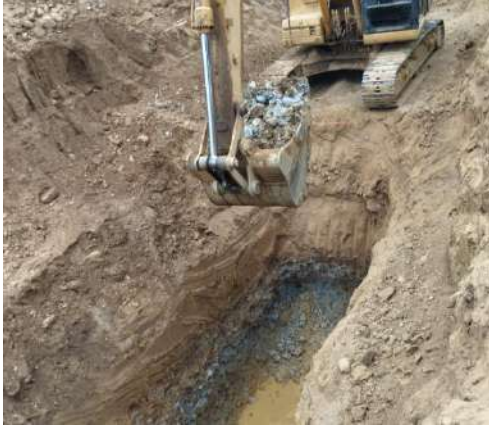
Excavacion entre 2m y 4m
