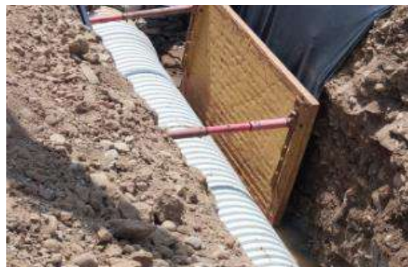
Instalacion de Tuberia PVC de 48"
