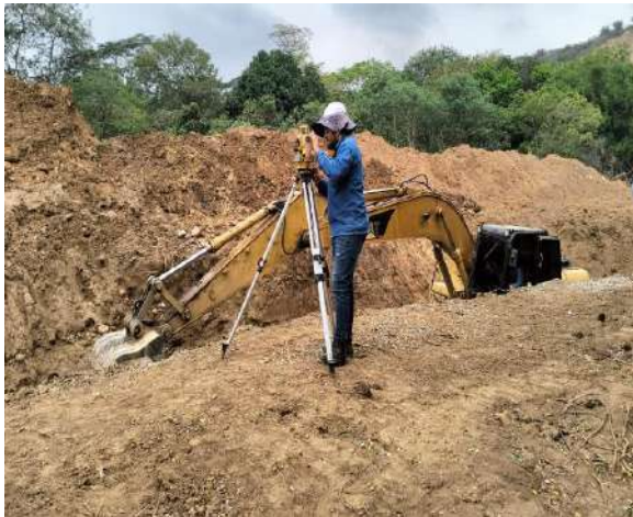
nivelación y replanteo
