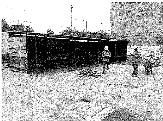
Ilustración 9 Construcción de campamento.
