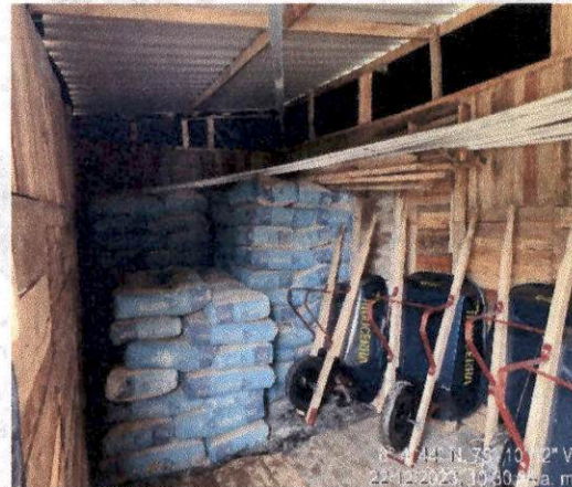
Foto 90 Verificación instalaciones temporales y acopio de materiales.
