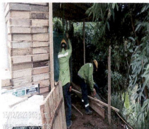
Foto 37. Adecuación de caseta para residuos en el campamento K19+450.
