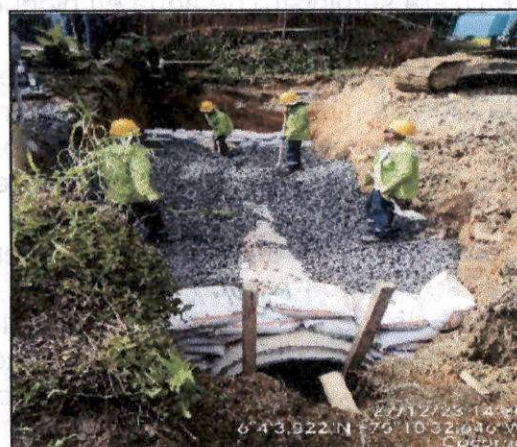
Foto 44 Instalación tubería 900 mm K1+743
