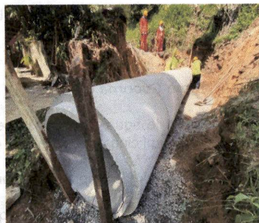
Foto 42 . Instalación tubería 900 mm K1+557
