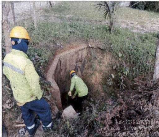
Foto 45. Mantenimiento (limpieza) de obras transversales.
