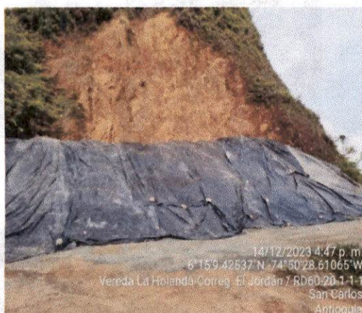
Foto 21. Zona de acopio de materiales K19+625 recubierta con plástico.
