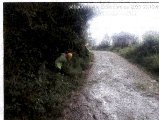
Foto 62 Actividad de desmonte manual.
