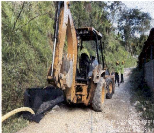
Foto 89 Verificación maquinaria en frentes de obra
