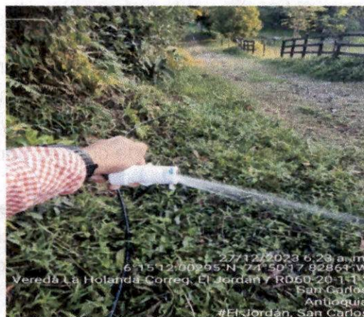
Foto 58. Funcionamiento de punto de captación de agua K19+250.
