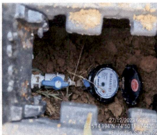
Foto 57. Instalación de micromedidor de agua K19+250.
