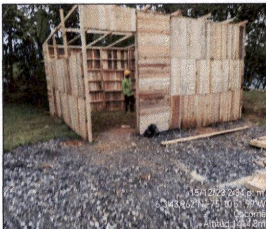
Foto 15 Acondicionamiento sitio para almacén
