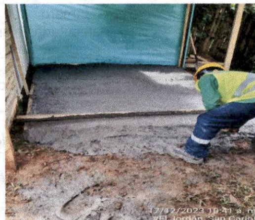
Foto 70. Loza de concreto para centro de acopios de residuos sólidos K19+640 (derecho).
