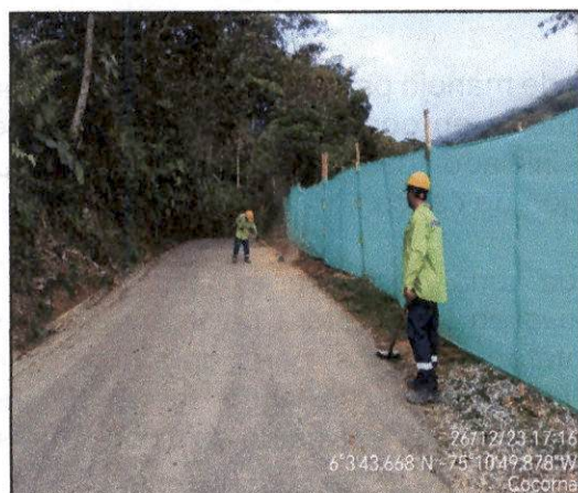
Foto 43 Jornada de barrido de vía pavimentada Acopio 1.
