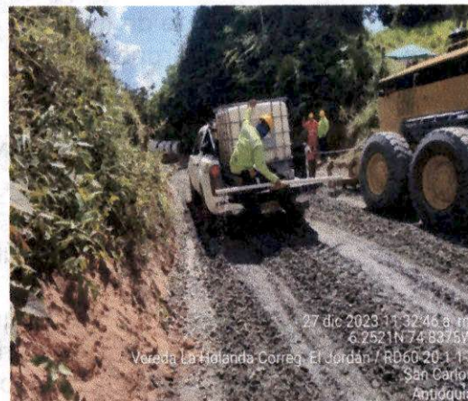
Foto 78. Prueba de irrigación con mecanismo artesanal.
