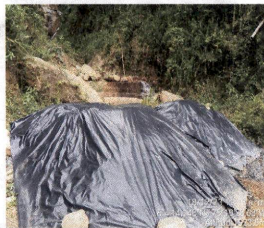
Foto 20 Acopio temporal sub base cubierto con plástico.
