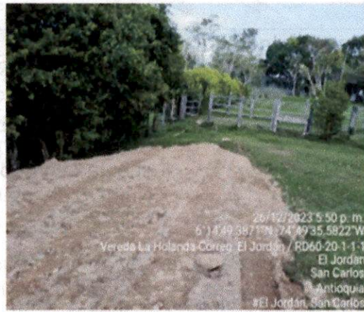
Foto 30. Nivelación de terreno en el predio "Feria Ganadera".
