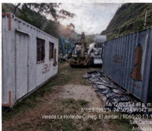
Foto 67. Zona destinada a funcionamiento de campamento y almacén K19+640 (derecho).
