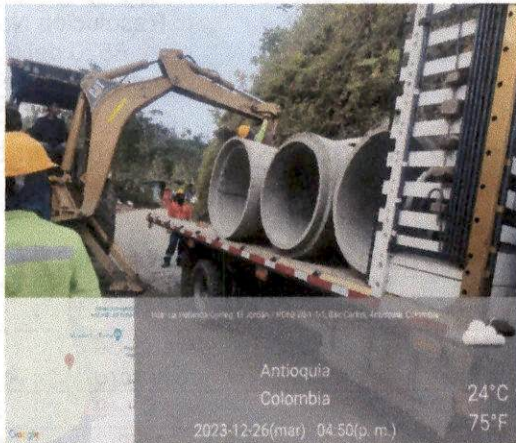
Foto 25. Llegada de prefabricado (tubería) a la obra para el reemplazo de la K19+020.
