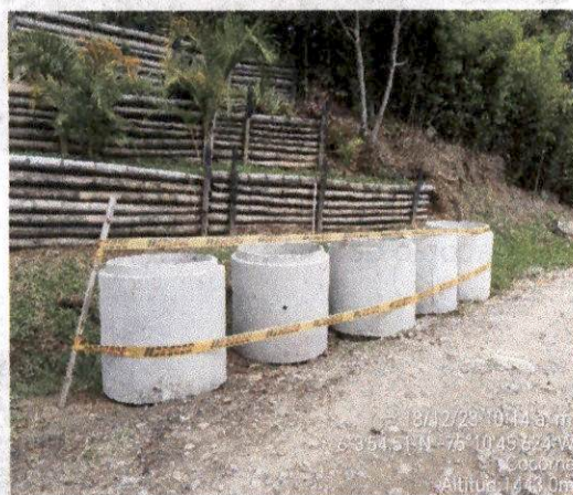
Foto 19 Señalización acopio temporal tubería.
