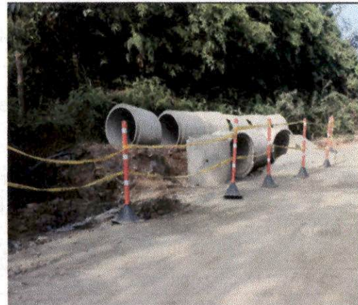
Foto 26. Tuberías señalizadas.
