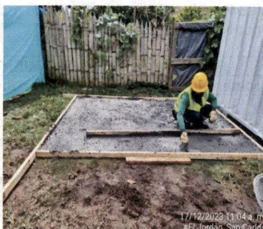
Foto 40. Vaciado de concreto para piso de caseta de Sustancias Químicas K19+450.
