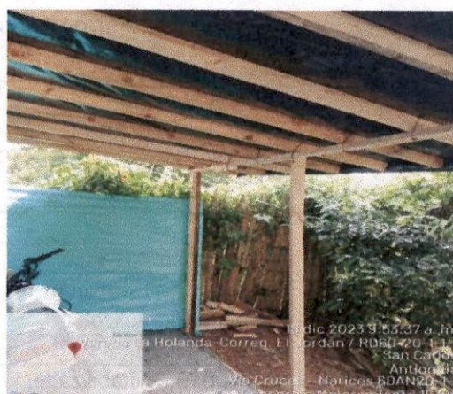
Foto 38. Techado de caseta para residuos en el campamento K19+450.
