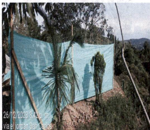
Foto 23. Aislamiento de la zona de acopio del K19+180.
