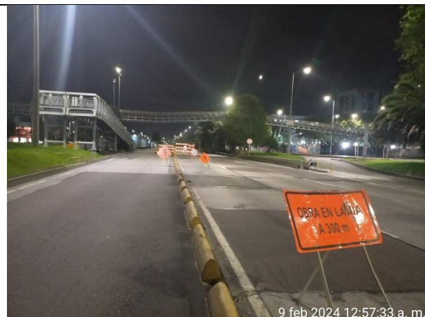
Prado, Seguimiento y verificación PMT
