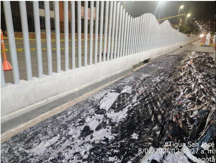
Tigua San José, protección plástico Puntura de tubos cerramiento perimetral.
