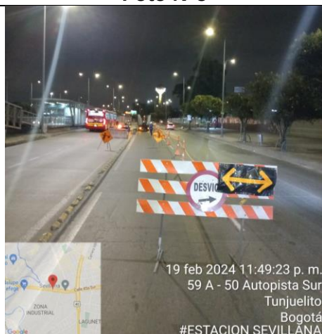
Sevillana, Seguimiento y verificación PMT
