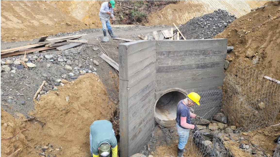
K1+600 Vía terciaria Colón – Vergel de Fátima, Municipio de Colón. CABEZOTE DE SALIDA DE ALCANTARILLA TERMINADO, INICIO CONSTRUCCIÓN CANAL DE DESCOLE.
