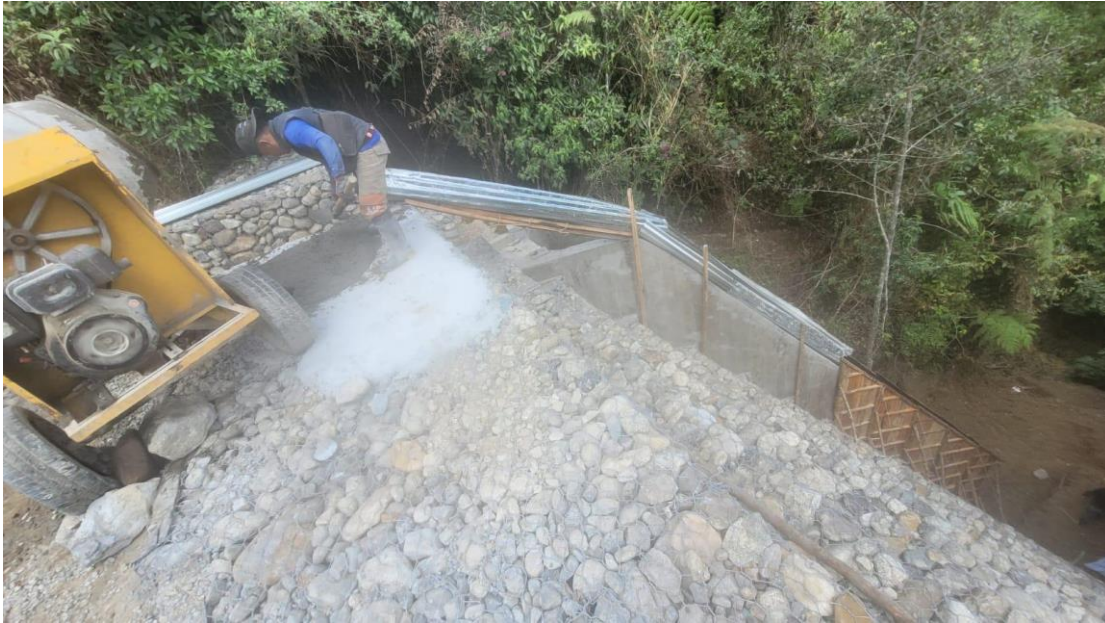
K1+600 Vía terciaria Colón – Vergel de Fátima, Municipio de Colón. PROCESO CONSTRUCTIVO DISIPADOR DE ENERGÍA.
