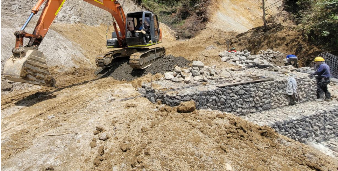
K1+600 Vía terciaria Colón – Vergel de Fátima, Municipio de Colón CONSTRUCCIÓN DE GAVIONES EN NIVEL DE CORONA DE LA ESTRUCTURA DE CONTENCIÓN, INSTALACIÓN DE MATERIAL DE AFIRMADO EN LA CALZADA.
