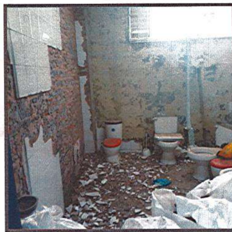
DESMONTE DE APARATOS SANITARIOS Y DEMOLICION DE ENCHAPE MURO/PISO
