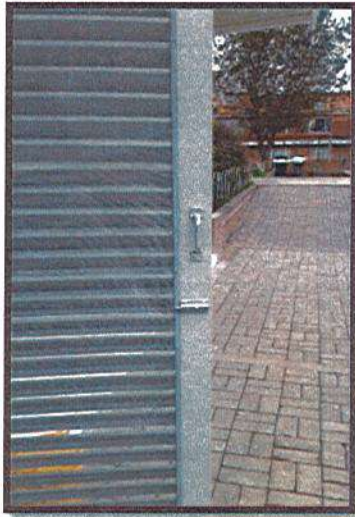
INSTALACION DE MANIJA PARA PUERTA CUARTO DE REFRIGERIOS
