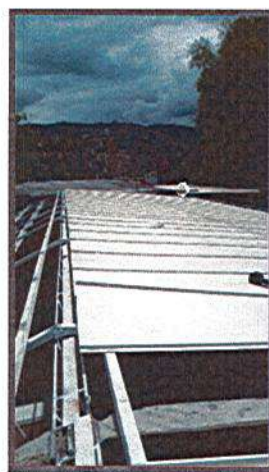
MONTAJE DE PANELES DE CUBIERTA TIPO SANDWICH
