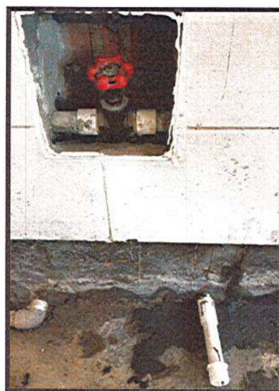
ADECUACIÓN REGISTRO Y PUNTO HIDRÁULICOS
