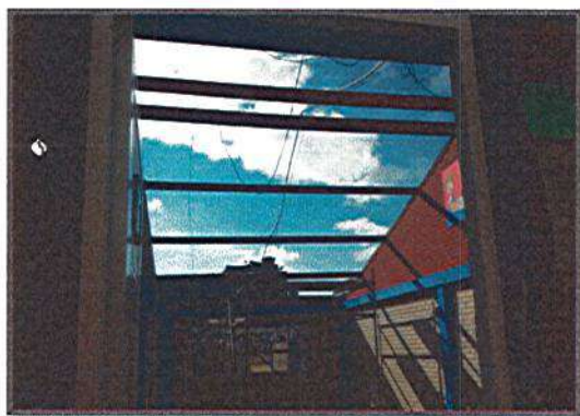
DESMONTE DE CUBIERTA
