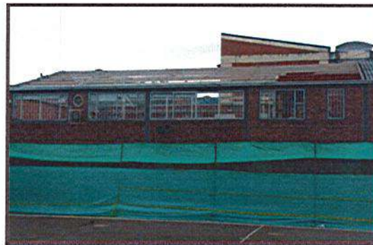
INSTALACIÓN DE MAMPARA
