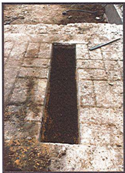
EXCAVACIÓN MANUAL PARA RED SANITARIA
