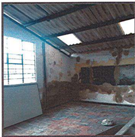
RESANE Y DILATACIONES DE FISURAS EN MUROS
