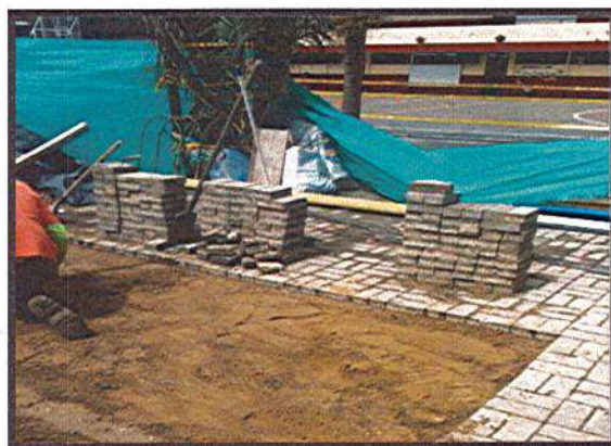
MEJORAMIENTO DE MATERIAL BASE ANTES DE SENTAR ADOQUÍN
