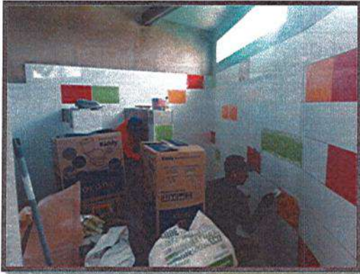
EMBOQUILLADO DE ENCHAPES PARA MUROS
