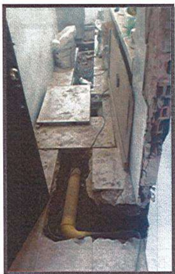
REPOSICION DE TUBERIA HIDROSANITARIA
