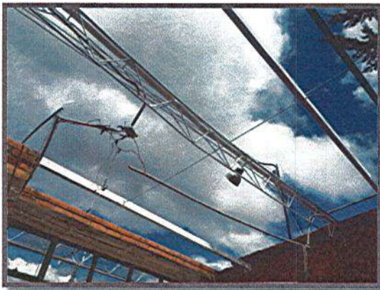
PINTURA DE PERFILERIA METALICA
