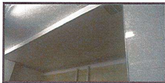
PINTURA DE TECHO EN COCINA
