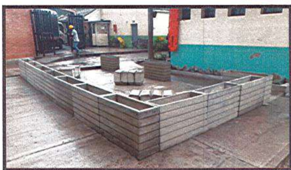
INSTALACION DE MATERAS Y BANCAS EN CONCRETO
