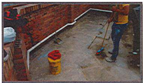
LIMPIEZA DE CUBIERTA
