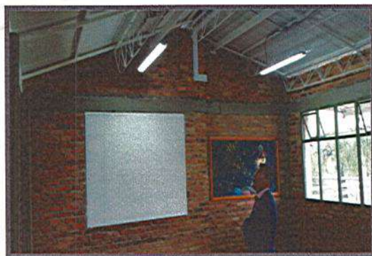
INSTALACIÓN DE SUPERBOARD EN VENTANA
