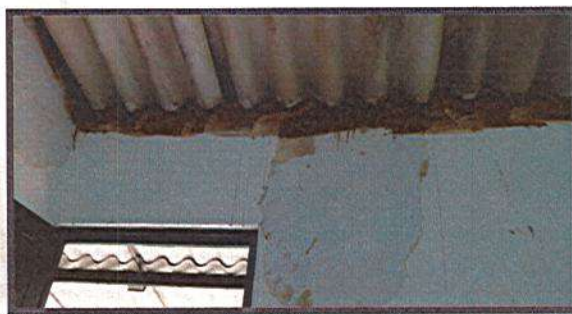
RESANE DE FISURAS EN MUROS
