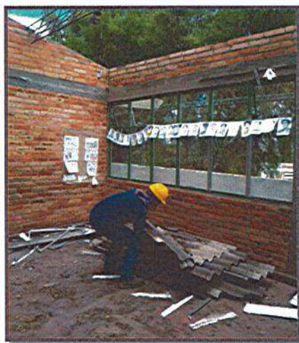
RETIRO DE CUBIERTA
