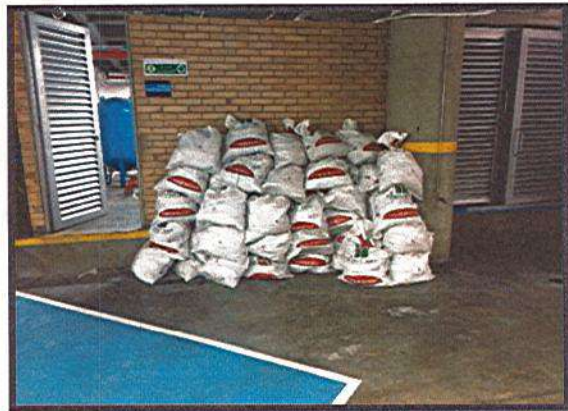
RETIRO DE ESCOMBRO
