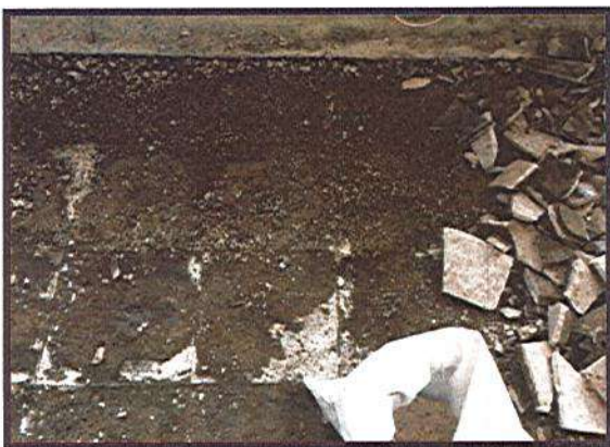
DEMOLICIÓN DE BALDOSA
