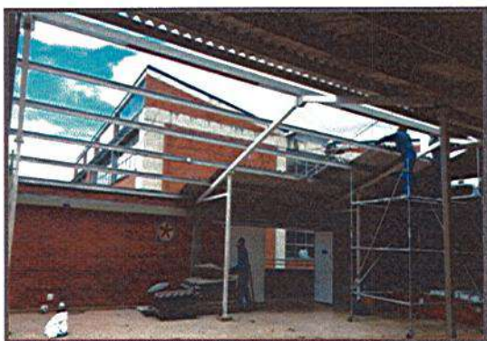
DESMONTE DE CUBIERTA
