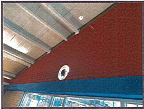
LIMPIEZA DE MUROS
