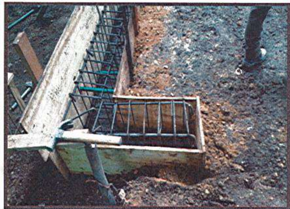
FIGURADO DE ACERO Y ENCOFRADO DE VIGAS
