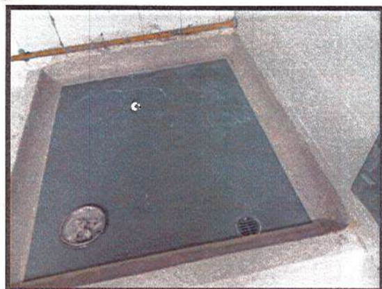
APLICACIÓN DE MATERIAL IMPERMEABILIZANTE- ARREGLOS ZONA DE MARMITA
