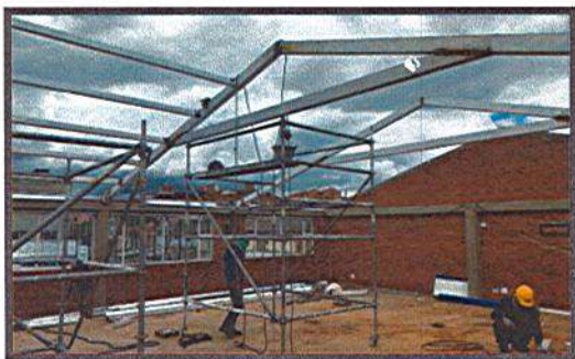
MONTAJE DE CERCHAS METALICAS
