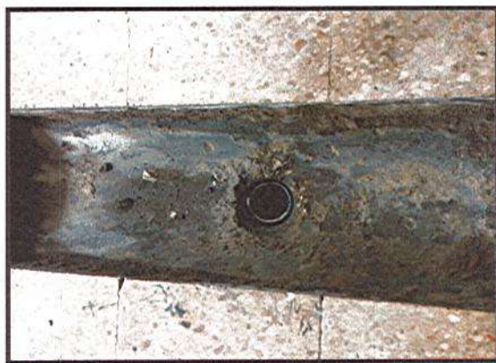
DEMOLICIÓN DE CÁRCAMOS
