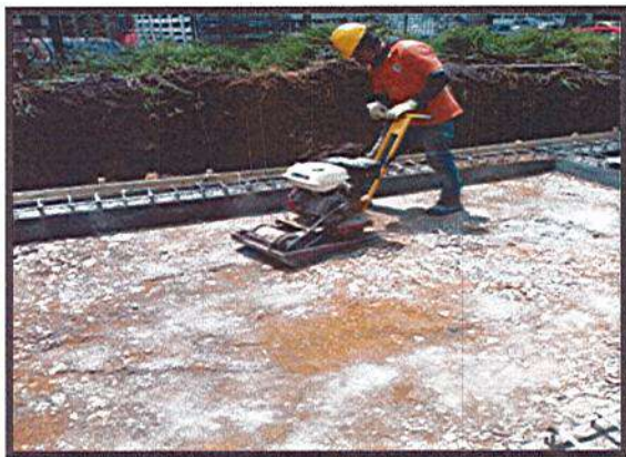
COMPACTACIÓN DE MATERIAL RECEBO
