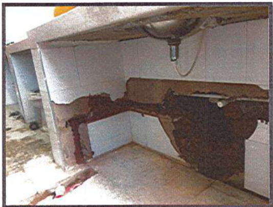
DESMONTE DE TUBERIA DE SUMINISTRO
