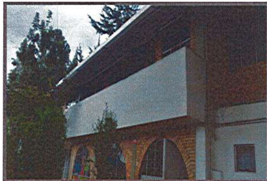
ASEO Y LIMPIEZA DEL ÁREA Y RETIRO DE CERRAMIENTOS
