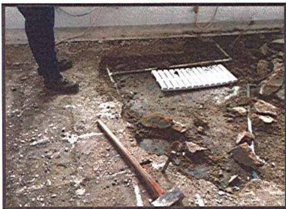
DEMOLICIÓN DE AFINADO DE PISO
