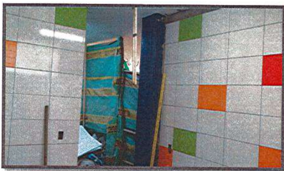
INSTALACIÓN DE ENCHAPE PARA MURO
