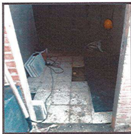
INSTALACION DE BALDOSA PISO AL INTERIOR DEL BAÑO INFANTIL
