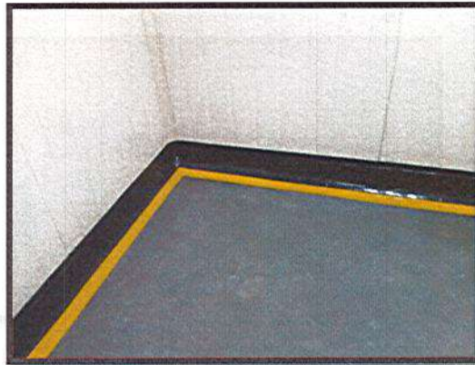
ACABADO FINAL CUARTOS FRIOS
