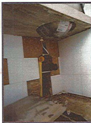
INSTALACION DE TUBERIA HIDROSANITARIA EN PVC
