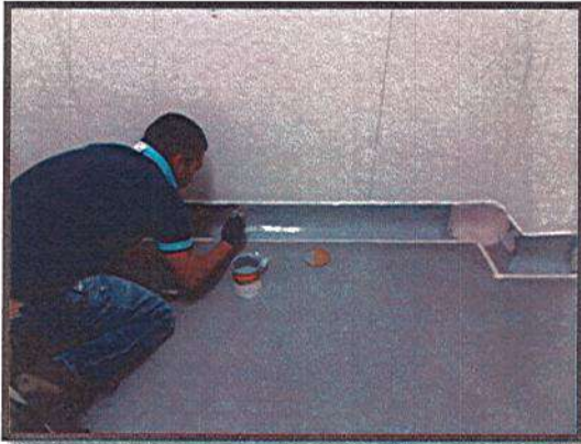
IMPERMEABILIZACION CUARTOS FRIOS
