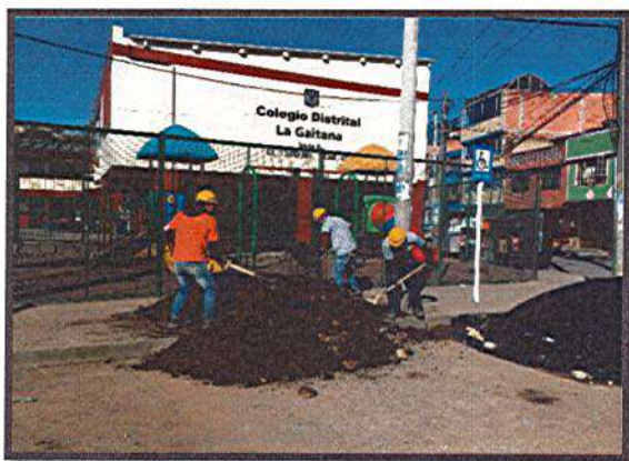
TRASEGO DE MATERIAL ESCOMBRO Y TIERRA
