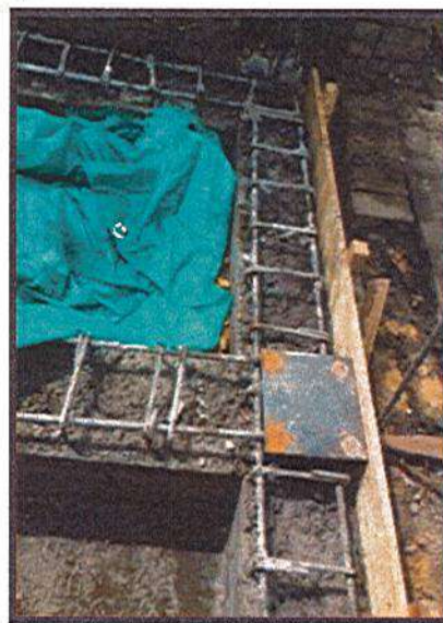
DESENCOFRAO DE VIGAS DE AMARRE
