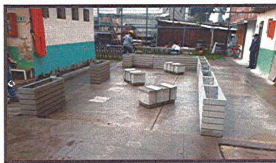
INSTALACION DE MATERAS Y BANCAS EN CONCRETO
