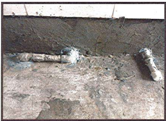
APLICACIÓN DE SELLO EN TUBERÍAS HIDRÁULICAS
