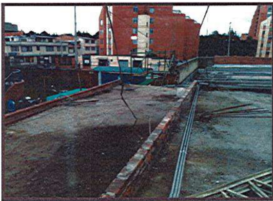
INSTALACIÓN DE MEDIA CAÑA PERIMETRAL
