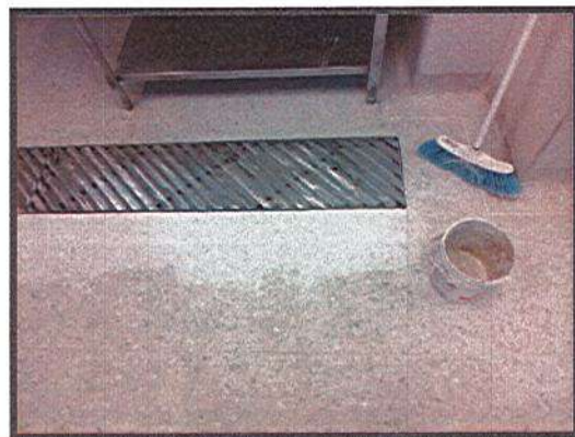
INSTALACION DE MARCO PARA REJILLA DE CARCAMO
