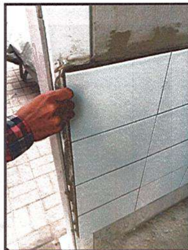
INSTALACION DE ENCHAPE PARED
