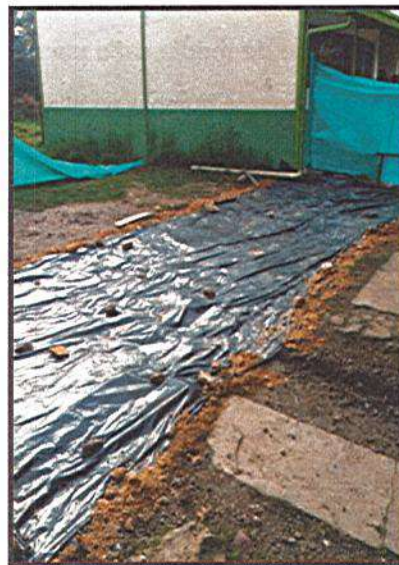
CUBRIMIENTO CON PLÁSTICO SOBRE MATERIAL EXCAVADO
