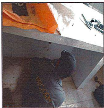
DESMONTE DE APARATOS SANITARIO
