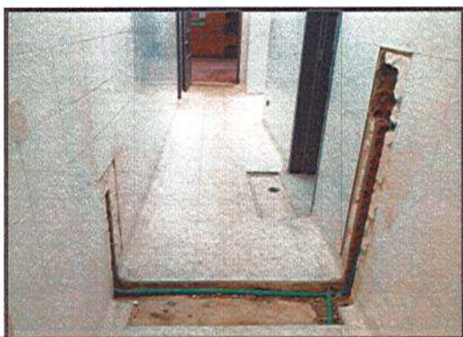
CORTE Y DEMOLICIÓN DE PISO Y MUROS
