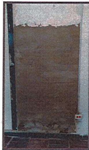
RESANES EN ZONA DE FISURAS SUPERFICIALES
