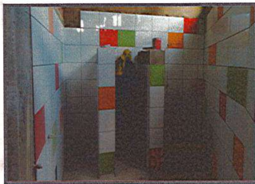
INSTALACIÓN DE ENCHAPE MUROS
