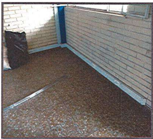
TAPAS PARA PUNTOS ELECTRICOS
