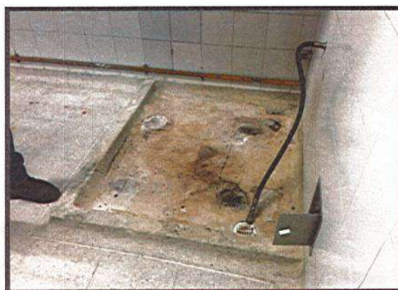
ESTADO ACTUAL DE CÁRCAMO ANTES DE DEMOLER MARMITA
