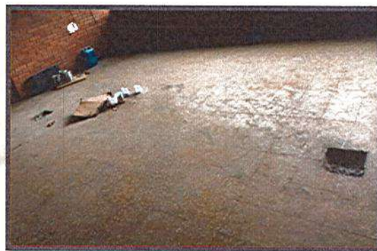
DEMOLICION DE PEDESTALES DE PORTICOS EXISTENTES
