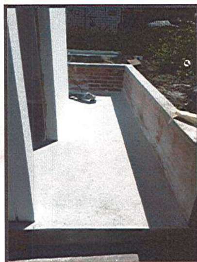
INSTALACION DE BALDOSA EXTERIOR
