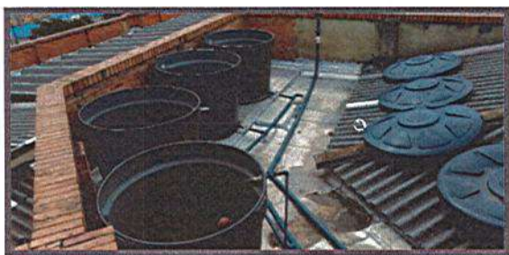
RETIRO DE TANQUES
