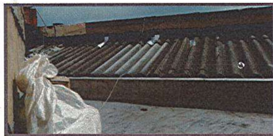
RETIRO DE MANTO IMPERMEABILIZANTE
