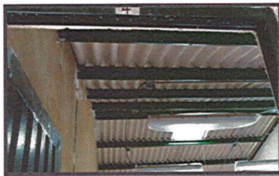
APLICACIÓN DE PINTURA PARA TEJAS EN CEMENTO
