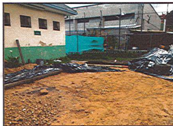
RELLENO DE MATERIAL RECEBO
