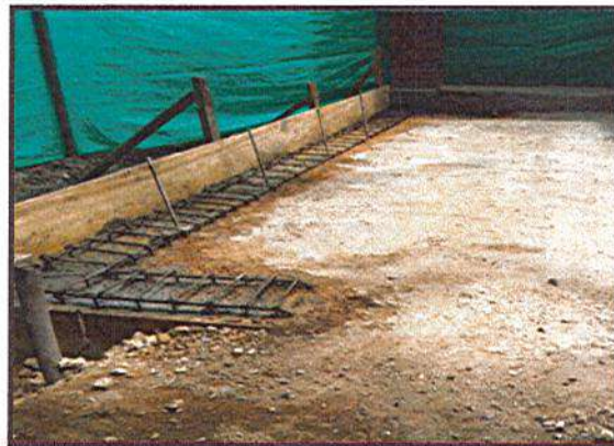
RELLENO DE MATERIAL RECEBO
