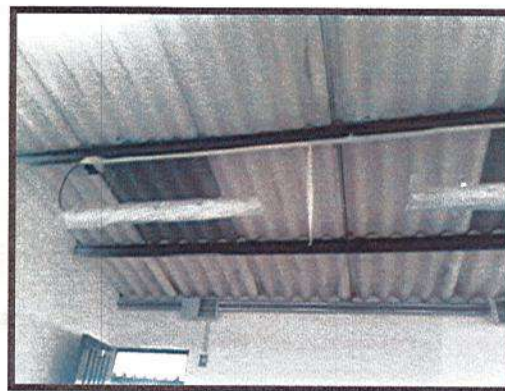
CAMBIO DE TEJAS DE ASBESTO CEMENTO DAÑADAS
