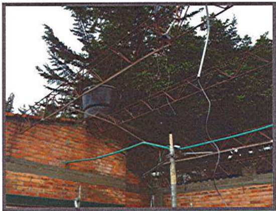
DESMONTE CUBIERTA DE ASBESTO CEMENTO
