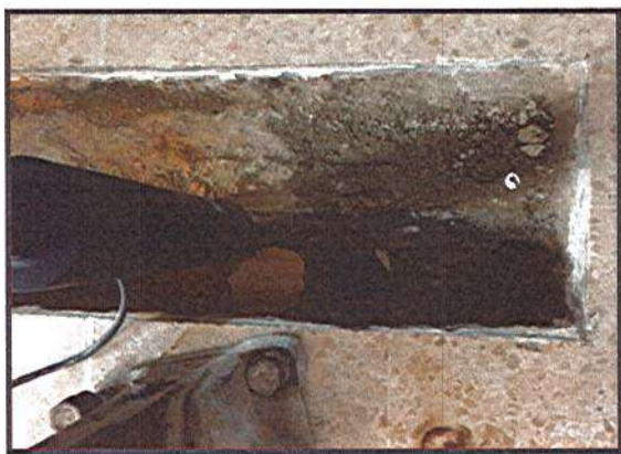
PERFORACIÓN CON TALADRO SACANUCLEOS
