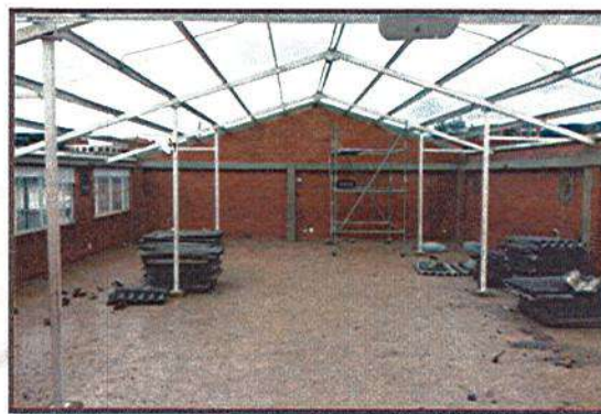
DESMONTE DE CUBIERTA
