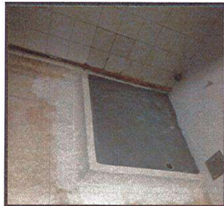
INSTALACION DE PISO IMPERMEABILIZANTE EN ZONA DE
