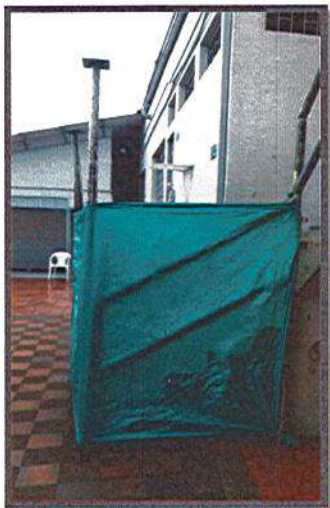
REFUERZO DE CERRAMIENTO CON PARALES METALICOS
