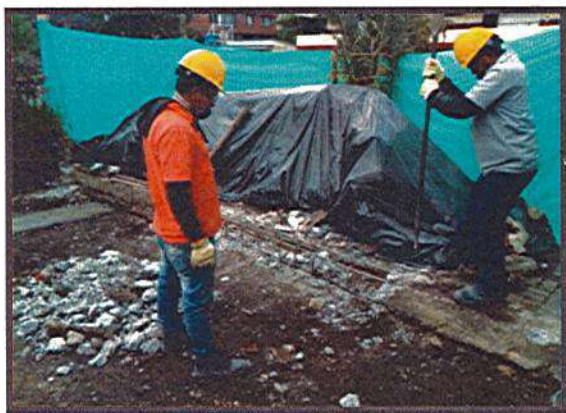
DEMOLICIÓN DE VIGAS DE AMARRE
