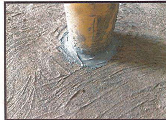
APLICACIÓN DE SELLO EN TUBERÍAS SANITARIAS
