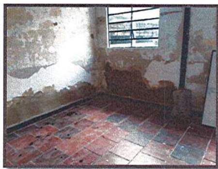
RESANES EN ZONA DE FISURAS SUPERFICIALES
