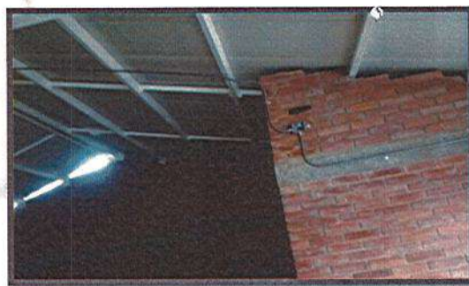
INSTALACIÓN DE TUBERIA EMT PARA RED ELECTRICA
