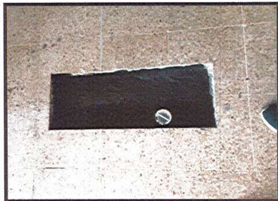
APLICACIÓN PUENTE DE ADHERENCIA ENTRE PLACA E IMPERMEABILIZANTE
