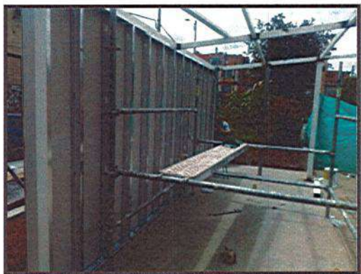
INSTALACION DE SUPERBOARD
