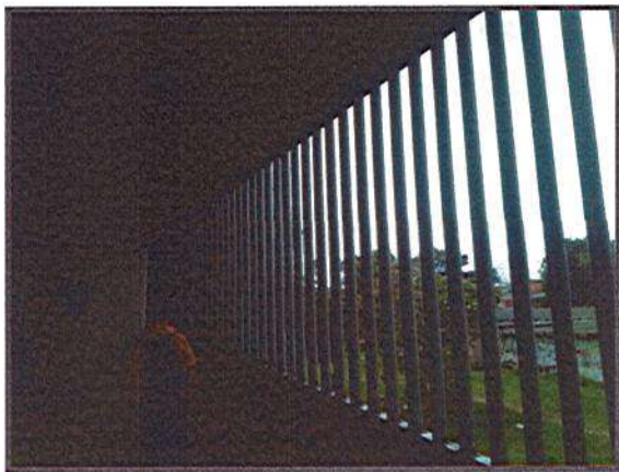
PINTURA DE TUBERIA Y PLATINAS
