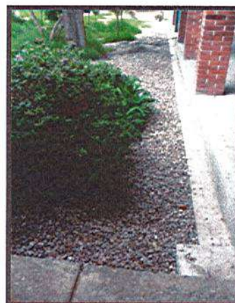
EXTENDIDO DE GRAVA
