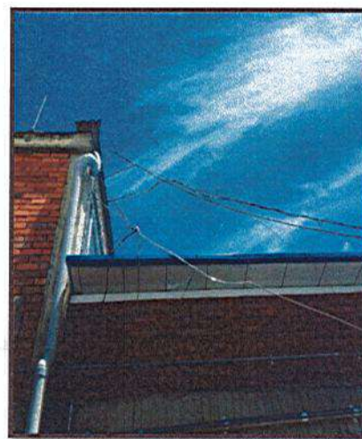
FINALIZA INSTALACION DE BAJANTE DE ALL
