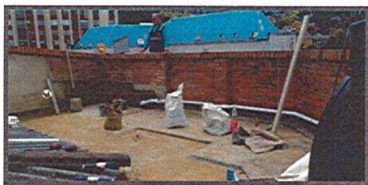
DESMONTE TOTAL DE MANTO IMPERMEABILIZANTE DE CUBIERTA
