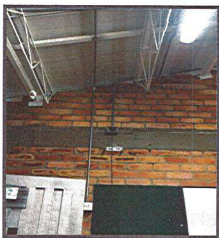
SALIDAS ELECTRICAS Y TUBERIA EMT
