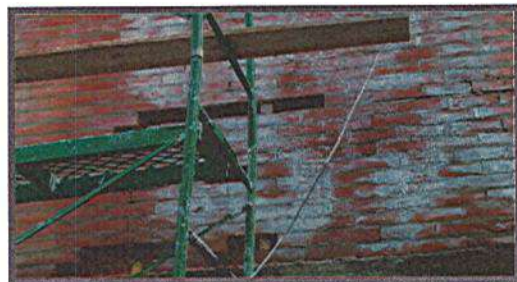
REPOSICION DE MAMPOSTERIA SUELTA
