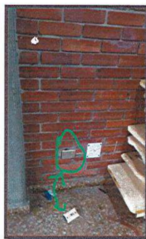
INSTALACIÓN DE CANALETA METALICA
