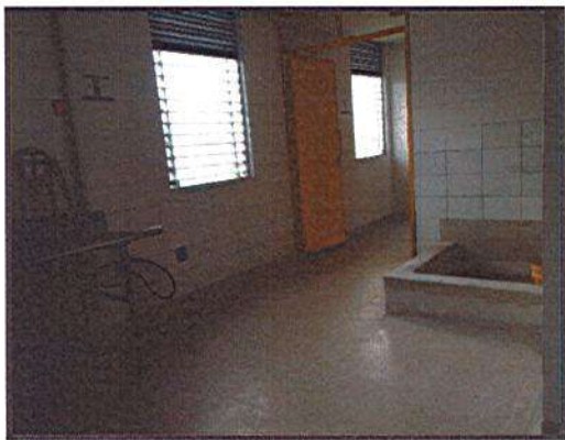
FINALIZACION DE INSTALACION DE BALDOSA
