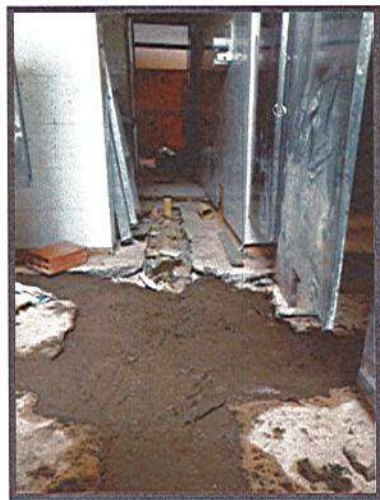
FUNDICION DE PLACA DE CONTRAPISO
