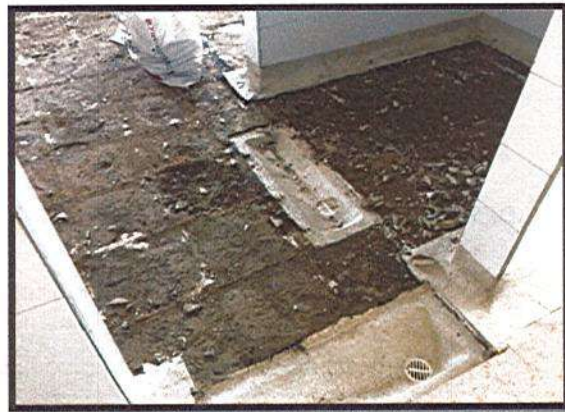
DEMOLICIÓN DE CÁRCAMOS
