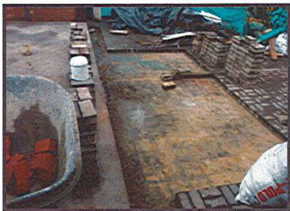
RETIRO DE ADOQUÍN EN CONCRETO
