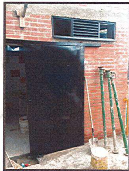
INSTALACIÓN DE PUERTA CORREDIZA METALICA Y VENTANERÍA
