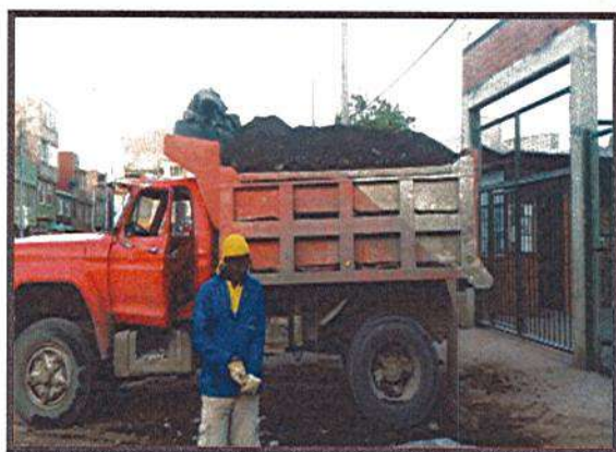
CARGUE MANUAL DE MATERIAL DE TIERRA
