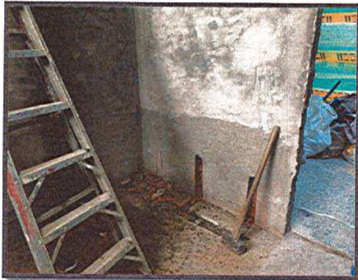
REGATAS PARA INSTALACION DE TUBERIA SANITARIA Y SUMINISTRO
