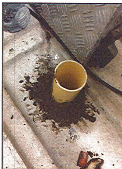
REPOSICION DE TUBERIA SANITARIA
