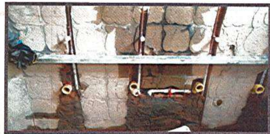
NIVELACION DE PUNTOS PARA LAVAMANOS
