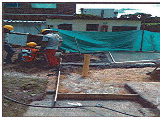
FUNDICIÓN DE ANDENES
