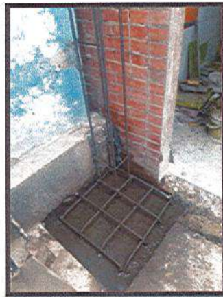
FUNDICIÓN DE ZAPATA
