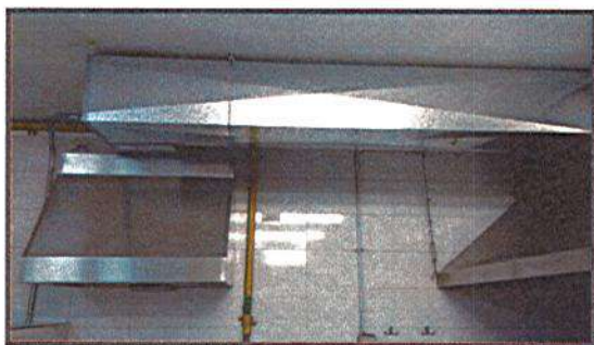
INSTALACION DE CAMPANA
