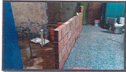
CONSTRUCCION DE MUROS EN MAMPOSTERIA DIVISORIOS
