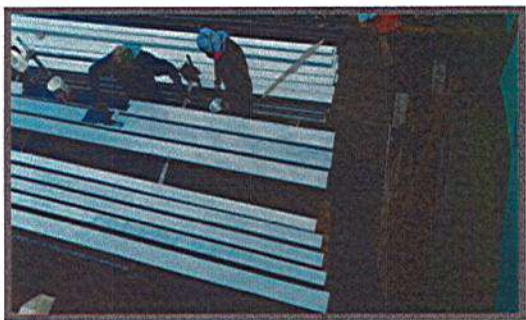
APLICACIÓN DE PINTURA DE PERFILES
