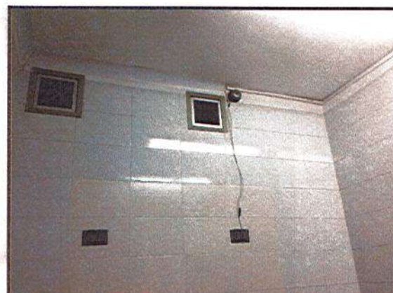
REPOSICION DE ENCHAFE PARED Y BALDOSA PISO
