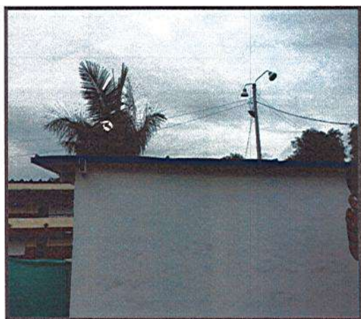
INSTALACION DE CUBIERTA TIPO SANDWICH
