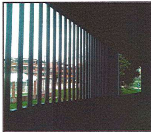
INSTALACION DE TUBERIA EN VANO
