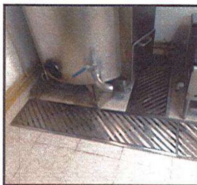
INSTALACION DE REJILLA PARA CÀRCAMO
