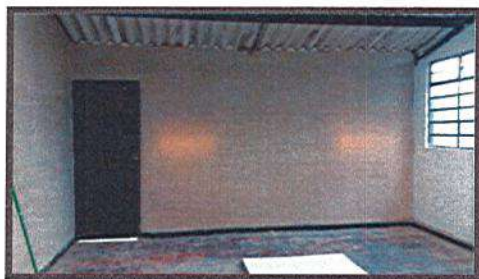
PRIMERA CAPA DE PINTURA EN MURO
