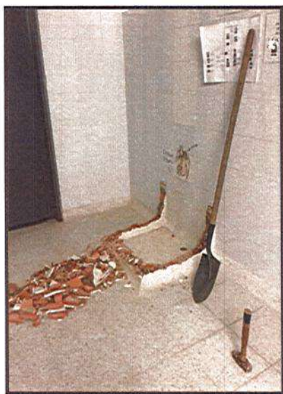
DEMOLICIÓN DE POCETA
