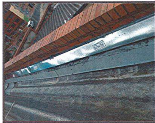
INSTALACION DE FLANCHE EN DILATACION DE MURO LATERAL
