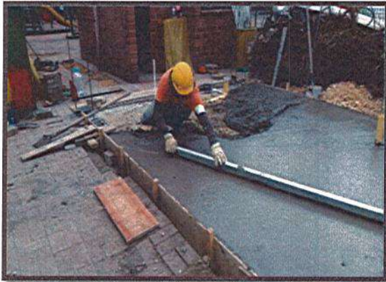
FUNDICIÓN DE PLACA EN CONCRETO
