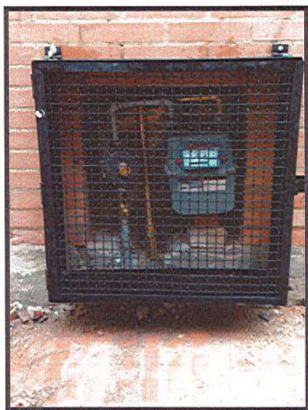
INSTALACION DE REGULADOR Y REJILLA
