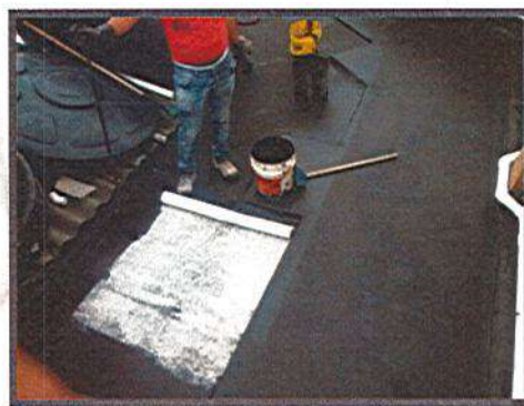
APLICACIÓN DE IMPERMEABILIZANTE PARA CUBIERTA
