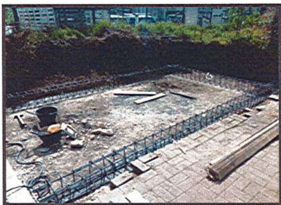
FIGURADO DE ACEROS PARA VIGAS DE AMARRE
