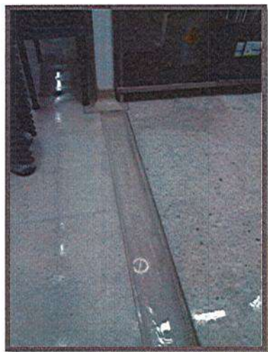
FINALIZA ARREGLO DE CARCAMO DE COCINA
