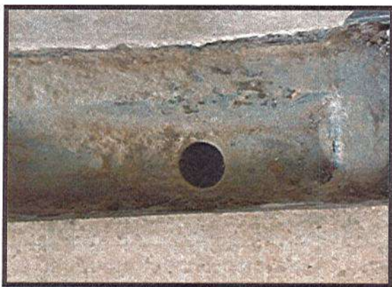
LIMPIEZA DE CÁRCAMO
