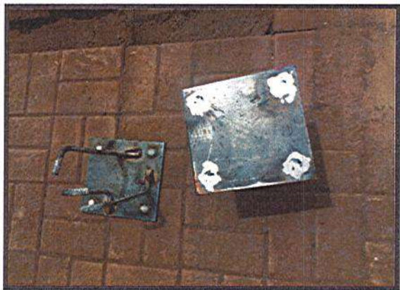
PLATINA DE SOPORTE PARA COLUMNAS
