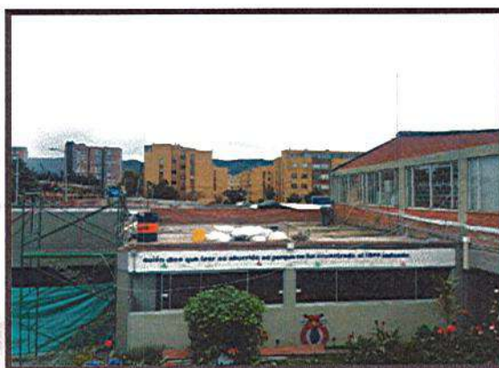
RETIRO DE ESCOMBRO Y CERCHAS SOBRE PLACA
