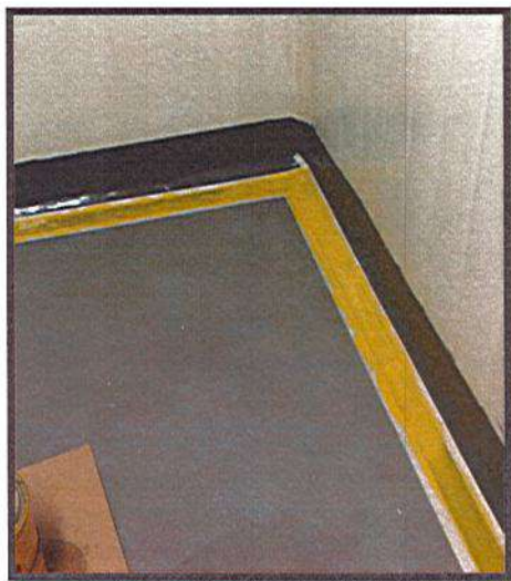
PINTURA MEDIAS CAÑAS Y CINTA DE SEGURIDAD
