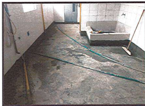
APLICACIÓN PUENTE DE ADHERENCIA ENTRE PLACA E IMPERMEABILIZANTE
