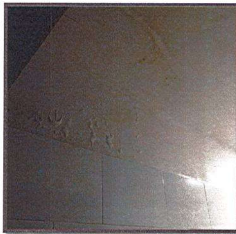
REPARACIÓN Y PINTURA EN FILTRACION DE MUROS DE BAÑOS
