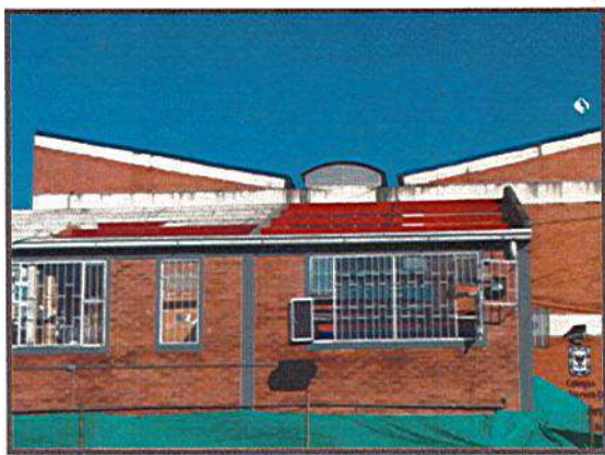
DESMONTE DE CUBIERTA
