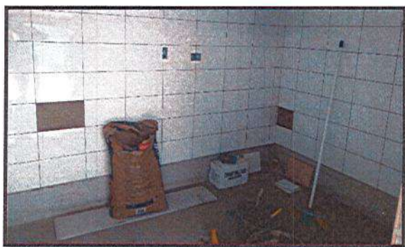
INSTALACION DE ENCHAFE PARED
