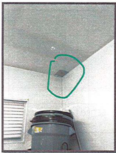
ARREGLOS DE CIELO RASO EN COCINA
