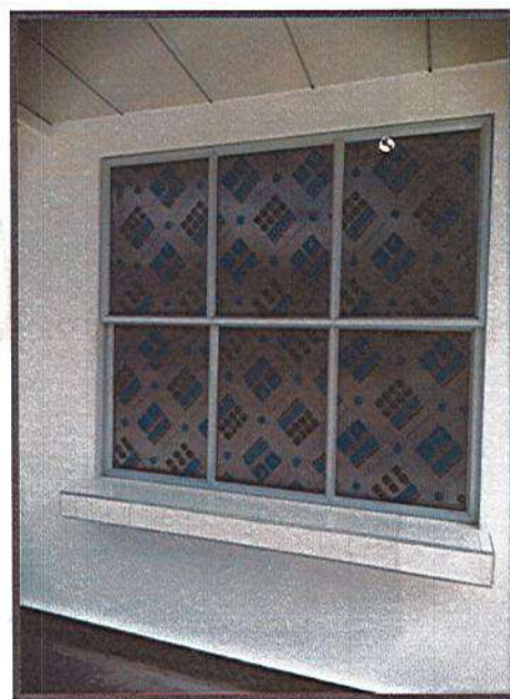
INSTALACIÓN DE VENTANA EN POLICARBONATO
