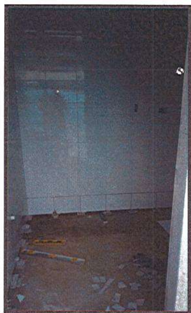
INSTALACION DE ENCHAFE MUROS
