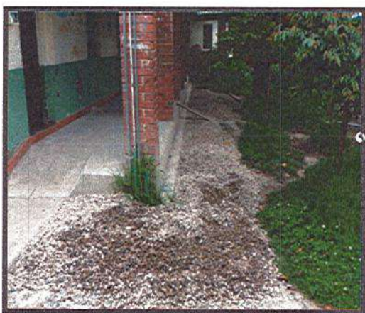
EXTENDIDO DE GRAVA
