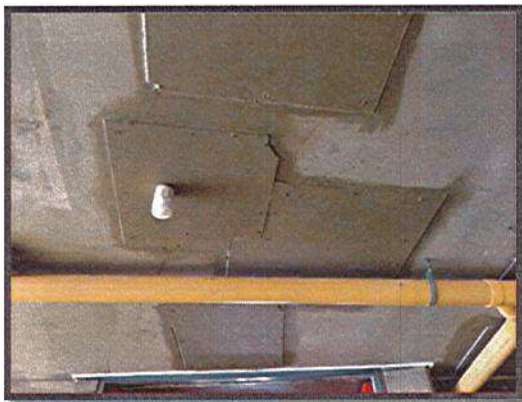
PINTURA PARA TAPAS EN DRYWALL- BIBLIOTECA
