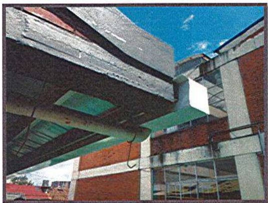
CANAL PERIMETRAL (MEJORAMIENTO DE SOLDADURA)
