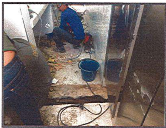
DESMONTE DE TUBERIA HIDROSANITARIA GALVANIZADA
