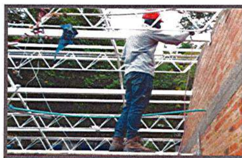
APLICACIÓN DE PINTURA PARA ESTRUCTURA
