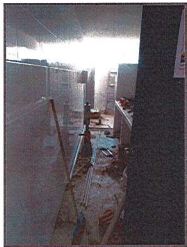
DEMOLICIÓN DE PISO
