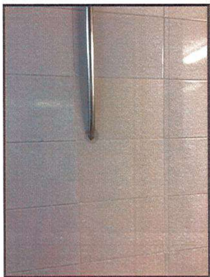
REPOSICION DE ENCHAPE PARED
