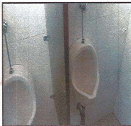
DESMONTE DE APARATOS SANITARIO
