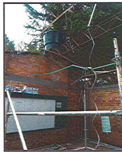
RETIRO DE CUBIERTA
