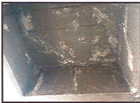
LIMPIEZA DE PLACA ALIGERADA PARTE INFERIOR
