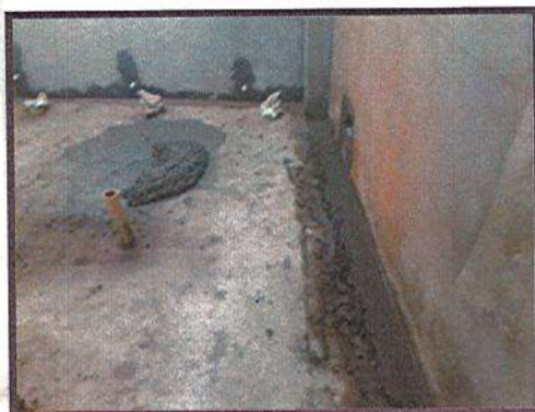
FUNDICION DE SOBRE PLACA
