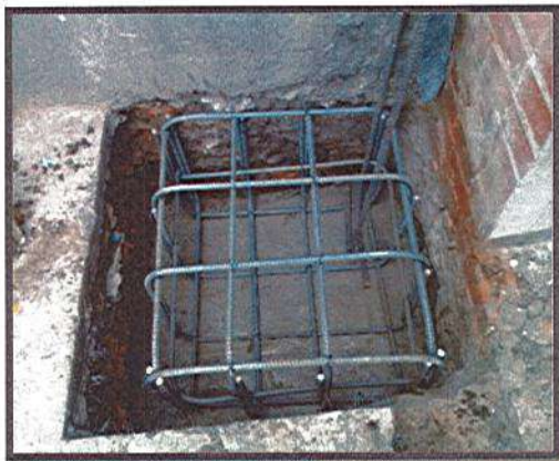
ARMADO DE ZAPATA
