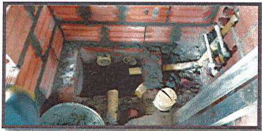
CONEXIÓN DE TUBERIAS A CAJA DE INSPECCION
