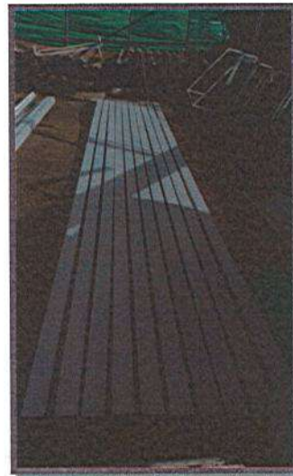
PINTURA DE PERFILERIA METALICA
