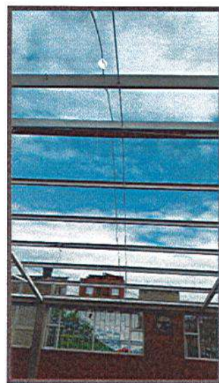
MONTAJE DE ESTRUCTURA
