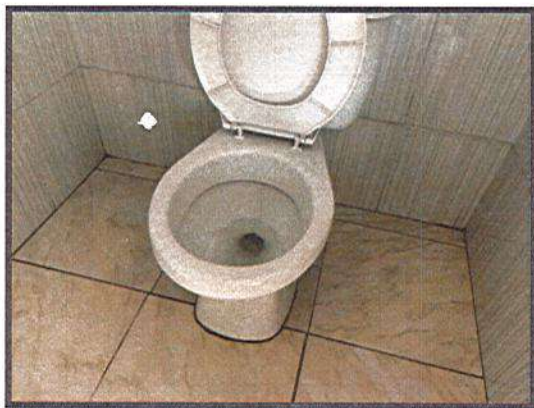
LIMPIEZA DE ÁREAS INTERVENIDAS(BAÑOS)
