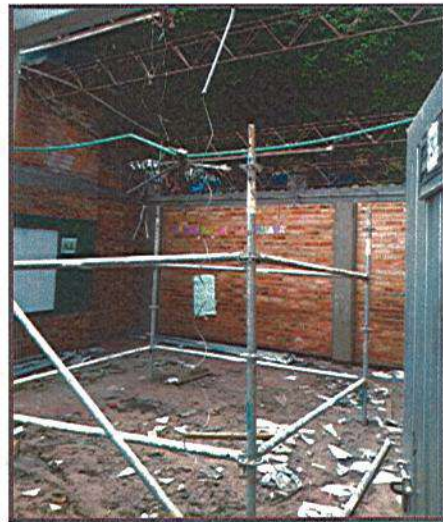
DESMONTE DE CUBIERTA
