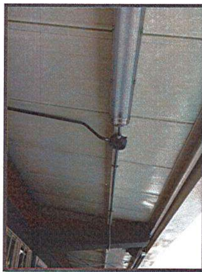
INSTALACION DE CAJAS DE PASO PARA LUMINARIAS
