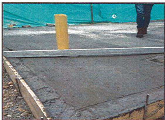
FUNDICIÓN DE PLACA
