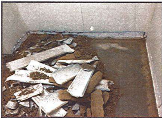
FUNDICIÓN DE PLACA EN CUARTO FRIO
