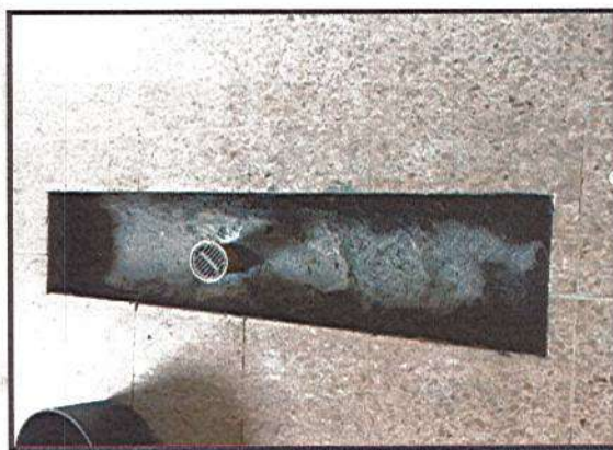
IMPERMEABILIZACIÓN DE CÁRCAMO
