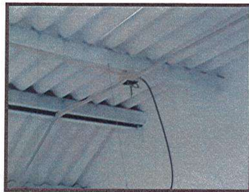
APLICACIÓN DE PINTURA PARA CUBIERTA
