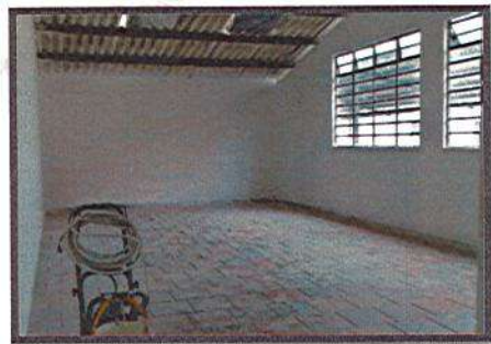
APLICACIÓN DE ULTIMA CAPA DE PINTURA EN MUROS
