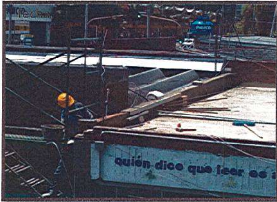
APLICACIÓN DE MORTERO DE NIVELACIÓN IMPERMEABILIZADO
