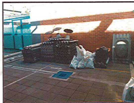
ACOPIO DE MATERIAL ASBESTO CEMENTO
