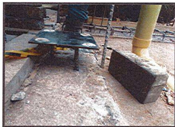
INSTALACIÓN DE PLATINAS EN VIGAS DE AMARRE
