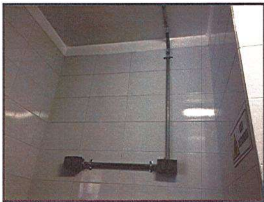
SALIDAS ELECTRICAS Y TUBERIA EMT
