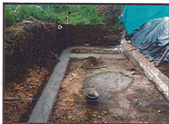
FUNDICIÓN DE SOLADO
