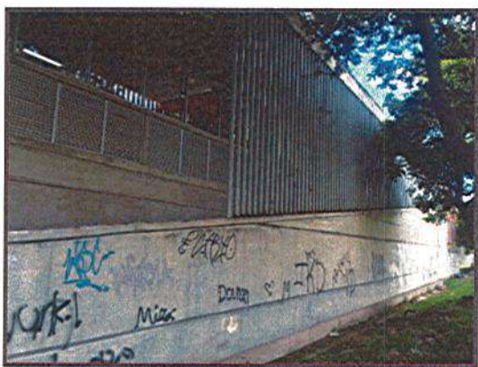
INSTALACION DE TUBERIA
