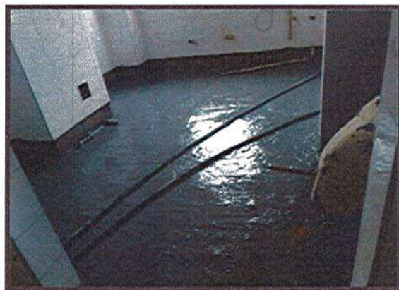
APLICACIÓN DE IMPERMEABILIZANTE
