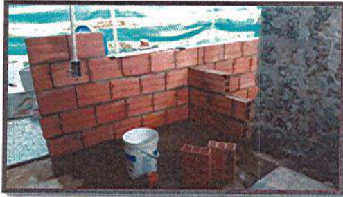
CONSTRUCCION DE MUROS EN MAMPOSTERIA DIVISORIOS
