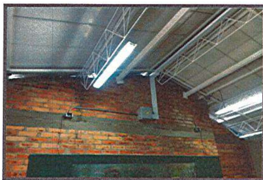
INSTALACION DE LUMINARIAS Y PUNTOS PARA PARLANTES
