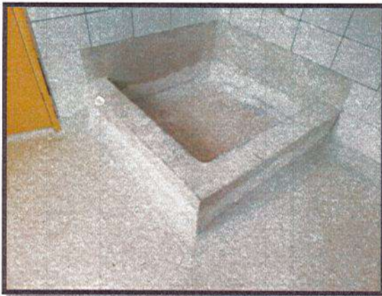
RESANE E IMPERMEABILIZACION DE POCETA
