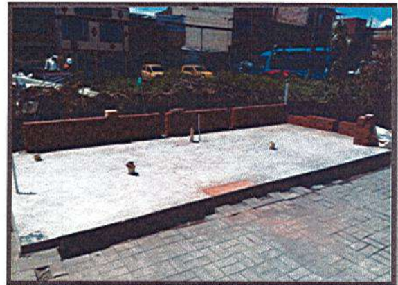
INSTALACIÓN DE MURO EN BLOQUE MACIZO
