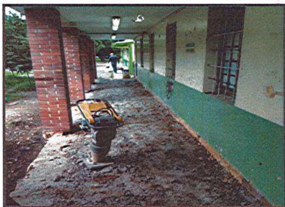
RELLENO DE MATERIAL RECEBO
