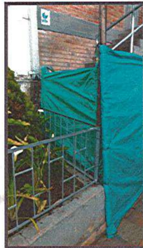
REFUERZO DE CERRAMIENTO CON PARALES METALICOS
