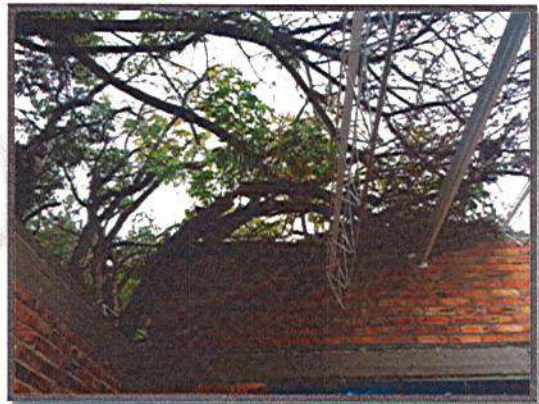
PINTURA DE PERFILERIA METALICA
