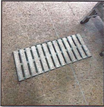
INSTALACION DE REJILLAS EXISTENTES
