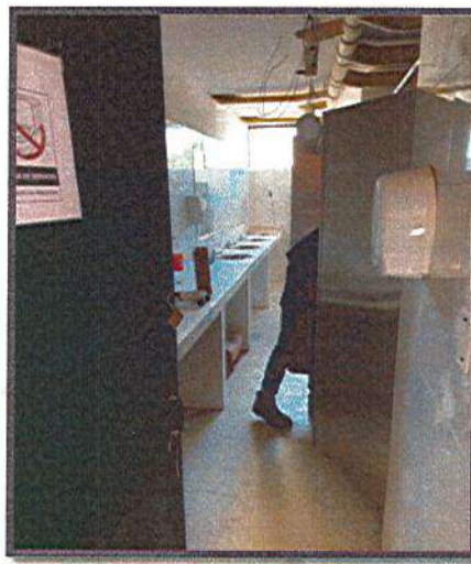
TUBERIA HIDROSANITARIA A LA VISTA- 2DO PISO
