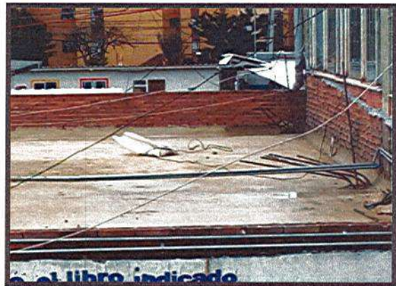
ADECUACIÓN DE MURO LATERAL
