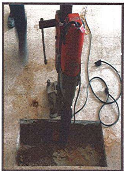
PERFORACIÓN CON TALADRO SACANUCLEO
