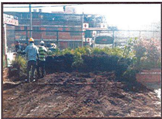
EXCAVACIÓN MANUAL
