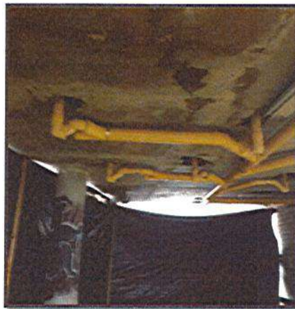
REPOSICION DE TUBERIA SANITARIA
