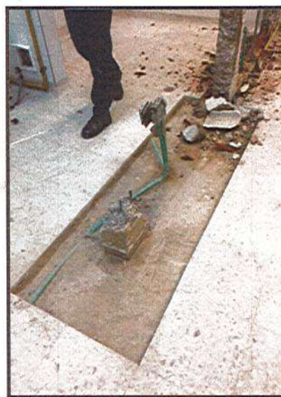
DEMOLICIÓN DE MURO
