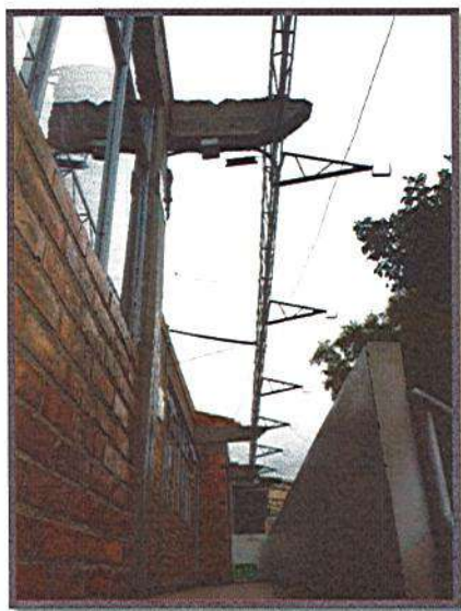
DESMONTE CUBIERTA DE ASBESTO CEMENTO
