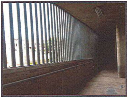
FINALIZA RASPAJE DE MUROS MANCHADOS
