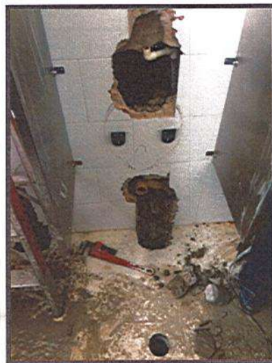
REPOSICION DE TUBERIA HIDROSANITARIA EN PVC
