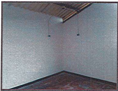
ACABADO FINAL DE MUROS (3 MANOS DE PINTURA)
