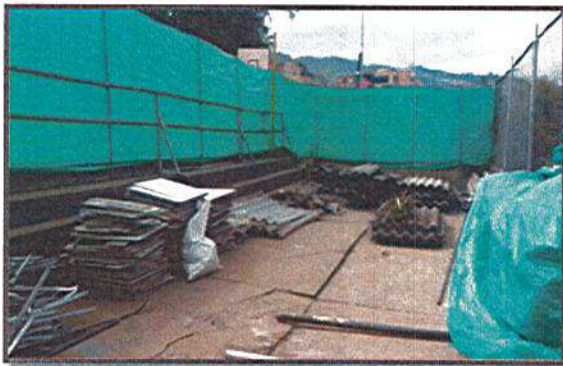
CERRAMIENTO Y ACOPIO DE MATERIAL
