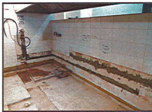
REPOSICION DE ENCHAFE PARED Y BALDOSA PISO
