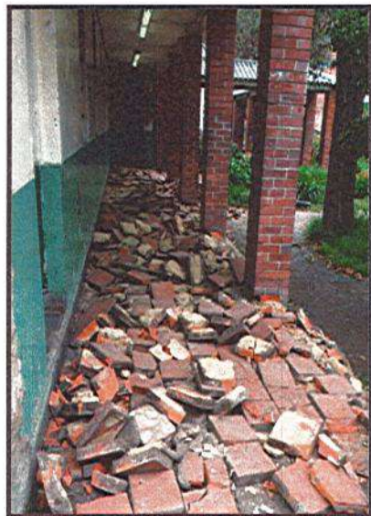
DEMOLICIÓN DE PISO
