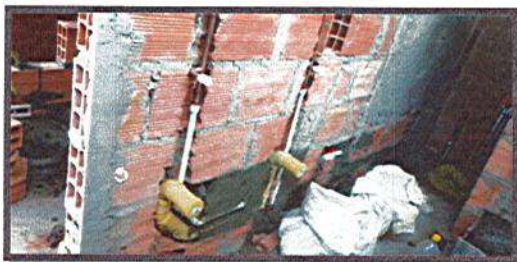
INSTALACION DE PUNTOS SANITARIOS PARA ORINALES BAÑO NIÑOS
