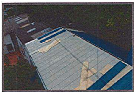
MONTAJE DE PANELES DE CUBIERTA TIPO SANDWICH
