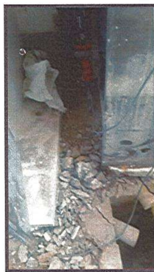
DEMOLICION DE ENCHAPE PISO
