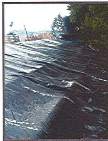
RECUBRIMIENTO DE CUBIERTA CON PLASTICO
