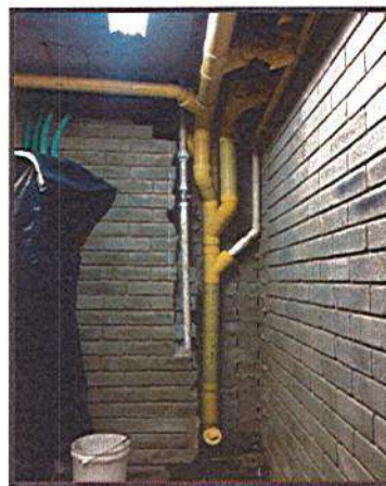
DEMOLICION DE BLOQUE EN CUARTO ELECTRICO
