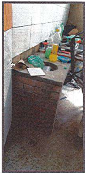
MESÓN EN MAMPOSTERIA Y GRANITO
