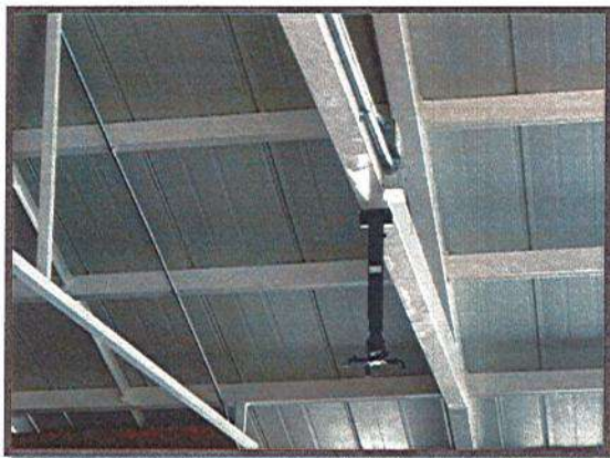
INSTALACIÓN DE BRAZO PARA SOPORTE DE VIDEO BEAM
