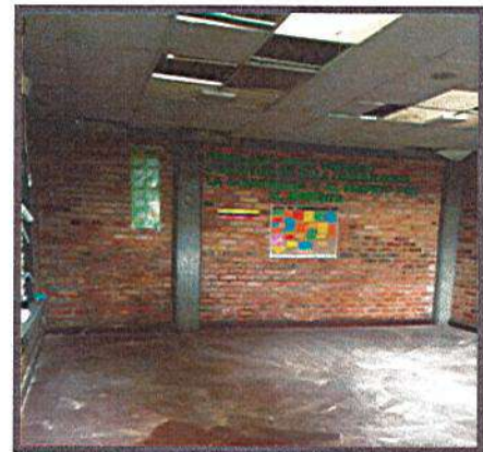
DESMONTE CIELO RASO
