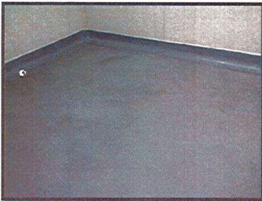
APLICACIÓN DE MATERIAL IMPERMEABILIZANTE-ARREGLOS-CUARTOS
