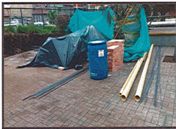
ACOPIO DE MATERIAL DE OBRA
