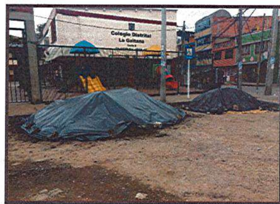
CUBRIMIENTO DE MATERIAL ESCOMBRO Y RECEBO
