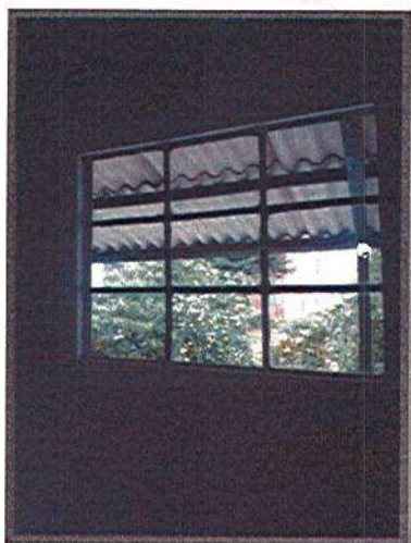
CAMBIO DE VIDRIOS DAÑADOS
