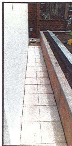
INSTALACION DE ENCHAFE PISO EXTERIOR
