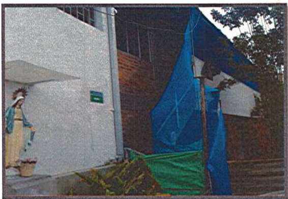
INSTALACION DE CERRAMIENTO SEGUNDO PISO
