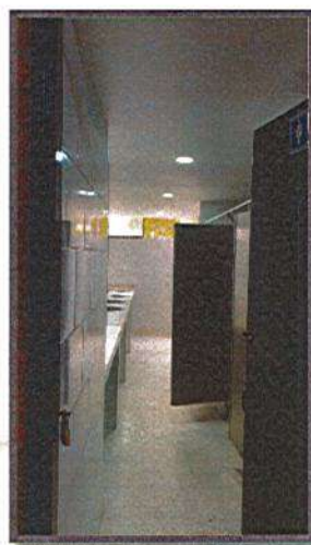
FINALIZA OBRA EN BAÑOS
