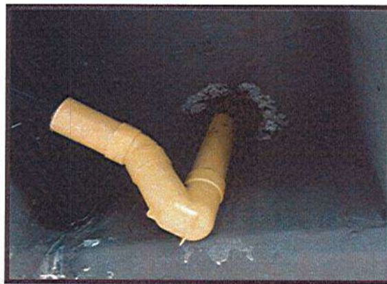
ADECUACIÓN PUNTO DE DESAGUE
