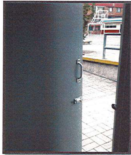
INSTALACION DE MANIJA PARA PUERTA TIENDA ESCOLAR
