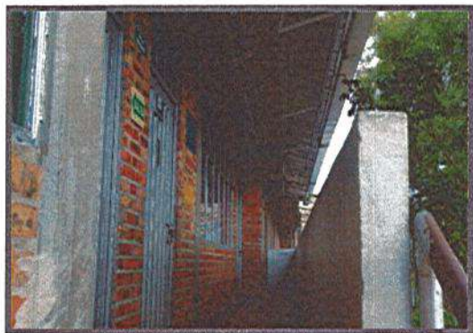
ASEO Y LIMPIEZA DEL ÁREA Y RETIRO DE CERRAMIENTOS
