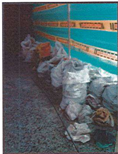
INGRESO DE MATERIAL DE CONSTRUCCIÓN
