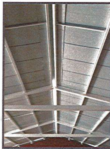
INSTALACION DE CUMBRERA INTERIOR
