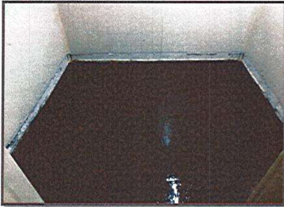
DEMOLICIÓN MANUAL DE BALDOSA CUARTO FRIOS
