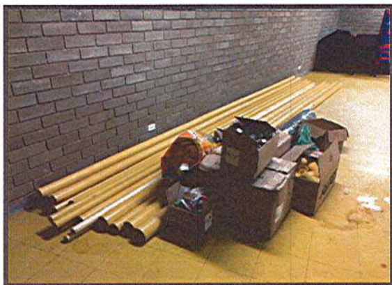
ACOPIO DE MATERIAL DE OBRA
