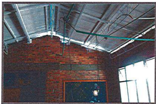
DESMONTE DE RED ELECTRICA EXISTENTE
