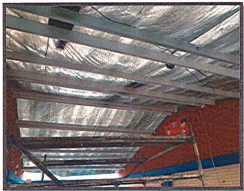
FINALIZA INSTALACIÓN ESTRUCTURAL
