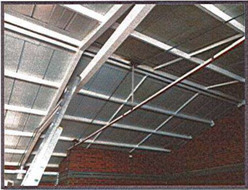
INSTALACION DE TUBO PARA REFLECTORES Y PARLANTES DE TARIMA
