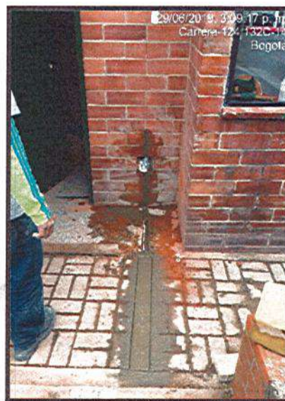
PAÑETE SOBRE RED HIDRAULICA
