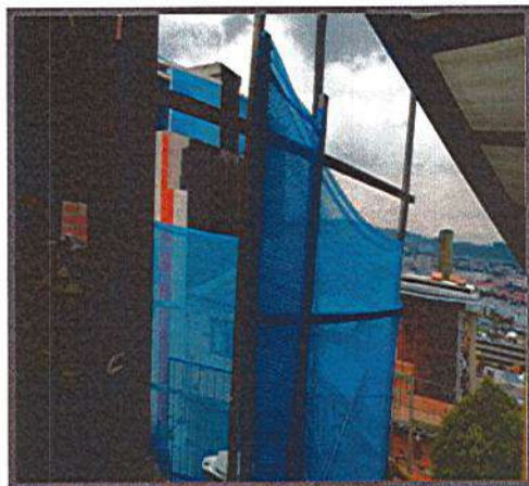
INSTALACION DE CERRAMIENTO
