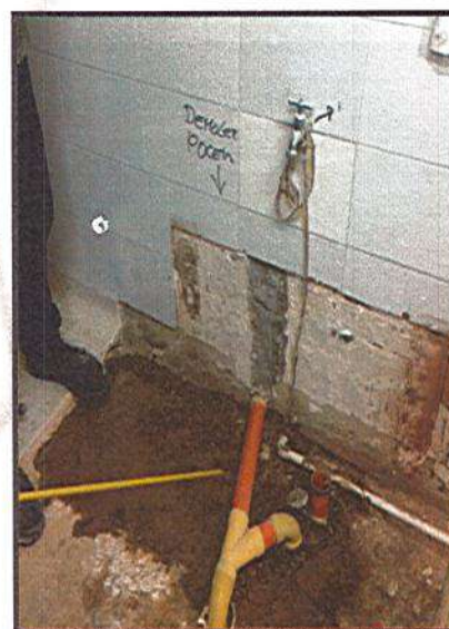
ADECUACIÓN DE RED SANITARIA POCETA DE LAVADO
