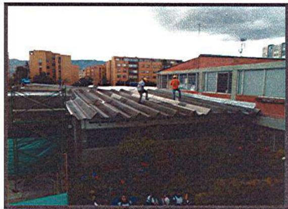
DESMONTE DE CUBIERTA
