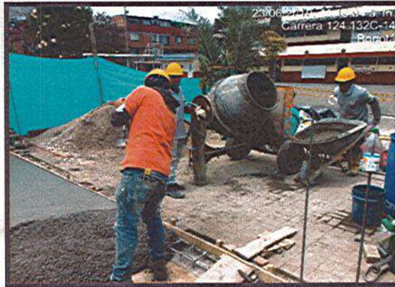
PREPARACIÓN DE MEZCLA DE CONCRETO
