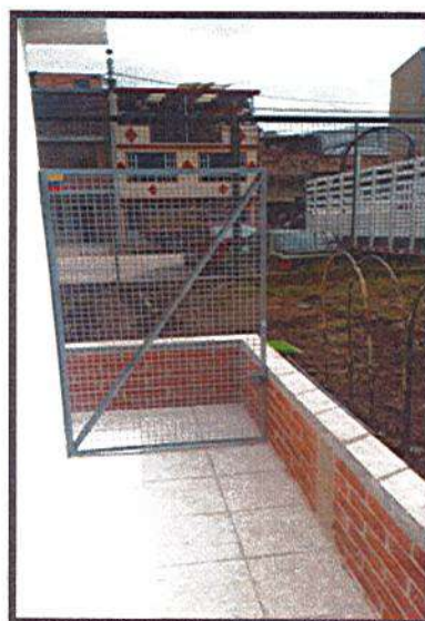
CORTE Y PINTURA DE PUERTA
