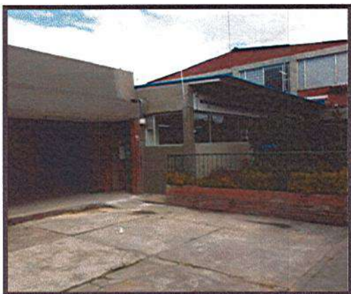
RETIRO DE ESCOMBROS Y MATERIAL DE OBRA
