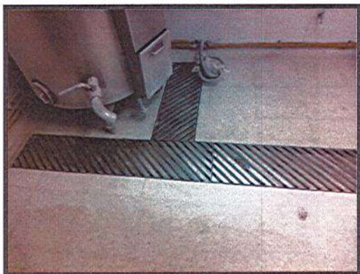
INSTALACION DE MARCO PARA REJILLA DE CARCAMO
