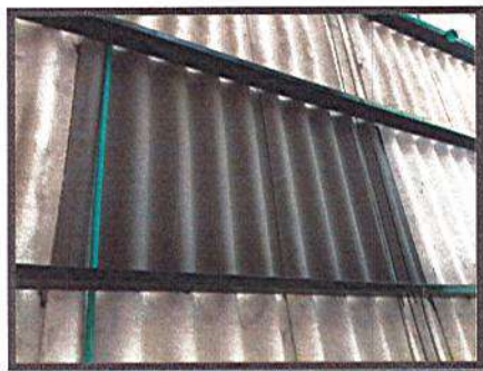
CAMBIO DE TEJAS DAÑADAS
