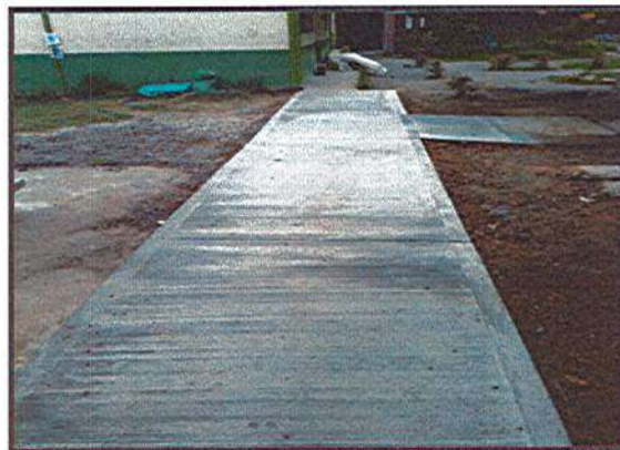
ACABADO DE ANDENES
