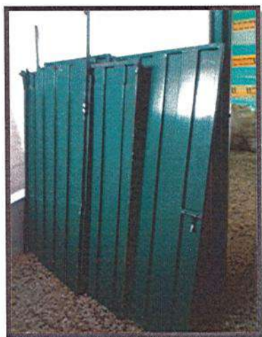
DESMONTE DE DIVISIONES METALICAS DE BAÑOS
