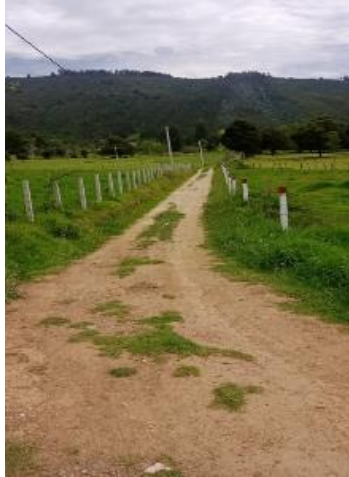
Ilustración 10. Estado inicial de la vía. Vereda Cachavita.
