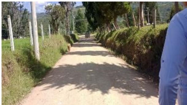
Ilustración 12. Estado inicial de la vía. Vereda La Creciente.
