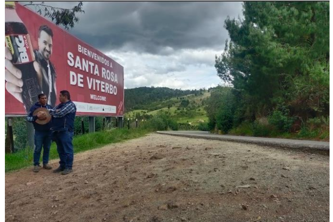
Ilustración 3. Estado inicial de la vía. Vereda San Antonio.
