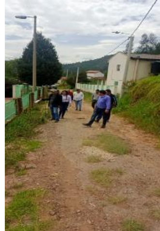
Ilustración 11. Estado inicial de la vía. Vereda Cachavita.
