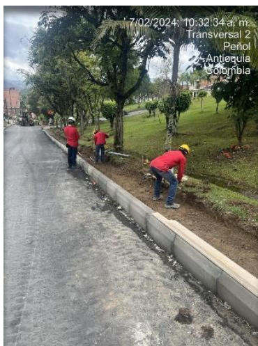
Ilustración 4, Empleados con uso adecuado de EPP
