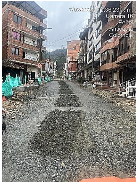
Ilustración 6, Señalización y demarcación de obra
