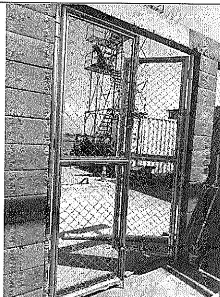
MALLA ESLABONADA FORADA PVC # 10 R. 2", NAVE PUERTA TUBO C.13 MALLA (2x2.51-3.0), INSTALACION MALLA ESLABONADA.
