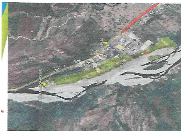
Agosto 2023 a febrero 2024: El río se ubicó a 1 metro del cerramiento de la PTAP Definitiva
