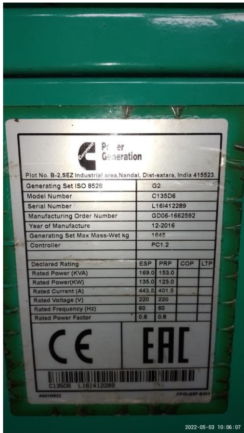
Imagen No 3, 4 Generador y Placa de características de generador
