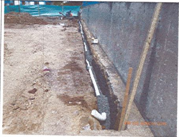
Fotografía No. 2: Instalación de gravilla, para filtro
