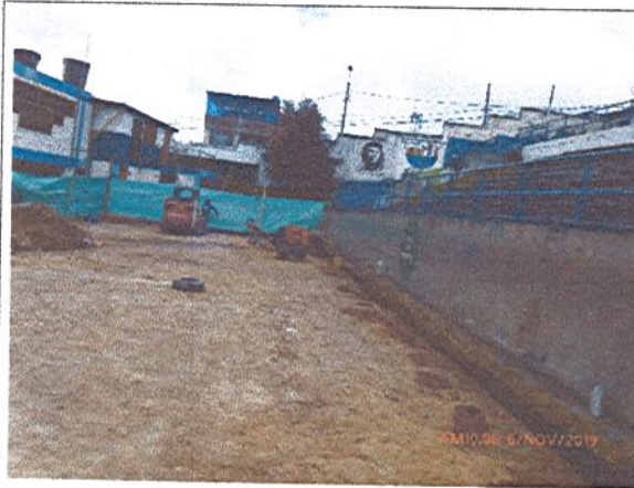
Fotografía No. 1: Excavación para montaje de filtro
