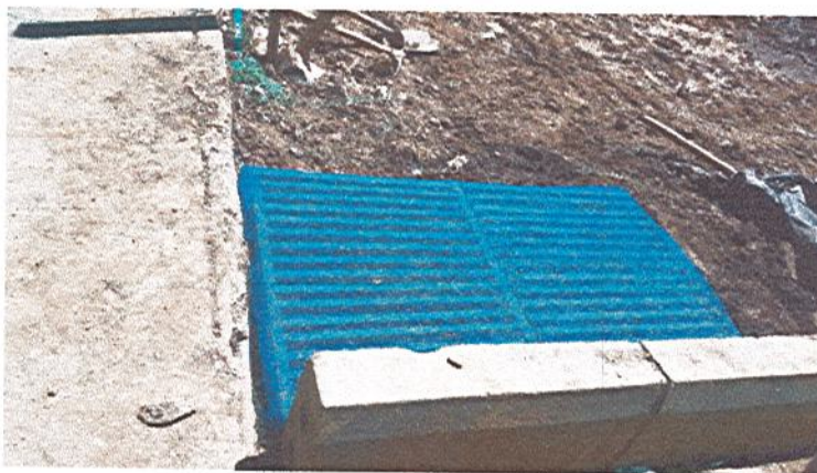
Fotografía 6. Limpieza e inventario de sumideros
