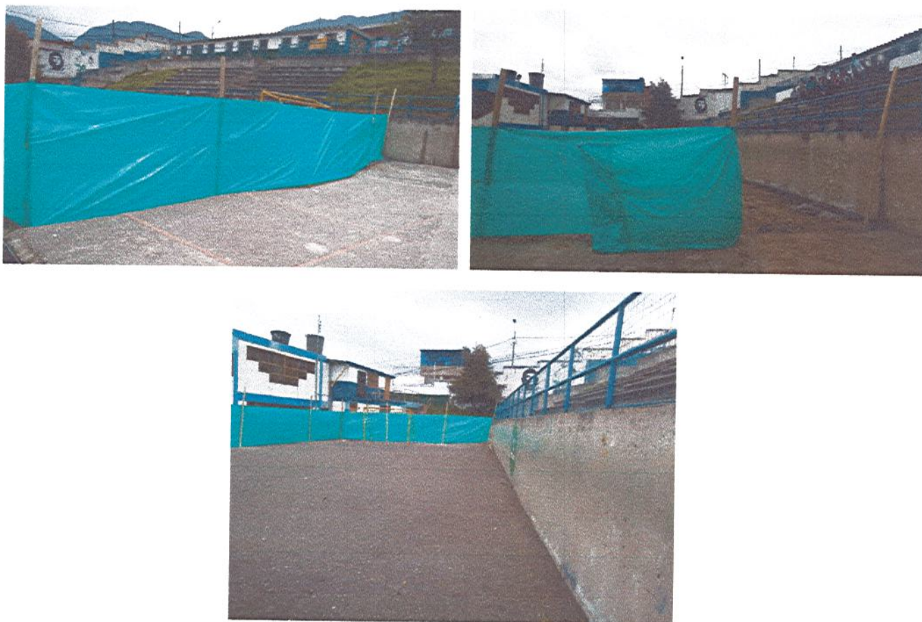
Fotografía 14. Cerramiento de la obra
