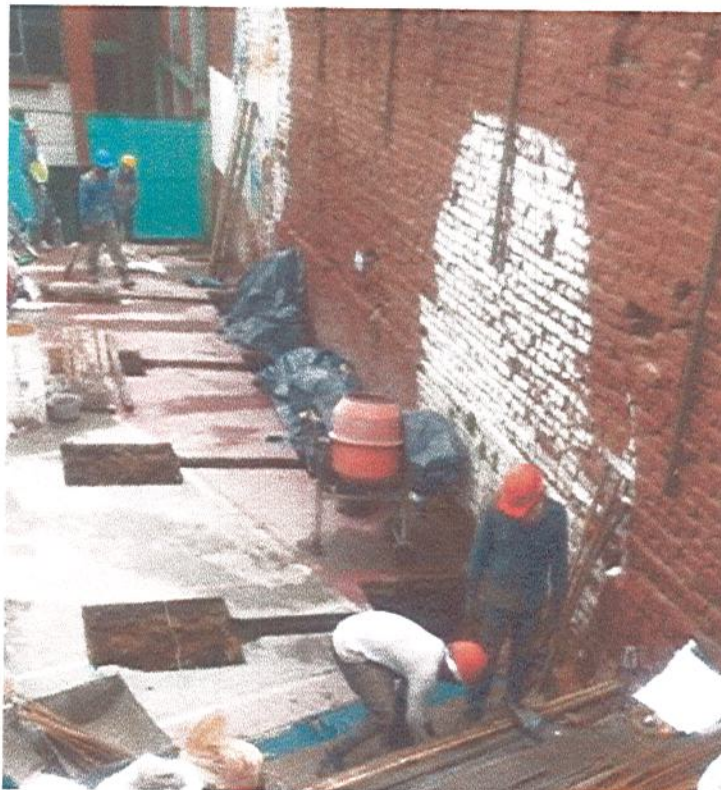
Fotografía 23. Orden y Aseo
