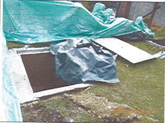
Fotografía No. 4: Construcción de caja eléctrica- red cocina móvil.
