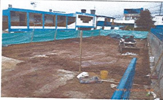
Fotografía No. 3: Perfilado del terreno con minicargador.
