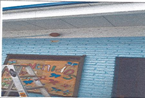
Fotografía No. 4: Instalación de timbre
