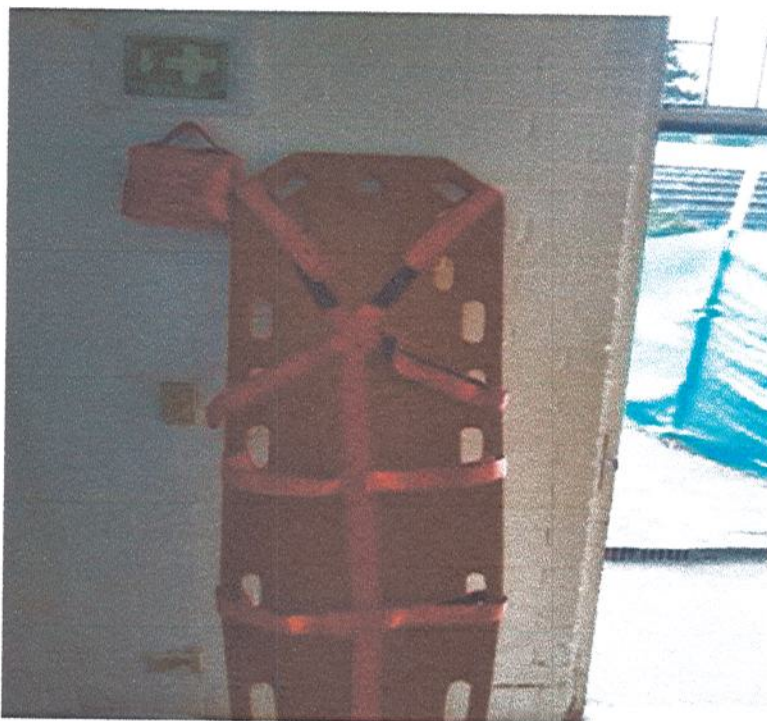
Fotografía 30. Equipamiento requerido en caso de emergencia (Camilla, Extintor, Botiquín) Colegio La Belleza Los Libertadores
