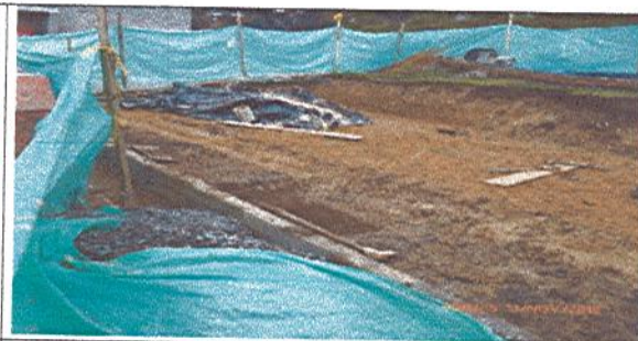
Fotografía No. 2: Zona donde se ubicará cocina móvil
