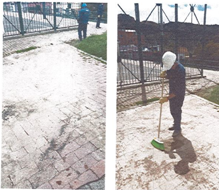
Fotografía 15. Orden y Aseo
