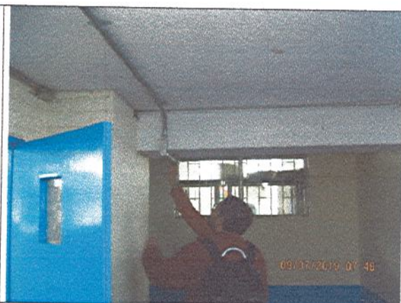
Fotografía No. 2: Recorrido nueva red a cocina
