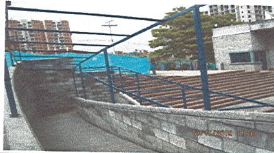
Fotografía No. 3: Estructura para cubierta-zona rampas
