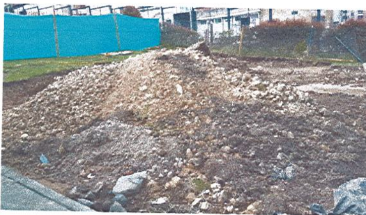
Fotografía 4. Acopio Materiales RCD
