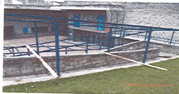
Fotografía No. 4: Estructura para cubierta-zona rampas
