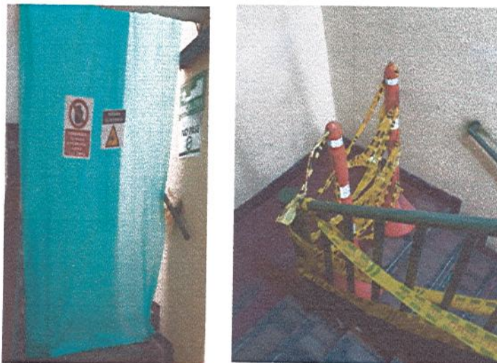
Fotografía 22. Cerramiento a la entrada de las escaleras 2° piso
