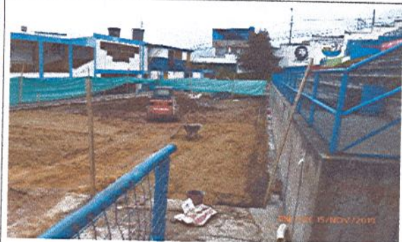
Fotografía No. 4: Extendida de recebo, después de perfilar piso.
