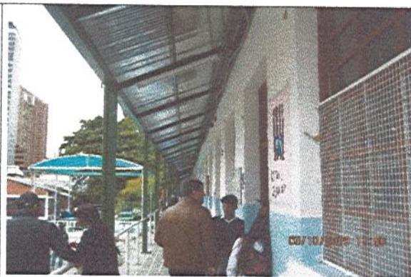
Fotografía No. 4: MUROS-PASILLO NIVEL 1
