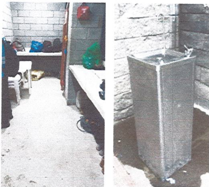
Fotografía 32. Campamento y Vestieres Colegio La Giralda
