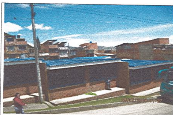
Fotografía No. 1: Fachada exterior - Cubierta
