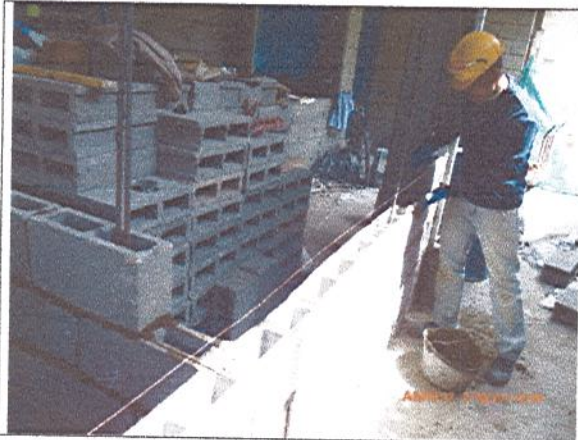
Fotografía No. 5: Mampostería perimetral bodega cocina
