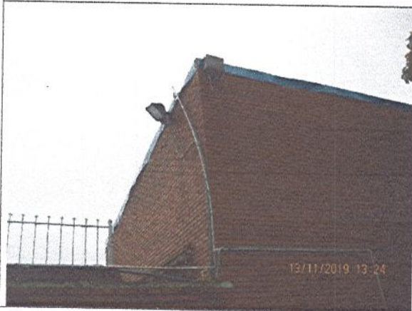
Fotografía No. 3: Montaje flanches – perímetro cubierta – sobre muros
