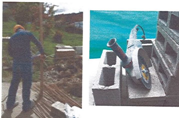
Fotografía 7. Trabajos con Pulidora
