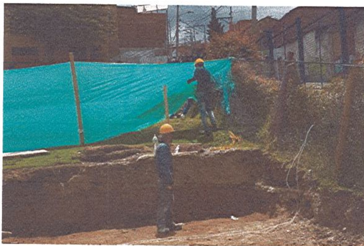
Fotografía 8. Cerramiento de la obra
