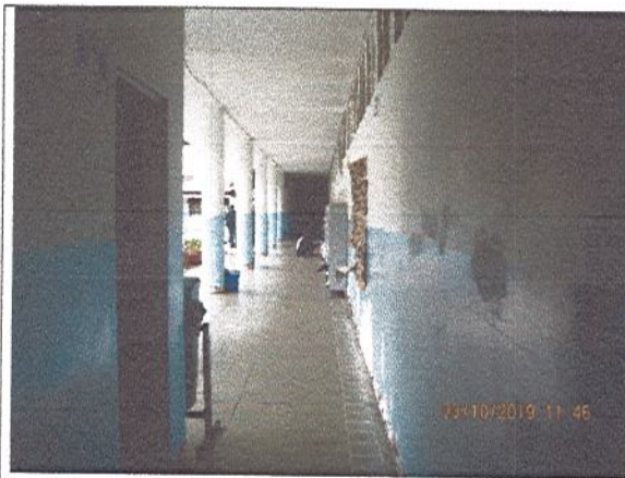
Fotografía No. 1: ASPECTO MUROSPASILLO NIVEL 2
