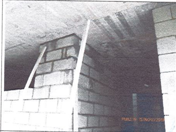
Fotografía No. 6: Mampostería perimetral bodega cocina.
