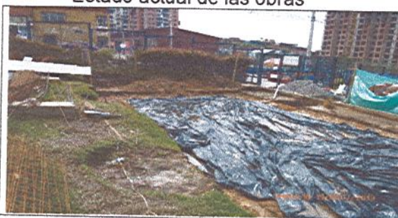
Fotografía No. 1: Zona definida para construir placa
