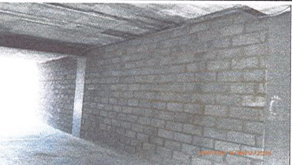
Fotografía No. 7: Presentación exterior costado occidental -muro en bloque - salón música.
