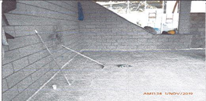
Fotografía No. 4: Emboquille piso en granito - salón de música.
