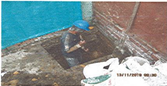
Fotografía No. 1: Excavación de zapata - Eje No 1
