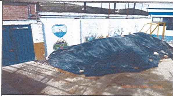
Fotografía No. 1: Acopio de recebo para generar capa en cancha
