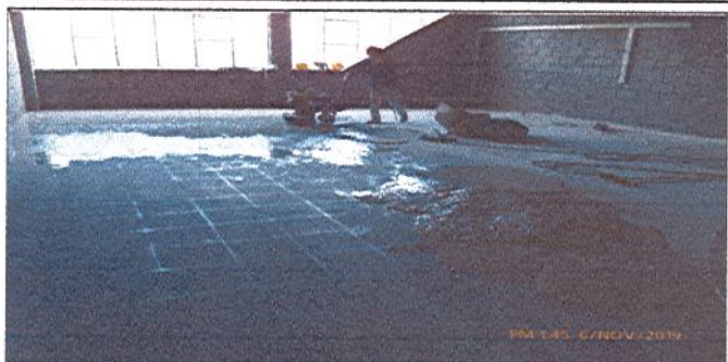
Fotografía No. 4: Pulida de piso en granito- salón de música.
