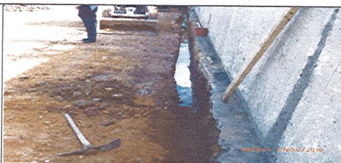
Fotografía No. 2: Excavación de terreno para construcción de filtro frances.
