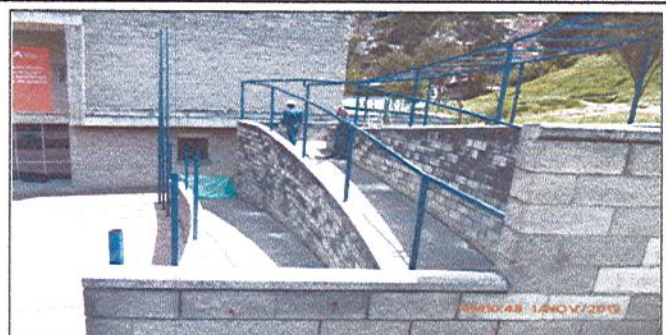
Fotografía No. 4: Estructura para cubierta - rampa
