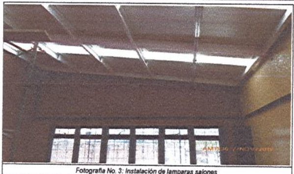
Fotografía No. 3: Instalación de lámparas salones
