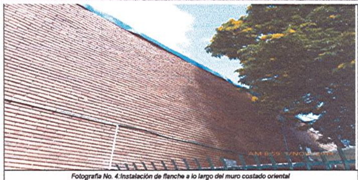
Fotografía No. 4: Instalación de flanche a lo largo del muro costado oriental
