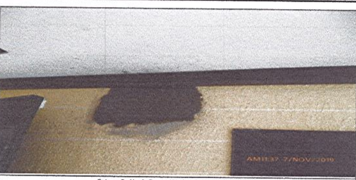
Fotografía No. 6: Reparación de tubería y sello en muro
