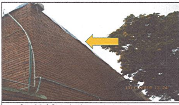
Fotografía No. 5: Flanchos de cubierta para mejorar instalación y asegurar aleta
