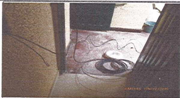
Fotografía No. 1: Se realiza cableado para alimentar red electrica de iluminación y sensor- pasillo entrada salones
