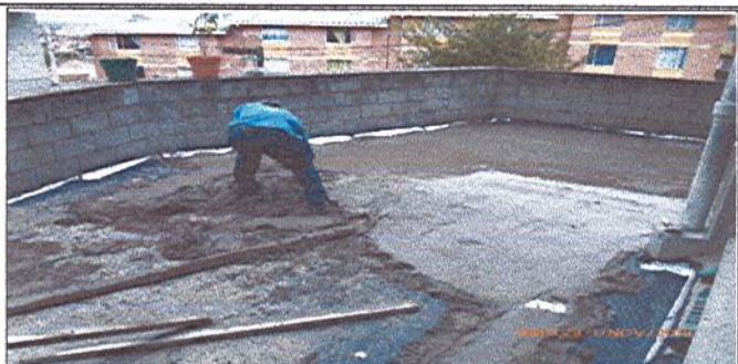
Fotografía No. 2: Construcción sobre-piso - balcones parrulos.
