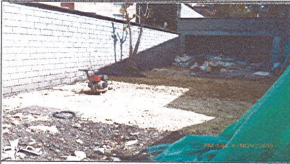
Fotografía No. 1: Recebado zona contigua a salón de artes
