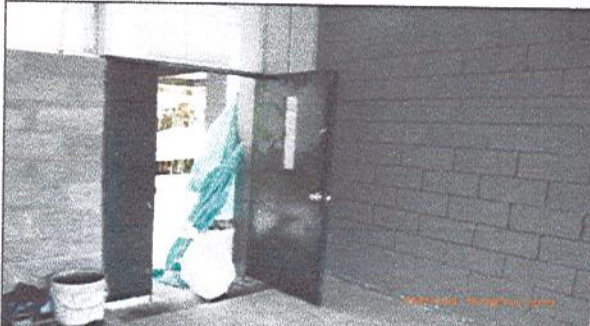
Fotografía No. 5: Puerta adecuada a la entrada - salón de artes.
