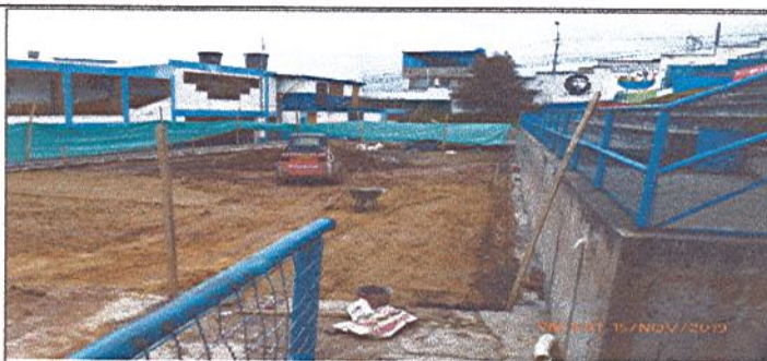
Fotografía No. 2: Instalación de capa de recebo antes de instalar geotextil.
