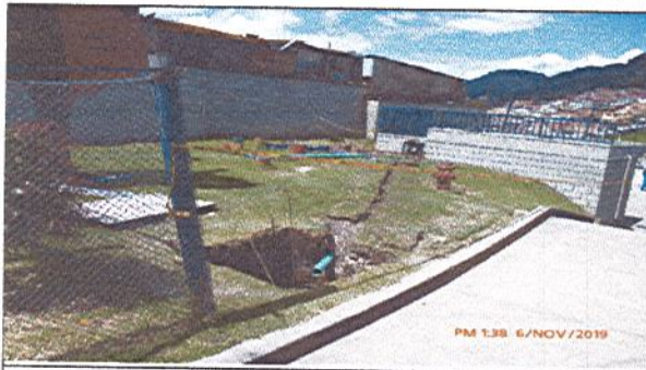
Fotografía No. 5: Excavación e instalación tubería eléctrica
