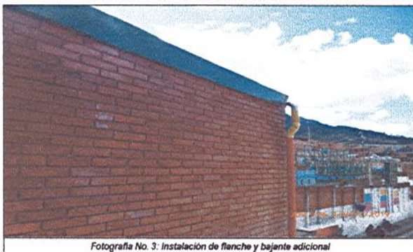
Fotografía No. 3: Instalación de flanche y bajante adicional
