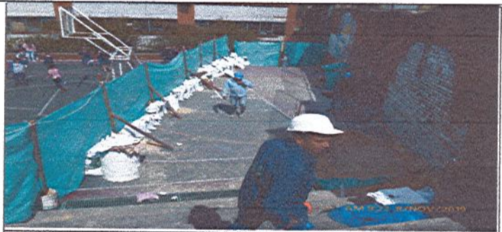
Fotografía No. 2: Excavación de zapatas - cimentación de cerramiento nuevo - paralelo a muro antiguo.
