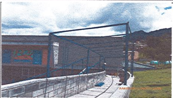
Fotografía No. 3: Se inicia proceso de montaje estructura soporte cubierta rampa
