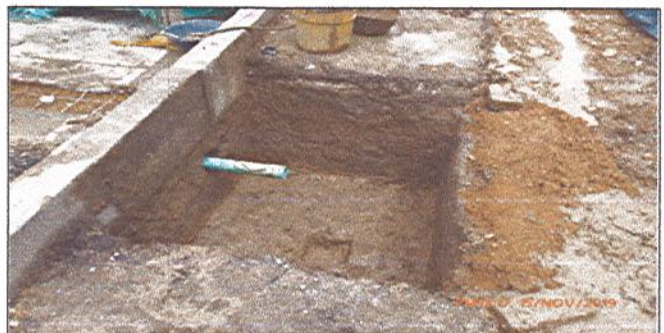
Fotografía No. 6: Excavación para caja electrica - alimentación cocina - móvil
