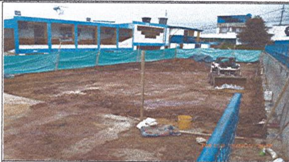
Fotografía No. 1: Perfilado de piso con mini cargador
