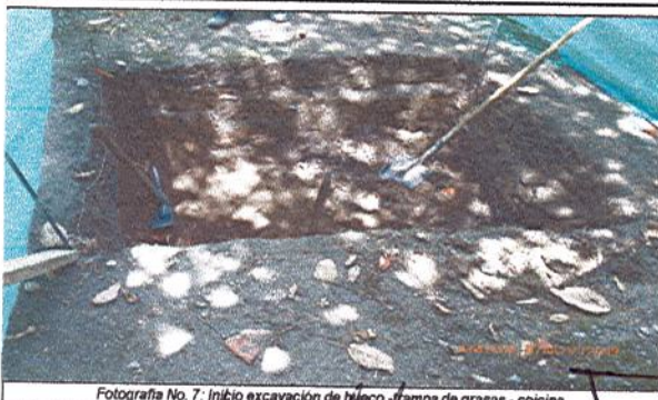
Fotografía No. 7: Inicio excavación de hueco -trampa de grasas - cocina
