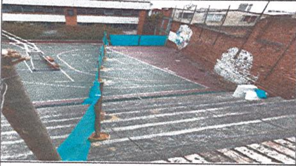
Fotografía No. 1: Cerramiento perimetral - zona a intervenir
