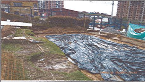
Fotografía No. 1: Material- recebo acopiado para relleno - zona placa cocina móvil
