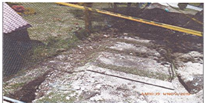
Fotografía No. 6: Se inicia el retape de tubería eléctrica - alimentación cocina - móvil
