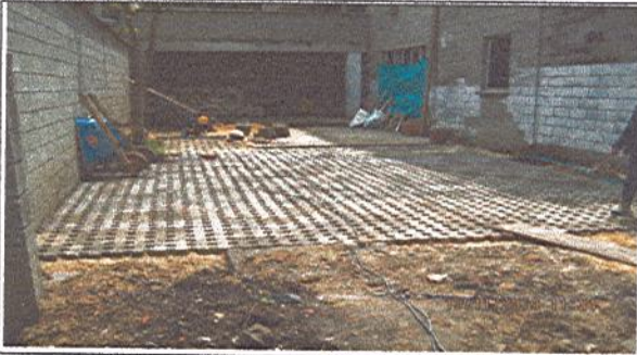
Fotografía No. 1: Instalación de adoquín ecológico - zona contigua a salón de artes
