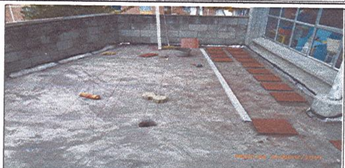
Fotografía No. 4: Instalación de piso cerámico - balcones - frente a salón parbulos.
