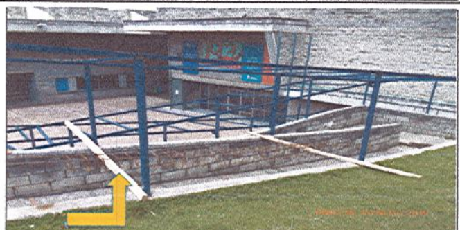
Fotografía No. 4: Estructura para cubierta -rampa - armado viga para placa cocina móvil.
