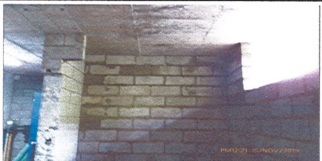
Fotografía No. 8: Continuación- mampostería almacén cocina
