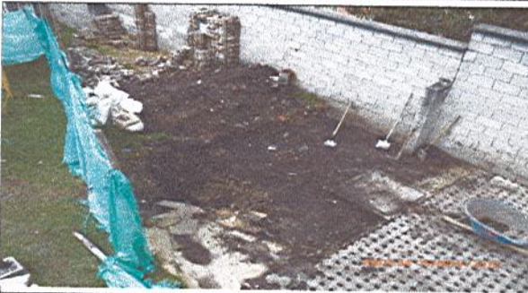
Fotografía No. 3: Continuación de arreglo piso para instalación de adoquín ecológico - zona contigua - salón de artes.
