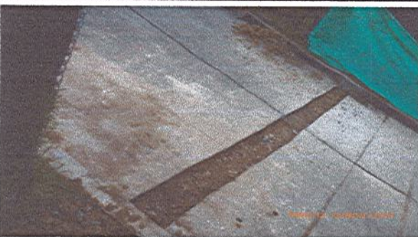
Fotografía No. 3: Demolición placa- para cruce tubería eléctrica - entrada parqueadero vehicular
