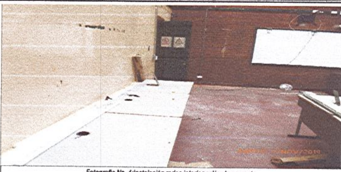
Fotografía No. 4: Instalación redes interior salón de computo
