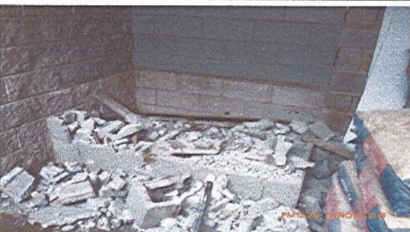
Fotografía No. 7: Demolición mampostería antigua- para ampliar espacios almacén cocina
