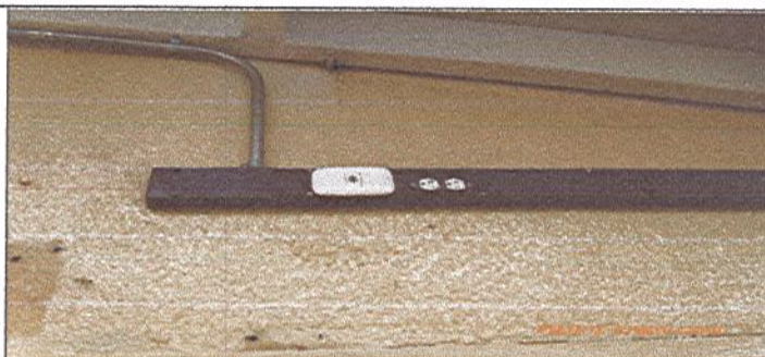
Fotografía No. 2: Montaje de tubería y cableado interior salones.
