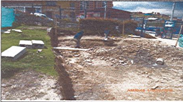
Fotografía No. 1: Se perfila piso y se continua retiro de material excavado
