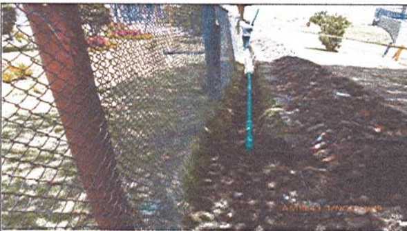
Fotografía No. 5: Excavación e instalación tubería eléctrica
