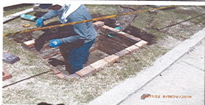
Fotografía No. 6: Se construye caja eléctrica - alimentación cocina móvil
