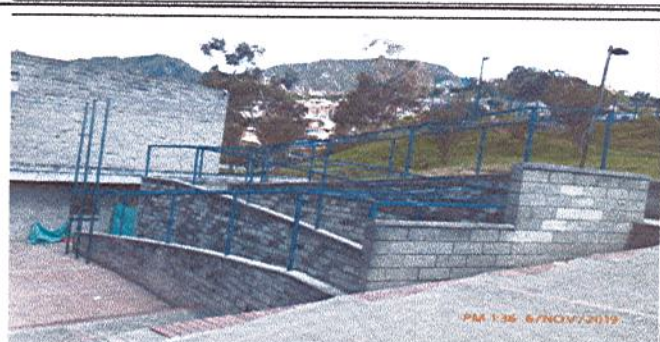
Fotografía No. 4: Estructura para cubierta - rampa
