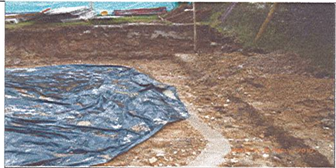
Fotografía No. 2: Excavación para piso zona zarpa -muro de contención- cocina -móvil
