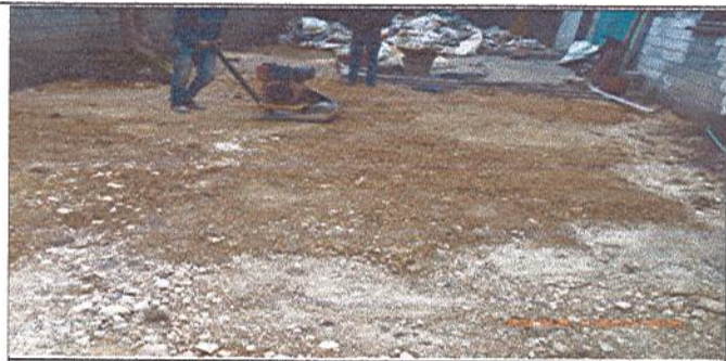
Fotografía No. 2: Compactación de recebo- zona contigua a salón de artes.
