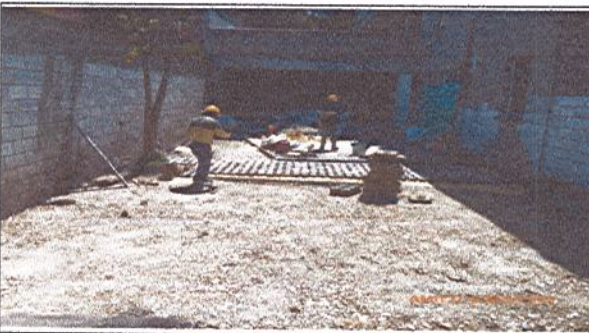
Fotografía No. 3: Instalación de adoquín ecológico- zona contigua - salón de artes.
