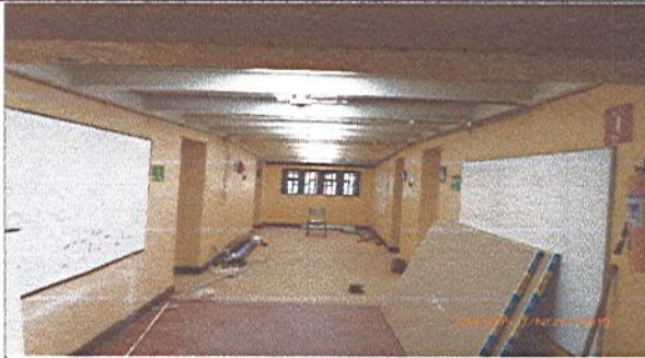
Fotografía No. 1: Se instala tubería, para red eléctrica de iluminación y sensor- pasillo entrada salones
