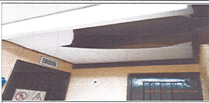
Fotografía No. 4: Cielo raso a la salida del cuarto de musica por terminar.
