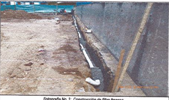
Fotografía No. 3: Construcción de filtro frances.
