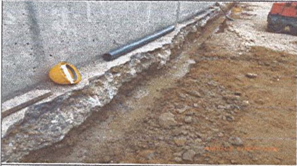
Fotografía No. 1: Excavación para construcción de filtro
