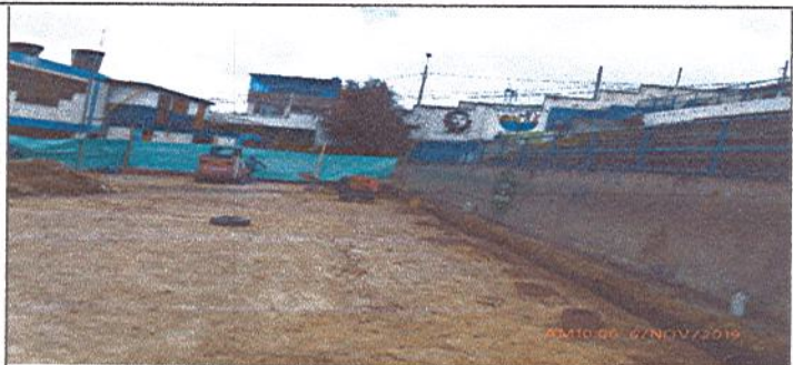
Fotografía No. 2: Excavación de terreno a lo largo base del muro - para construcción de filtro frances.
