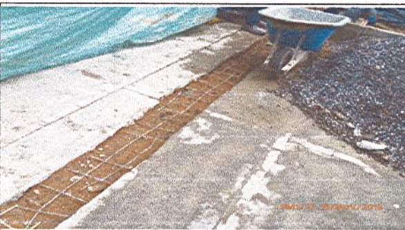
Fotografía No. 5: Demolición placa - entrada colegio- instalación tubería eléctrica
