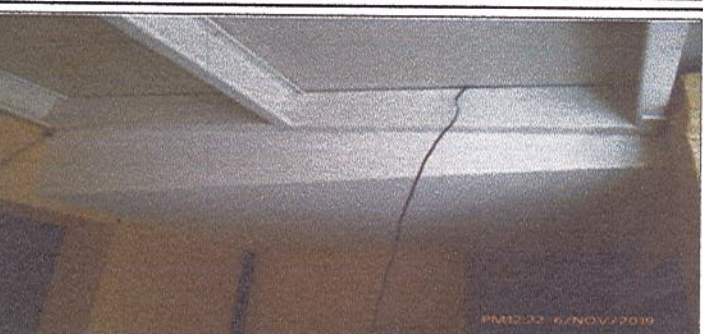
Fotografía No. 8: Instalación de cielo raso a la entrada sala emisora
