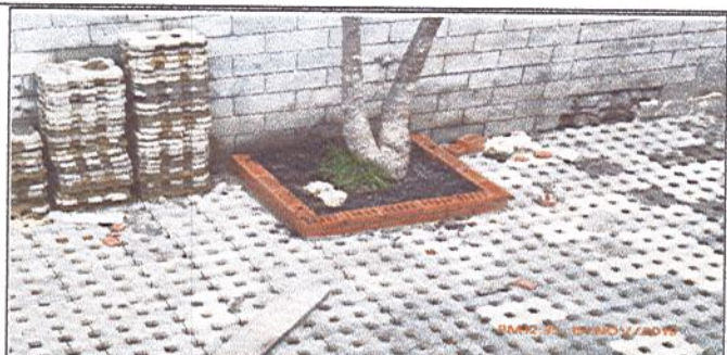
Fotografía No. 2: Construcción de matero - confinamiento árbol - zona contigua a salón de artes.
