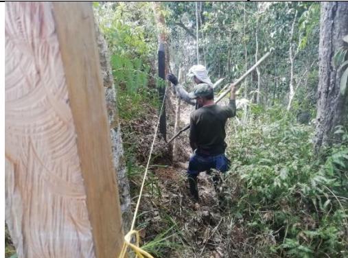
Foto 117. Labores de hincado de postes
