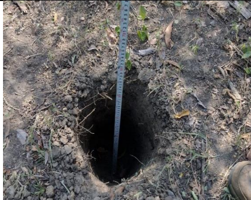
Foto 89. Ahoyado de 50 cm de profundidad
