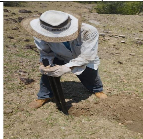
Foto 92. Labores de hincado
