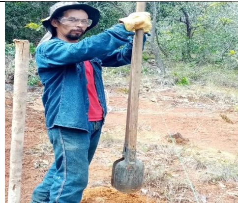
Foto 66. Ahoyado de 50 cm
