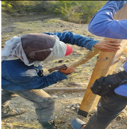
Foto 97. Aislamiento de postes
