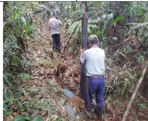
Foto 104. Hincado de postes
