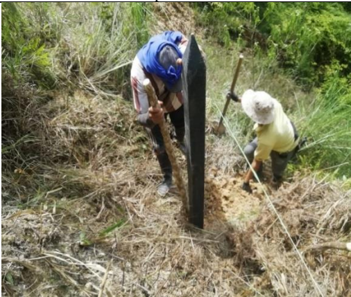
Foto 116. Apretado de postes
