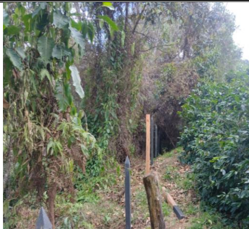
Foto 59. Hincado de postes
