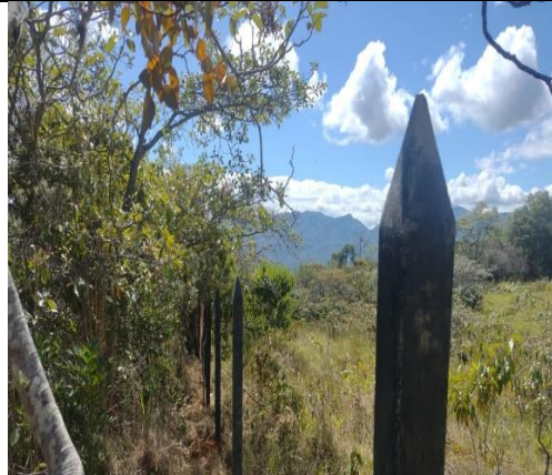
Foto 43. Línea con postes hincados
