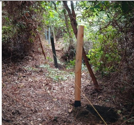
Foto 67. Línea con hincado de postes
