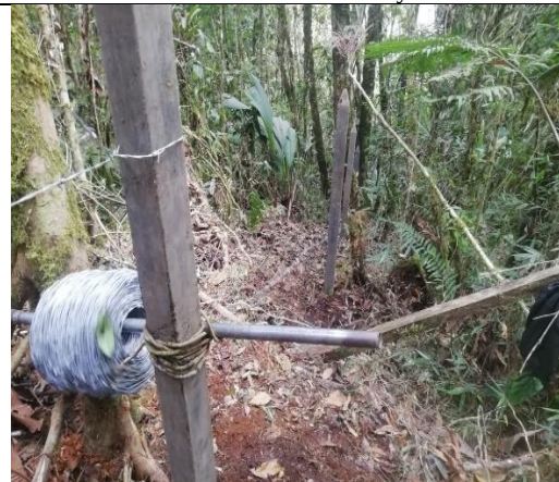
Foto 109. Labores de regado de alambre
