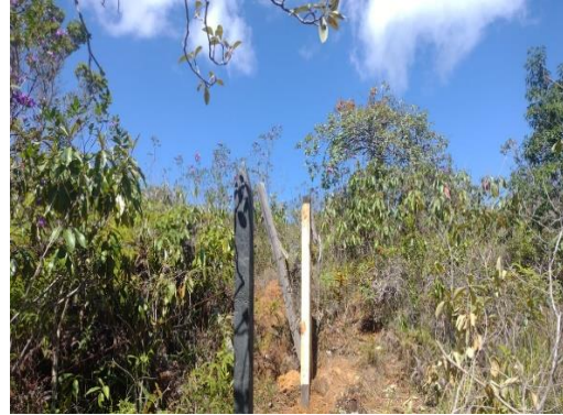
Foto 42. Labores de hincado
