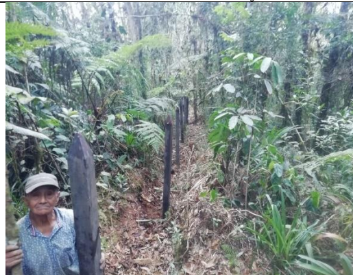
Foto 105. Hincado de postes
