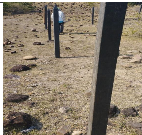
Foto 94. Línea de hincado de postes
