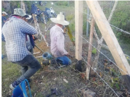
Foto 125. Tendido y grapado de alambre
