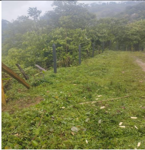
Foto 7. Labores de hincado de postes
