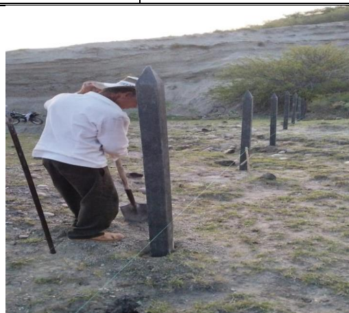
Foto 84. Labores de hincado
