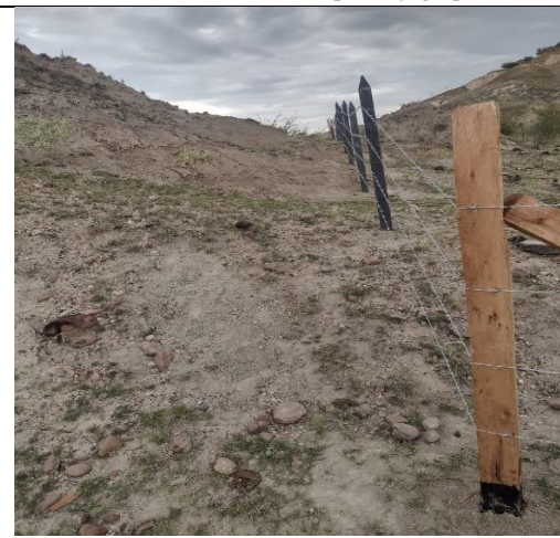
Foto 100. Aislamiento terminado con 4 líneas de alambre
