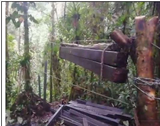
Foto 101. Transporte de postes
