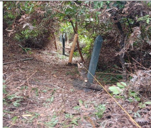
Foto 68. Hincado de postes
