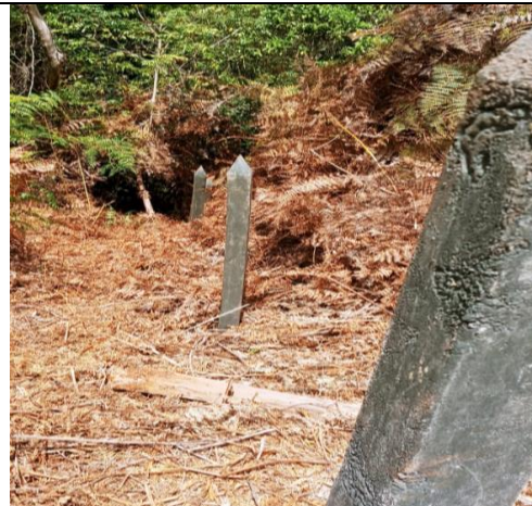
Foto 30. Hincado de postes
