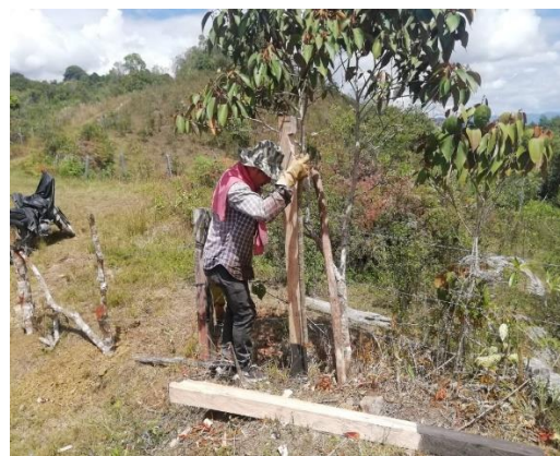
Foto 123. Labores de hincado de postes
