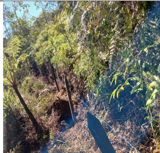
Foto 48. Hincado de postes
