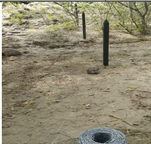
Foto 95. Labores de templado de alambre
