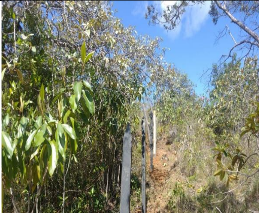
Foto 44. Hincado de postes
