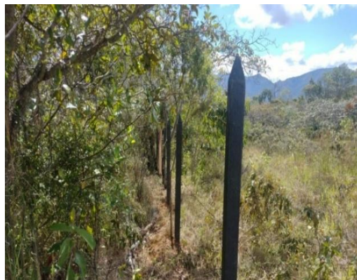
Foto 39. Labores de hincado de postes
