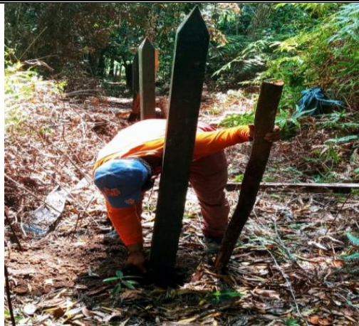
Foto 17. Labores de hincado
