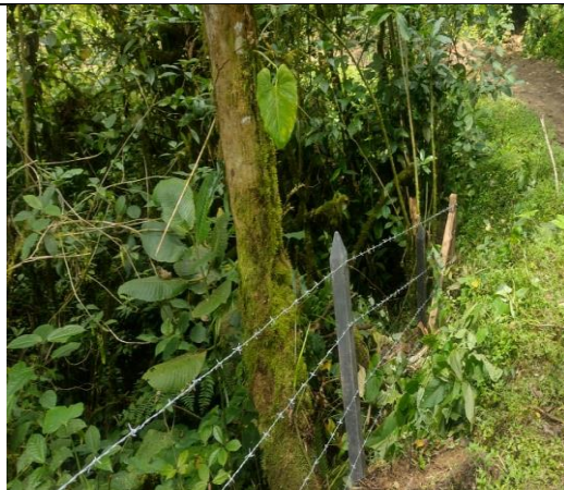
Foto 9. Labores de templado y grapado de aislamiento
