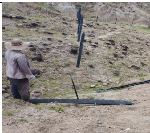
Foto 82. Labores de hincado
