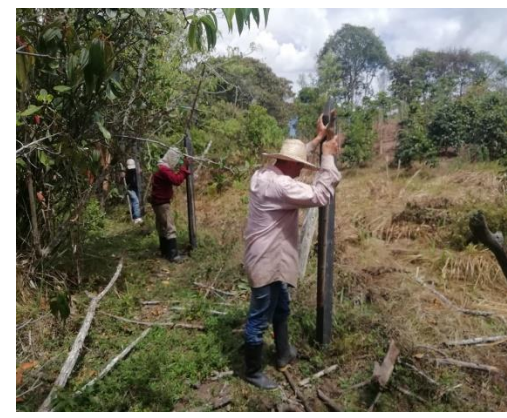
Foto 124. Hincado de postes
