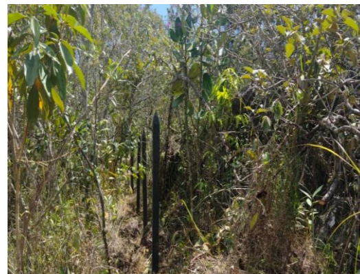
Foto 40. Hincado de postería
