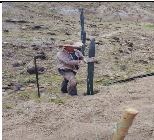
Foto 83. Línea para hincado de postes
