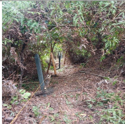
Foto 47. Labores de hincado
