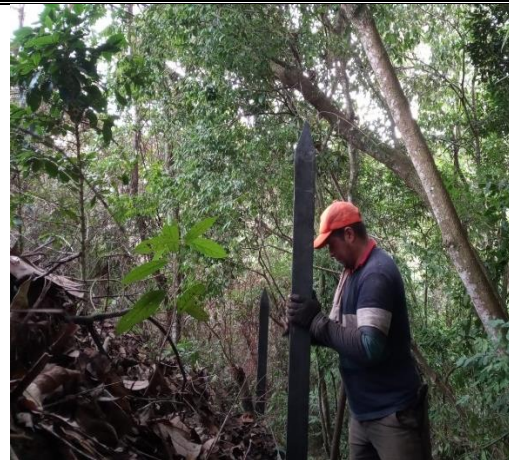
Foto 60. Hincado de postes
