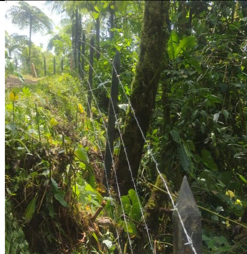
Foto 8. Labores de templado y grapado de alambre
