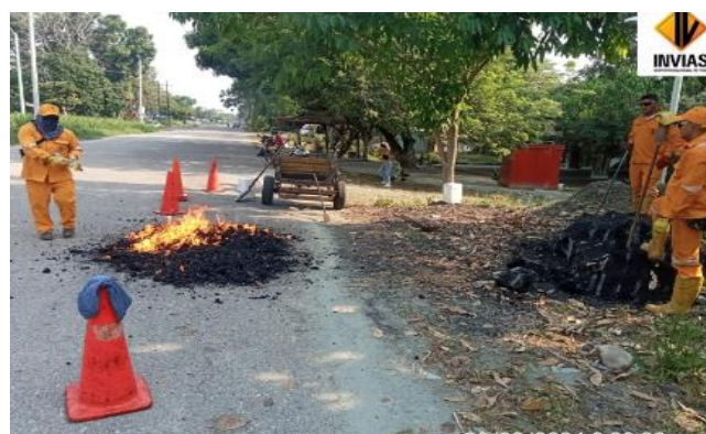
Bacheo del PR 105+000 AL 106+000 Ruta 65A02
