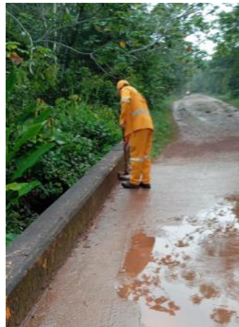
Ilustración 10 Limpieza de puentes en la ruta 6508 variante 65MTA
