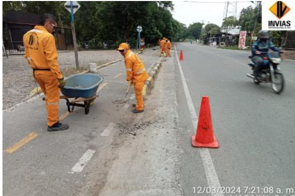
Limpieza de berma del Variante 65amtc Ruta 65A02
