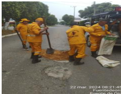
Tapado de huecos del PR 87+000 AL 89+000 Ruta 6508
