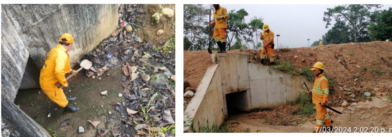
Ilustración 7 limpieza de obras hidráulicas en la ruta 65 A02
