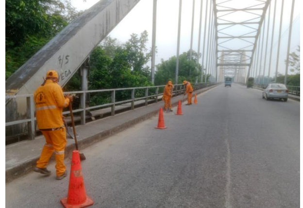
Ilustración 9 Limpieza de puentes en la ruta 65 A02
