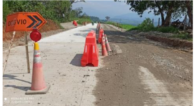
Ilustración 3 Construcción de vía en pavimento rígido del PR 11+0000
