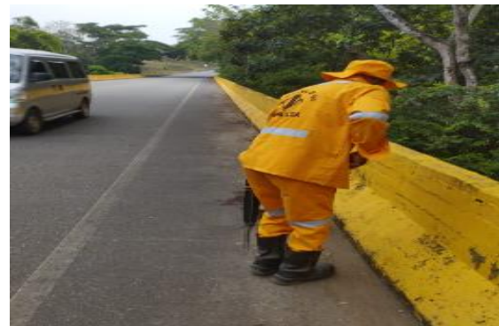
Limpieza de puente Iraca del PR 56+000 Ruta 6508
