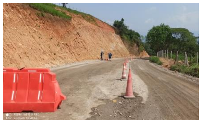
Ilustración 4 Construcción de vía en pavimento rígido del PR 11+0600
