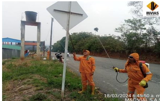
Limpieza de señalizaciones del PR 83+000 AL 89+000 Ruta 65A02
