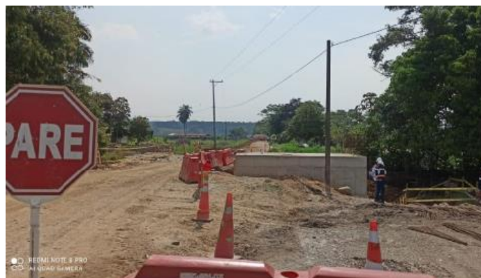
Ilustración 5 Construcción de vía en pavimento rígido del PR 11+0700
