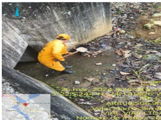
Limpieza de alcantarilla del PR 56+000 AL 59+000 Ruta 65A02
