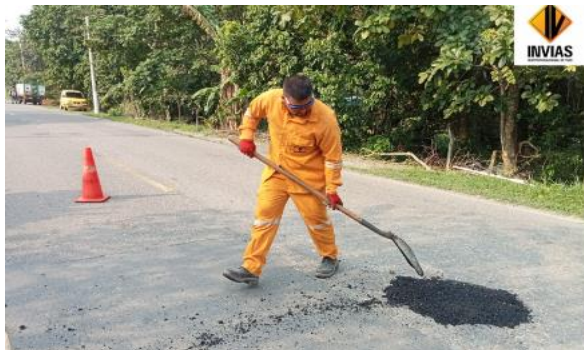
Bacheo del PR 108+000 AL 109+000 Ruta 65A02
