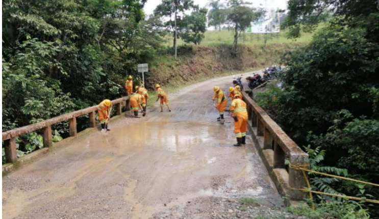
Ilustración 8 Limpieza de puentes en la ruta 65 A02
