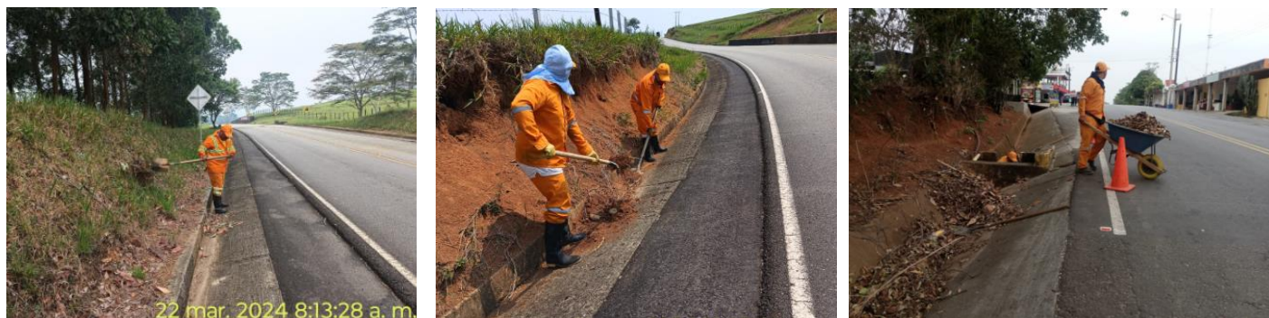
Ilustración 6 limpieza de cunetas en la ruta 65A02
