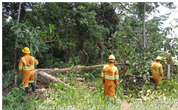
Retiro de arbol del PR 36+000 AL 37+000 Ruta 65A02
