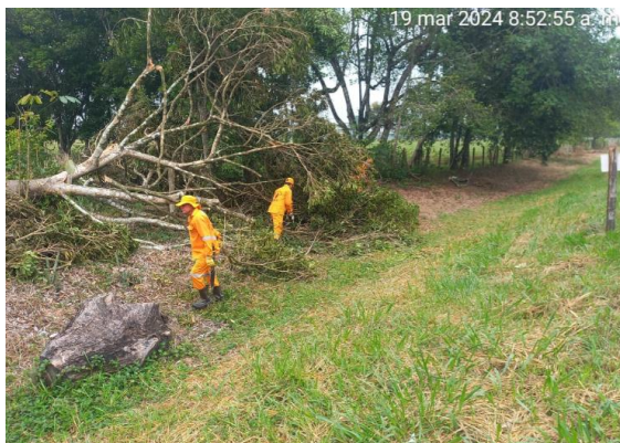
Ilustración 13 Retiro de árboles en la ruta 6508
