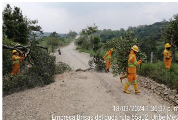
Retiro de arbol del PR 28+000 AL 36+000 Ruta 65A02
