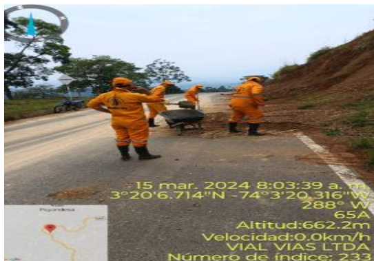
Remocion de derumbes del PR 47+000 al 49+000 Ruta 65A02
