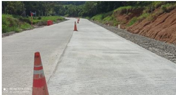
Ilustración 2 Construcción de vía en pavimento rígido del PR 09+0000
