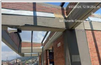
Desmante de cubierta
