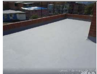
Impermeabilización de placa 1
