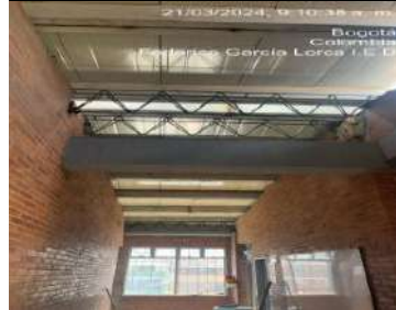
Instalación de cubierta
