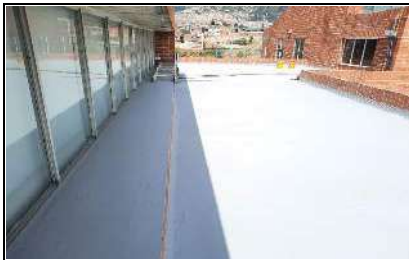
Impermeabilización de placa 1
