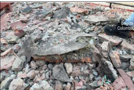
Demolición de circulaciones
