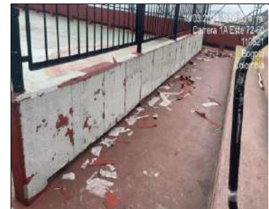
Retiro de Manto sobre la superficie
