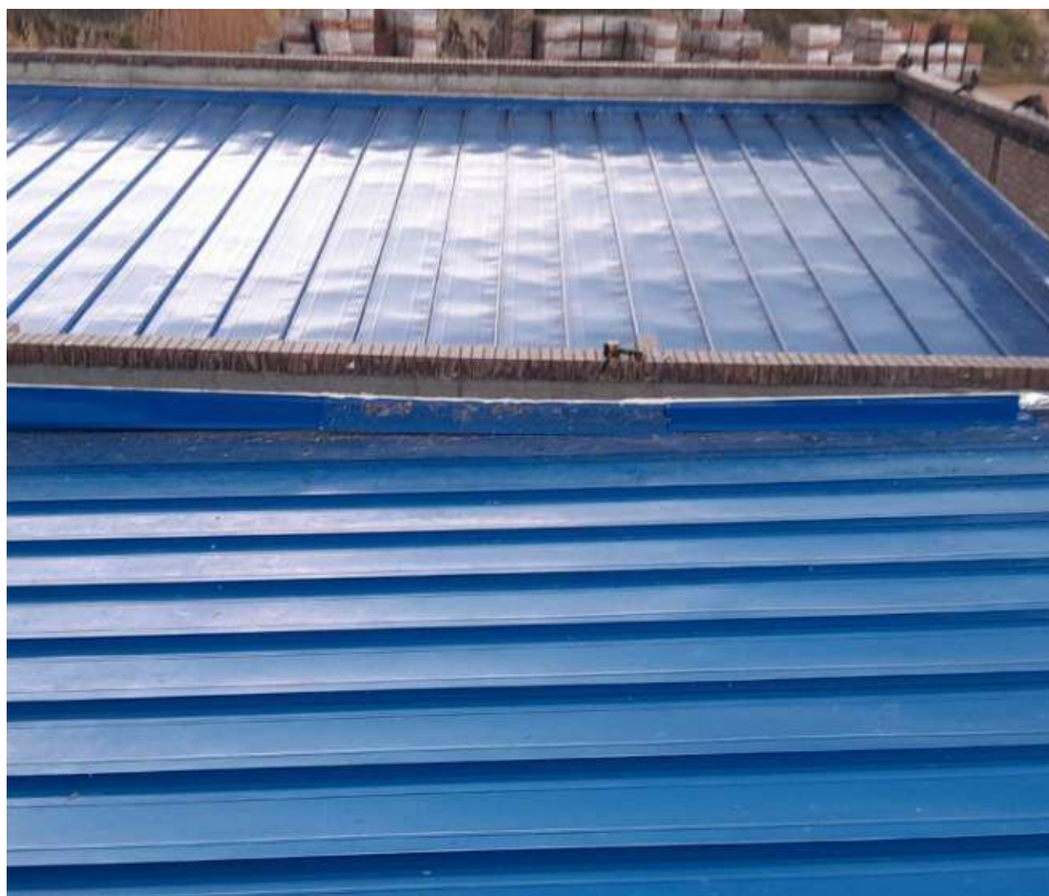
Ilustración 4 Sellado con flanche y cinta sika.
