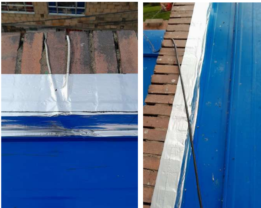
Ilustración 2 Sellado con cinta sika.
