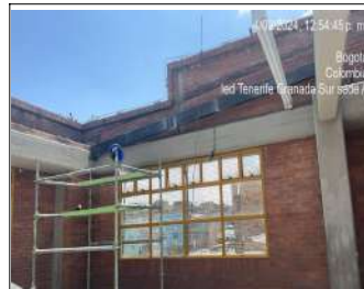
Instalación de perfiles en cubierta
