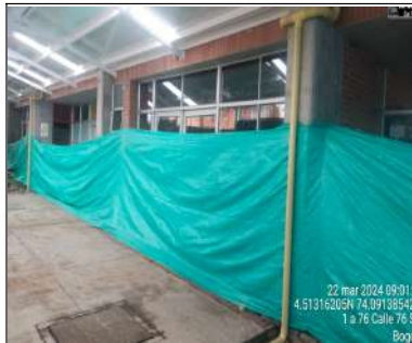
Instalación de bajantes
