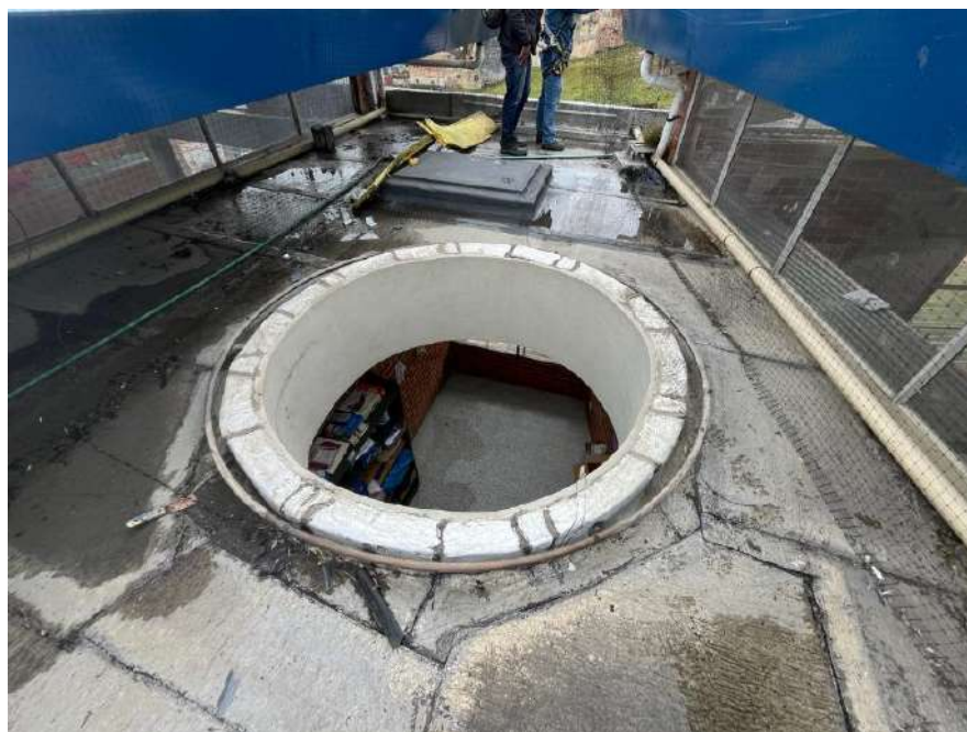
Ilustración 9 Desmonte total de cubierta.
