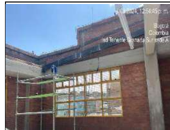
Instalación de perfiles en cubierta
