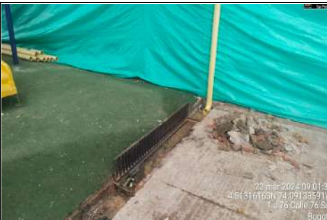
Instalación de bajantes
