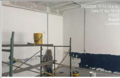
Resane y Pintura en salones
