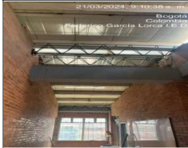
Instalación de cubierta
