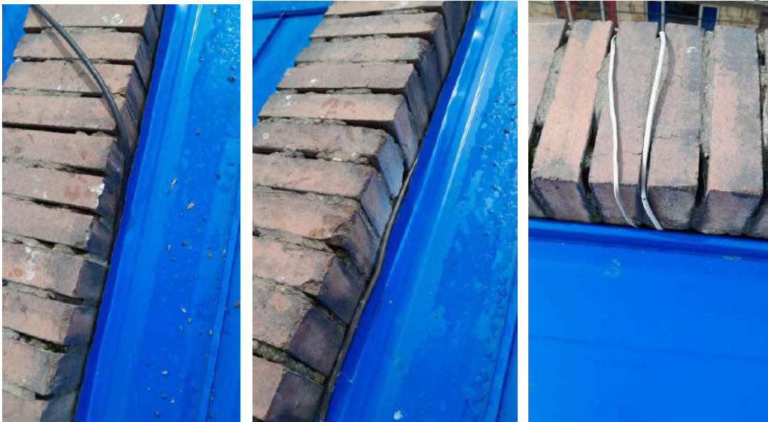
Ilustración 1 cableado por cubierta.
