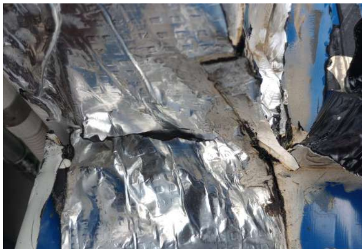
Ilustración 12 Desprendimiento cinta.
