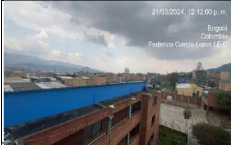
Desmonte de manto asfáltico
