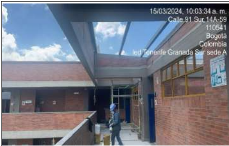
Desmante de cubierta
