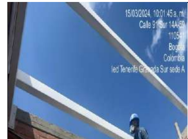
Instalación de perfilera metálica
