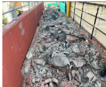
Demolición de circulaciones
