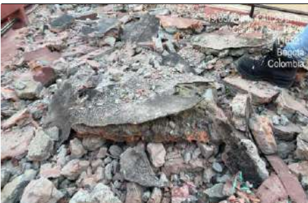
Demolición de circulaciones
