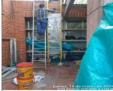
Instalación de escalera gato
