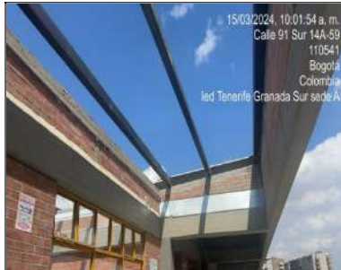
Instalación de perfilera metálica
