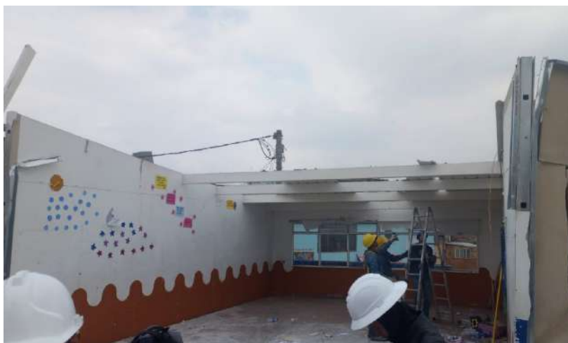
Ilustración 4 Estado posterior al desmonte de elementos en mal estado.
