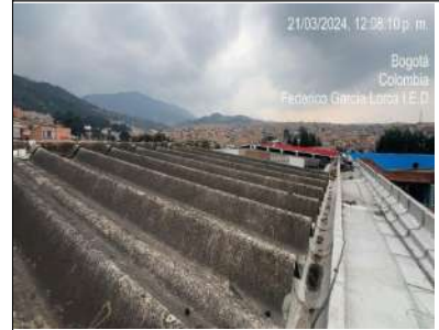
Desmante de cubierta
