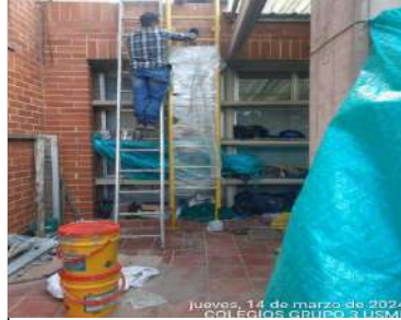
Instalación de escalera gato
