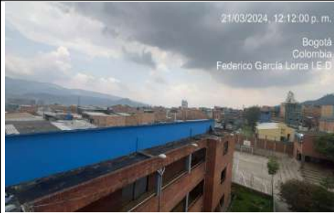
Desmante de manto asfáltico
