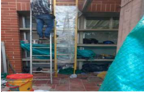
Instalación de escalera gato
