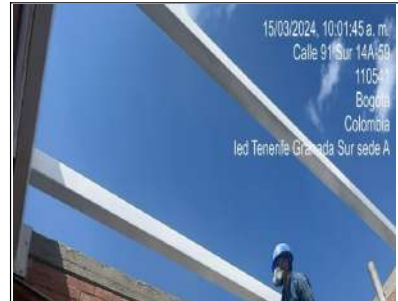
Instalación de perfilera metálica
