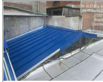
Instalación de cubierta en zona administrativa
