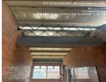
Instalación de cubierta
