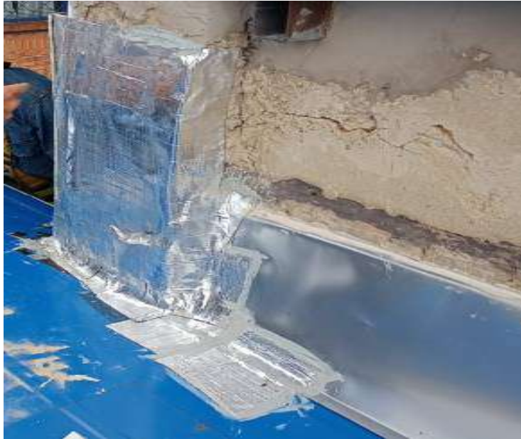
Ilustración 13 Ajuste cinta Sika.
