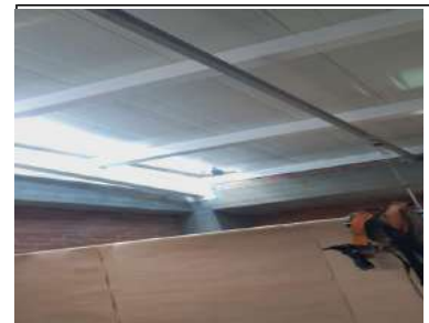
Instalación de cubierta
