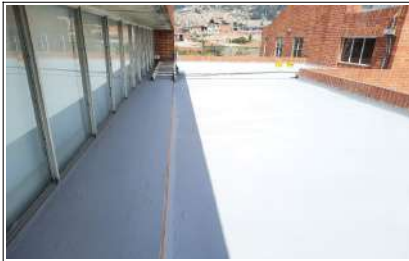
Impermeabilización de placa 1
