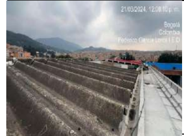
Desmonte de cubierta
