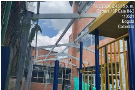
Instalación de porticos
