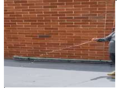
Prueba de impermeabilización
