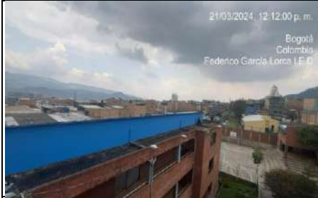
Desmonte de manto asfáltico
