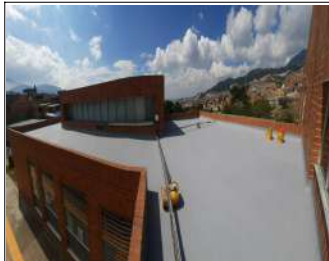
Impermeabilización de placa 1
