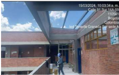
Desmonte de cubierta
