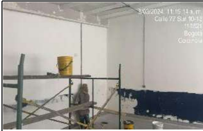
Resane y Pintura en salones
