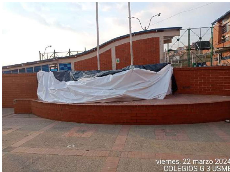
Ilustración 15 Acopio elementos desmontados.
