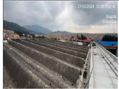
Desmante de cubierta
