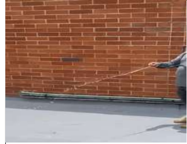
Prueba de impermeabilización
