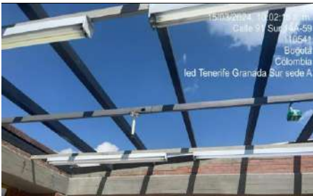
Instalación de perfilera metálica
