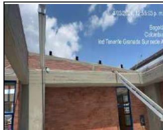
Instalación de perfiles en cubierta
