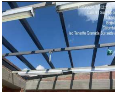
Instalación de perfiles en cubierta
