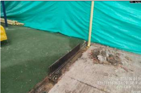
Instalación de bajantes
