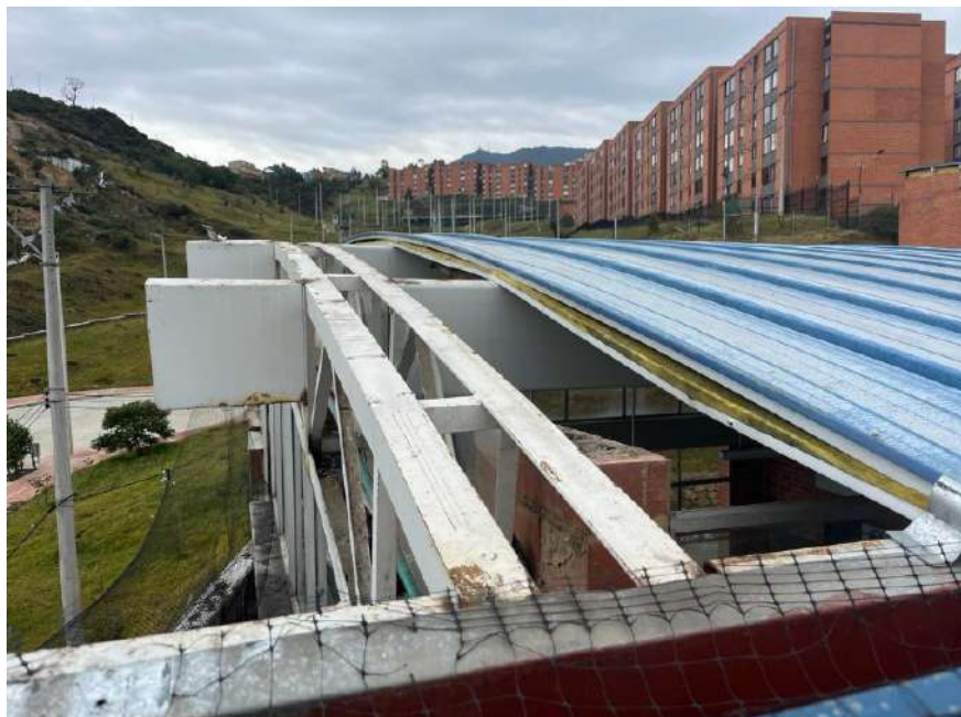
Ilustración 8 Desmonte total de elementos a nivel de cubierta.
