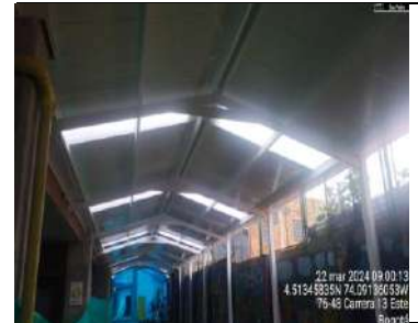
Instalación de cubierta
