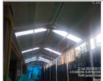
Instalación de cubierta
