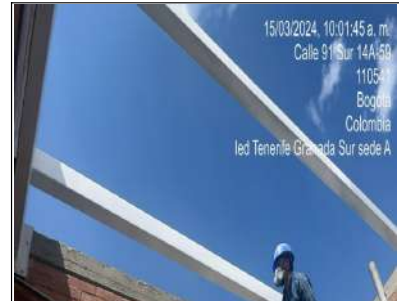
Instalación de perfilera metálica
