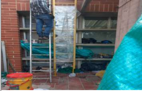
Instalación de escalera gato
