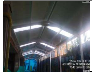
Instalación de cubierta
