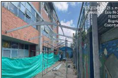
Armado de Porticos
