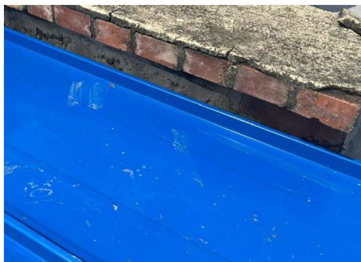
Ilustración 10 Remate cubierta y muro.
