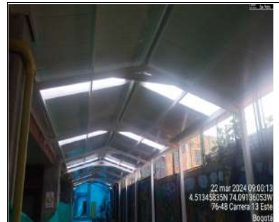
Instalación de cubierta
