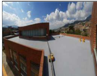
Impermeabilización de placa 1
