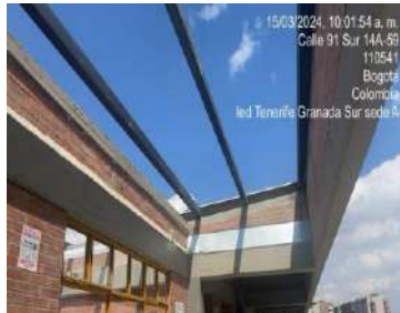
Instalación de perfilera metálica
