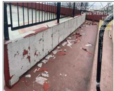
Retiro de Manto sobre la superficie
