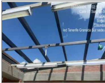
Instalación de perfiles en cubierta
