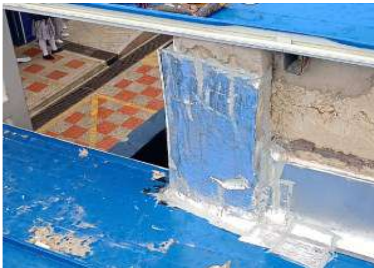
Ilustración 15 Ajuste cinta Sika.
