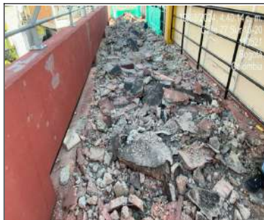
Demolición de circulaciones
