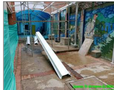
Instalación de canales
