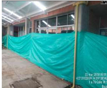
Instalación de bajantes
