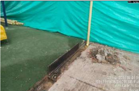
Instalación de bajantes
