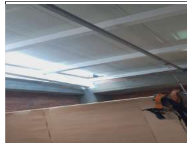
Instalación de cubierta
