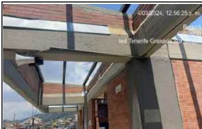
Desmante de cubierta
