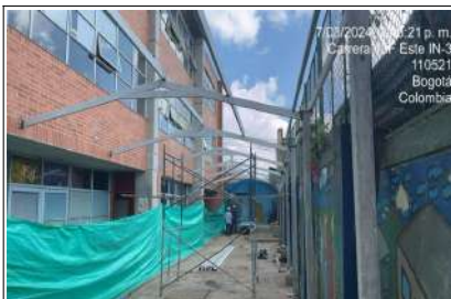
Armado de Porticos
