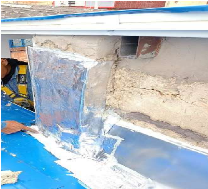
Ilustración 14 Ajuste cinta Sika.
