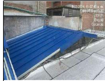
Instalación de cubierta en zona administrativa
