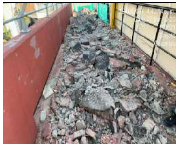
Demolición de circulaciones
