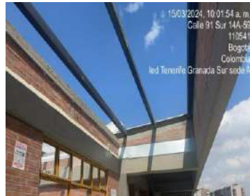
Instalación de perfilera metálica
