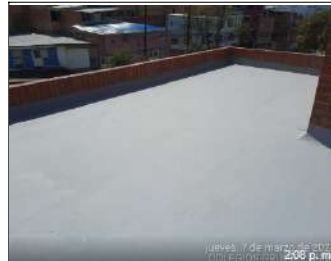
Impermeabilización de placa 1
