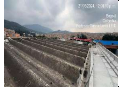
Desmonte de cubierta
