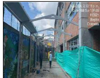
instalación de perfilieria metalica
