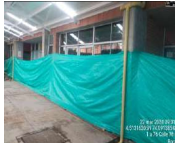
Instalación de bajantes
