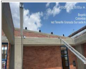
Instalación de perfiles en cubierta
