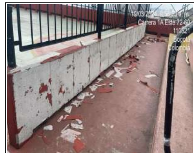
Retiro de Manto sobre la superficie
