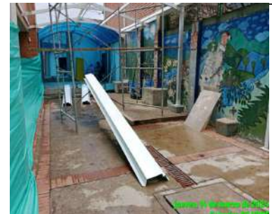
Instalación de canales
