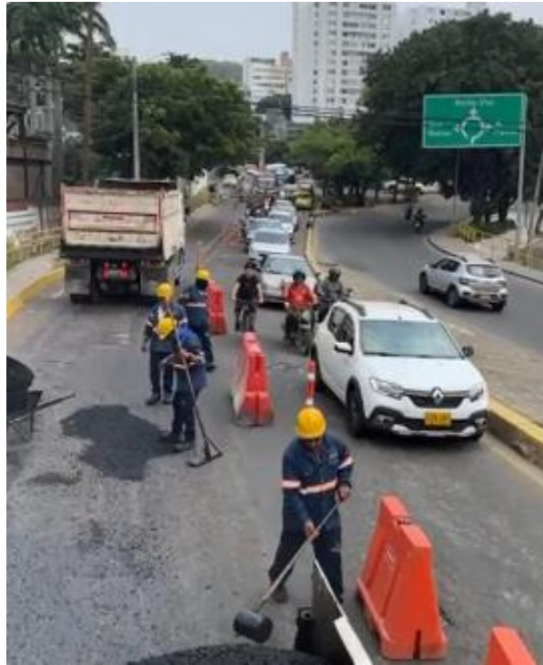
SUPERVISIÓN DE SEÑALIZACION EN AREAS INTERVENIDAS EN OBRA
