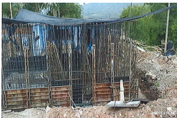
Instalación de formaleta metálica para muros bajos de la Ptap
