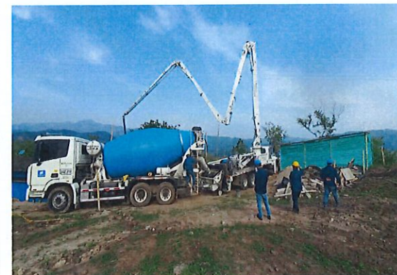
Fundición 29 de febrero Muros bajos de la Ptap
