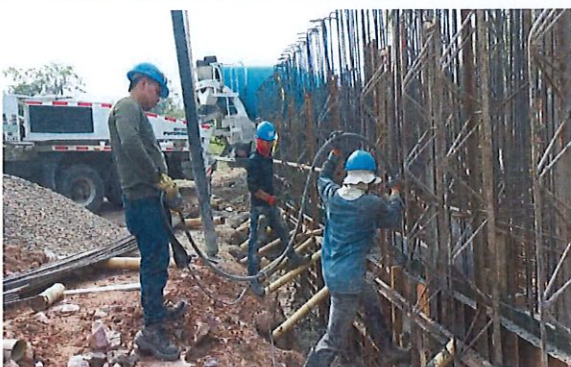
Vibrador de concreto en fundición de muros bajos de la Ptap
