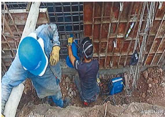
Intalación de formaleta y pasamuros para fundición de muros bajos Ptap
