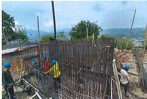
Vibrador de concreto en fundición de muros bajos de la Ptap
