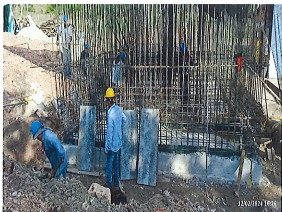
Instalación de formaleta metálica para muros bajos de la Ptap
