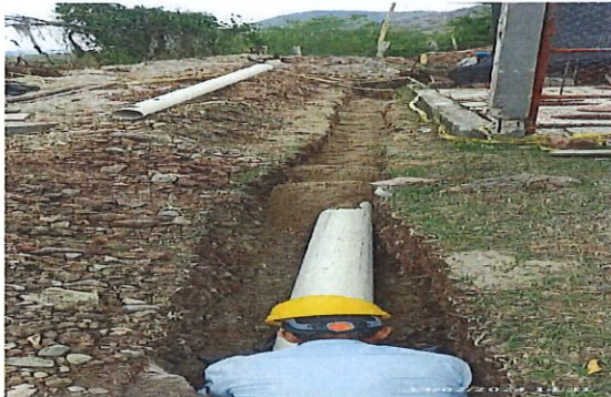
Instalación de tubería de 8"
