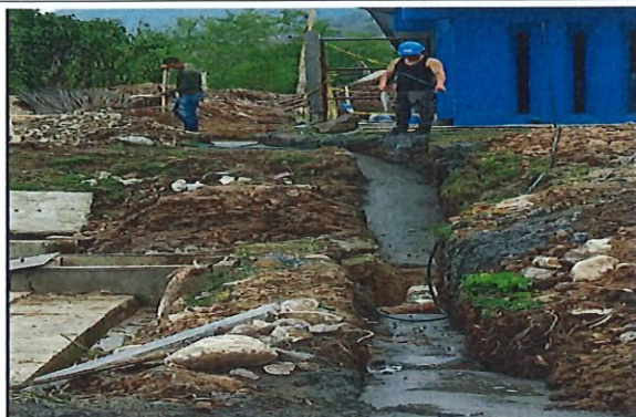
Vaciado de concreto para encofrado de tubería
