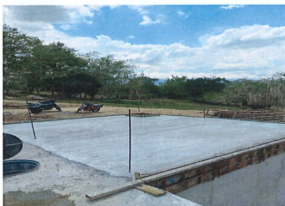
Estado final de caja de Salida del tanque de almacenamiento de agua potable
