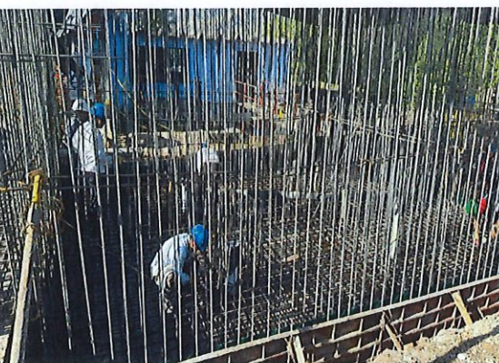
Vaciado de concreto Solado Ptap
