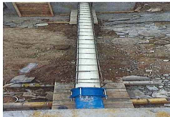
Figurado de Hierro para encofrado de tubería de 8"
