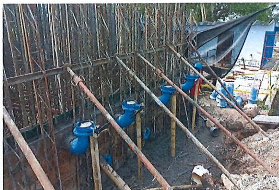
Intalación de Dispositivos en C
