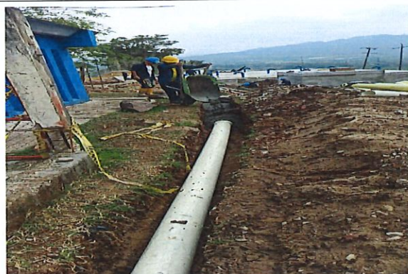
Vaciado de concreto para encofrado de tubería
