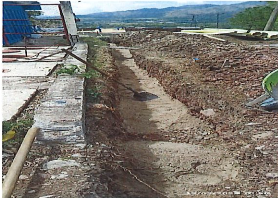
Cama de arena para tubería de 8"
