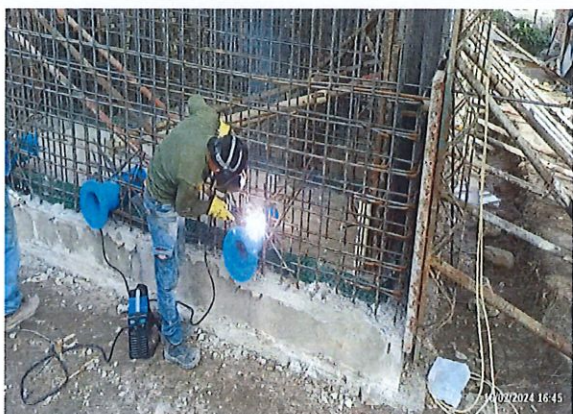
Soldadura de pasamuros para evitar movimiento en la fundición de muros
