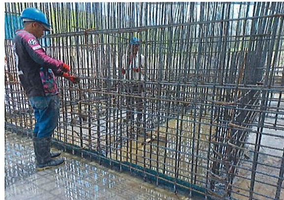
Figurado de Hierro para muros bajos de la Ptap
