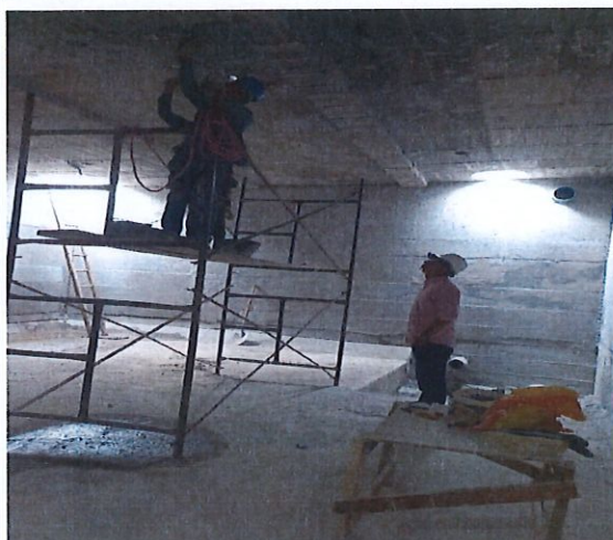
Trabajo en alturas, Uso correcto de Arnés de seguridad y línea de vida y andamios previamente verificados
