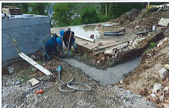
Instalación de tubería a caja de entrada del tanque de almacenamiento y a tanque antiguo
