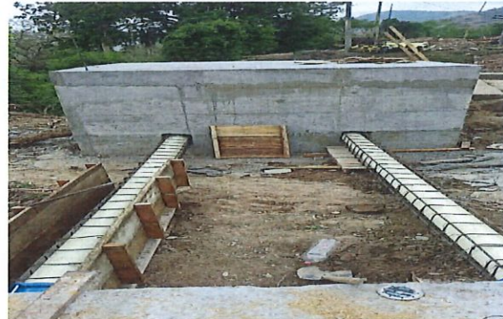
Intalación de tubería de 8" y encofrado de la misma Caja de entreda
