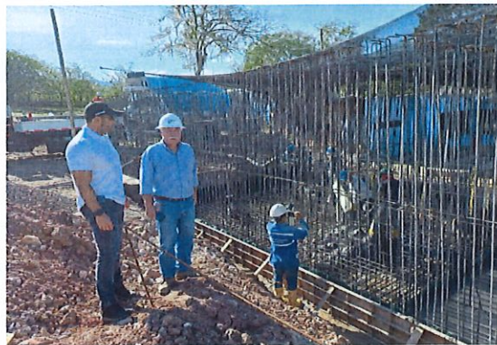
Fundición solado de Ptap-Supervisión Aguas del Huila
