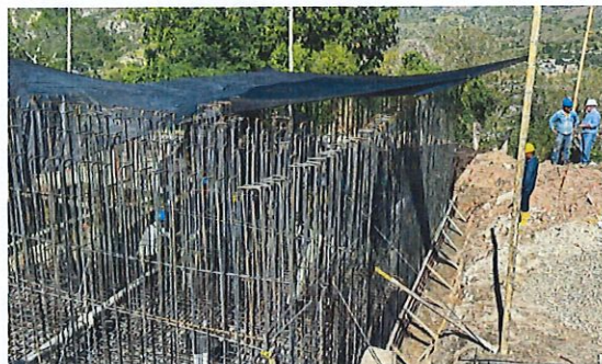
Fundición de solado Ptap
