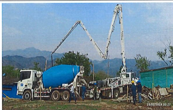
Fundición 29 de febrero Muros bajos de la Ptap
