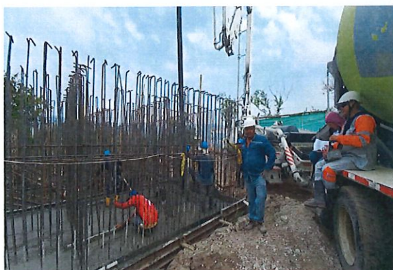
Vaciado de concreto Fundición de muros bajos de Ptap
