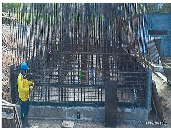
Figurado de Hierro para muros bajos de la Ptap
