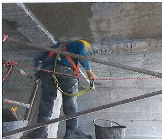
Trabajo en alturas, Uso correcto de Arnés de seguridad y línea de vida
