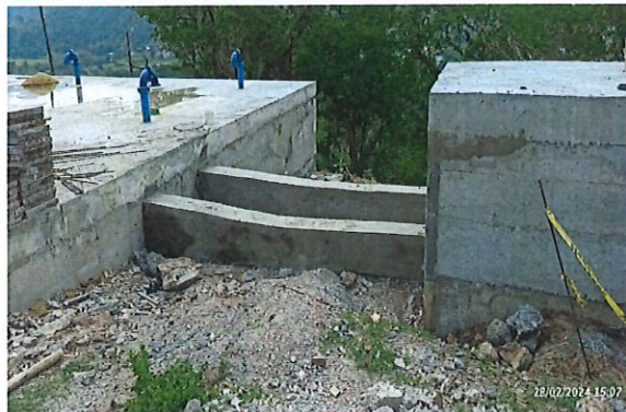
Fundición de encofrado de tubería caja de entrada a tanque de almacenamiento
