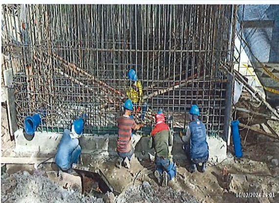
Soldadura de pasamuros para evitar movimiento en la fundición de muros
