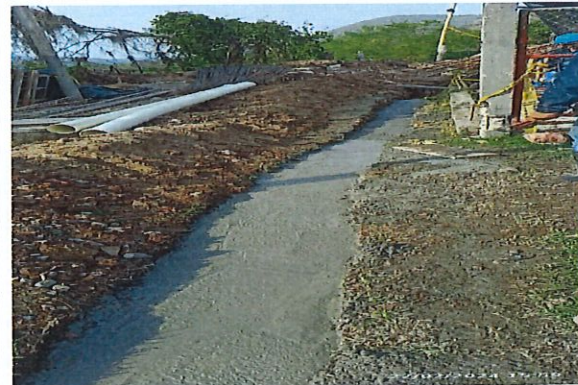
Vaciado de concreto para encofrado de tubería
