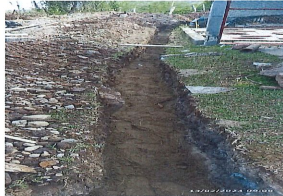
Cama de arena para tubería de 8"
