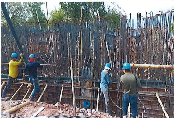
Fundición 29 de febrero Muros bajos de la Ptap
