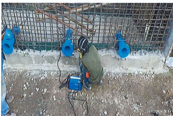
Soldadura de pasamuros para evitar movimiento en la fundición de muros
