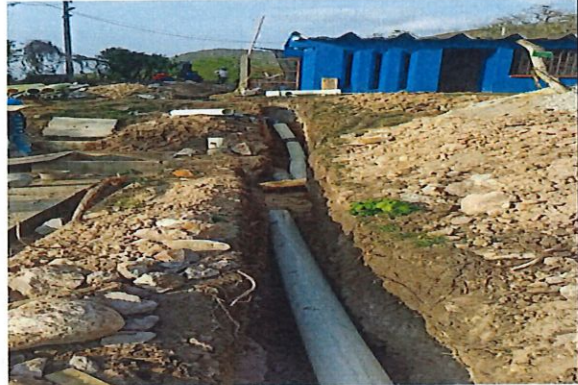
Instalación de tubería a caja de entrada del tanque de almacenamiento y a tanque antiguo
