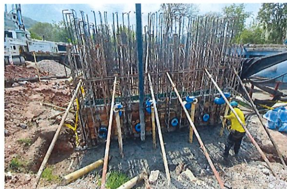
Vaciado de concreto Fundición de muros bajos de Ptap
