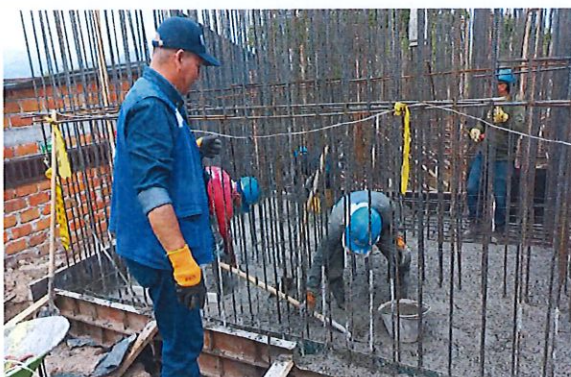
Supervisión de Interventoria Fundición 29 febrero
