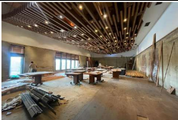
Cerramiento en lona en el Sotano del edificio de la Bolsa
