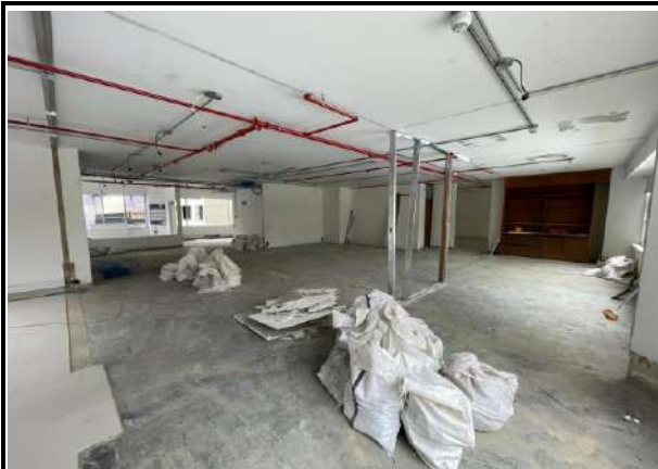
Recolección de los escombros en el Piso 7 del edificio de la Bolsa
