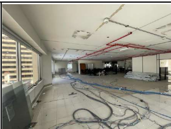
Desmonte de cableado eléctrico y UTP en el Piso 7 del edificio de la Bolsa
