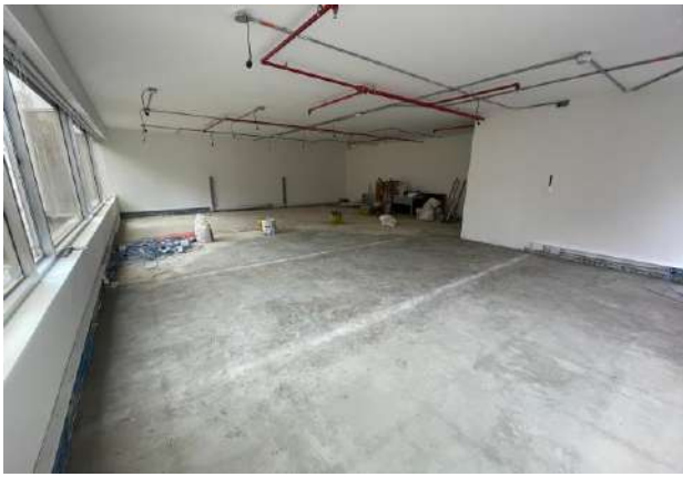
Nivelación del piso en el Piso 5 del edificio de la Bolsa
