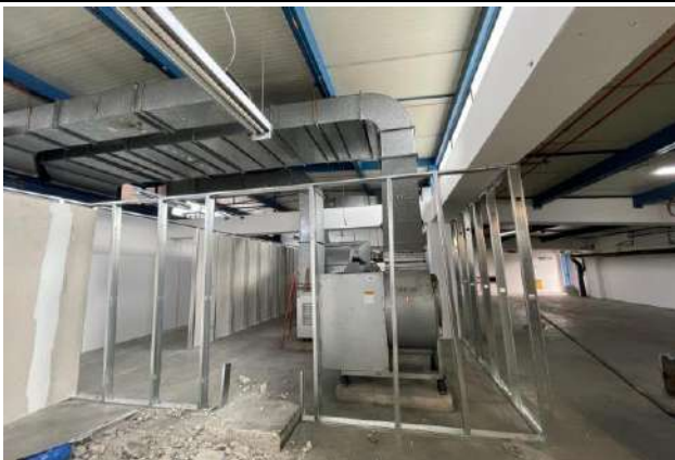
Instalación de la estructura metálica para muros de Superboard en el piso 4 del edificio Almacén Calle 18
