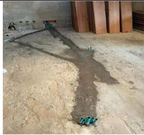
Fundida de las regatas para la tubería de red eléctrica en la sala plena del consejo de estado.
