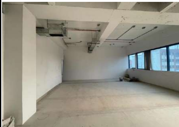
Nivelación de piso con mortero en el piso 3 del edificio Almacén Calle 18
