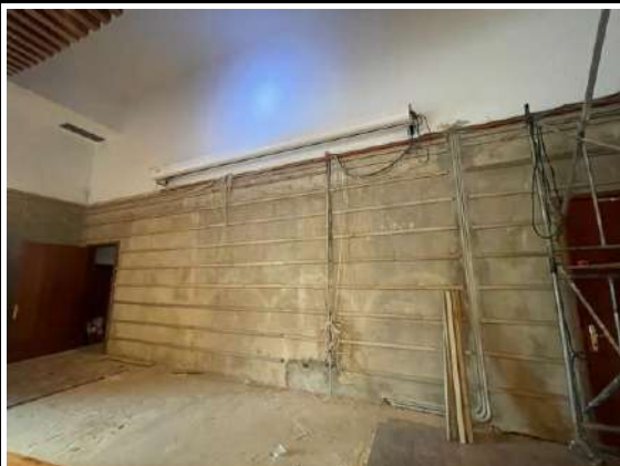
Restauración de la carpintería en madera en la sala plena del consejo de estado.
