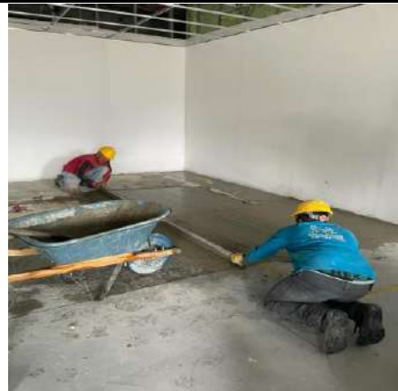
Instalación de red eléctrica para lámparas en el piso 3 del edificio Almacén Calle 18
