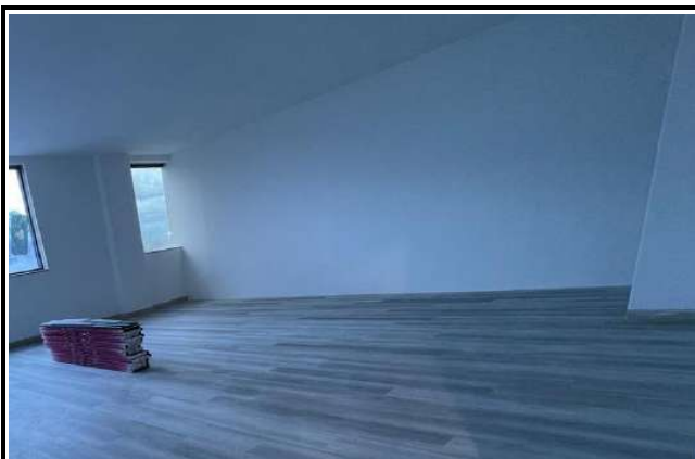
Instalación de guardaescobas en el piso 3 del edificio Almacén Calle 18
