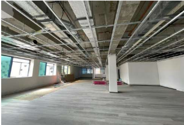
Instalación de cable eléctrico y cable UTP en el piso 3 del edificio Almacén Calle 18
