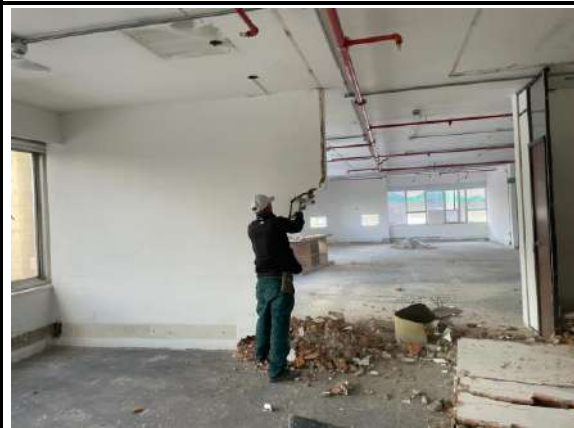
Desmonte de cableado electrico y UTP en el Piso 7 del edificio de la Bolsa
