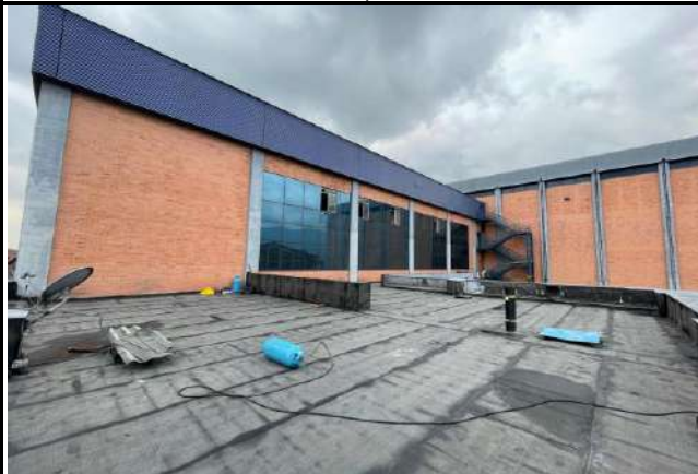
Instalación del manto de impermeabilización en la terraza exterior en el piso 2 del edificio Almacén Calle 18
