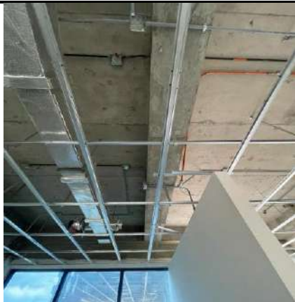
Instalación de tubería electrica en el piso 3 del edificio Almacén Calle 18
