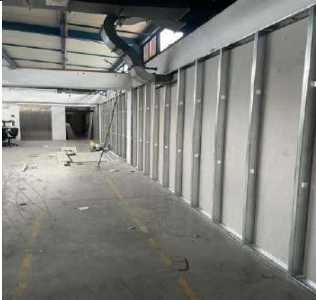
Instalación de la estructura metálica para muros de Superboard en el piso 4 del edificio Almacén Calle 18
