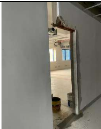
Desmonte de muro en el piso 3 del edificio Almacén Calle 18
