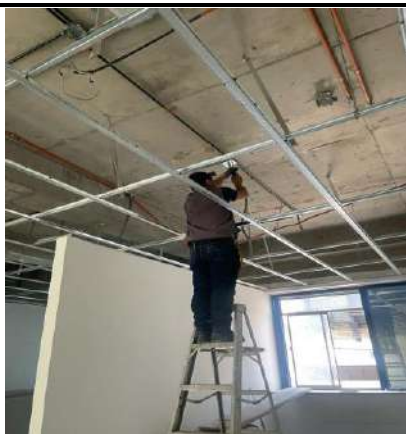
Desmontan los cables UTP y cables electricos en el piso 3 del edificio Almacén Calle 18
