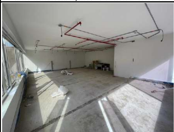
Demolición de enchape de piso en el Piso 5 del edificio de la Bolsa
