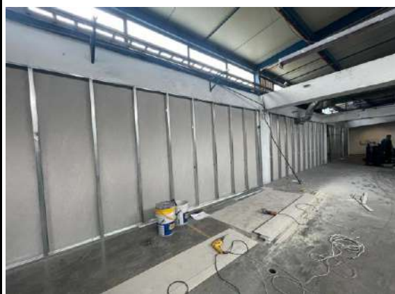
Instalación de la estructura metálica para muros de Superboard en el piso 4 del edificio Almacén Calle 18
