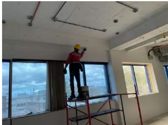
Demolición del piso en el piso 2 del edificio Almacén Calle 18
