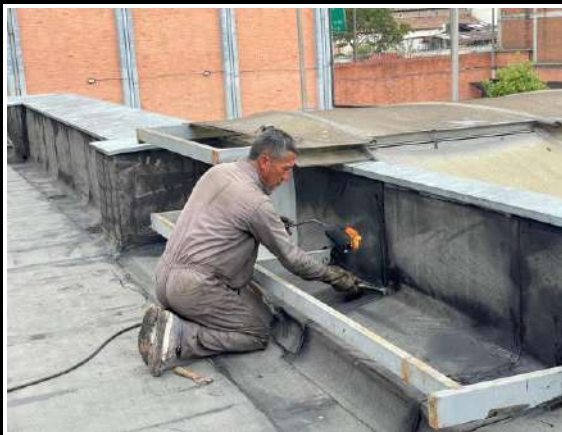
Instalación de imprimante asfáltico en la terraza exterior en el piso 2 del edificio Almacén Calle 18
