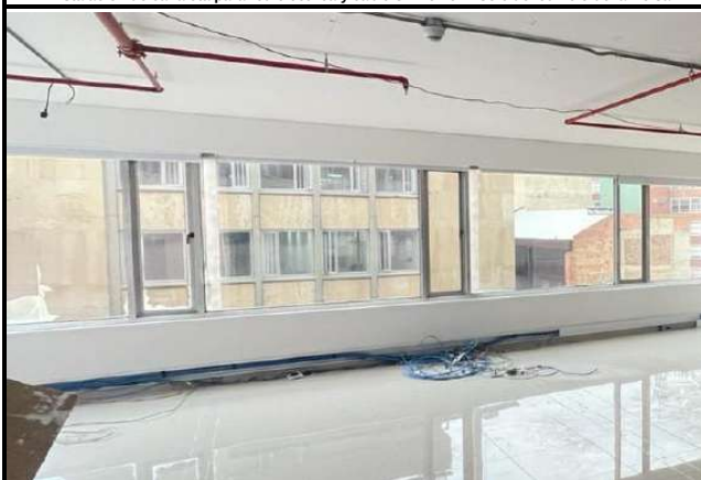
Instalación de canaleta para red eléctrica y cable UTP en el Piso 5 del edificio de la Bolsa
