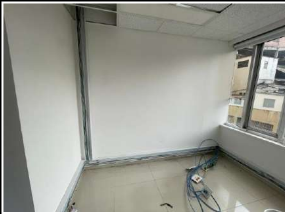
Instalación de cableado electrico y cable UTP en el Piso 6 del edificio de la Bolsa
