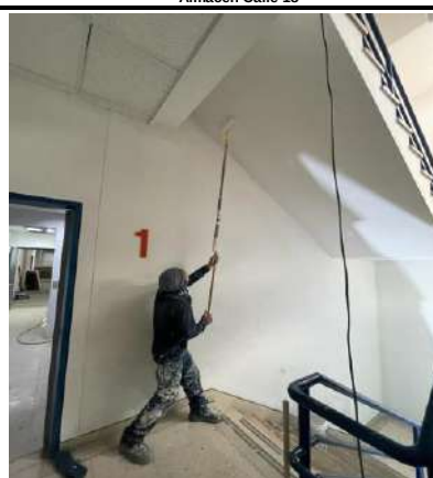
Aplicación de pintura en los muros en el pasillo de escalera entre los pisos 1 al 4 del edificio Almacén Calle 18
