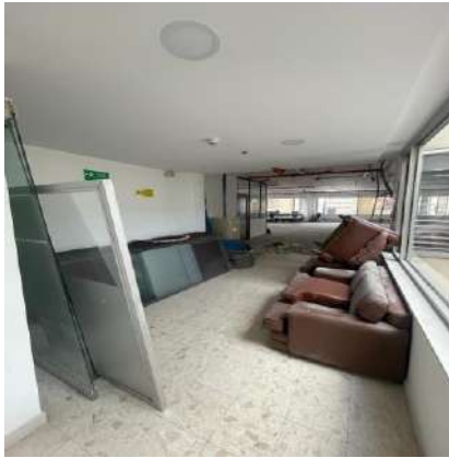
Desmonte de puertas de aluminio en el Piso 7 del edificio de la Bolsa
