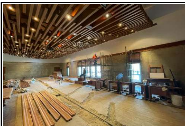
Desmonte de cornisa en la sala plena del consejo de estado.
