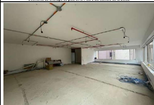
Desmonte de enchape de piso en el Piso 6 del edificio de la Bolsa
