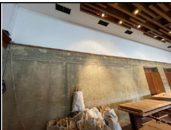
Desmonte de listones de fijaciones en la sala plena del consejo de estado.
