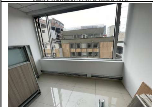
Instalación de canaleta para red eléctrica y cable UTP en el Piso 6 del edificio de la Bolsa
