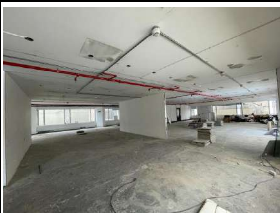
Desmonte de enchape de piso en el Piso 7 del edificio de la Bolsa
