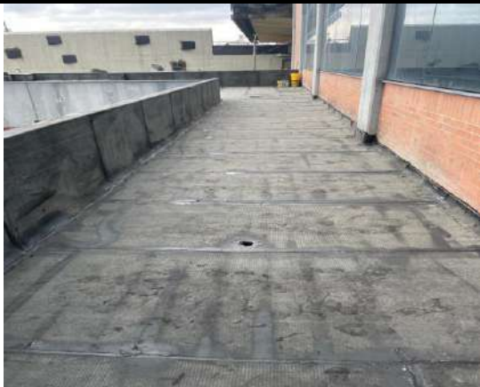
Instalación de los soportes y anclajes de la estructura para el cerramiento en malla eslabonada en el piso 1 del edificio Almacén Calle 18
