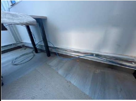
Aplicación lijado y pintura en los muros de super boards en el piso 3 del edificio Almacén Calle 18
