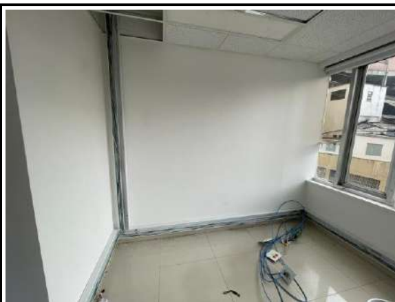
Instalación de cableado eléctrico y cable UTP en el Piso 6 del edificio de la Bolsa
