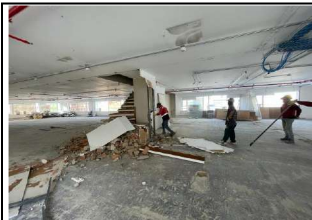
Demolición de la escalera en el Piso 7 del edificio de la Bolsa
