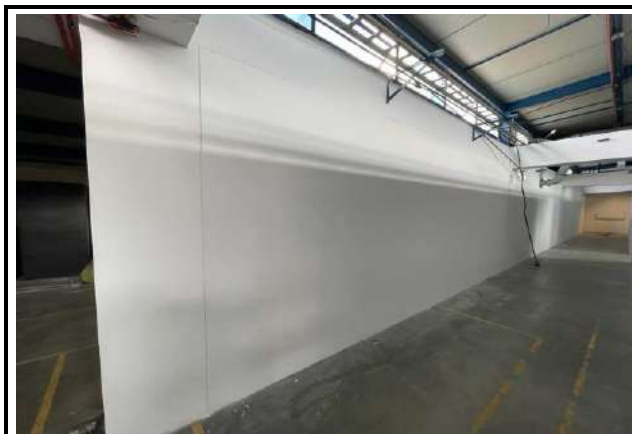
Aplicación lijado y pintura en los muros de super boards y mampostería en el piso 4 del edificio Almacén Calle 18
