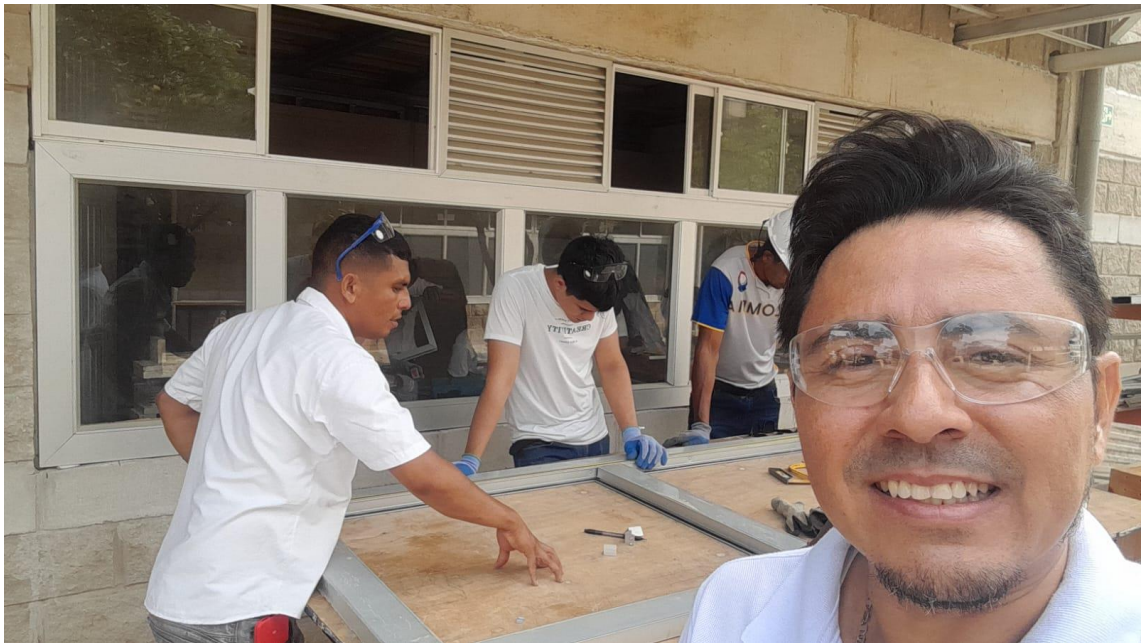
Proceso de armado de perfiles tubulares e instalación de machimbre al interior de las hojas
