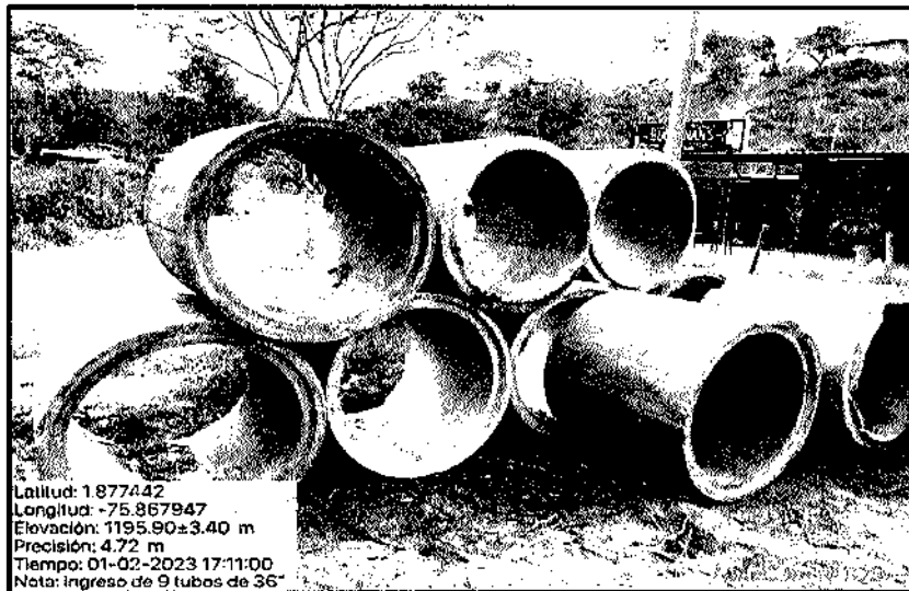
Acopio de Tubería de concreto reforzado de 36"
