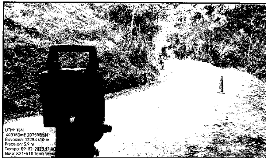
Localización y replanteo de la vía
