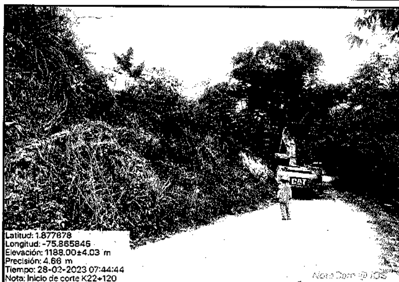
Excavación y/o ampliación de la vía
