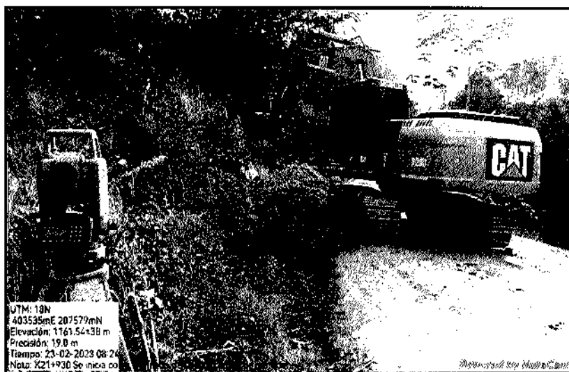
Excavación y/o ampliación de la vía
