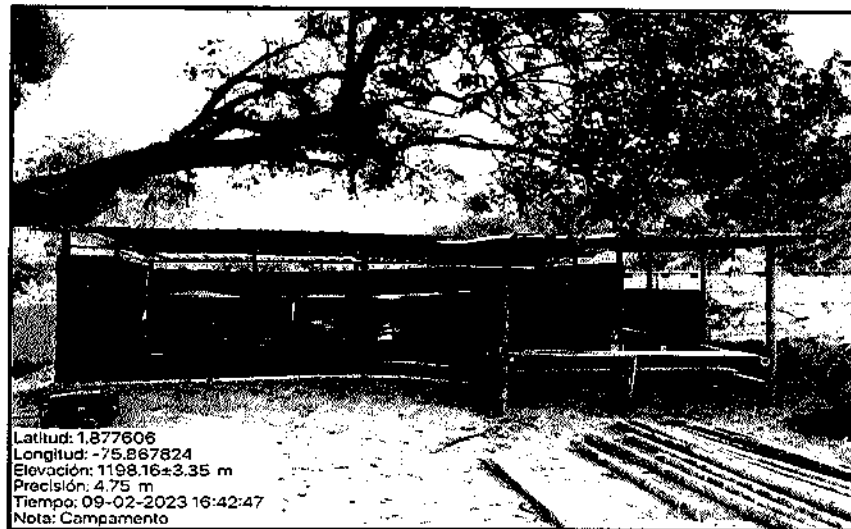
Construcción de campamento en obra K21+820
