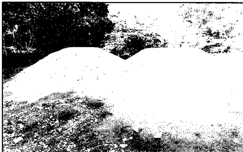
Acopio de Arena en Campamento
