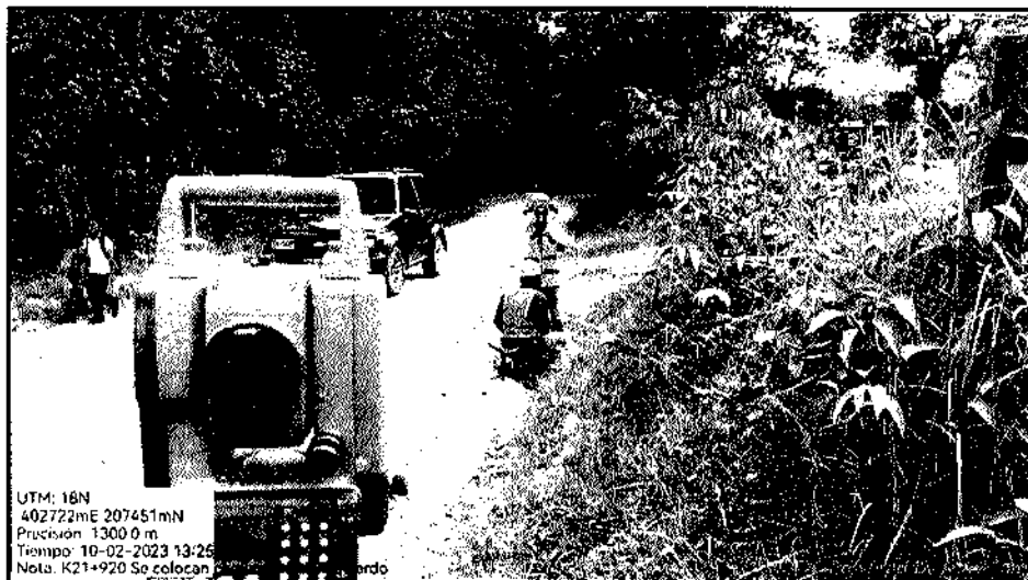
Chaflanado de la vía
