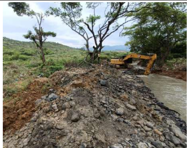
Adecuación con Maquinaria
