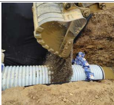
Instalacion de Material Granular
