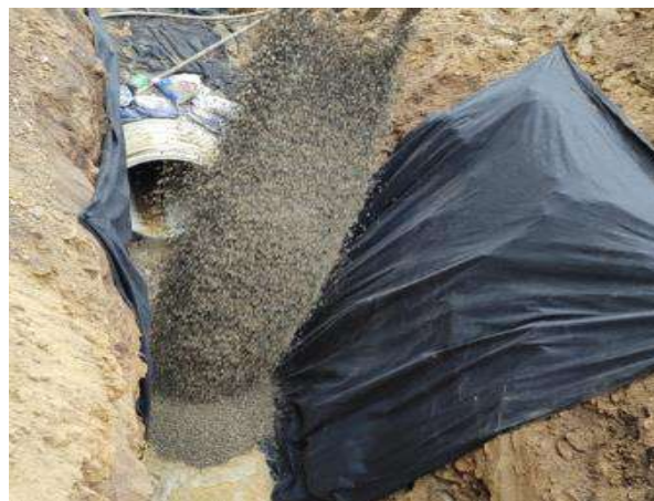
Relleno con triturado 3/4"
