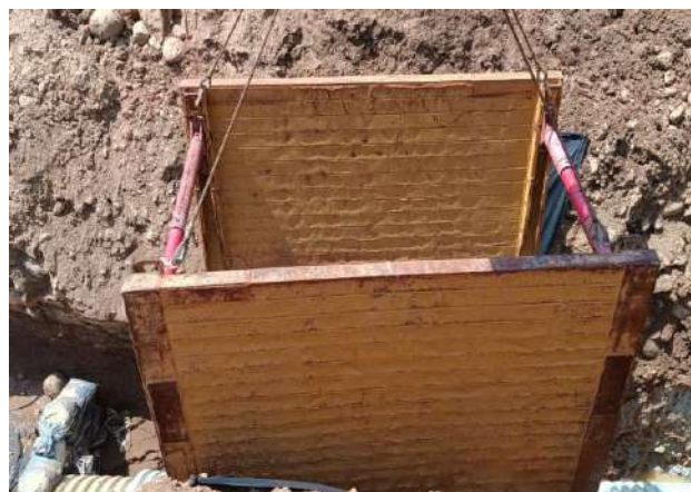
Instalacion de contencion metalica
