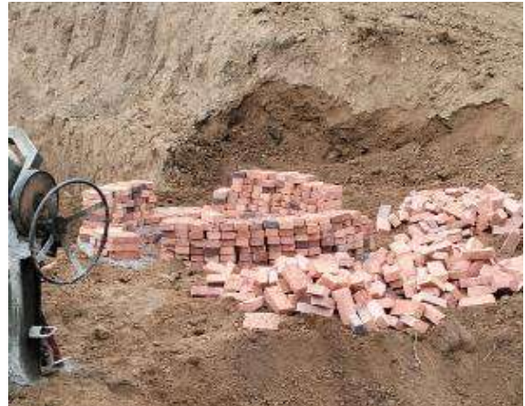
construccion de estructura
