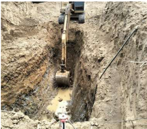
Excavacion >4m
