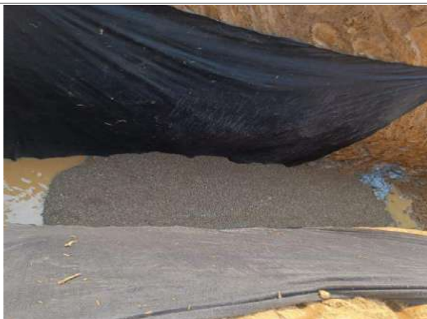
Relleno con triturado 3/4"
