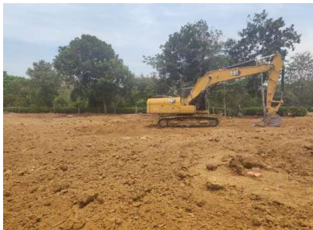
Adecuación con Maquinaria
