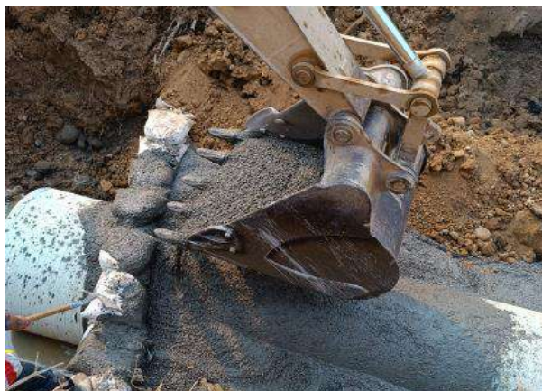
Instalacion de tubería sanitaria
