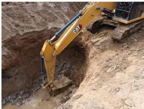
Excavacion con Maquinaria
