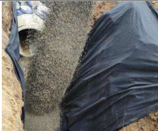
Instalacion de Material Granular
