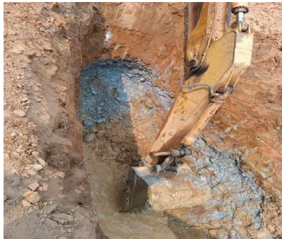
Excavacion con retroexcavadora 320D
