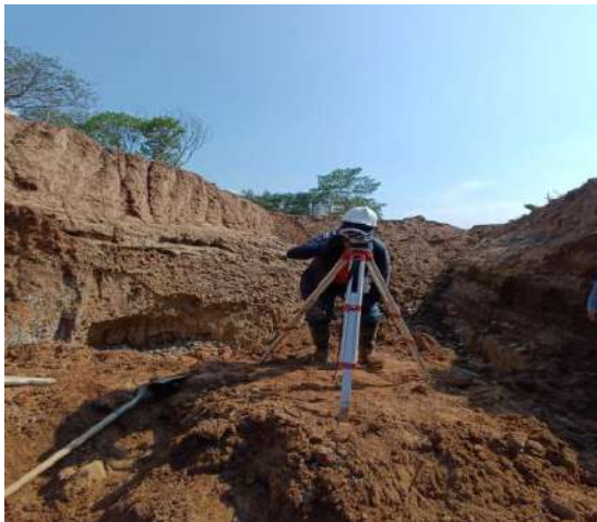
Nivelación y replanteo
