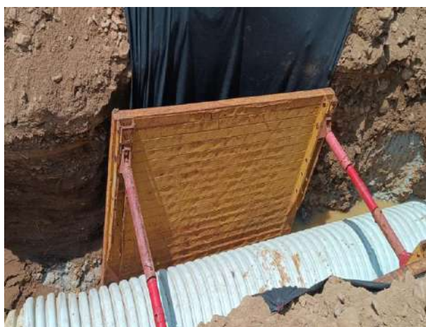
Instalacion de contencion metalica
