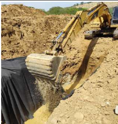
Instalacion de Material Granular
