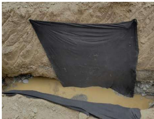
Instalacion de geotextil
