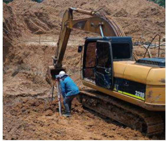
Nivelación y replanteo
