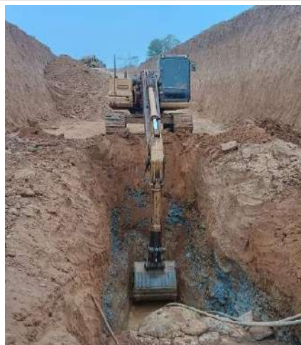
Excavacion con Maquinaria
