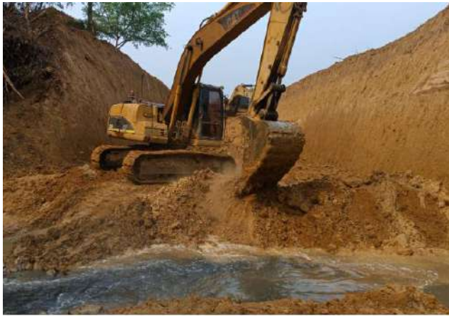
Adecuación con Maquinaria
