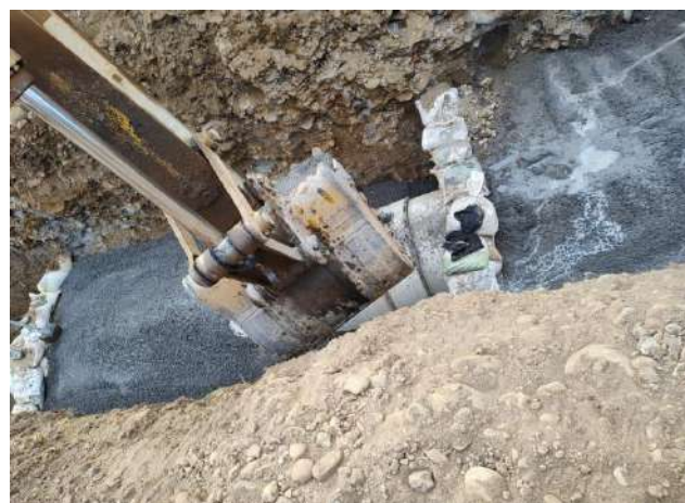
Anclaje en concreto ciclopeo
