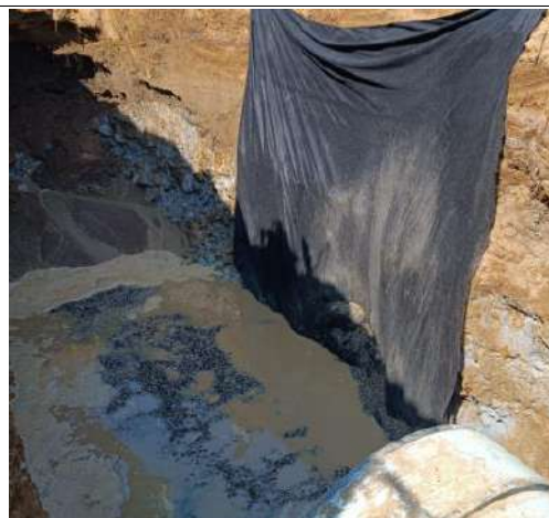
Instalacion de geotextil
