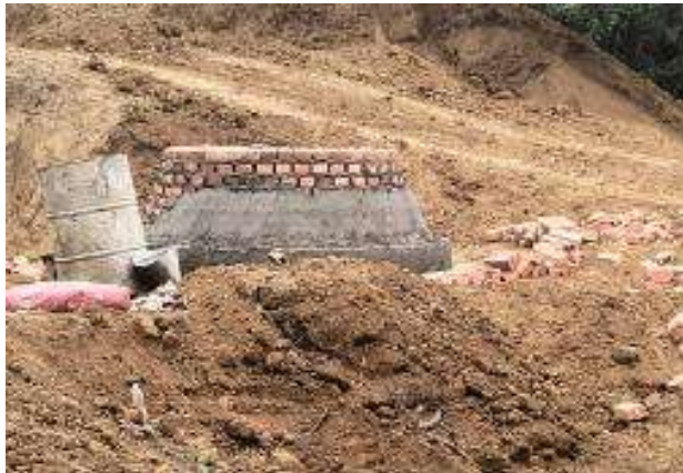
levantamiento de pozo
