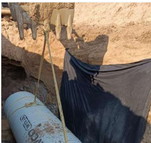
Instalacion de tubería sanitaria
