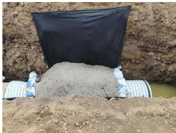
Relleno con triturado 3/4"
