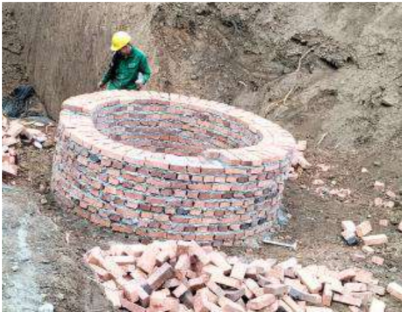
construccion de estructura
