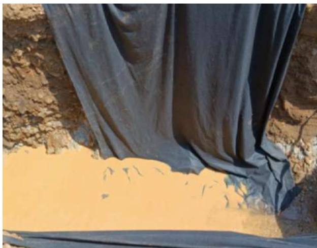
Instalacion de geotextil
