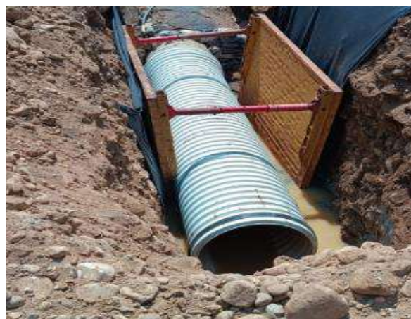
Instalacion de contencion metalica
