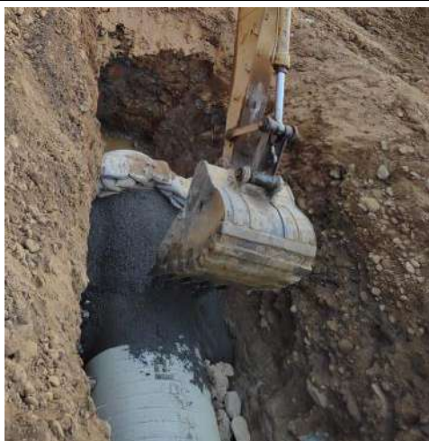
Anclaje en concreto ciclopeo
