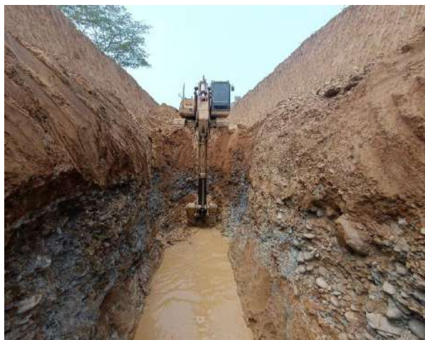
Excavacion con Maquinaria
