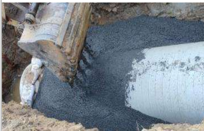
Anclaje en concreto ciclopeo
