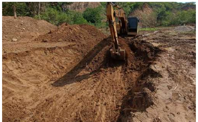
excavacion a <2 m
