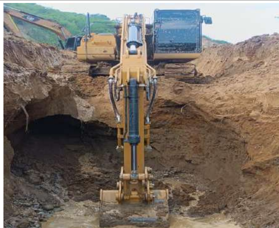
Excavacion con Maquinaria
