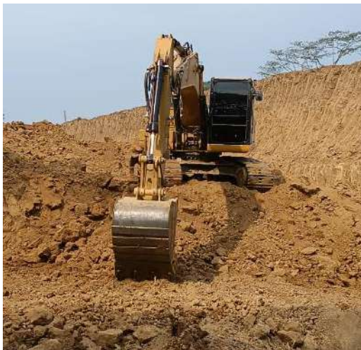
excavacion a <2 m
