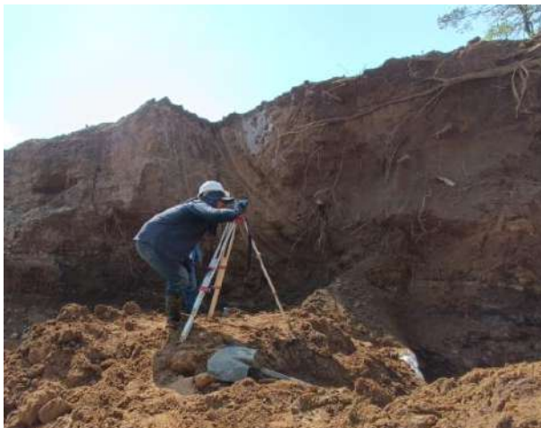
chequeo nivelacion de tubería
