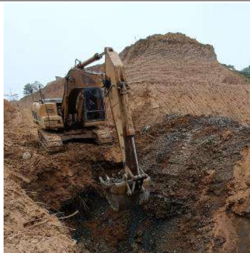
Excavacion con Maquinaria
