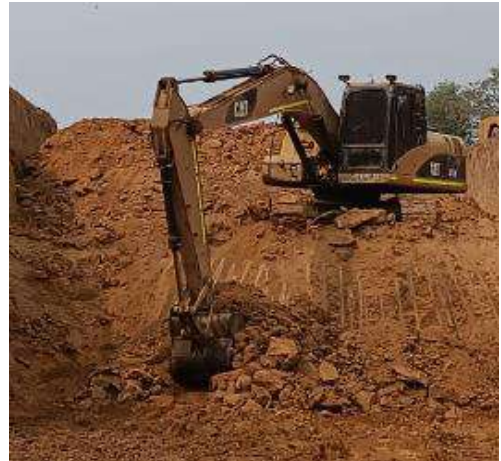
excavacion materiales arcillosos
