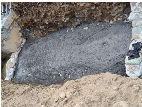
Anclaje en concreto ciclopeo
