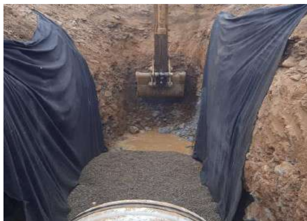
Relleno con triturado 3/4"
