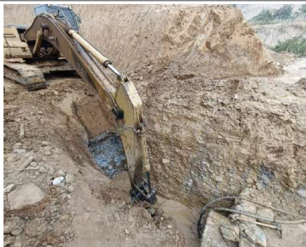
Excavacion con Maquinaria
