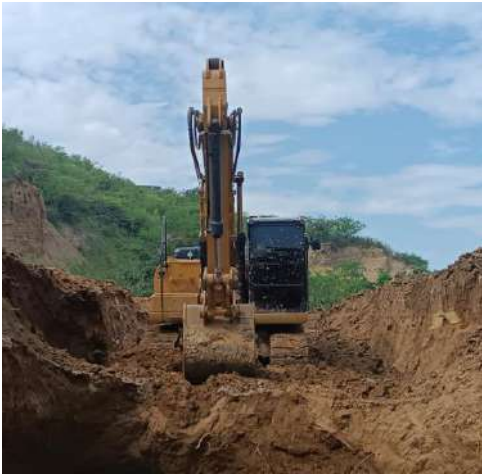
excavacion materiales arcillosos
