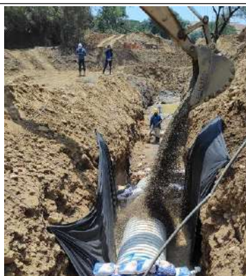
Instalacion de Material Granular
