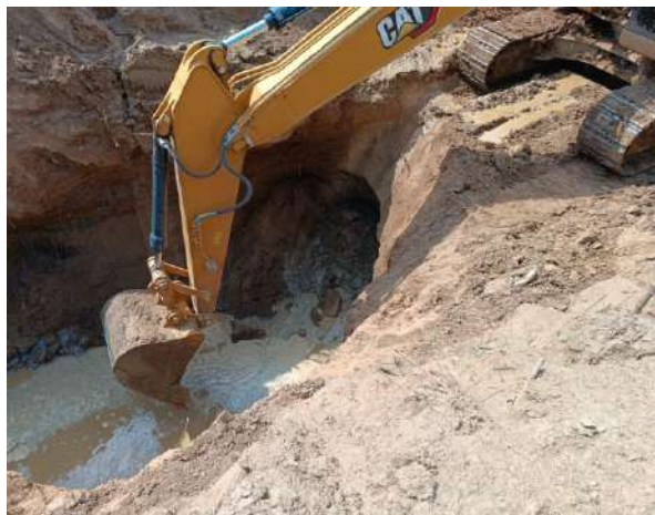
Excavacion con retroexcavadora 320D
