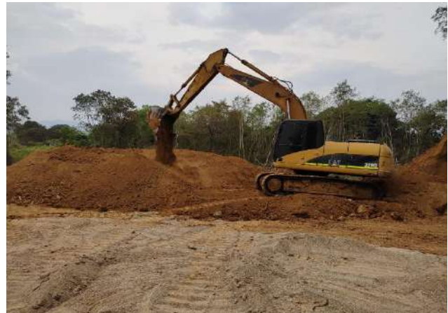
Adecuación con Maquinaria
