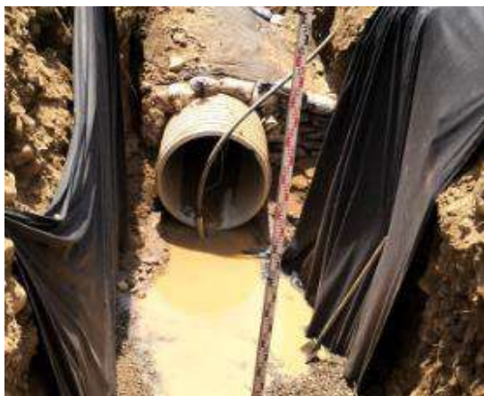
Instalacion de geotextil
