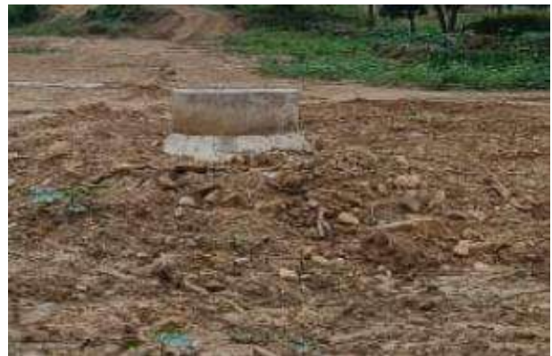
levantamiento de pozo
