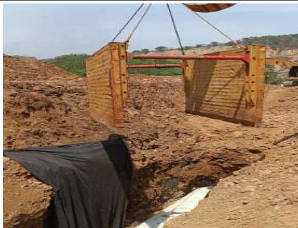
Instalacion de contencion metalica
