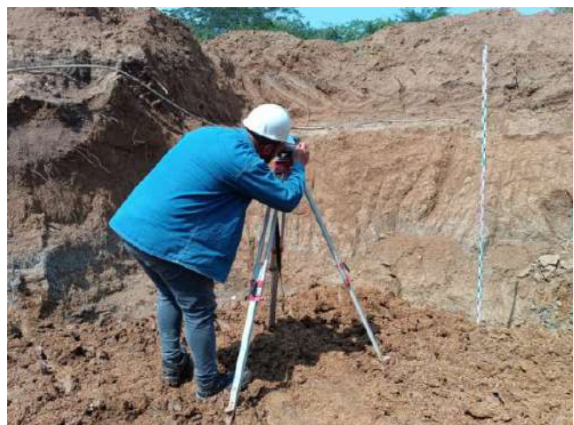
chequeo nivelacion de tubería
