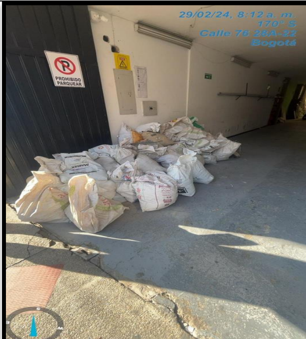
RCD en lonas almacenado en Bodega AMYCIA
