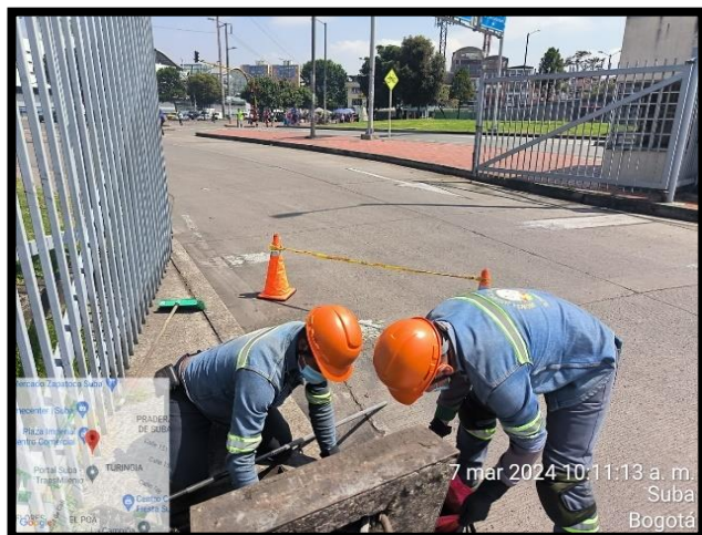
Señalización con cinta de peligro y conos reflectivos en Portal Suba
