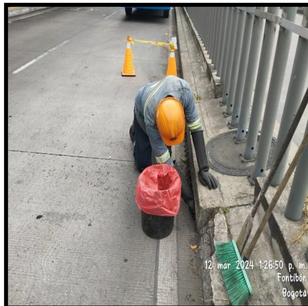
Limpieza de Cajas en Portal Dorado
