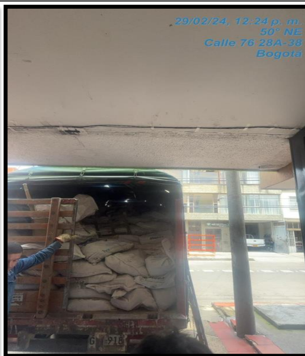
Cargue de RCD en vehículo GZZ918 – PIN SDA 19563
