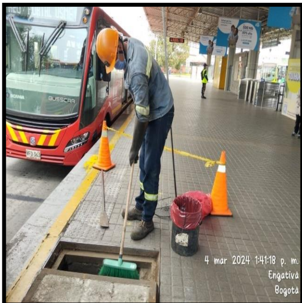
Limpieza de Cajas en Portal 80
