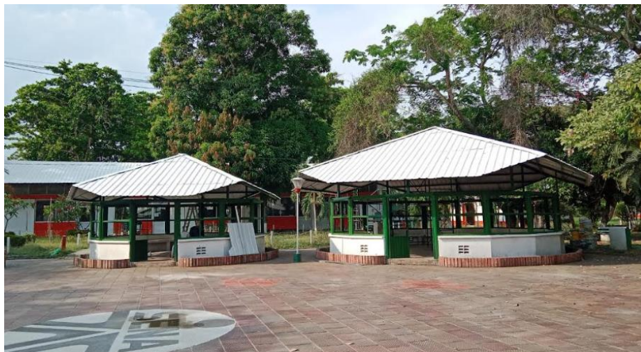
Imagen 1. Teja UPVC suministrada e Instalada en los (2) KIOSKOS
