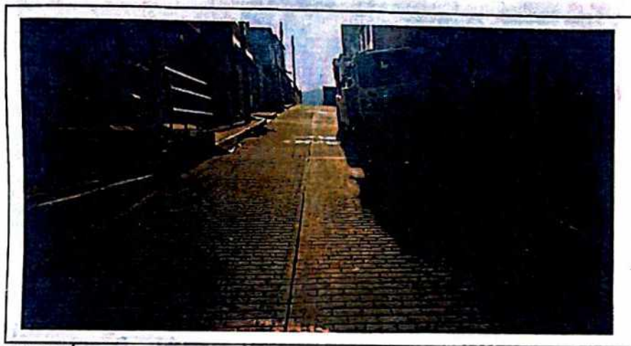
Foto No. 1 Descripción: Vía en concreto estampado
