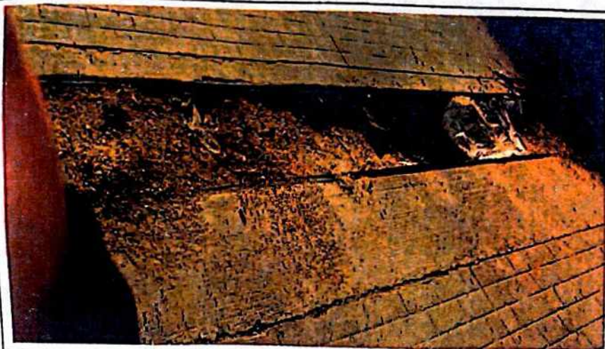
Foto No. 5 Descripción Semicubo con relleno de material granular
