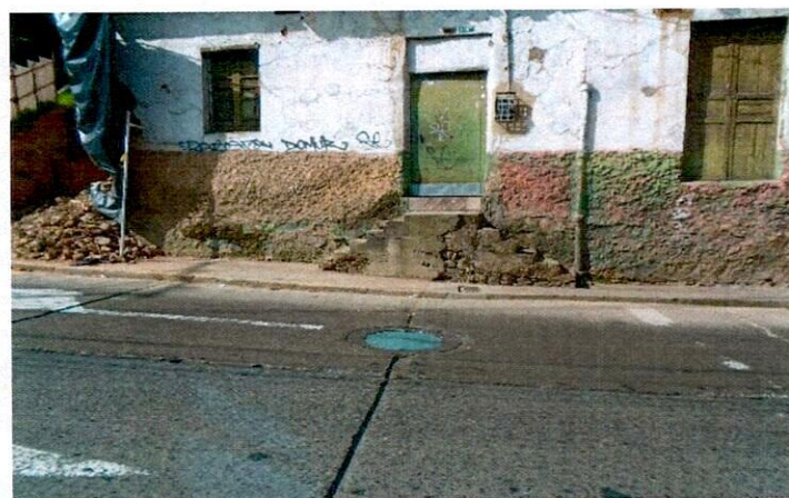
ILUSTRACIÓN 1 Detalle de juntas – Falla 1.
