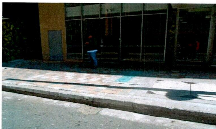
ILUSTRACIÓN 1 Detalle de corte – Falla 1.
