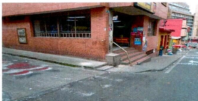
Ilustración 2 Detalle de Desprendimiento
