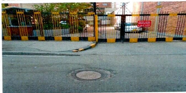
Ilustración 1 Detalle Pozo Hundido
