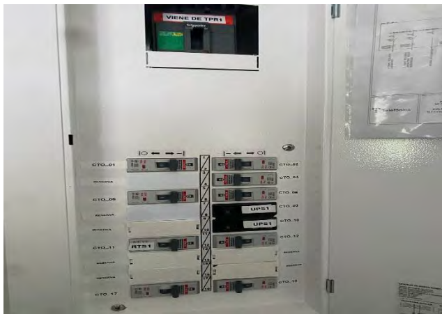
CUADRO DE CARGAS TABLERO TRIFASICO DE 18 CIRCUITOS REGULADO ZONA DE RACK UBICADO EN CASONA 2
