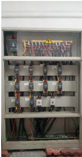
CUADRO DE CARGAS TABLERO TRIFASICO DE 12 CIRCUITOS ZONA DE CUARTO ELECTRICO POSTERIOR A CONECTIVIDAD PARQUE DEL CAFÉ
