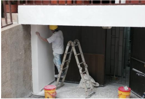
ACTIVIDADES DE PINTURA INTERIOR
