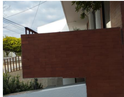
Lavado e hidrofugo fachada lateral y cambio de piezas rotas
