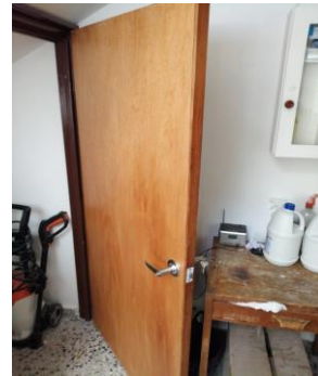
Suministro e Instalacion de puerta entamborada deposito
