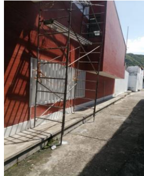
PINTURA FACHADA CON PINTURA KORAZA
