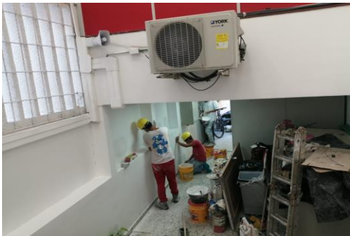
ACTIVIDADES DE PINTURA INTERIOR
