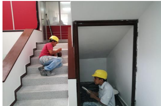
ACTIVIDADES DE PINTURA INTERIOR
