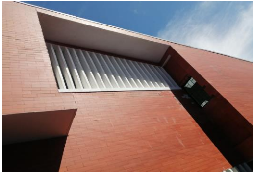
PINTURA FACHADA CON PINTURA KORAZA
