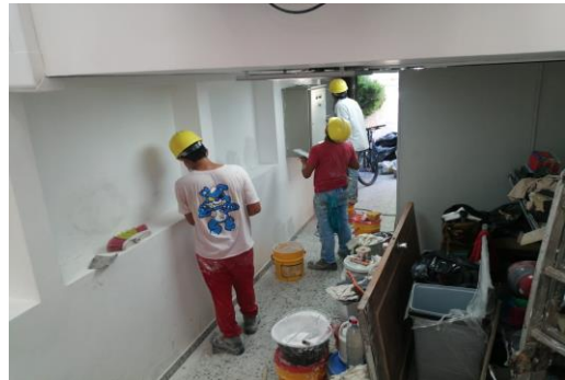
ACTIVIDADES DE PINTURA INTERIOR
