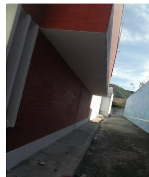
PINTURA FACHADA CON PINTURA KORAZA
