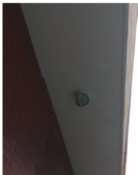
INSTALACION LAMPARAS TIPO TORTUGA
