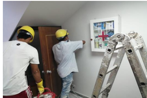
ACTIVIDADES DE PINTURA INTERIOR
