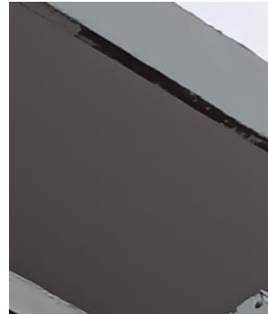
PINTURA VINILO TIPO I
