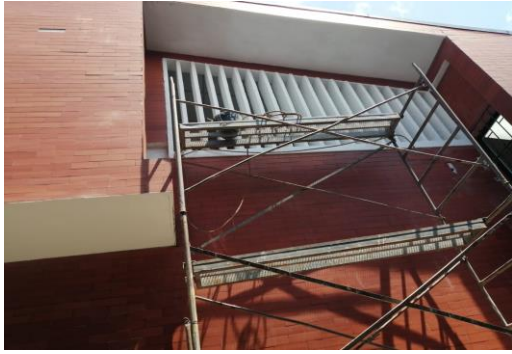
PINTURA FACHADA CON PINTURA KORAZA
