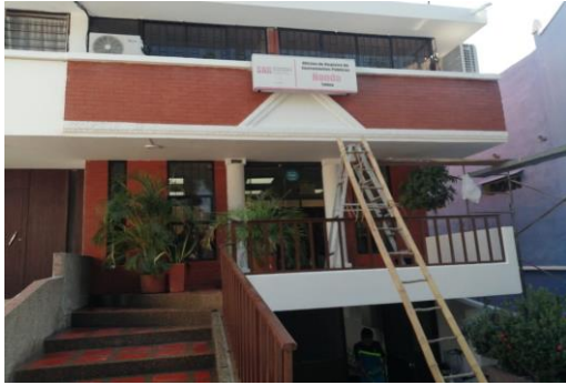
Pintura fachada principal, limpieza e hidrofugo de la fachada
