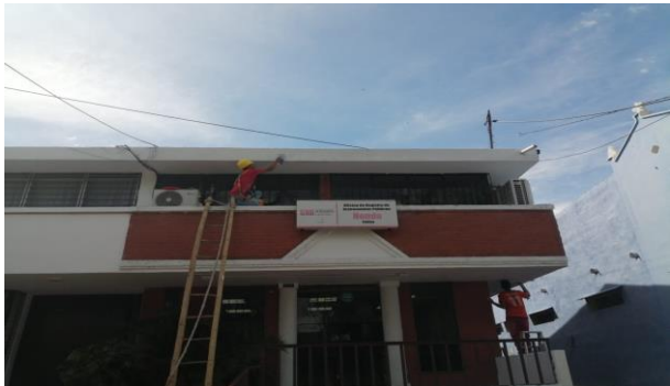
PINTURA FACHADA CON PINTURA KORAZA
