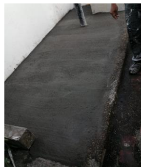
Fundida de placa en concreto interior
