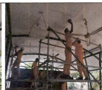
ejercicios de mantenimiento de aplicación de vinilo en cielo razo
