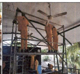
ejercicios de mantenimiento de aplicación de estuco plástico en cielo razo
