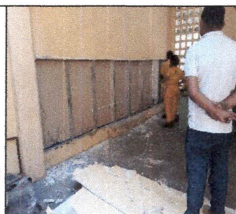
realización de mantenimiento de desmonte de drywall en mal estado en taller de soldadura
