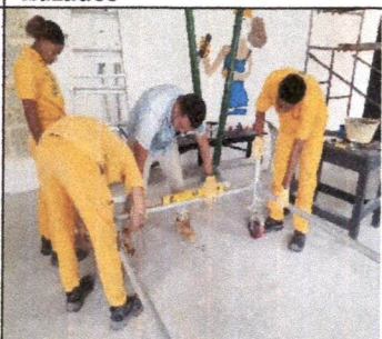
ejercicios de nivelación de base para andamios multifuncionales
