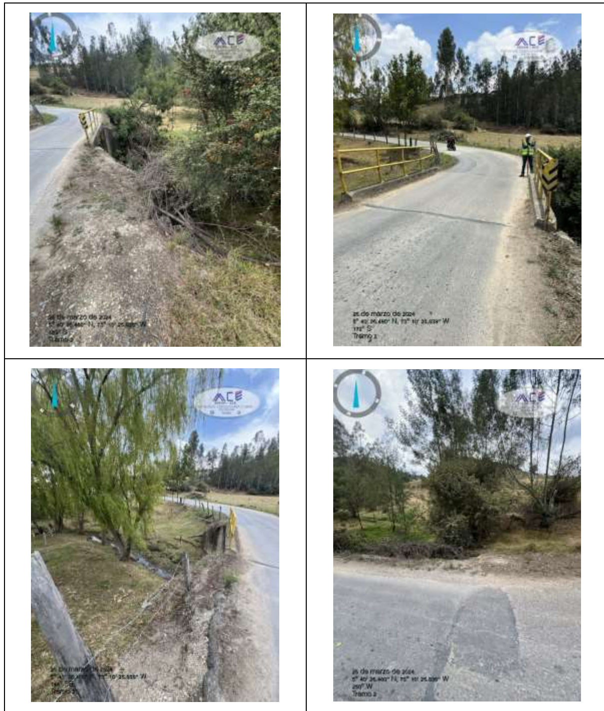
Fotografías Tomadas de la Visita Técnica Realizada el 06 de Marzo de 2024.
