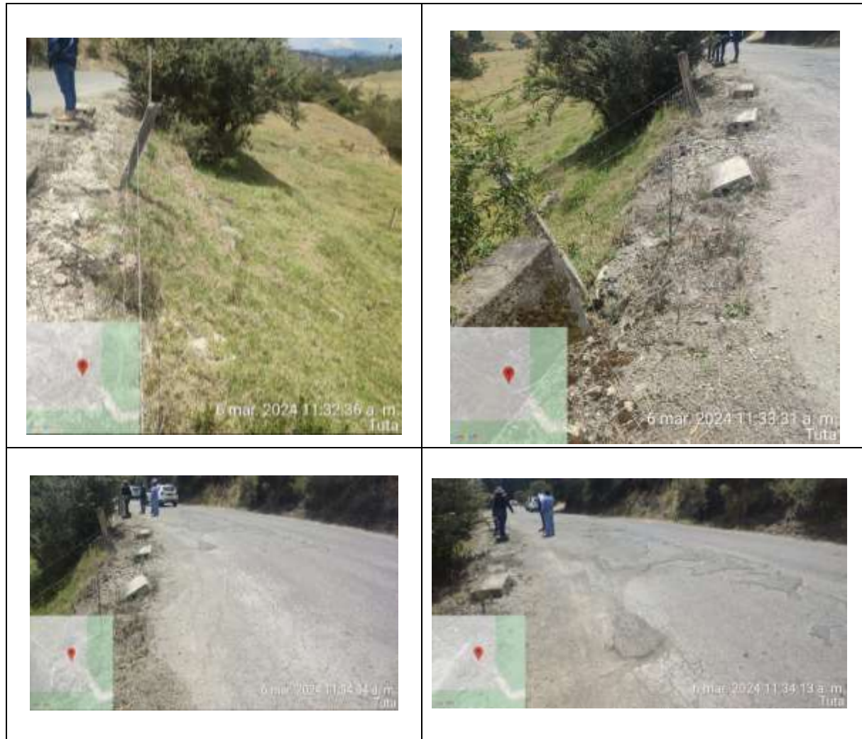
Fotografías Tomadas de la Visita Técnica Realizada el 06 de marzo de 2024.
