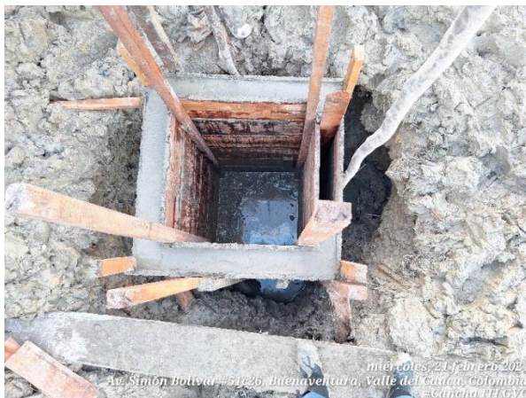
Carpintería en madera para formaletas y posterior encofrado de cajas de inspección. Fundición de cajas y cámara de inspección.
