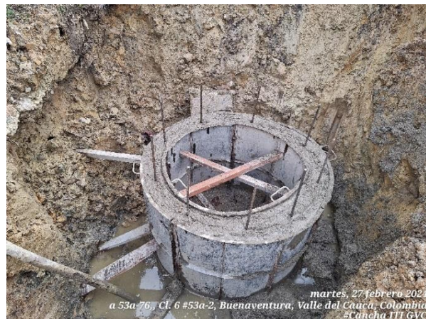
Carpintería en madera para formaletas y posterior encofrado de cajas de inspección. Fundición de cajas y cámara de inspección.
