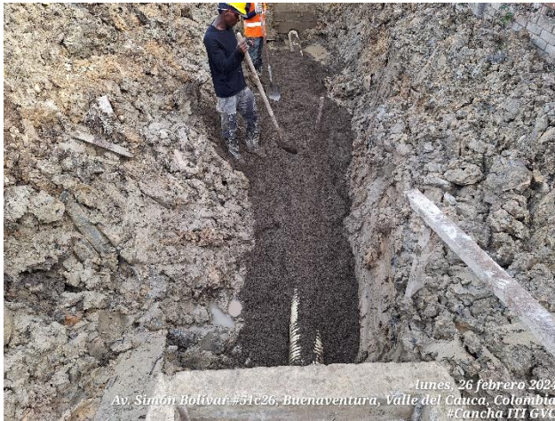
Relleno con material de río.
