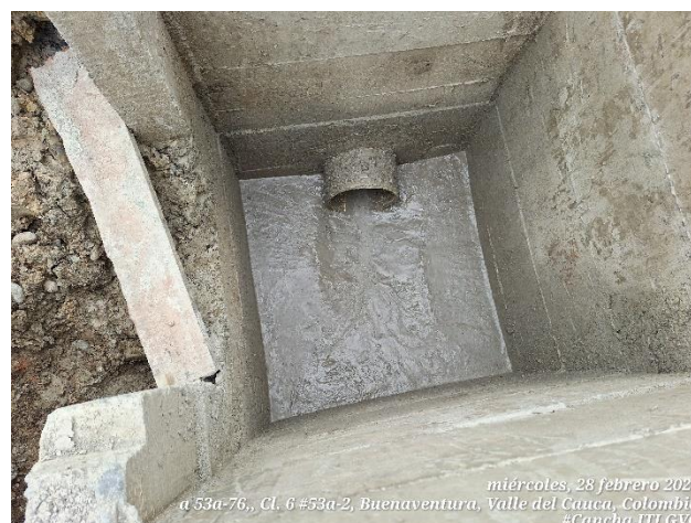
Construcción de batea en concreto en cajas y cámara de inspección
