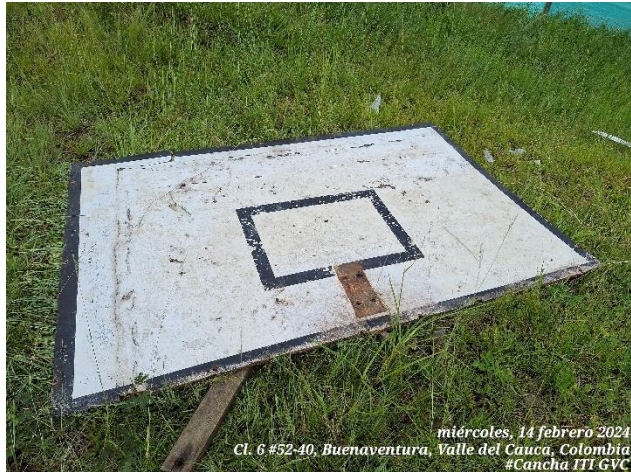
Desmonte de poste de juegos existente
