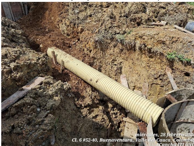
Instalación de tuberías sanitarias de 10" y 12"
