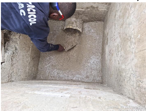
Construcción de batea en concreto en cajas y cámara de inspección
