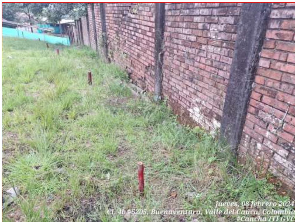
Implantación de localización y replanteo según diseños.
