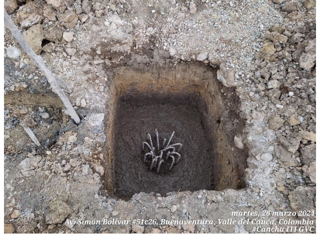
Solado de cimentación para zapatas y vigas de cimentación de la estructura de cubierta.
