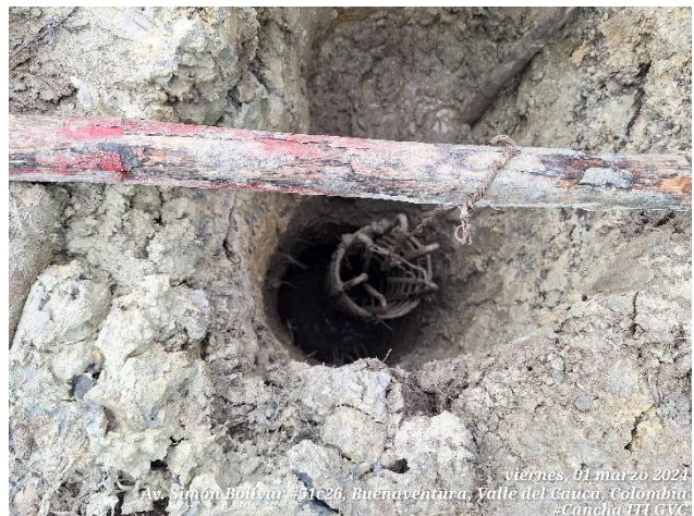
Fundición de pilotes en concreto de la malla contra impacto.
