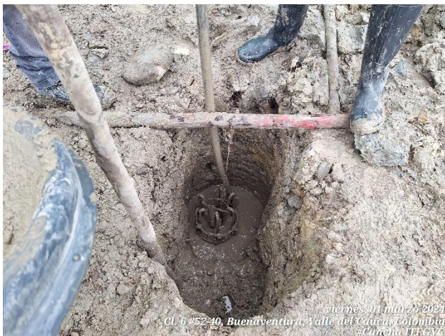
Fundición de pilotes en concreto de la malla contra impacto.
