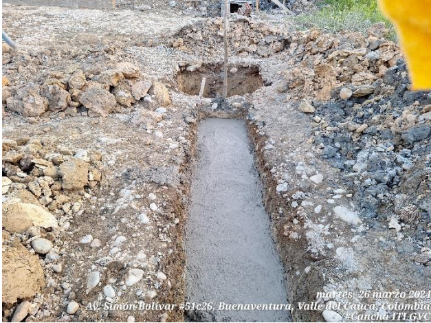
Solado de cimentación para zapatas y vigas de cimentación de la estructura de cubierta.
