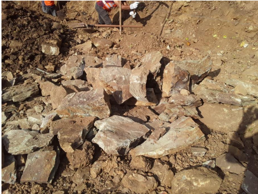
Excavación Manual En Roca
