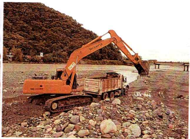
Excavadora Orugada Shantui 220LC #1 realizando actividades de canalización y conformación de Jarillón
