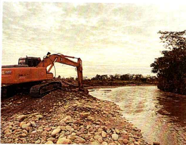
Excavadora Hitachi 200 #4 realizando actividades de conformación de jarillon
