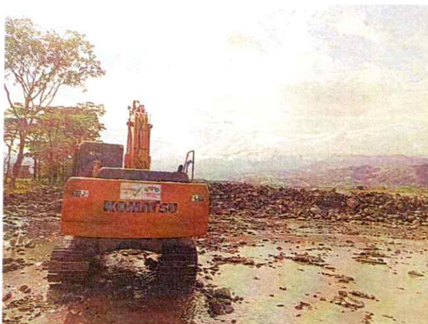
Excavadora Komatsu PC 200LC #4 realizando actividades de extracción de material y conformación de jarillón
