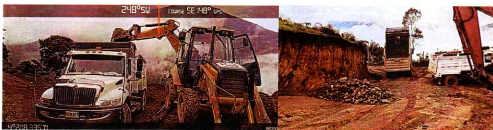
Volqueta UZN327 Realizando actividades de cargue, transporte y descargue de material
