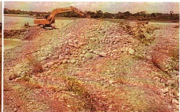
Excavadora Shantui 220 #5 realizando actividades de excavación y conformación de Jarillón
