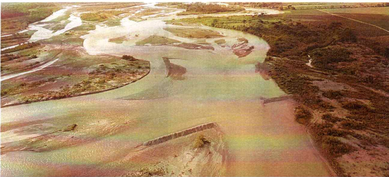
Posterior a la intervención, Fuente De Oro – Río Ariari, Vereda El Porvenir-Parte Baja
