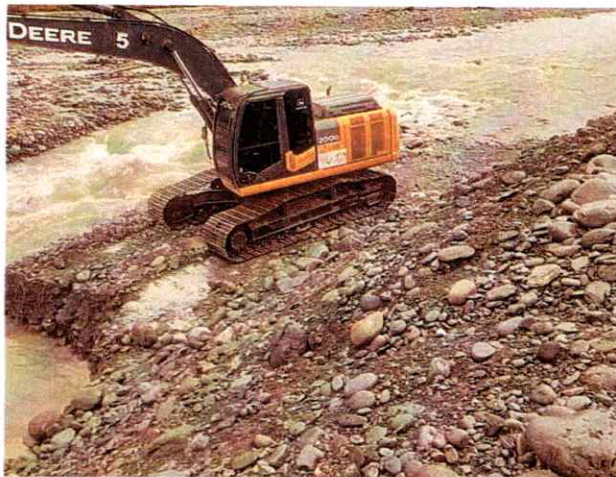
Excavadora Jhon Deere 200LC realizando actividades de canalización y conformación de jarillón
