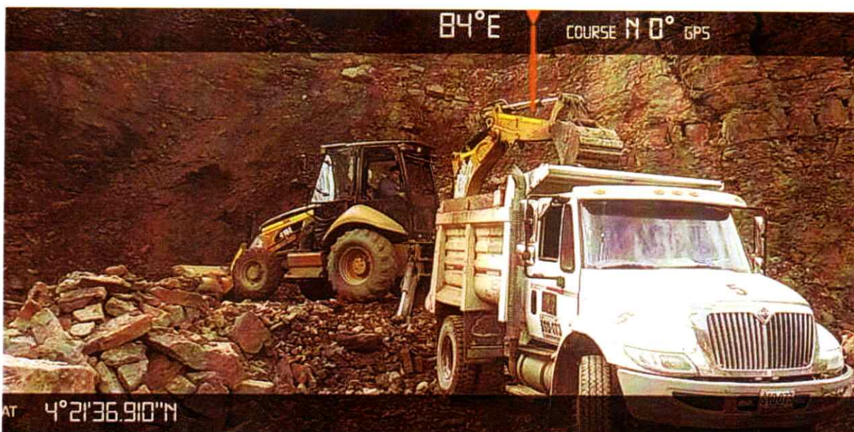
Volqueta STO 073 Realizando actividades de cargue, transporte y descargue de material
