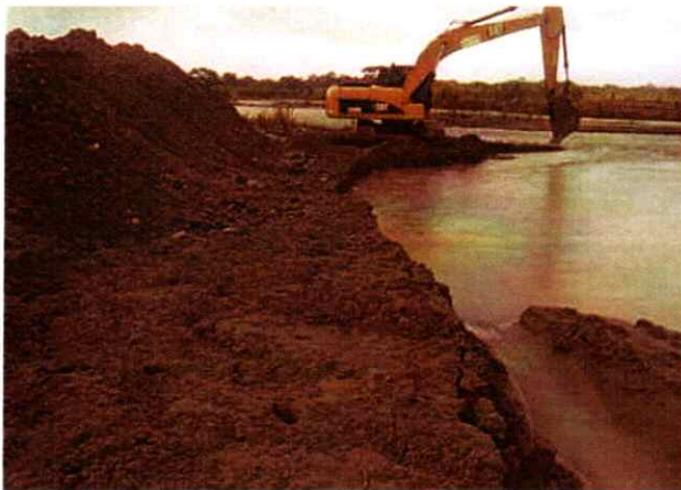
Excavadora Caterpillar 320D #7 realizando actividades de canalización
