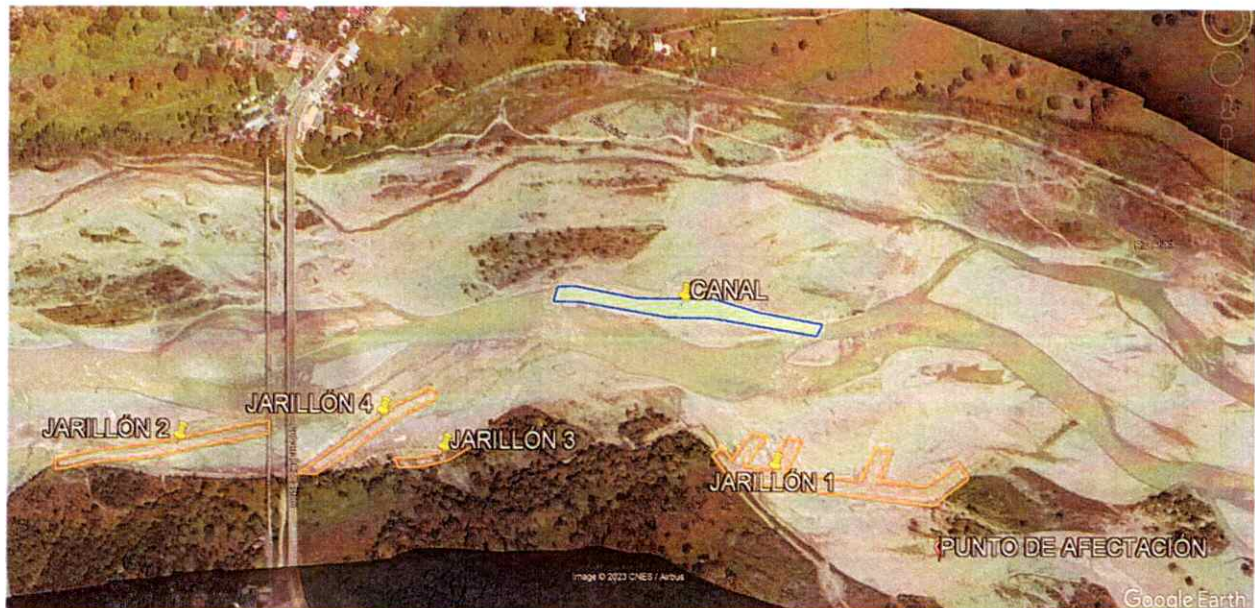
Intervención realizada, Rio Ariari - Margen Derecha Puente La Amistad
