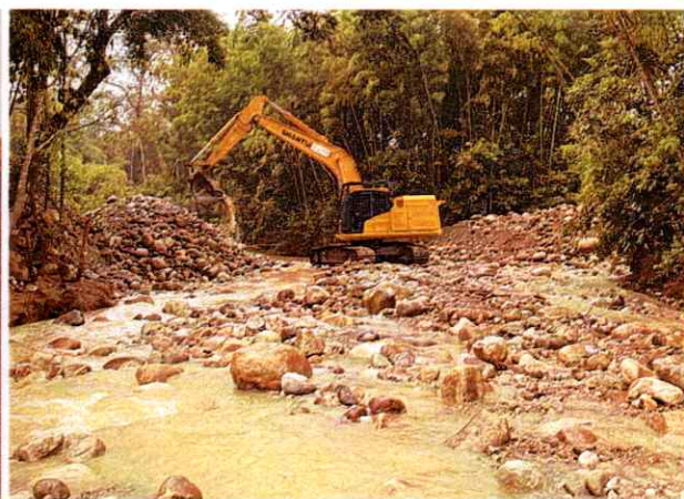
Excavadora Shantui 220 #3 realizando actividades de canalización y protección del aproche del puente
