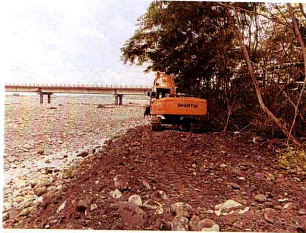
Excavadora Orugada Shantui 220LC #1 realizando actividades de canalización y conformación de Jarillón
