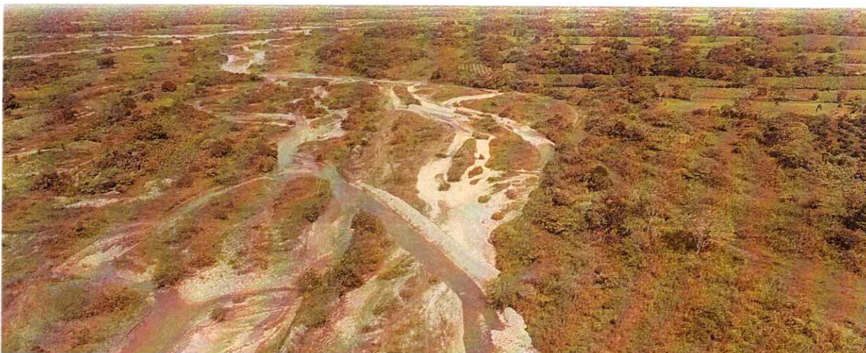
Intervención realizada, El Castillo – Vereda La Unión, Rio Guape – Jarillón #3 y Jarillón #4
