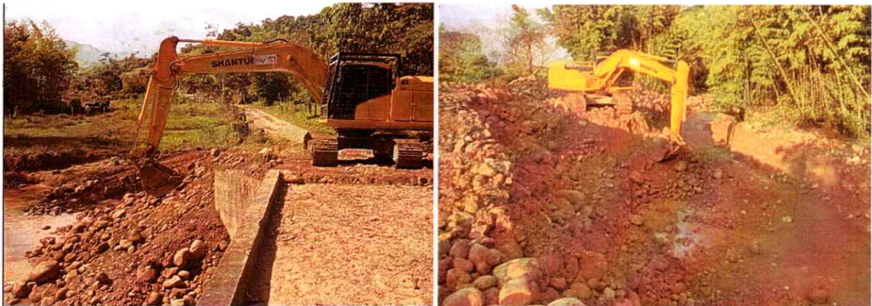
Excavadora Shantui 220 #3 realizando actividades de canalización y protección del aproche del puente
