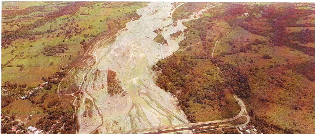
Posterior a la Intervención, Rio Ariari - Margen Derecha Puente La Amistad
