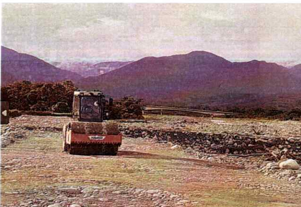
Vibrocompactador Hamm #3 realizando actividades de compactación de jarillón
