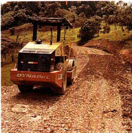
Vibro compactador dynapac #1 realizando labores de compactación a la vía
