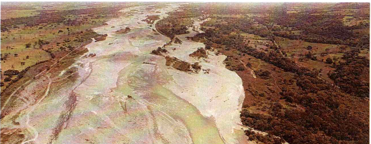
Antes de la Intervención, Rio Ariari - Margen Derecha Puente La Amistad
