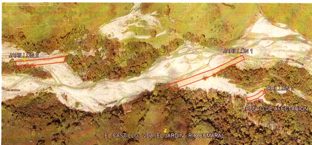
Intervención realizada, El Castillo – Medellín Del Ariari, Rio Cumaral
