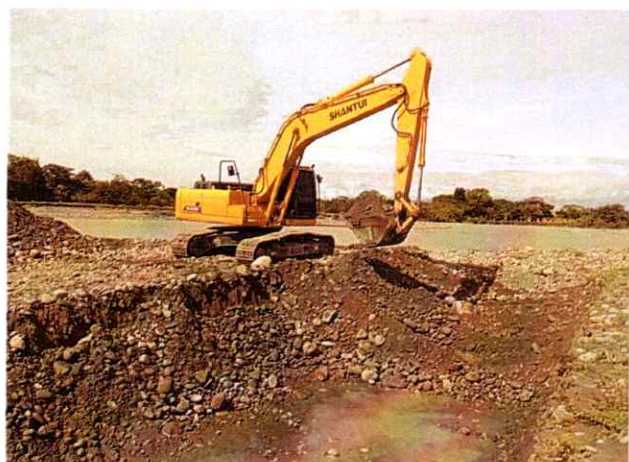
Excavadora Shantui 220LC #4 realizando actividades de canalización
