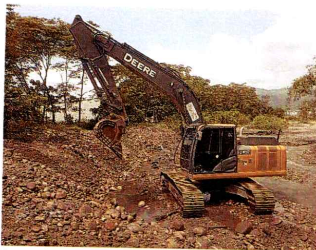
Excavadora Jhon Deere 210LC #2 realizando actividades de canalización
