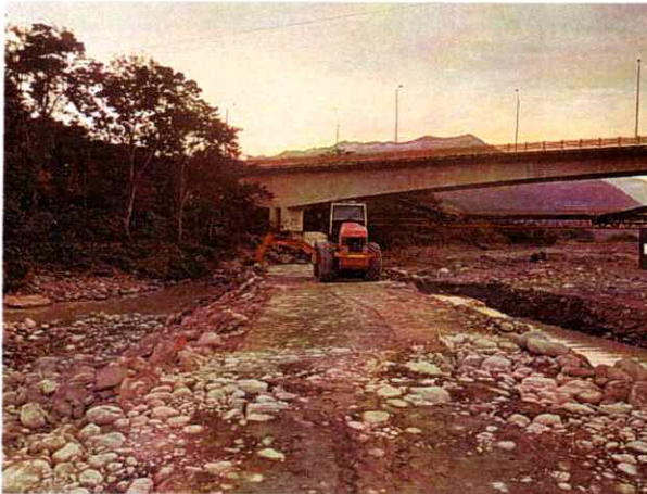
Vibrocompactador Hamm #3 realizando actividades de compactación de jarillón
