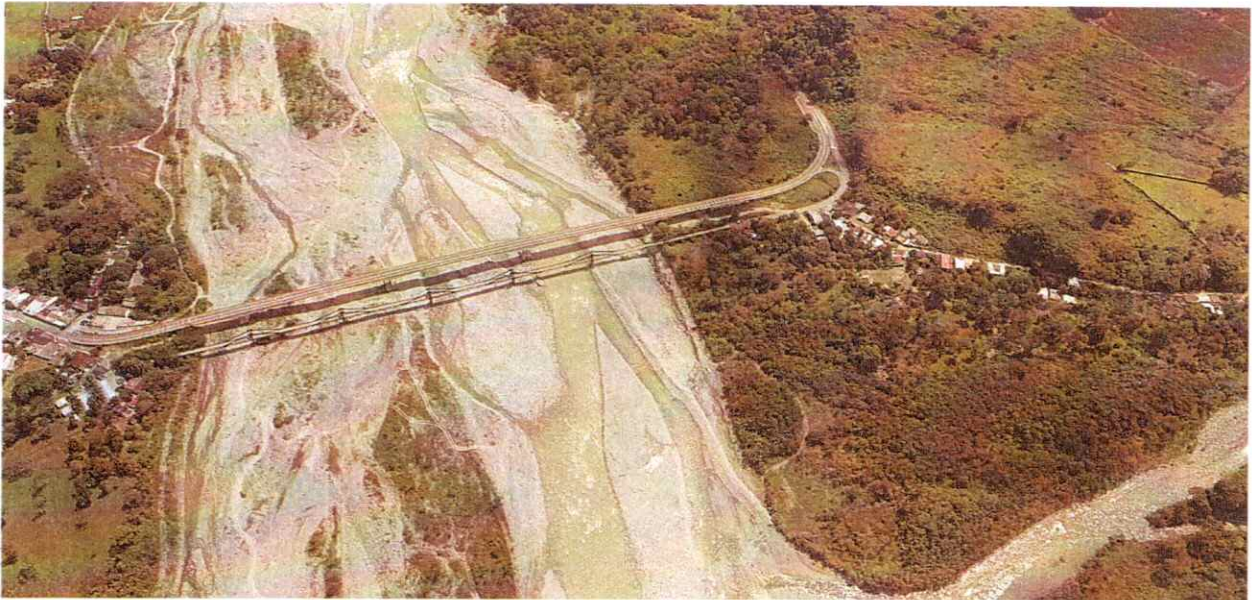
Posterior a la Intervención, Rio Ariari - Margen Derecha Puente La Amistad
