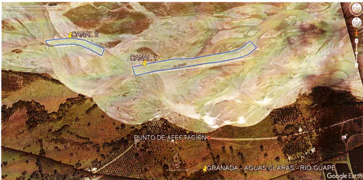
Intervención realizada, Granada – Aguas Claras Rural, Rio Guape
