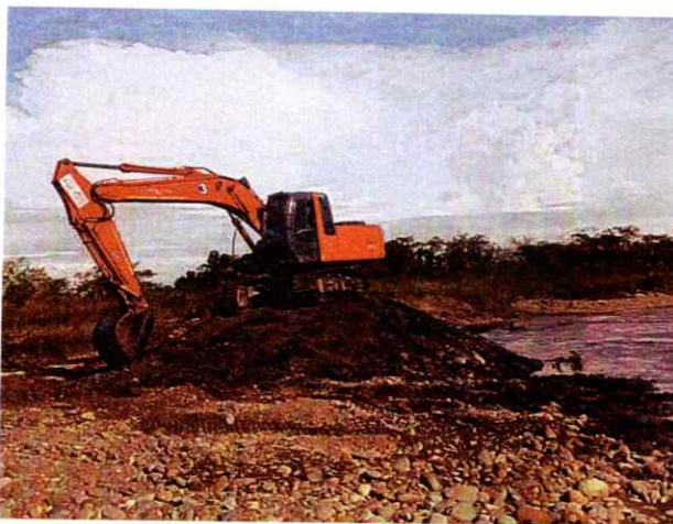
Excavadora Hitachi 200 #4 realizando actividades de conformación de jarillon
