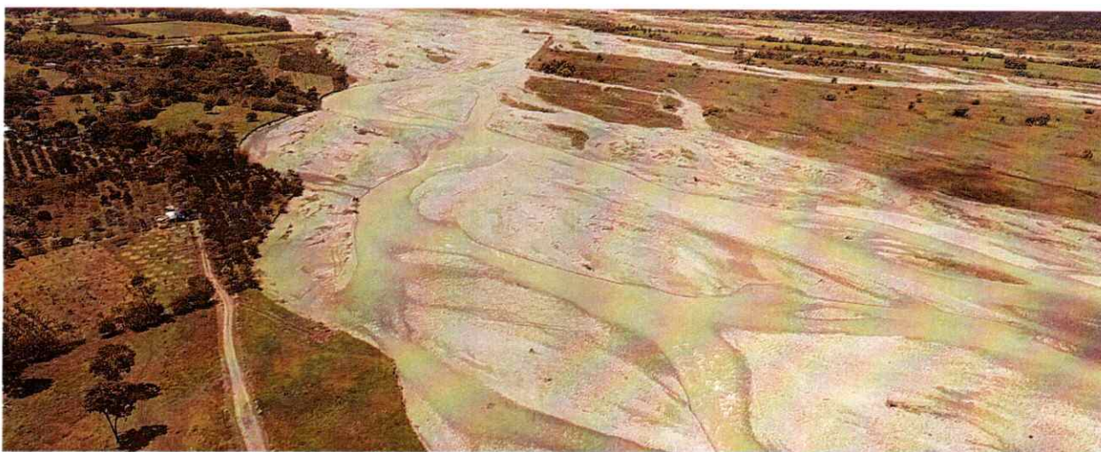
Después de la intervención, Granada – Aguas Claras Rural, Rio Guape
