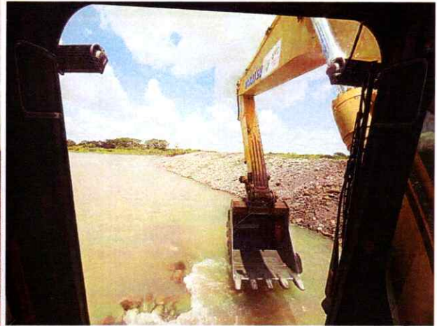
Excavadora Komatsu PC200 #5 realizando actividades de canalización y conformación de cierre
