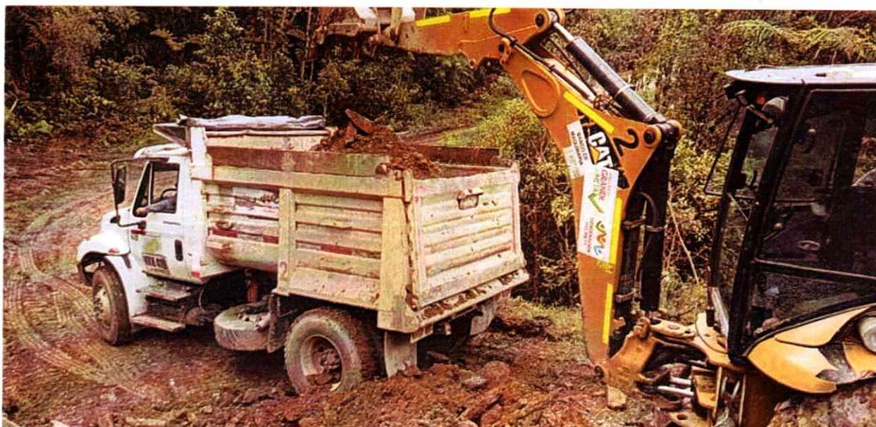
Volqueta VKK 419 Realizando actividades de cargue, transporte y descargue de material
