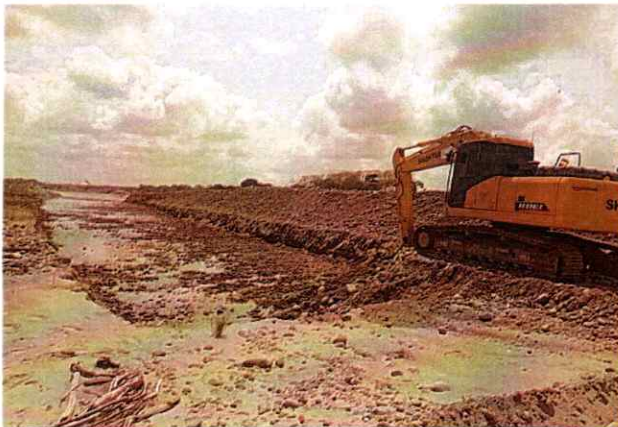
Excavadora Shantui 220LC #4 realizando actividades de canalización
