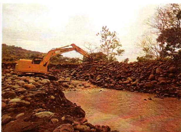
Excavadora Shantui 220 #3 realizando actividades de canalización y protección del aproche del puente
