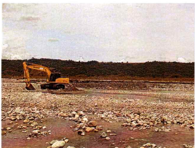
Excavadora Shantui 220LC #4 realizando actividades de canalización
