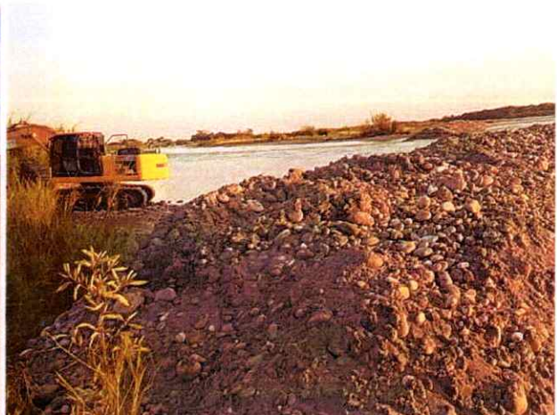
Excavadora Komatsu PC200 #5 realizando actividades de canalización y conformación de cierre
