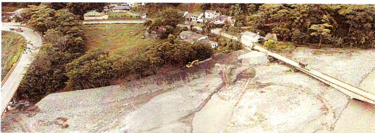
Intervención en proceso, Villavicencio, Entre Puentes – Rio Guayuriba
