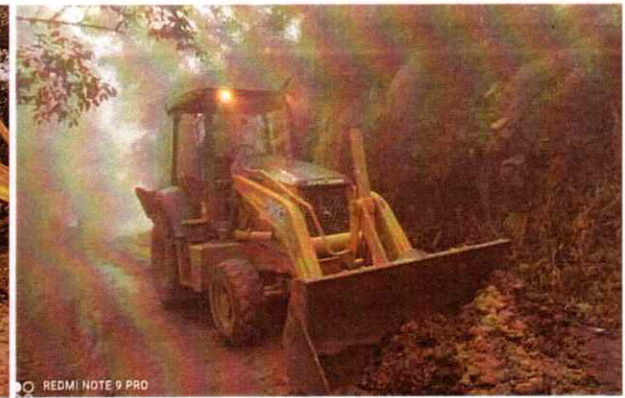
Retroexcavadora John deere 310G realizando actividades de remoción de material y conformación de vía
