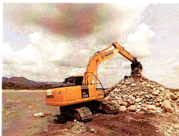
Excavadora Komatsu PC 200LC #4 realizando actividades de extracción de material y conformación de jarillón
