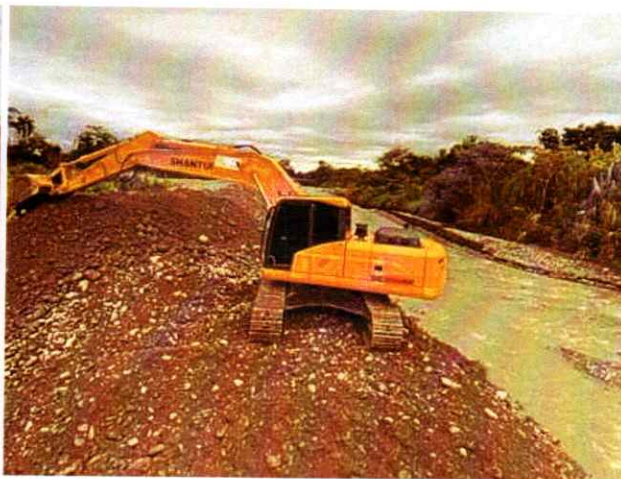
Excavadora Shantui 220LC #2 realizando actividades de canalización y conformación de jarillón
