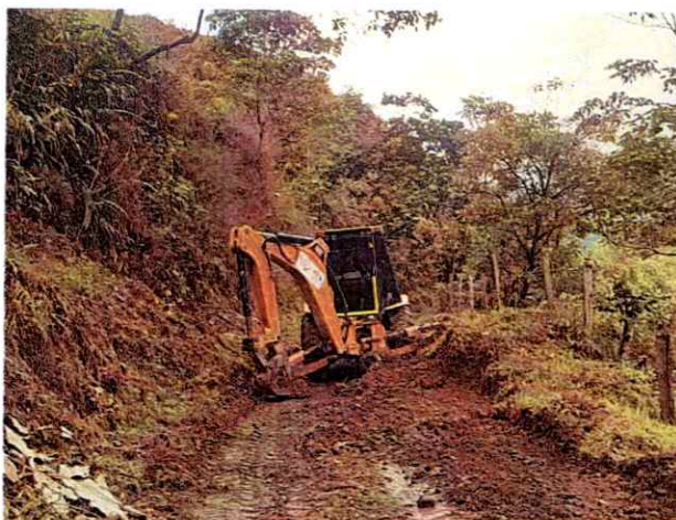
Retroexcavadora Caterpillar 420D realizando actividades de mejoramiento de via y limpieza de derribes
