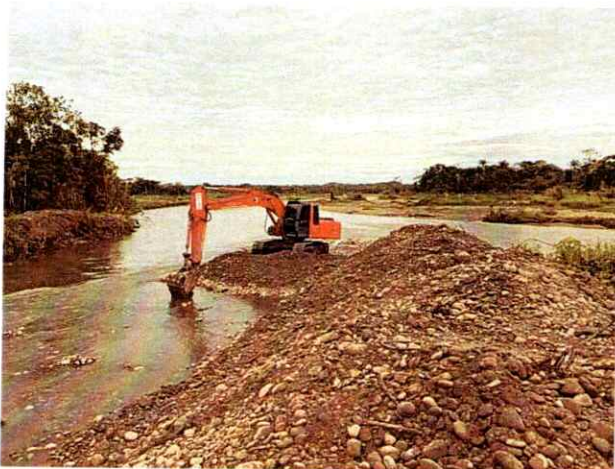
Excavadora Hitachi 200 #4 realizando actividades de conformación de jarillon
