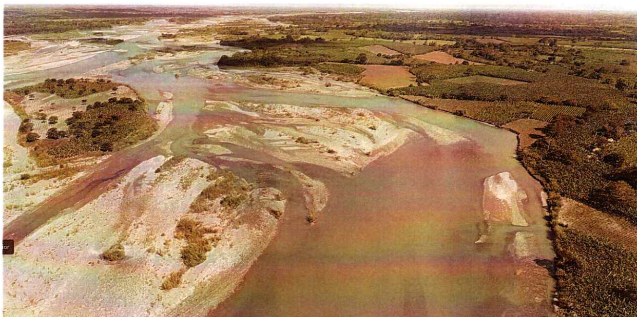
Antes de la intervención, Granada – Rio Ariari, Sector La Isla
