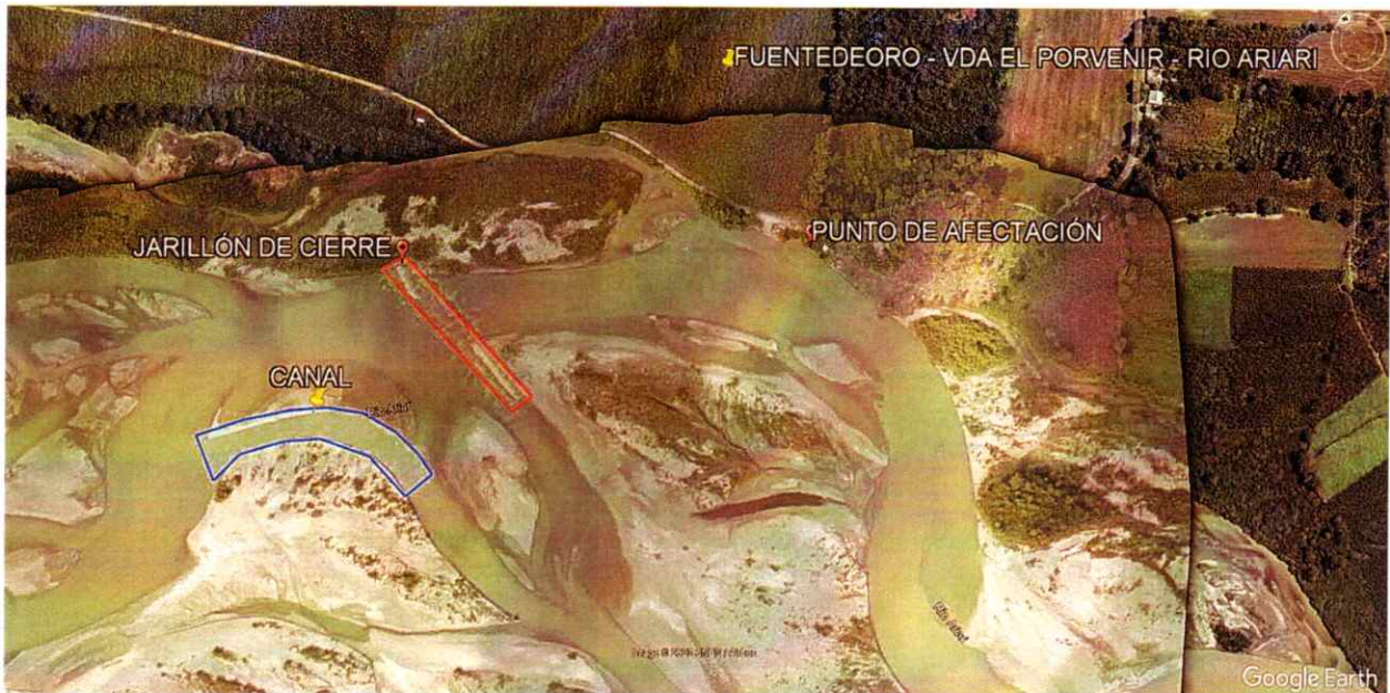
Intervención realizada, Fuente De Oro – Rio Ariari, Vereda El Porvenir-Parte Baja
