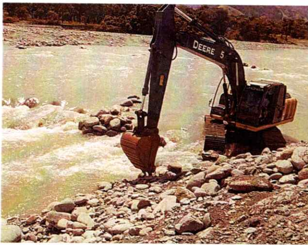
Excavadora Jhon Deere 200LC realizando actividades de canalización y conformación de jarillón
