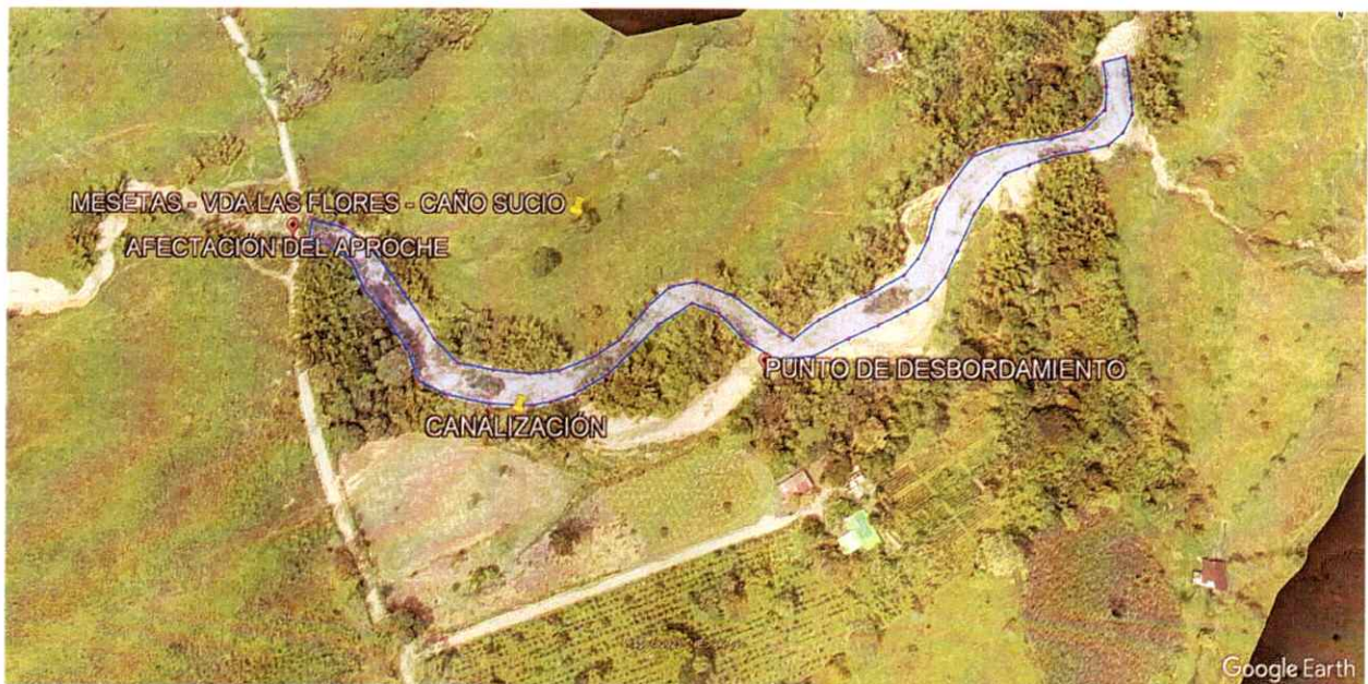
Intervención realizada, Mesetas – Vereda Las Flores, Caño Sucio
