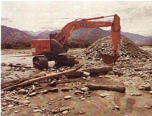
Excavadora Hitachi 225 realizando actividades de canalización y conformación de jarillón
