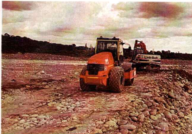
Vibrocompactador Hamm #3 realizando actividades de compactación de Jarillón
