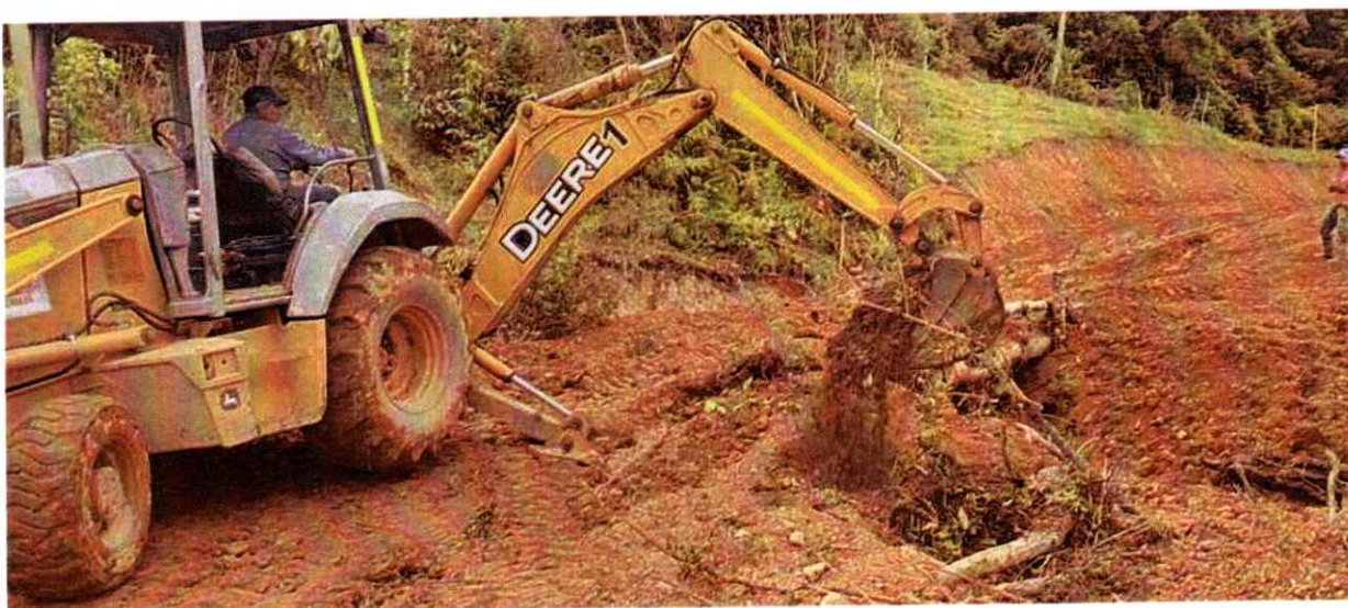
Retroexcavadora John deere 310G realizando actividades de remoción de material y conformación de vía
