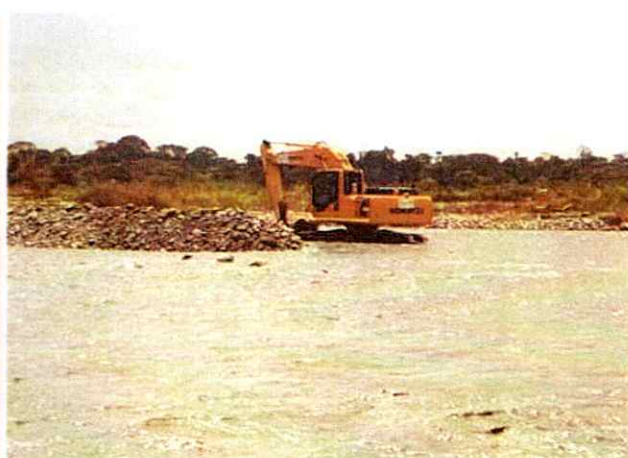
Excavadora Orugada Komatsu PC200LC - 8 #3 realizando actividades de canalización
