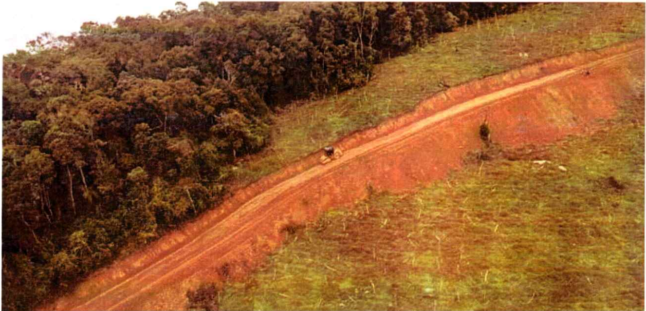
Avance de la rehabilitación de la vía El Clavario - Monfort
