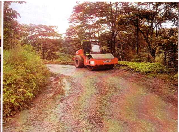
Vibrocompactador Hamm #3 realizando actividades de compactación de jarillón
