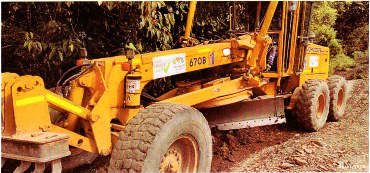
Motoniveladora john deere #1 realizando labores de conformación y rehabilitación de vía
