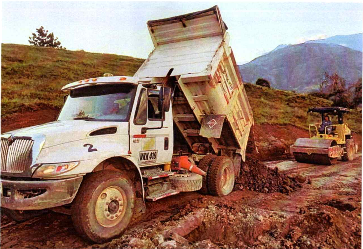
Volqueta VKK 419 Realizando actividades de cargue, transporte y descargue de material
