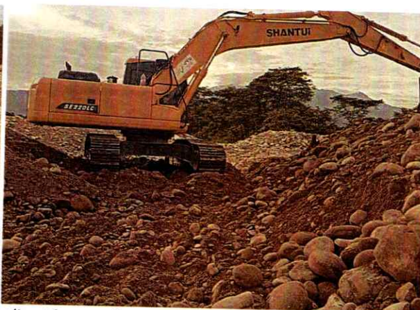
Excavadora Shantui 220 #5 realizando actividades de canalización y conformación de jarillón
