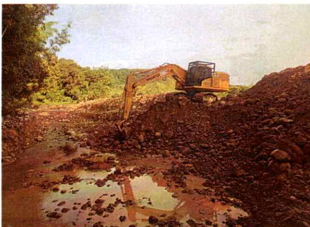
Excavadora Shantui 220 #3 realizando actividades de canalización y protección del aproche del puente
