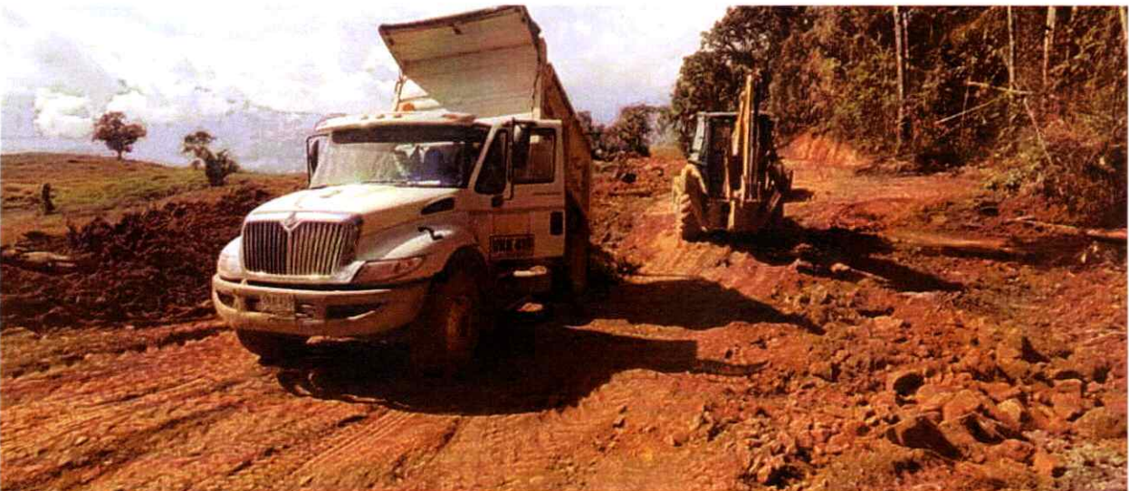
Volqueta VKK 419 Realizando actividades de cargue, transporte y descargue de material
