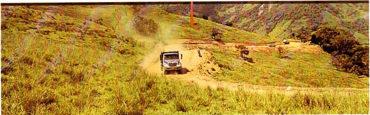
Volqueta SVC 806 Realizando actividades de cargue, transporte y descargue de material
