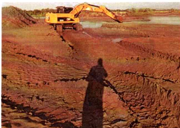
Excavadora Caterpillar 320D #7 realizando actividades de canalización
