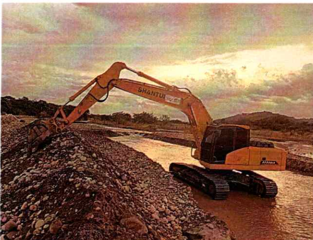
Excavadora Shantui 220LC #4 realizando actividades de excavación y conformación de jarillón y espolones
