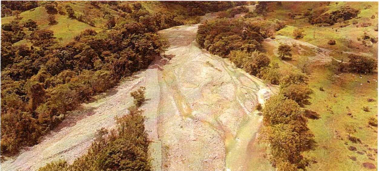
Intervención realizada, El Castillo – Medellín Del Ariari, Rio Cumaral
