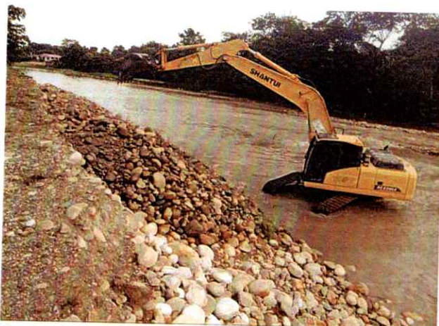
Excavadora Shantui 220 #5 realizando actividades de canalización y conformación de Jarillón
