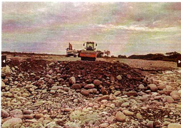
Vibrocompactador Hamm #3 realizando actividades de compactación de Jarillón
