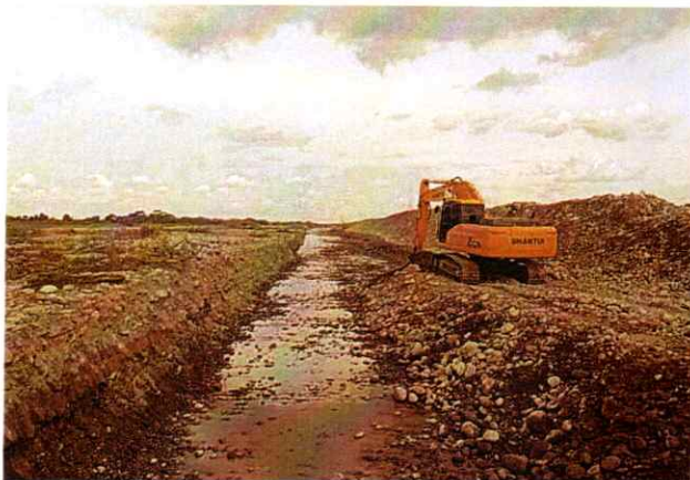
Excavadora Shantui 220LC #4 realizando actividades de canalización
