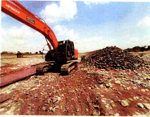
Excavadora Hitachi 225 #5 realizando actividades de canalización
