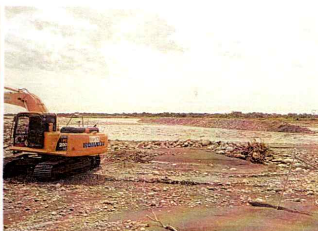
Excavadora Orugada Komatsu PC200LC - 8 #3 realizando actividades de canalización
