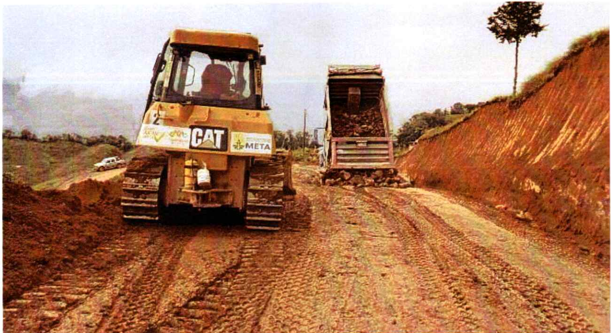
Volqueta SVC 806 Realizando actividades de cargue, transporte y descargue de material
