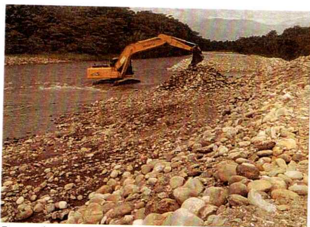
Excavadora Shantui 220 #5 realizando actividades de canalización y conformación de jarillón
