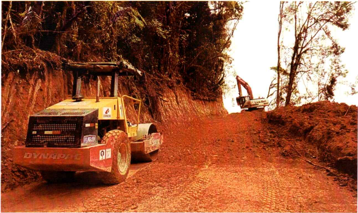
Vibro compactador dynapac #1 realizando labores de compactación a la vía
