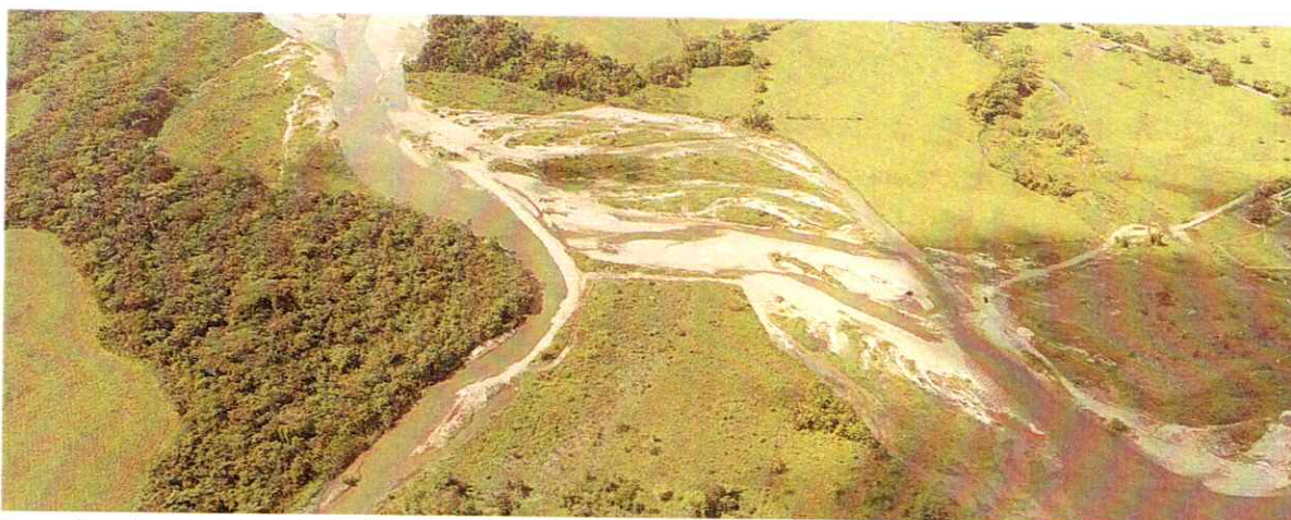
Posterior a la intervención, Villavicencio – Vereda El Guamo, Rio Ocoa
