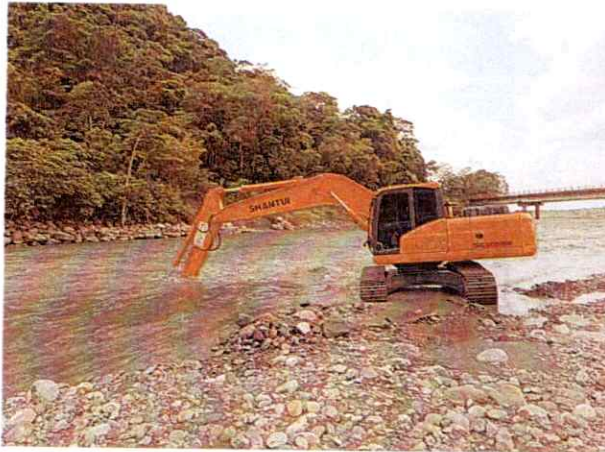
Excavadora Orugada Shantui 220LC #1 realizando actividades de canalización y conformación de Jarillón
