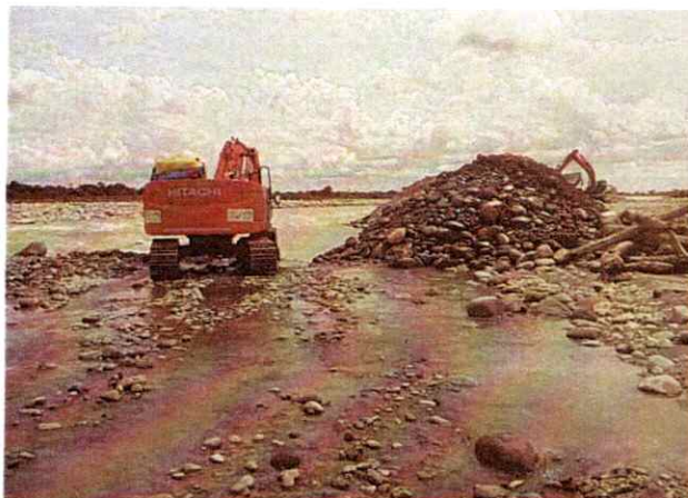
Excavadora Hitachi 225 realizando actividades de canalización y conformación de jarillón
