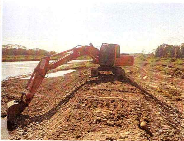
Excavadora Hitachi 200 #4 realizando actividades de conformación de jarillon
