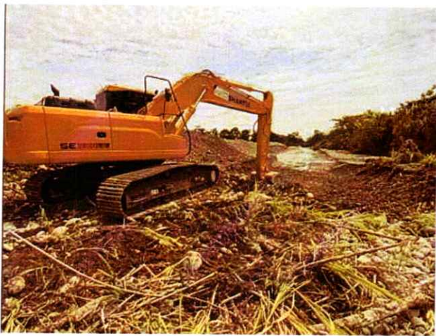
Excavadora Shantui 220LC #2 realizando actividades de canalización y conformación de jarillón
