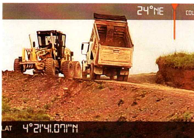
Volqueta UZN327 Realizando actividades de cargue, transporte y descargue de material
