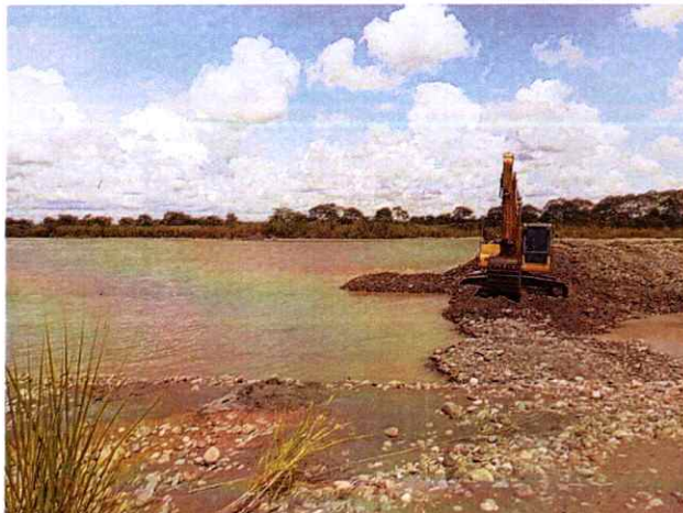
Excavadora Komatsu PC200 #5 realizando actividades de canalización y conformación de cierre
