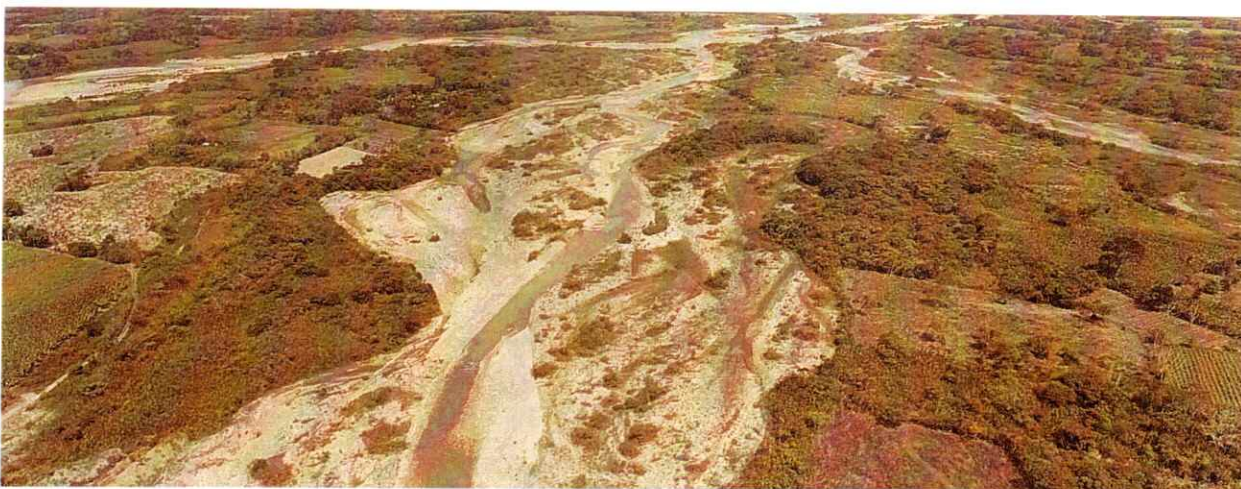
Intervención realizada, El Castillo – Vereda La Unión, Rio Guape – Jarillón #2
