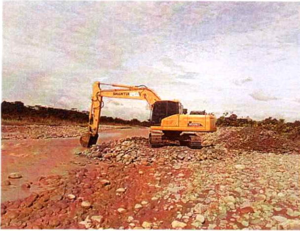
Excavadora Shantui 220LC #4 realizando actividades de excavación y conformación de Jarillón y espolones
