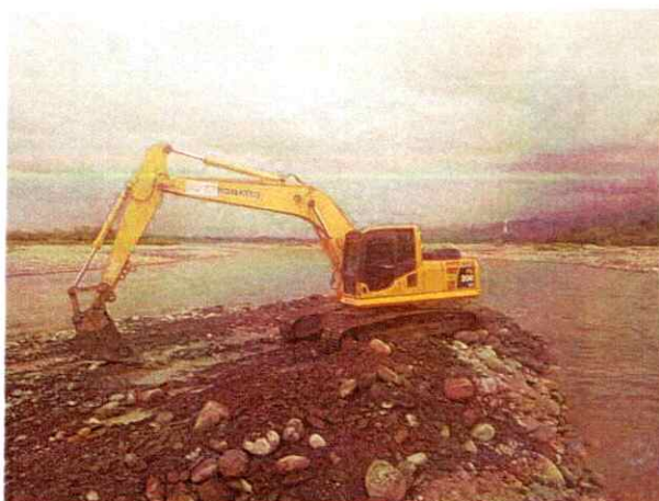
Excavadora Orugada Komatsu PC200LC - 8 #3 realizando actividades de canalización
