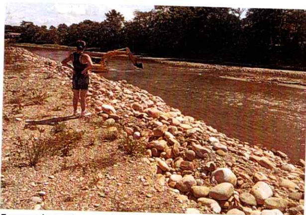
Excavadora Shantui 220 #5 realizando actividades de canalización y conformación de jarillón
