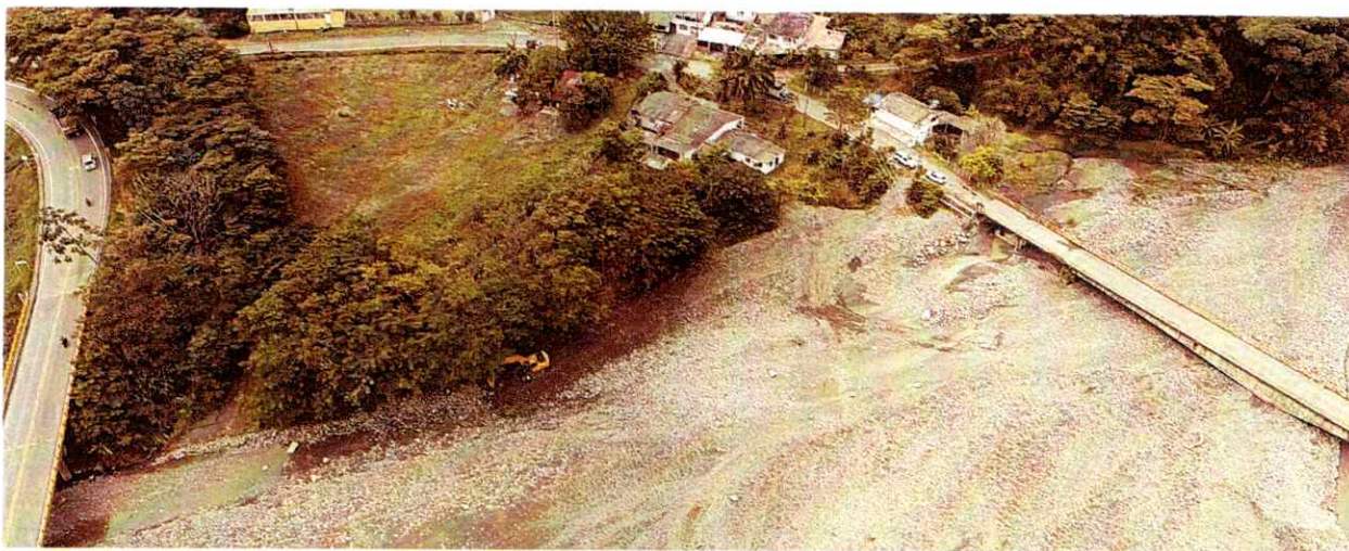
Intervención en proceso, Villavicencio, Entre Puentes – Rio Guayuriba
