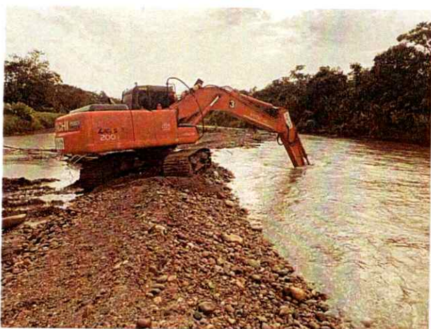
Excavadora Hitachi 200 #4 realizando actividades de conformación de jarillon
