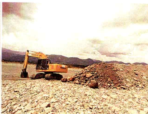
Excavadora Komatsu PC 200LC #4 realizando actividades de extracción de material y conformación de jarillón
