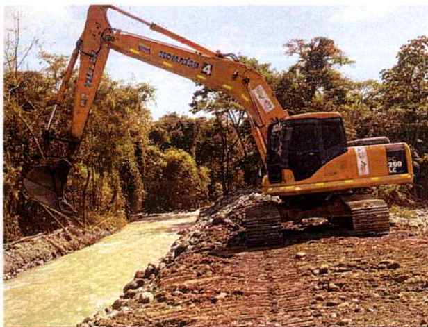
Excavadora Komatsu #6 realizando actividades de excavación y conformación de Jarillón
