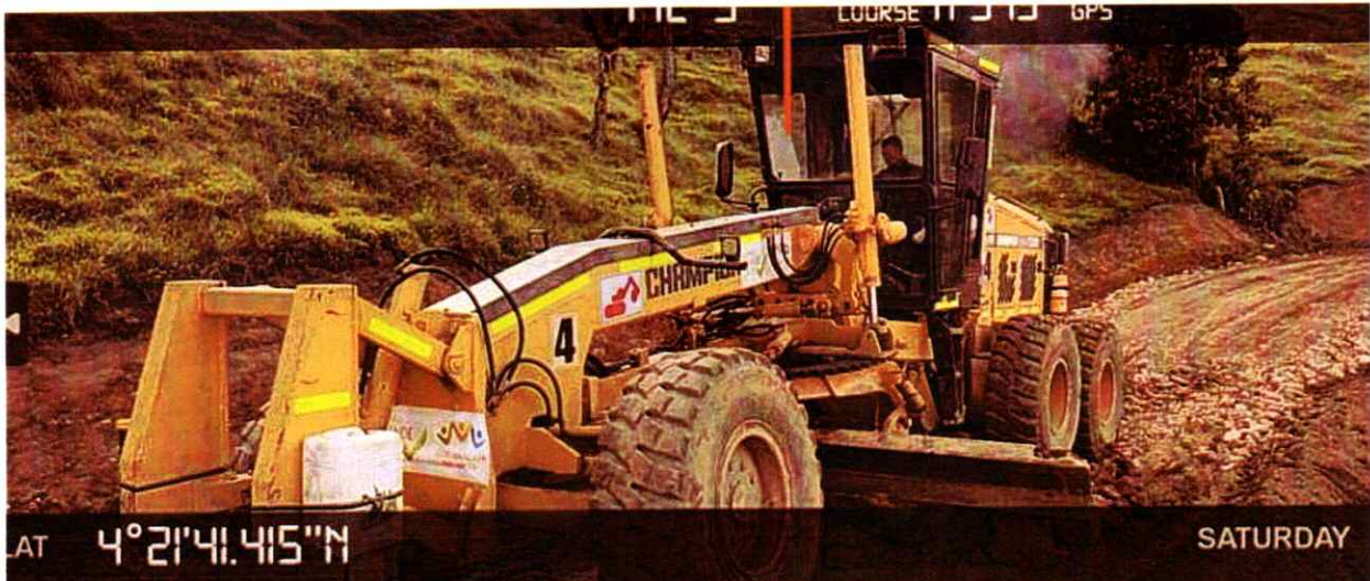
Motoniveladora champion #4 realizando labores de extendido de material y conformado de cunetas
