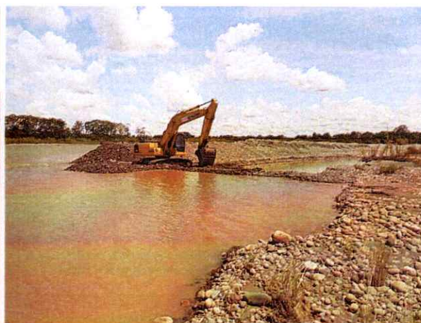
Excavadora Komatsu PC200 #5 realizando actividades de canalización y conformación de cierre
