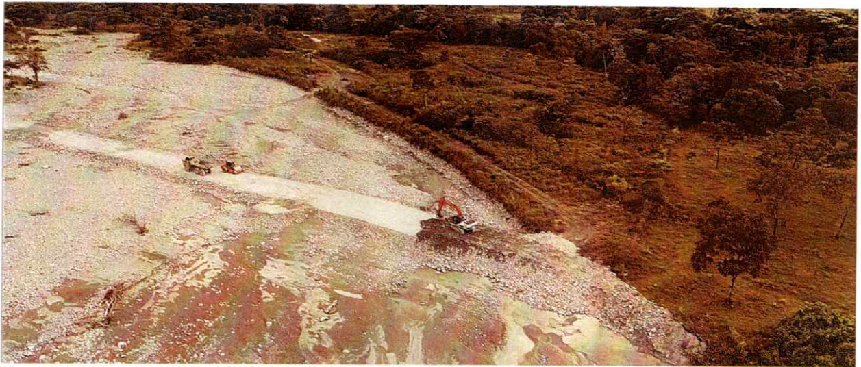
Durante la Intervención, Rio Ariari - Margen Derecha Puente La Amistad
