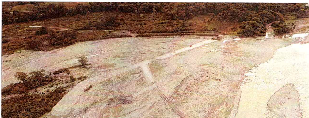
Durante la Intervención, Rio Ariari - Margen Derecha Puente La Amistad
