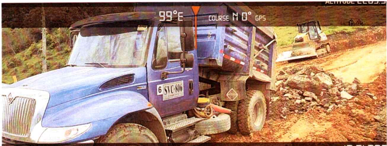
Volqueta SVC 806 Realizando actividades de cargue, transporte y descargue de material
