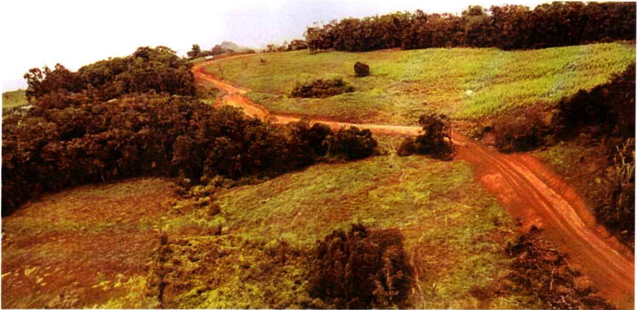
Avance de la rehabilitación de la vía El Clavario – Monfort
