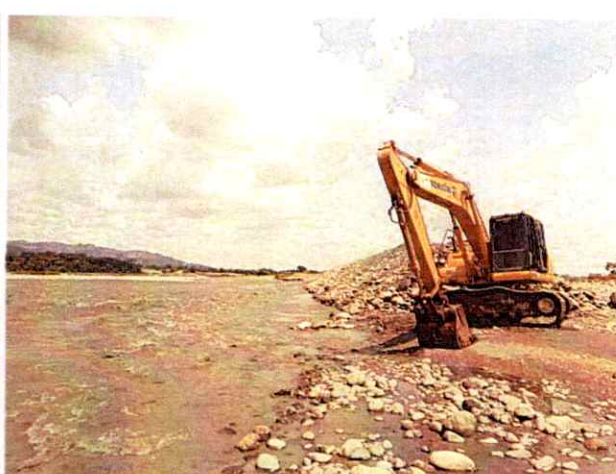
Excavadora Komatsu PC 200LC #4 realizando actividades de extracción de material y conformación de jarillón
