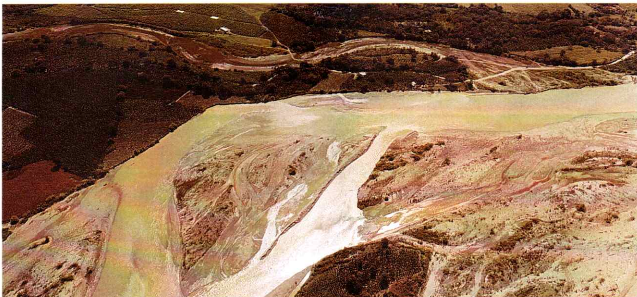
Posterior a la intervención, Granada – Rio Ariari, Sector La Isla
