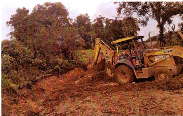
Retroexcavadora John deere 310G realizando actividades de remoción de material y conformación de vía
