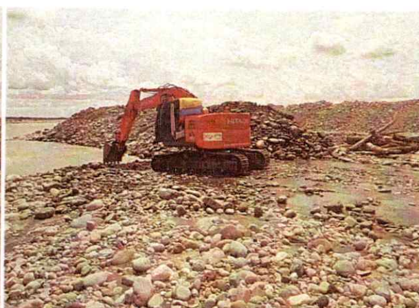
Excavadora Hitachi 225 realizando actividades de canalización y conformación de jarillón
