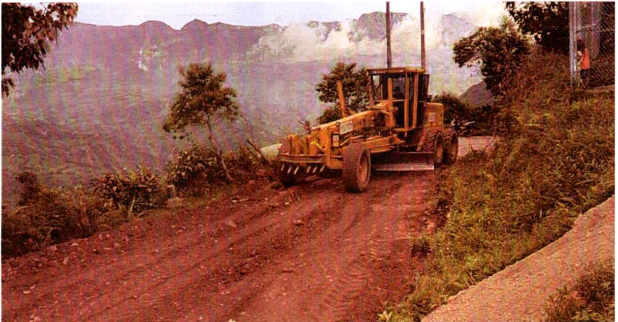
Motoniveladora jhon deere #1 realizando labores de conformación y rehabilitación de vía
