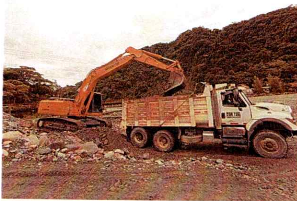
Excavadora Orugada Shantui 220LC #1 realizando actividades de canalización y conformación de jarillón
