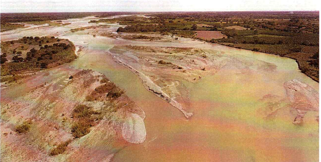
Posterior a la intervención, Granada – Rio Ariari, Sector La Isla
