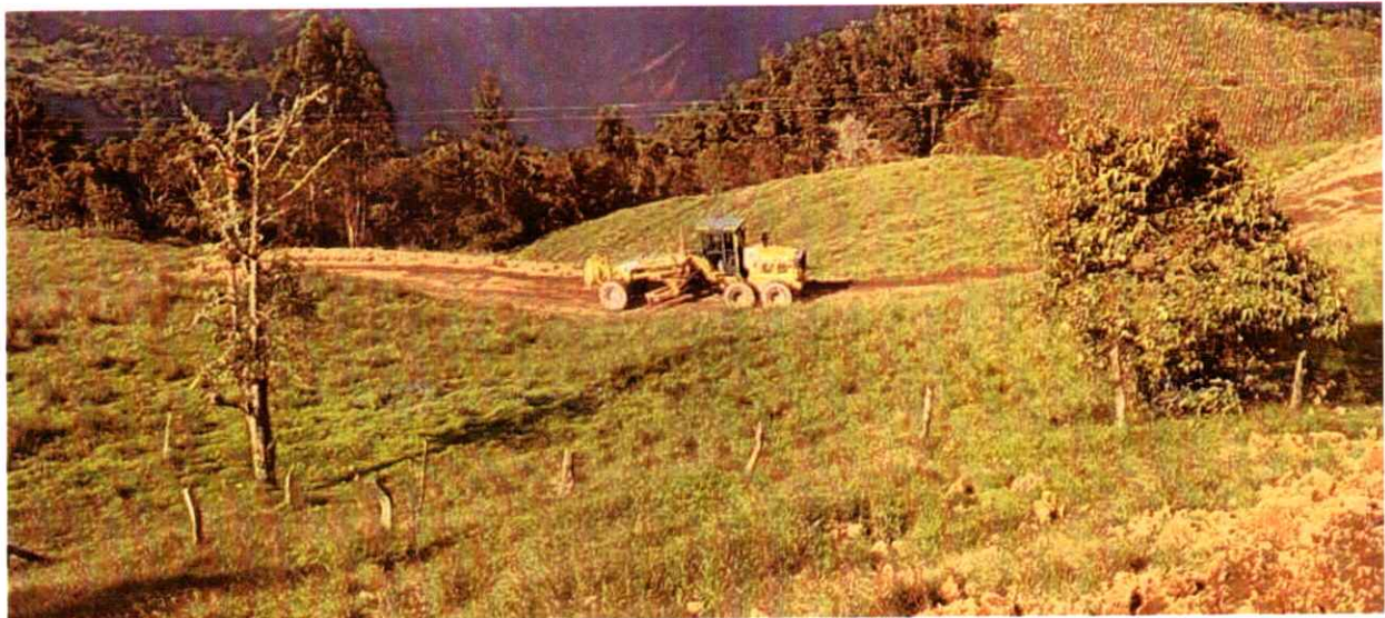
Motoniveladora champion #4 realizando labores de conformación de vía
