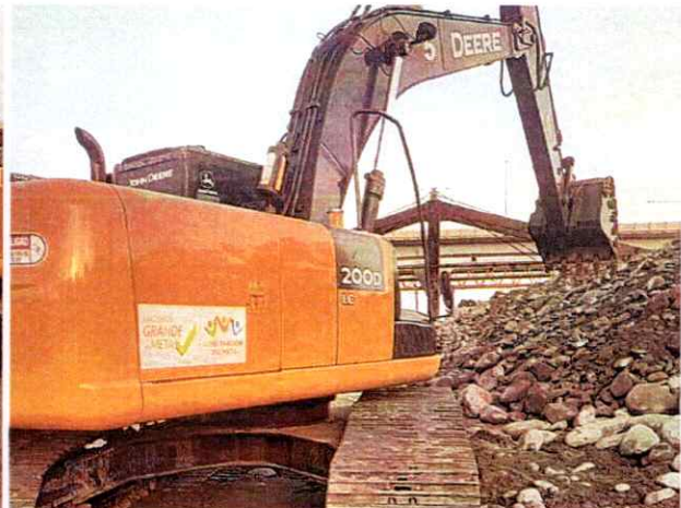
Excavadora Jhon Deere 200LC realizando actividades de canalización y conformación de Jarillón
