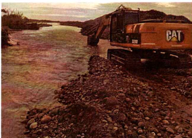
Excavadora Caterpillar 320D #7 realizando actividades de canalización
