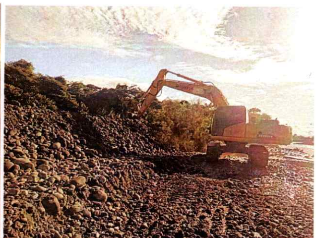
Excavadora Shantui 220LC #4 realizando actividades de excavación y conformación de jarillón y espolones
