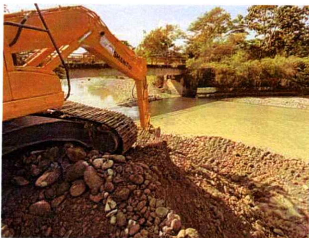
Excavadora Shantui 220LC #2 realizando actividades de canalización y conformación de jarillón
