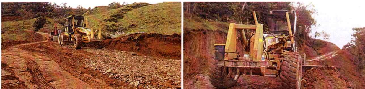
Motoniveladora champion #4 realizando labores de extendido de material
