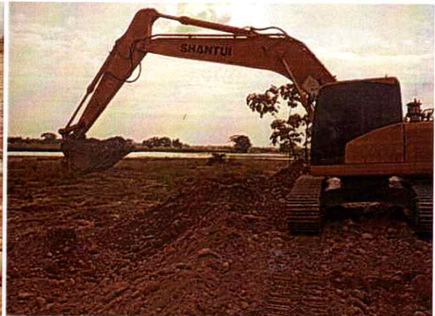
Excavadora Shantui 220 #5 realizando actividades de excavación y conformación de Jarillón
