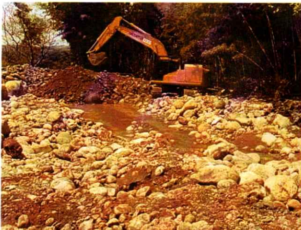
Excavadora Shantui 220 #3 realizando actividades de canalización
