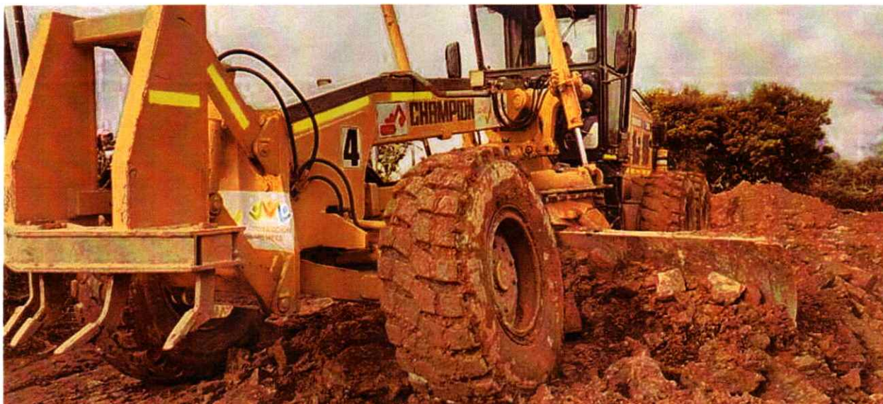
Motoniveladora champion #4 realizando labores de extendido de material
