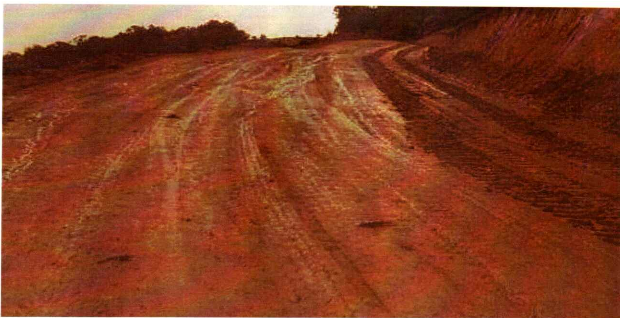
Avance de la rehabilitación de la vía El Clavario – Monfort
