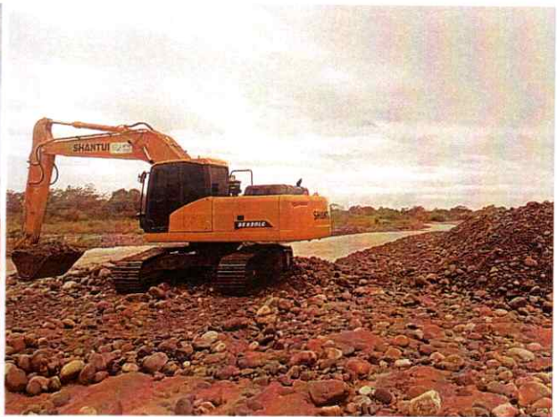
Excavadora Shantui 220LC #4 realizando actividades de excavación y conformación de Jarillón y espolones
