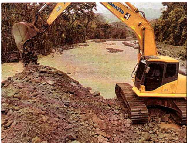
Excavadora Komatsu #6 realizando actividades de excavación y conformación de Jarillón
