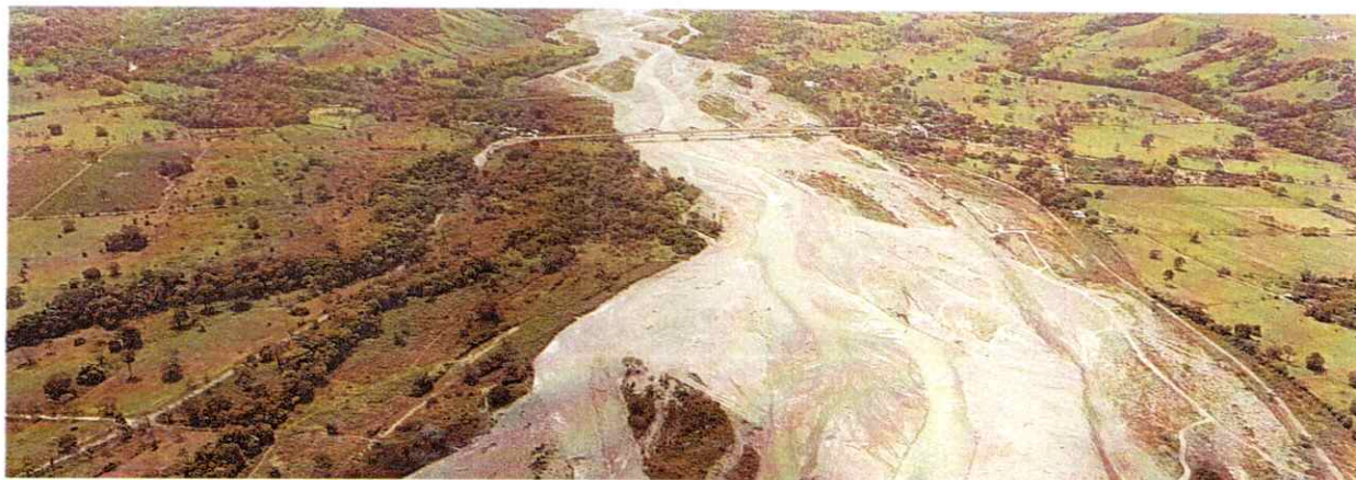
Antes de la Intervención, Rio Ariari - Margen Derecha Puente La Amistad
