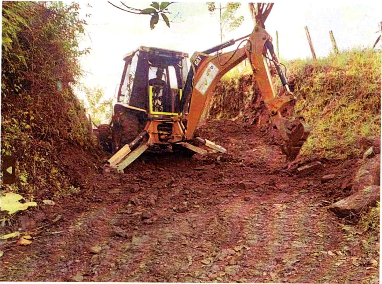
Retroexcavadora Caterpillar 420D realizando actividades de mejoramiento de via y limpieza de derribes
