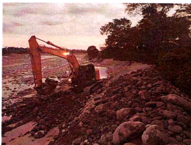
Excavadora Hitachi 225 realizando actividades de canalización y conformación de jarillón
