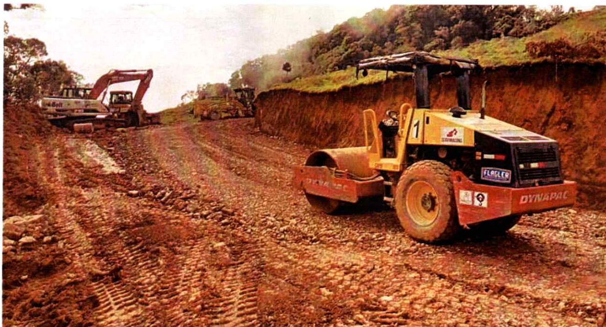
Vibro compactador dynapac #1 realizando labores de compactación a la vía
