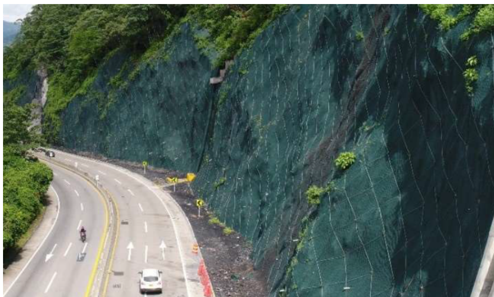
Ilustración 15. Imagen ilustrativa de protección de taludes con manto permanente y malla de alta resistencia.
