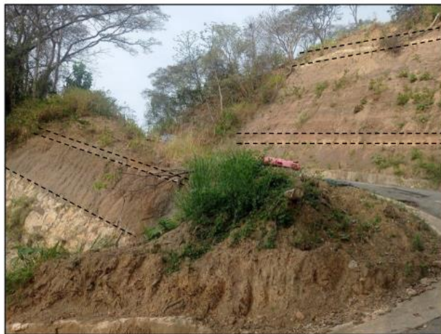
Ilustración 8. Vista general de talud en el tramo comprendido entre K3+760 a K3+780, se observan los niveles de arenisca y arcillolita a lo largo de la unidad.
