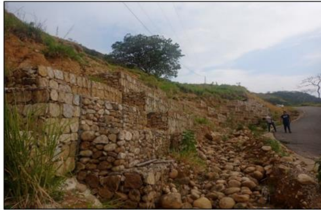
Ilustración 7. Vista panorámica de muros tipo Gavión.
