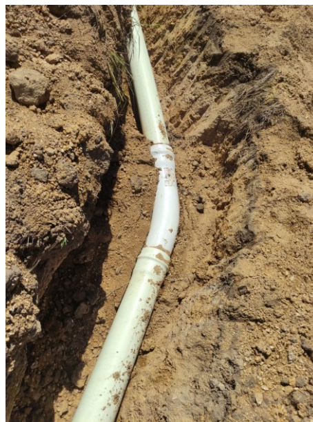
Registro Fotográfico 12. Suministro e Instalación de Codo HD 22.5 x 8"
