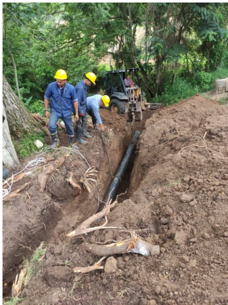
Registro Fotográfico 09. Instalación Tubería HD 8 " (unión por enchufe y caña)
