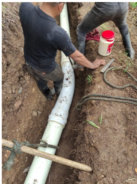
Registro Fotográfico 12. Suministro e Instalación de Codo HD 22.5 x 8"
