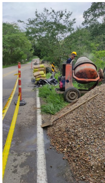
Registro Fotográfico 14. Concreto 3000 PSI (Inc. Formaleta 1/4 usos y colocación)
