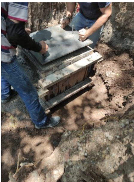
Registro Fotográfico 14. Concreto 3000 PSI (Inc. Formaleta 1/4 usos y colocación)
