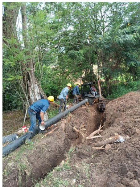
Registro Fotográfico 09. Instalación Tubería HD 8 " (unión por enchufe y caña)
