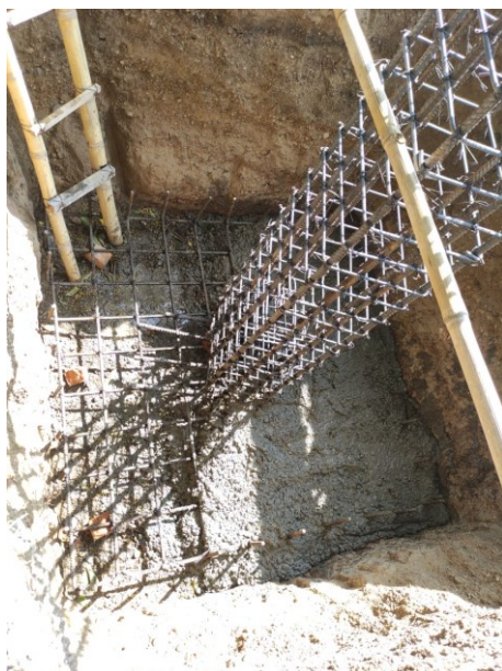
Registro Fotográfico 14. Concreto 3000 PSI (Inc. Formaleta 1/4 usos y colocación)
